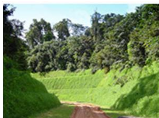
Figura 6- Área após os procedimentos com hidrossemeadura Foto ilustrativa
