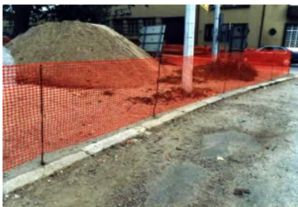
FIGURA 2.23.1 – EXEMPLO DE ISOLAMENTO COM REDE DE PROTEÇÃO PARA OS INSUMOS DA CONSTRUÇÃO FONTE: HTTP://SINORGAN.COM/CONSTRUCAO
