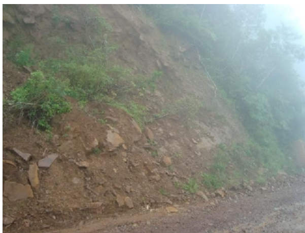
FIGURA 2.6.10 - FOTO: BLOCOS DE ROCHA NA EMINÊNCIA DE CAIR COORDENADAS: LAT.: 6.812.950 N / LONG.:602.800 E / ALTITUDE: 941 M
