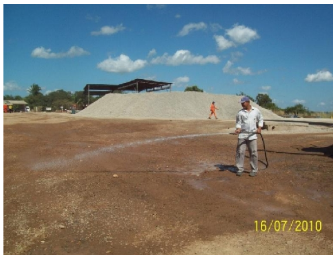
FIGURA 2.5.4 – EXEMPLO DE JATEAMENTO DO SOLO PARA REDUÇÃO DE POEIRA DECORRENTE DO TRÁFEGO DE VEÍCULOS FONTE: UFPR / ITTI, 2010.
