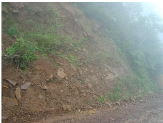
FIGURA 2.6.3 - FOTO: BLOCOS DE ROCHA NA EMINÊNCIA DE CAIR COORDENADAS: LAT.: 6.812.950 N / LONG.:602.800 E / ALTITUDE: 941 M
