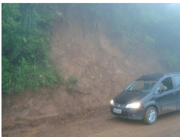
FIGURA 2.6.12 - FOTO: ESCORREGAMENTO DE SOLO COORDENADAS: LAT.: 6.813.150 N / LONG.:604.560 E / ALTITUDE: 650 M
