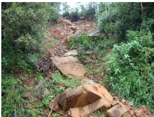
FIGURA 2.6.7 – FOTO: GRANDE ESCORREGAMENTO DE BLOCOS DE ROCHA EM SOLO COORDENADAS: LAT.: 6.812.541 N / LONG.:605.861 E / ALTITUDE: 339 M
