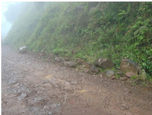
FIGURA 2.6.2 – FOTO: ESCORREGAMENTO DE SOLO E BLOCOS DE ROCHA COORDENADAS: LAT.: 6.813.587 N / LONG.:602.619 E / ALTITUDE: 1.112 M
