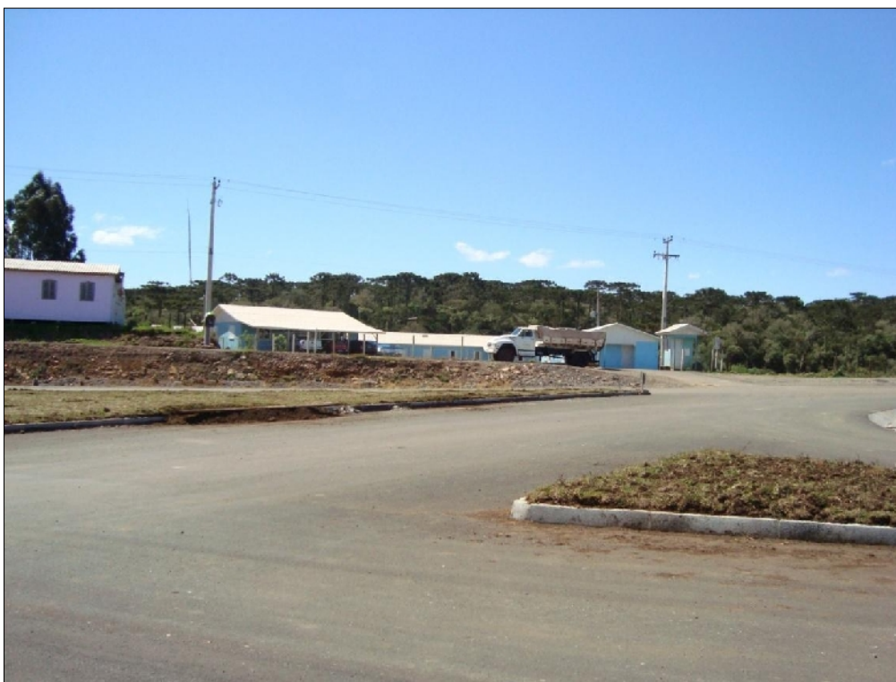
FIGURA 2.2.1 – FOTO DO CANTEIRO DE OBRAS JÁ EXISTENTE DA CONSTRUTORA SULTEPA S.A. FONTE: UFPR, 2009.
