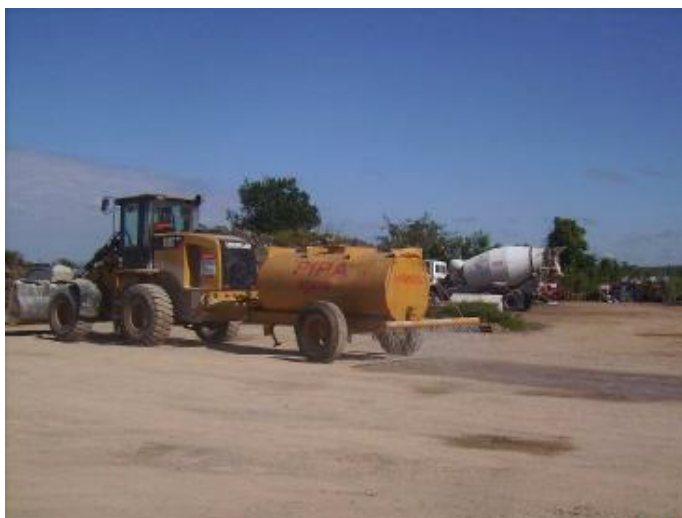
FIGURA 2.5.5 – EXEMPLO DE JATEAMENTO DO SOLO COM CAMINHÃO PIPA PARA REDUÇÃO DE POEIRA DECORRENTE DO TRÁFEGO DE VEÍCULOS
