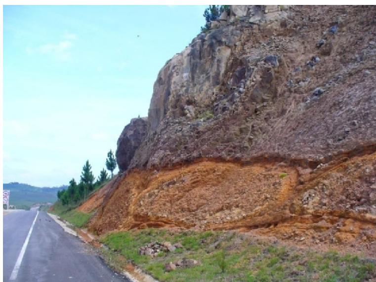
FIGURA 2.6.2 – DESLIZAMENTOS DE MATERIAL INTEMPERIZADO (ELÚVIO) SOB BLOCOS ROCHOSOS EM CORTE – ENTRE A SEDE DE SÃO JOSÉ DOS AUSENTES E KM 45+800 M FONTE: UFPR, 2011.
