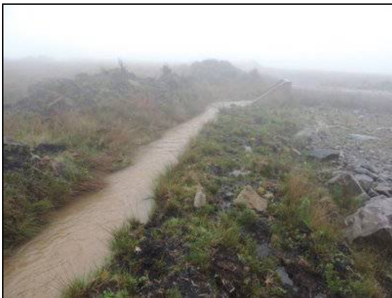
Foto 51. Valeta de drenagem funcional (jusante). km 52+500. Coord. UTM 600922/6814594 22J (Out/2015).
