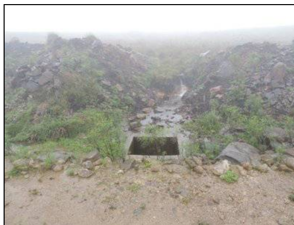
Foto 54. Caixa de drenagem funcional. km 53+540. Coord. UTM 601720/6814007 22J (Out/2015).
