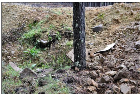
Foto 68. Resíduos dispostos de forma incorreta na faixa de domínio. km 46+555 (LE). Coord. UTM 597052/6817797 22J (Nov/2015).
