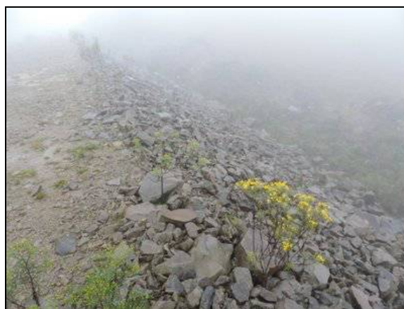
Foto 56. Aterro enrocado. km 53+750. Coord. UTM 601914/6813916 22J (Out/2015).
