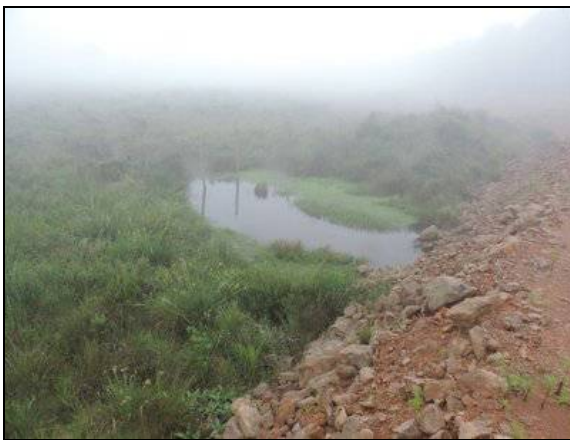
Foto 47. Drenagem provisória conduzindo a contento o volume de água a montante. km 47+432. Coord. UTM 597656/6817148 22J (Out/2015).
