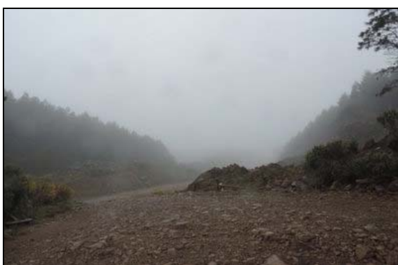
Foto 13. Início do Lote 1 em segmento paralisado sem sinalização específica. km 45+800. Coord. UTM 596491/6818199 22j (Out/2015)
