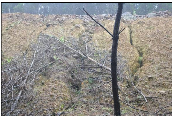
Foto 35. Incidência de processo erosivo em aterro com impacto dentro da faixa de domínio. km 46+890 (LD). Coord. UTM 597285/6817534 22J (Nov/2015).
