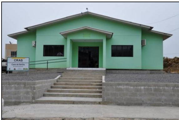
Foto 83. Centro de Referência de Assistência Social (CRAS). São José dos Ausentes/RS. Coord. UTM 591704/6819740 22J (Nov/2015).
