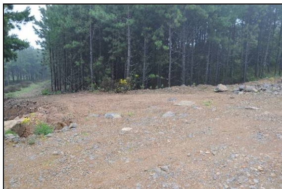
Foto 70. Acesso em condições de trafegabilidade. km 46+870 (LD). Coord. UTM 597270/6817565 22J (Nov/2015).
