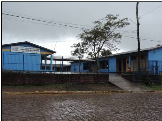
Foto 74. Escola Estadual de Ensino Médio Antônio Inácio Velho. São José dos Ausentes/RS. Coord. UTM 591176/6819557 22J (Out/2015).
