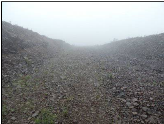
Foto 57. Vista geral do corte e do corpo estradal em conformidade. km 53+920. Coord. UTM 612067/6813840 22j (Out/2015).
