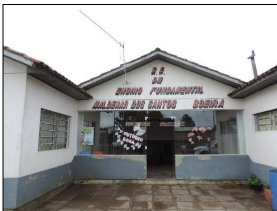
Foto 80. Escola Estadual de Ensino Fundamental Waldemar dos Santos Boeira. São José dos Ausentes/RS. Coord. UTM 604356/6833116 22J (Out/2015).
