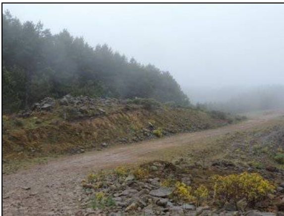
Foto 15. Corte (LE) apresenta-se bem compactado, km 45+920. Coord. UTM 596504/6818204 22J (Out/2015).
