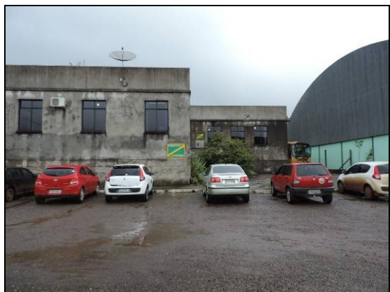
Foto 76. Prefeitura Municipal. São José dos Ausentes/RS. Coord. UTM 591493/6819408 22J (Out/2015).
