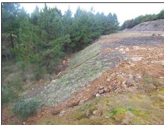
Foto 17. Monitoramento do segmento de aterro reconformado e enleivado, km 45+900 (LE). Coord. UTM 6818129/ 596635 (Jun/2015)
