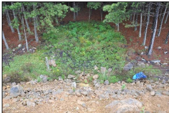
Foto 66. Resíduos dispostos de forma incorreta na faixa de domínio. km 46+245 (LD). Coord. UTM 596815/6817965 22J (Nov/2015).
