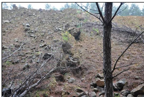
Foto 42. Incidência de processo erosivo em aterro com impacto dentro da faixa de domínio. km 46+975 (LD). Coord. UTM 597336/6817471 22J (Nov/2015).
