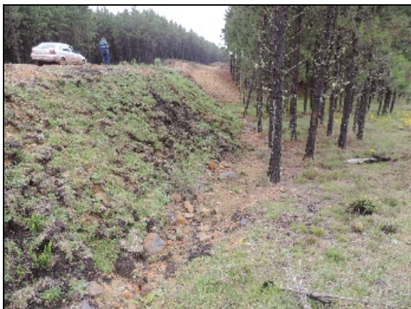
Foto 29. Aterro protegido com leivas. km 46+520. Coord. UTM 597015/ 6817800 22J (29/10/2015).
