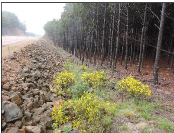
Foto 23. Aterro enrocado sem a incidência de processos erosivos (LD). km 46+190. Coord. UTM 596763/6818001 22J (Out/2015).
