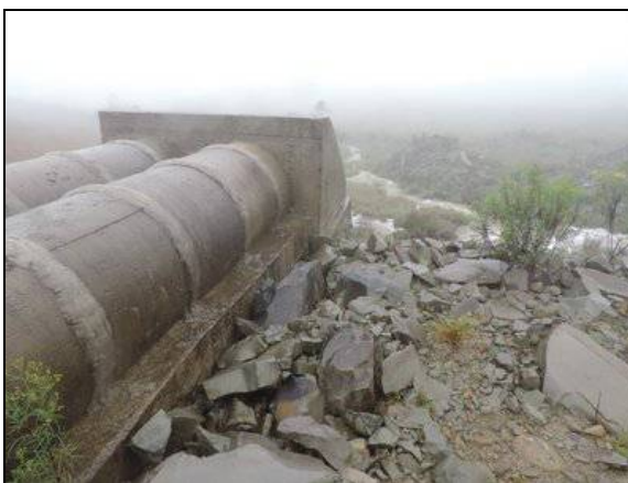
Foto 49. Bueiro funcional no início do segundo segmento com obras paralisadas. km 52+480. Coord. UTM 600935/6814580 22J (Out/2015).
