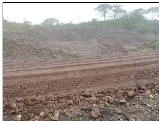
Foto 6. Atividades de manutenção na atual estrada no entorno da Cascalheira 1. Coord. UTM 597782/6815712 22J (Out/2015).
