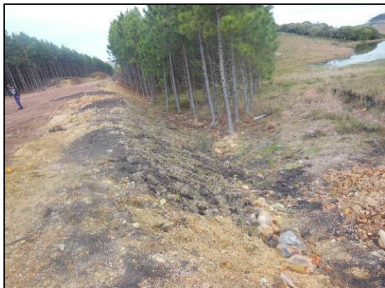
Foto 27. Reconformação e enleivamento de talude de aterro próximo a açude lindeiro. km 46+520. Coord. UTM 6817791/ 597043 (LD). (Jun/2015)
