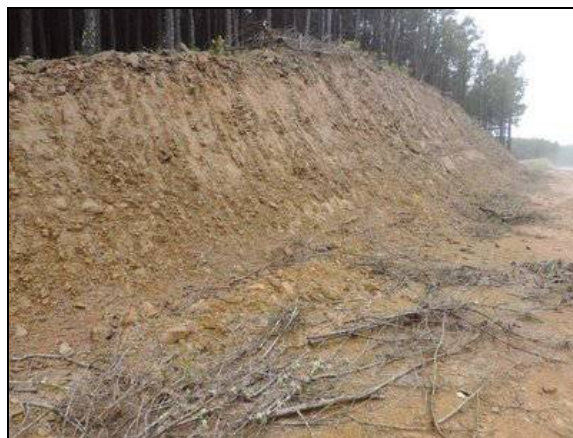
Foto 24. Corte (LE) apresenta-se bem compactado. km 46+280 ao 46+380. Coord. UTM 596847/6817956 22J (Out/2015).
