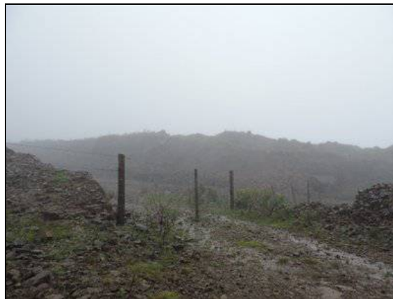
Foto 58. Cerca limitando o final do segundo segmento com obras paralisadas. km 54+000. Coord. UTM 602131/6813795 22j (Out/2015).
