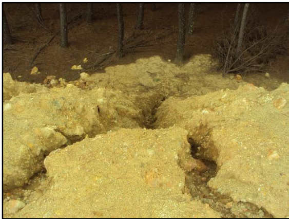
Foto 14 – Ravinamento sobre a face do talude – novembro/14.
