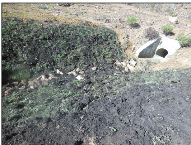
Fotos 9 - KM 46+020 (LE) – Detalhe da reconfiguração e do enleivamento executado – maio/15.
