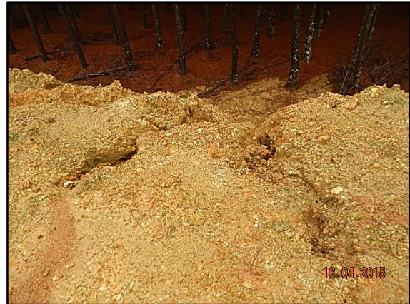
Foto 15 – Ravinamento sobre a face do talude – maio/15.
