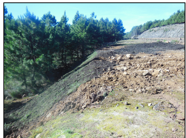
Fotos 5 - Km 45+900 (LE) – Vista das medidas corretivas executadas – maio/15.
