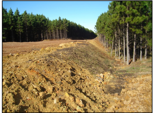
Foto 11 – Vista das medidas corretivas executadas no talude de aterro – maio/15.
