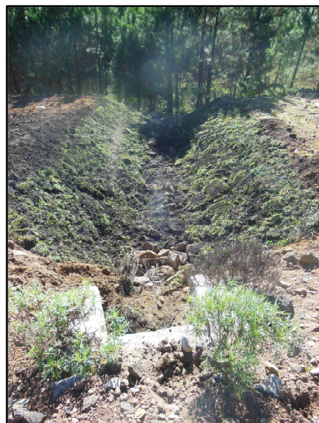
Fotos 8 - KM 46+020 (LE) – Vista das medidas corretivas executadas – maio/15.
