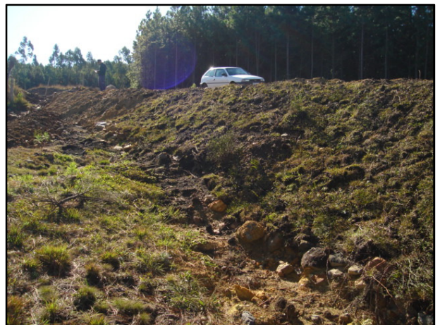
Foto 13 – Detalhe do talude revegetado – maio/15.
