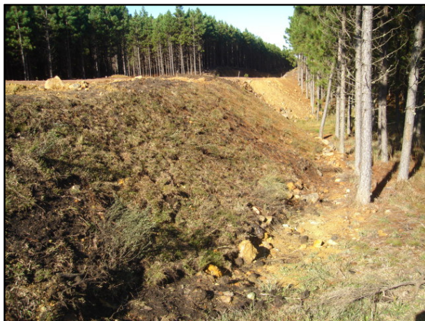
Foto 12 – Detalhe do talude revegetado – maio/15.
