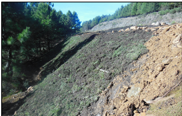
Fotos 6 - Km 45+900 (LE) – Detalhe do talude reconfigurado e do enleivamento – maio/15.
