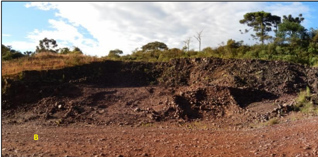
Foto 32 – Local onde presumivelmente houve retirada de material após a colocação das placas de advertência. Foto 32A tomada em 15/01/2015; foto 32B tirada em 20/02/2015.
