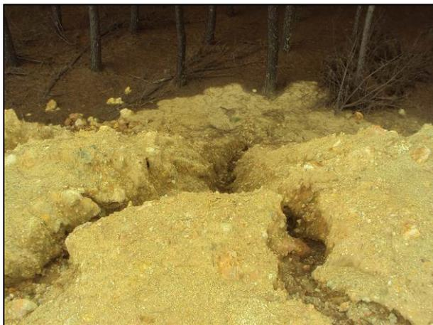
Foto 4 - Ravinação sobre a face do talude de aterro no km 46+245 (LE).
