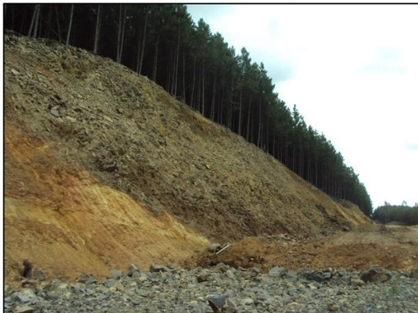
Foto 1 - Talude de corte no km 46+700 (LD). No canto inferior esquerdo é possível observar o predomínio de alteração de rocha, enquanto no restante do corte ocorre rocha alterada com blocos sãos imersos. Até o momento não ocorreu a queda de blocos, embora muitos estejam em situação instável.
