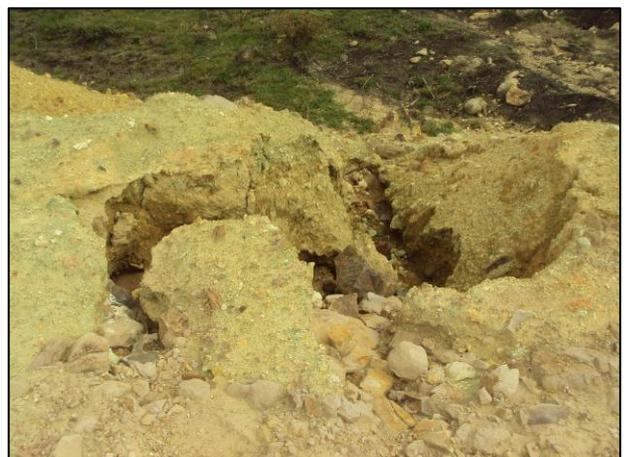
Foto 5 - Erosão severa no material colocado sobre o talude de aterro no Km 46+510 (LD).
