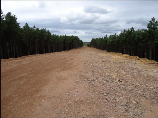
Foto 24 - Trecho do Km 47+000, no sentido do estaqueamento, onde se visualiza o leito no nível, com terraplenagem finalizada e o aterro sem alterações.
