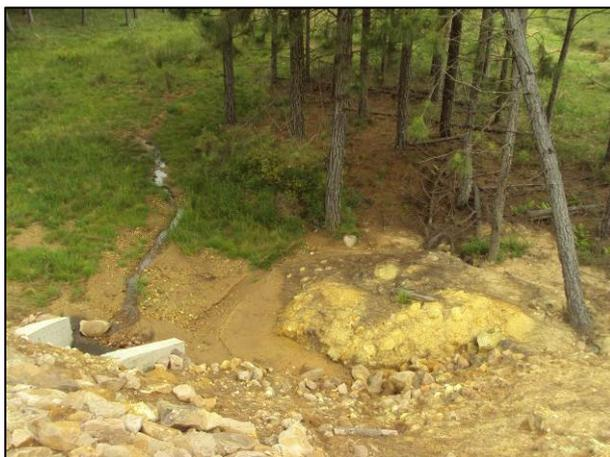
Foto 6 - Km 46+530 (LD). Material depositado junto ao talvegue resultante da erosão a montante.
