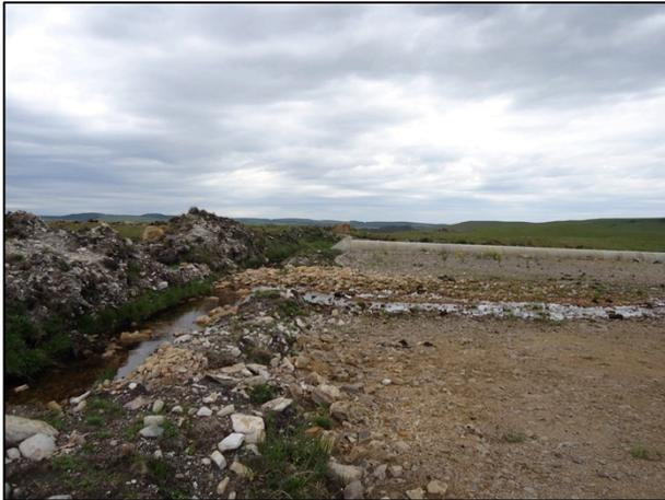
Foto 28 - Bueiro do Km 52+500, onde ocorreu barragem do curso d'água. O mesmo está passando sobre o leito da rodovia, mas não está ocorrendo processo erosivo devido às características rochosas do material.
