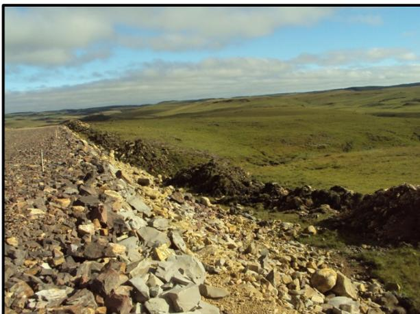
Foto 12 - Material a ser utilizado na recuperação de do trecho da estrada existentes a ser desativado.
