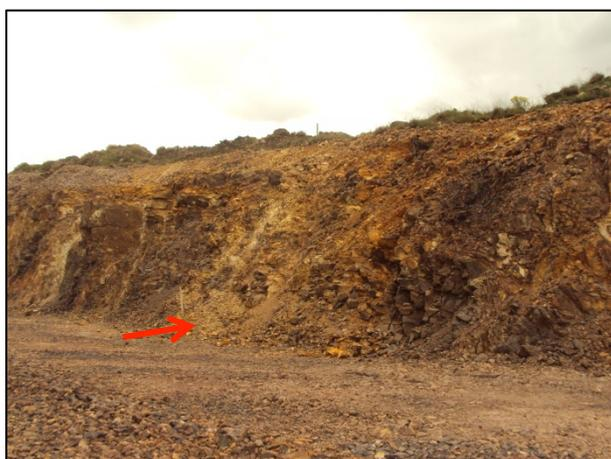
Foto 3 - Corte localizado no km 53+900 (LD) executado em rocha extremamente fraturada. Como os fraturamentos mergulham em direção ao offset, está ocorrendo a queda de placas que se acumulam no pé do corte, como indicado pela seta.
