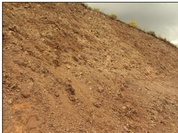
Foto 2 - Corte no km 47+800 composto basicamente de alteração de rocha e rocha alterada com pequenos blocos de rocha em menor estado de alteração imersos. Pode-se observar os blocos em situação instável sobre a face do talude. Na retomada das obras deverá ser forçada a queda destes blocos instáveis.
