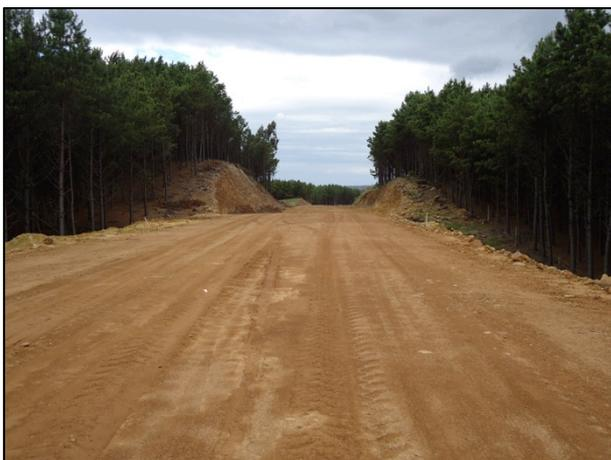
Foto 22 - Trecho do Km 46+200, no sentido do estaqueamento, onde se visualiza o leito no nível, com terraplenagem finalizado e o aterro sem alterações.
