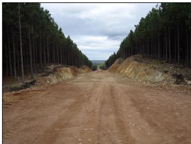
Foto 23 - Trecho do Km 46+600, no sentido do estaqueamento, onde se visualiza o talude de corte sem queda de blocos ou outras alterações.
