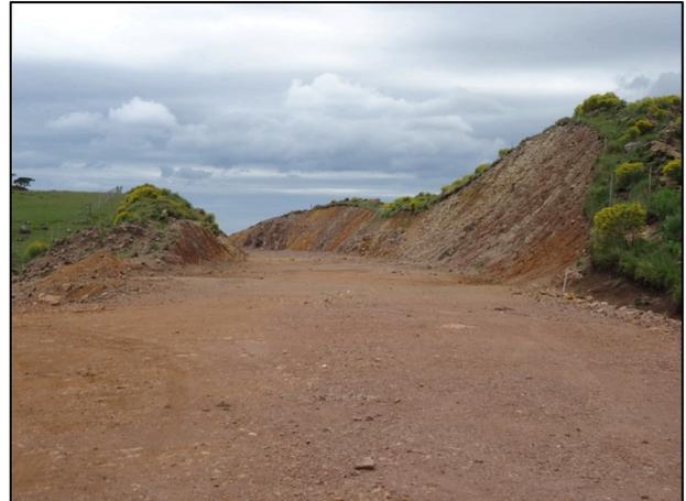
Foto 25 - Trecho do Km 47+800, no sentido do estaqueamento, onde se visualiza os taludes de corte sem queda de blocos, com leito no nível e sem alterações.
