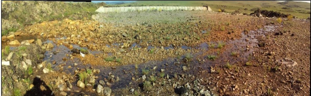
Foto 11 - Km 52+500. Bloqueio da valeta (LE) desviando o fluxo por sobre o aterro. Podemos observar que não ocorre processo erosivo no mesmo.
