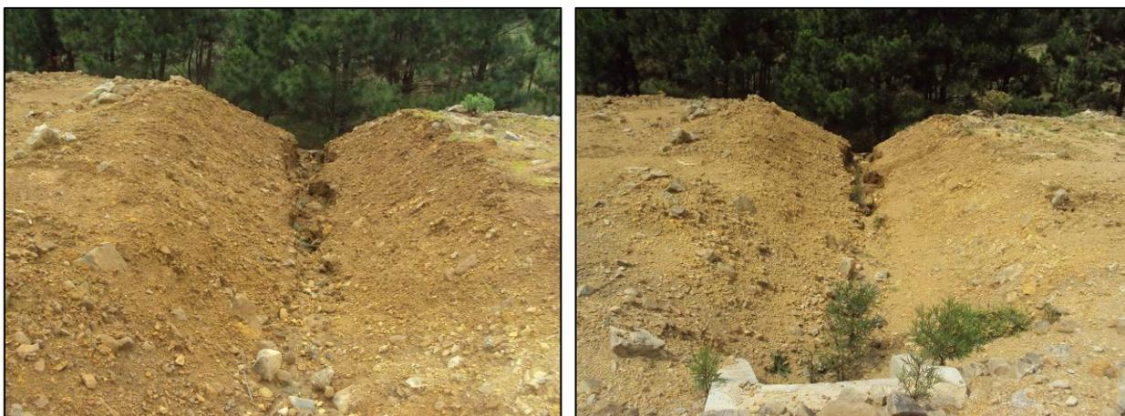
Fotos 9 e 10 - KM 46+020 (LE) – Foto esquerda tomada em julho/14 e foto direita tirada em novembro/14. Como nas fotos anteriores podemos constatar que não houve evolução do processo erosivo no período.
