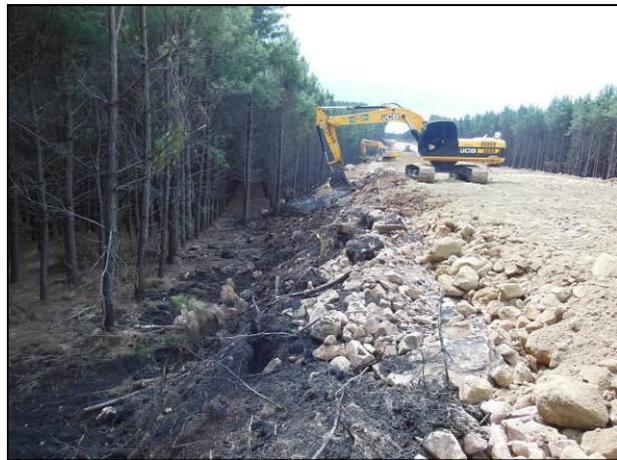
Vista em detalhe da escavadeira realizando a remoção de solo orgânico.
