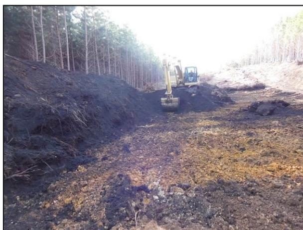
Escavadeira realizando o destocamento no trecho do Km 46+660 m.
