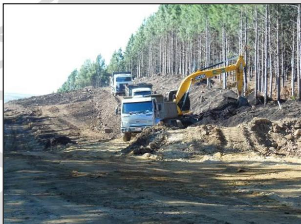
Escavadeira realizando a limpeza e destocamento no trecho do Km 46+680 m.
