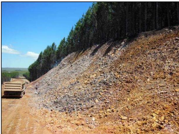
**Foto 35** - Corte km 46+720. Como no anterior, poderá ocorrer queda de blocos que ficaram instáveis após o corte. Até o momento, apesar do tráfego de veículos e máquinas pesados, isto não está ocorrendo. Observa-se que não há material acumulado no pé do talude.
