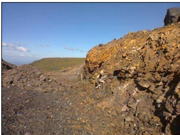
**Foto 24** - Corte km 53+950 (LD). Material muito fraturado, mergulhando na direção da rodovia. Queda de placas sendo monitorada. Causa pouca preocupação em vista da pequena altura. Antes de ser liberado o tráfego neste segmento, deverá ser forçada a queda das placas instáveis e, caso seja considerado necessário, serão sugeridas medidas de contenção (foto de mai/2013).
