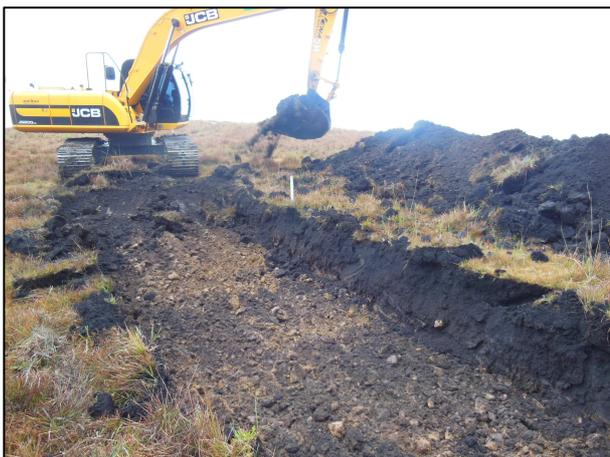
**Foto 148** - Trecho sendo escavado, com profundidade aproximada de 40 cm.
