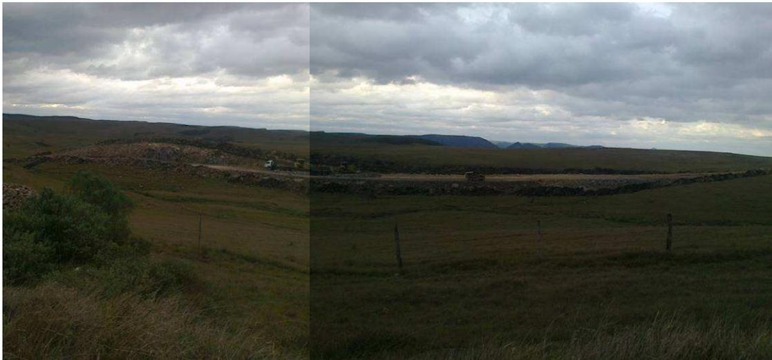
**Fotos 29 e 30** - Segmento compreendido aproximadamente entre as estacas 52+900 e 53+200, respectivamente em jun/13 e jul/13. Na foto 30 o aterro, constituído por material rochoso, está em fase final de execução.
