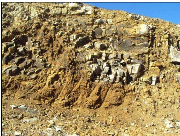
**Foto 28** - No mesmo corte da imagem anterior, foi constatada a ocorrência de material alterado sob rocha sã, quando a previsão era de que o corte fosse feito totalmente nesta última, ou seja, com inclinação 4x1. O segmento está sendo monitorado no sentido de definir se alguma medida corretiva deve ser adotada.
