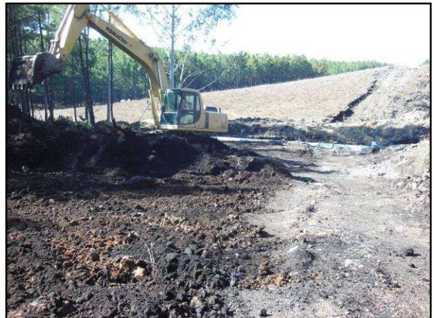
**Foto 79** – Acompanhamento da decapagem do solo e destocamento.
