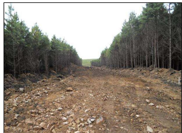
**Foto 81** – Trecho do entre Km 46+800 e 47+100, área que foi realizada a decapagem do solo e destocamento.
