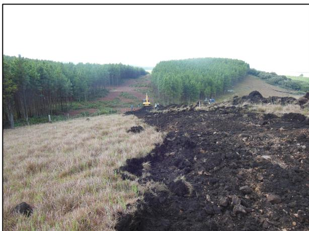
**Foto 149** - Local em que ocorreu a escavação, de linha contínua e largura de 3m.
