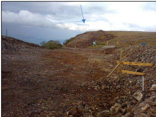
**Foto 22** - Limpeza do terreno entre as estacas 54+000 e 54+040 (jun/13).
