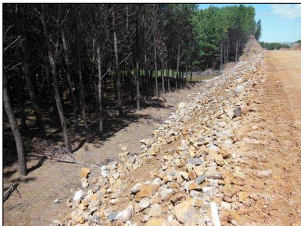
**Foto 34** - Aterro km 46+240. Constituído por blocos de rocha e alteração de rocha. Não ocorre evidência de carreamento de finos da face do talude. Como alguns blocos rolam e se depositam no pé do talude, forma-se uma proteção contra erosão pelas águas que por ali escoem antes da implantação do sistema de drenagem.
