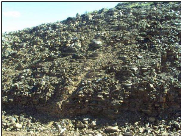
**Foto 31** - Corte no km 52+650 (LE), composto por rocha alterada, mostrando sulco erosivo ao longo de uma linha de fratura. O talude está sendo monitorado para avaliar a continuidade do processo. Até o momento não causa grande preocupação, já que o volume de material removido é insignificante e não chega a atingir o sistema hídrico a jusante.
