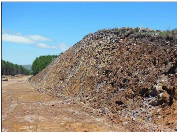
**Foto 33** - Corte km 46+420. Rocha alterada onde era prevista rocha sã. Inclinação do talude passou de 4x1 para 1x1. Existe certo risco de queda de blocos que está sendo monitorado.
