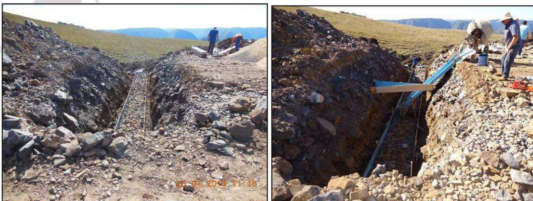
– Detonação do lado direito (restante) no Km 53+950 m e do bueiro localizado no Km 54+005 m. Em ambos os casos a explosão lançou o material em direção aos cânions, a uma distância aproximada de 25 metros.
