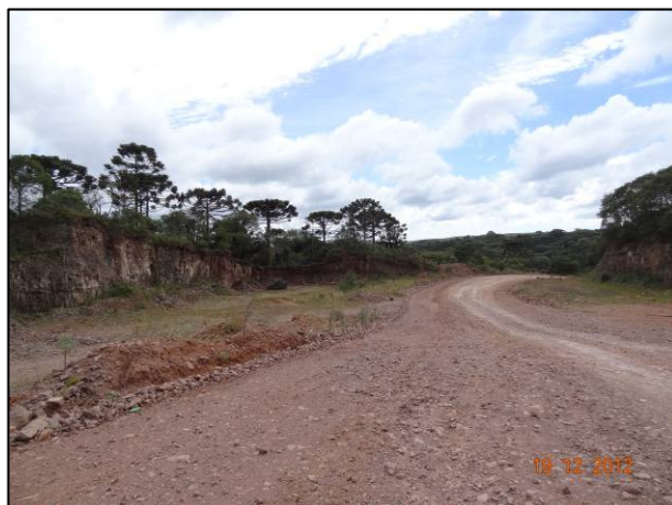
Vista da Cascalheira 1, no sentido do Rio das Antas, detalhando o lado esquerdo.
