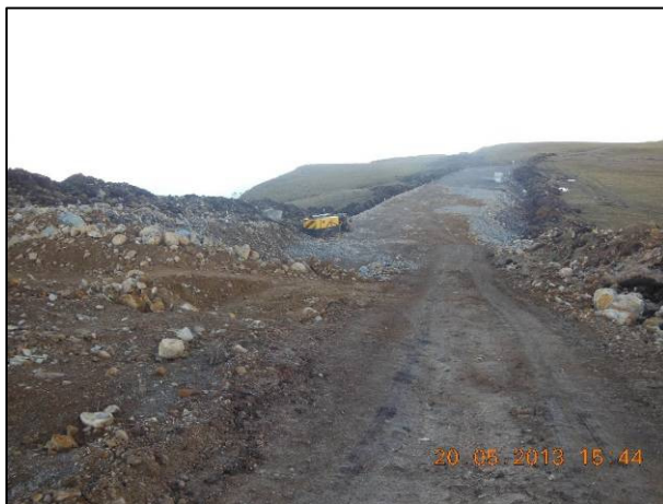
Aterro em fase final de execução.
