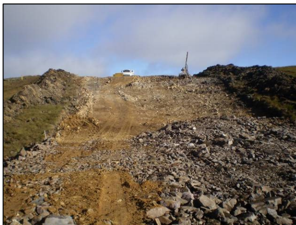
Local do corte, em 30/04/2013, antes do início do desmonte.
