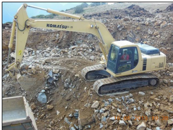
Escavadeira PC-200 EH-205.
