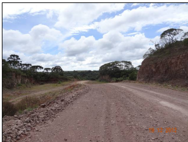
Vista da Cascalheira 1, no sentido do Rio das Antas.
