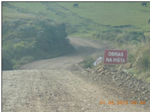
Placa de obras na pista.
