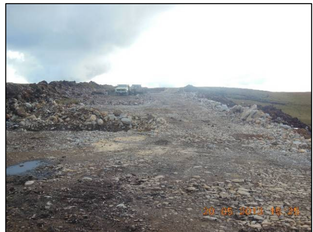
Final da terraplenagem no km 53+120 m.
