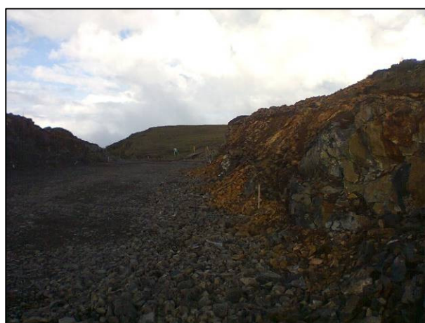
Tomada em 20/05/2013. Face do talude de corte rebaixada, visando evitar uma possível queda de material.
