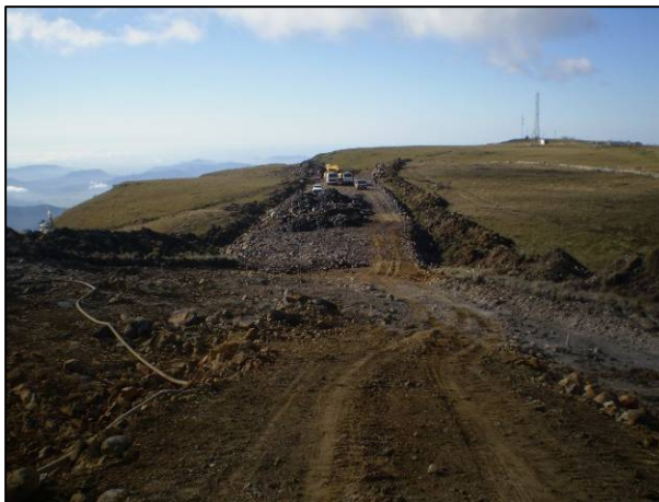
Tomada em 30/04/2013. Aterro em fase intermediária de implantação. Observar material oriundo da limpeza, depositado ao lado do offset .
