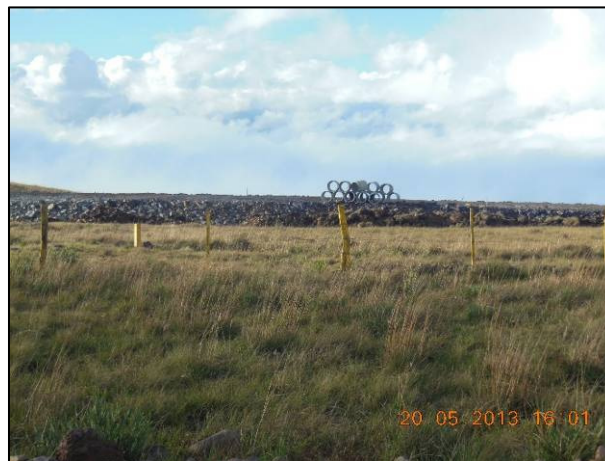
Vista lateral do aterro, praticamente concluído.
