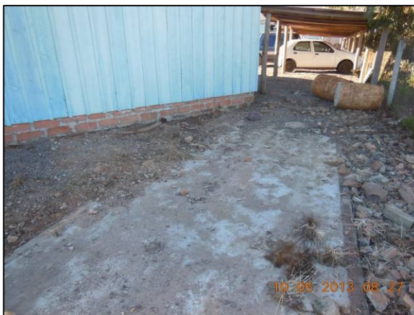
Fossa séptica instalada atrás do alojamento.
