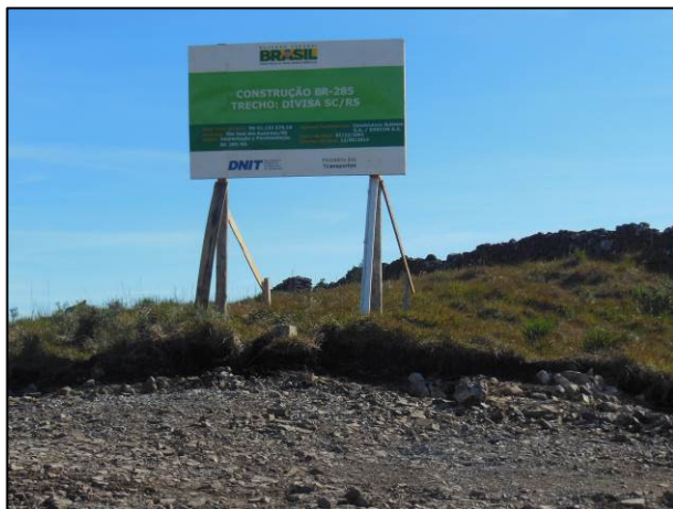
Placa informativa da obra.
