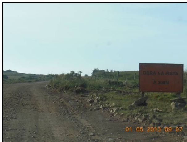
Placa informativa de obras na pista, a 300m.
