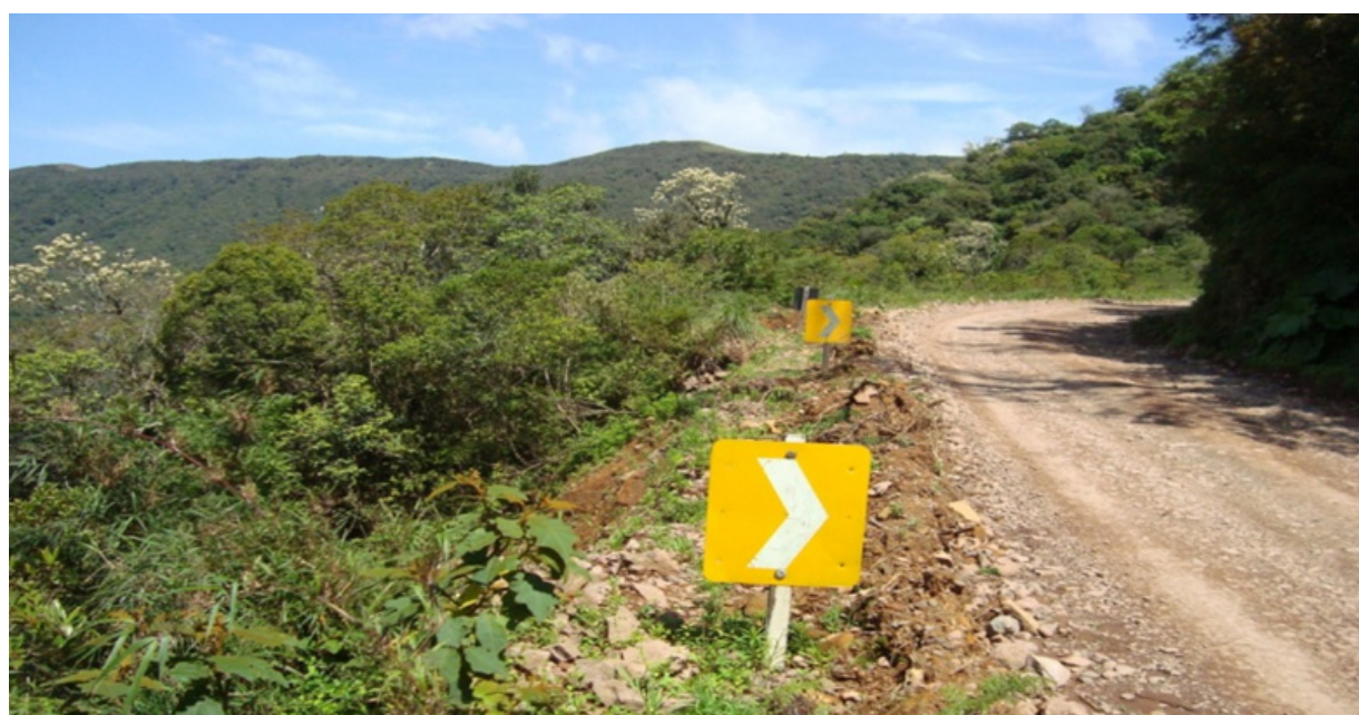
FIGURA 2.11 - LOCAL DE IMPLANTAÇÃO DE UM DOS VIADUTOS
