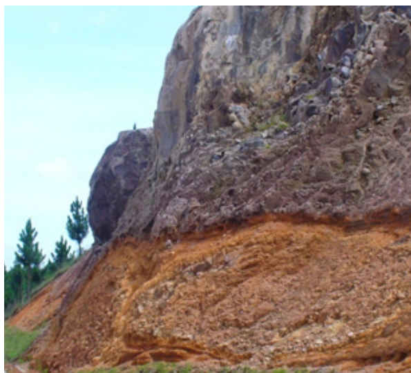
FIGURA 3.10 - ÁREAS COM RISCO DE DESLIZAMENTOS DE MATERIAL INTEMPERIZADO (ELÚVIO) SOB BLOCOS ROCHOSOS EM CORTE DE ESTRADA
