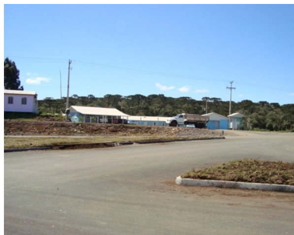
FIGURA 2.18 - INSTALAÇÕES DO CANTEIRO DE OBRA DA CONSTUTORA SULTEPA S.A.
