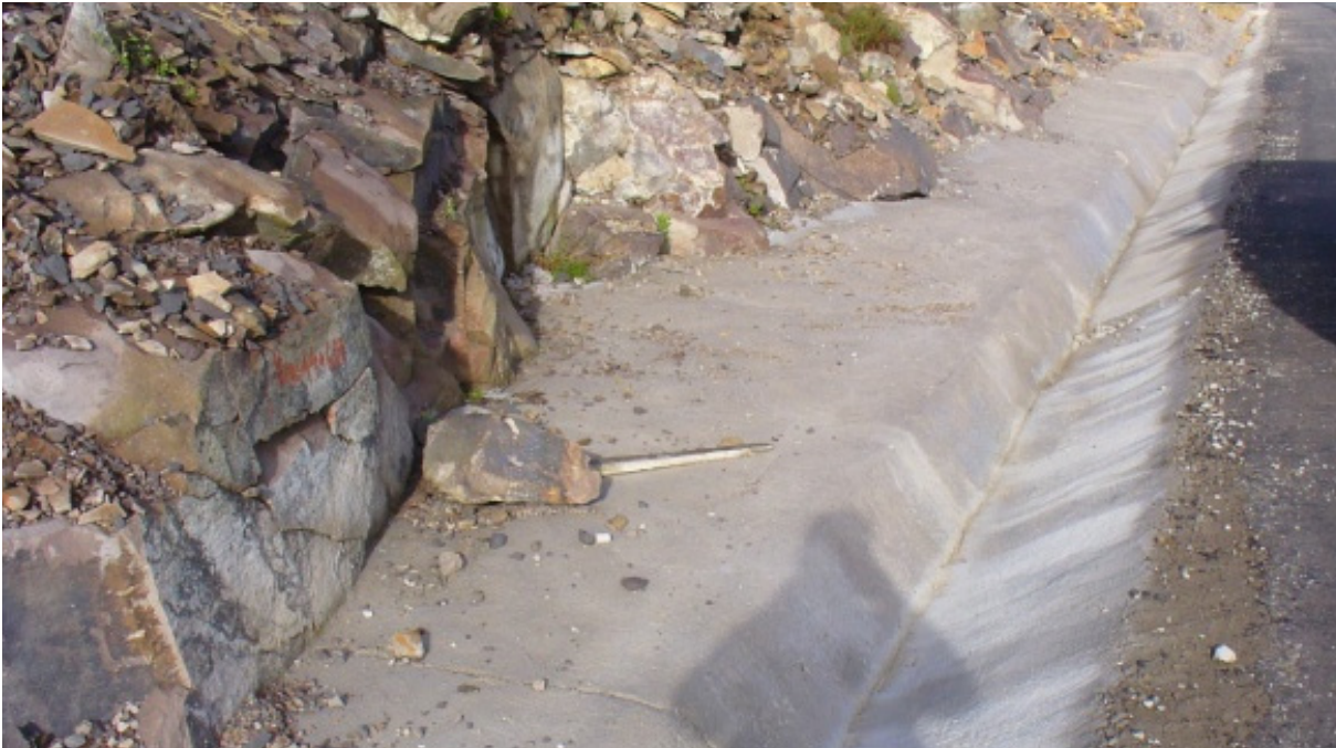
FIGURA 3.16 – AFLORAMENTOS DE ROCHAS VULCÂNICAS EM BLOCOS POUCO FRATURADOS E POUCO ALTERADOS. SÃO ADEQUADAS PARA RECEBER AS CARGAS DA FUTURA RODOVIA
