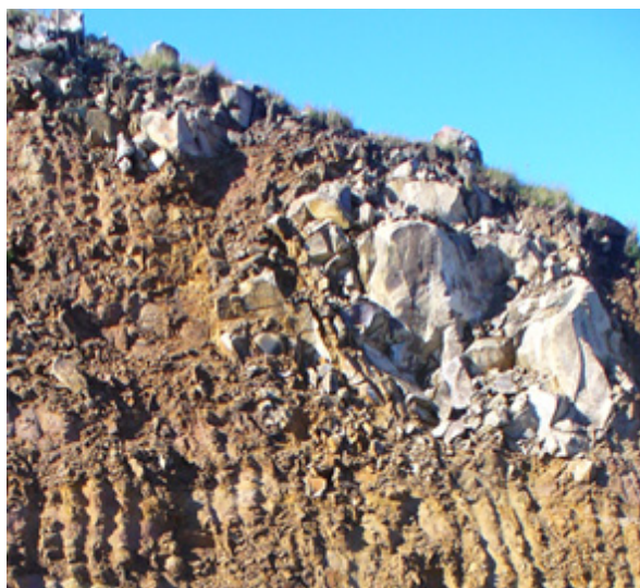
FIGURA 3.10 - ÁREAS COM RISCO DE DESLIZAMENTOS DE MATERIAL INTEMPERIZADO (ELÚVIO) SOB BLOCOS ROCHOSOS EM CORTE DE ESTRADA
