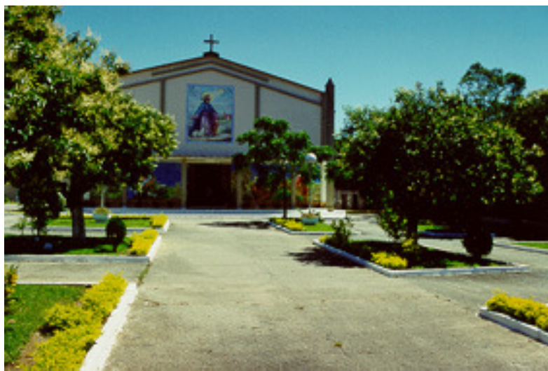
FIGURA 5.3.82 - VISTA DE TIMBÉ DO SUL
