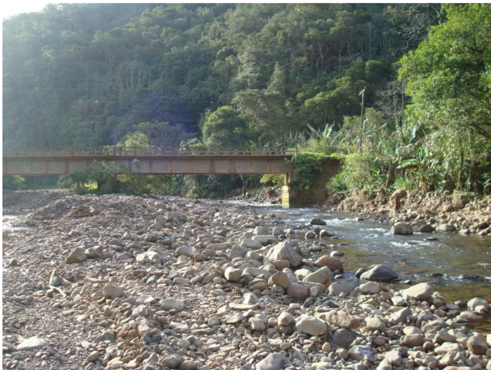
FIGURA 5.2.97 - PONTO 7, NO RIO SERRA VELHA
