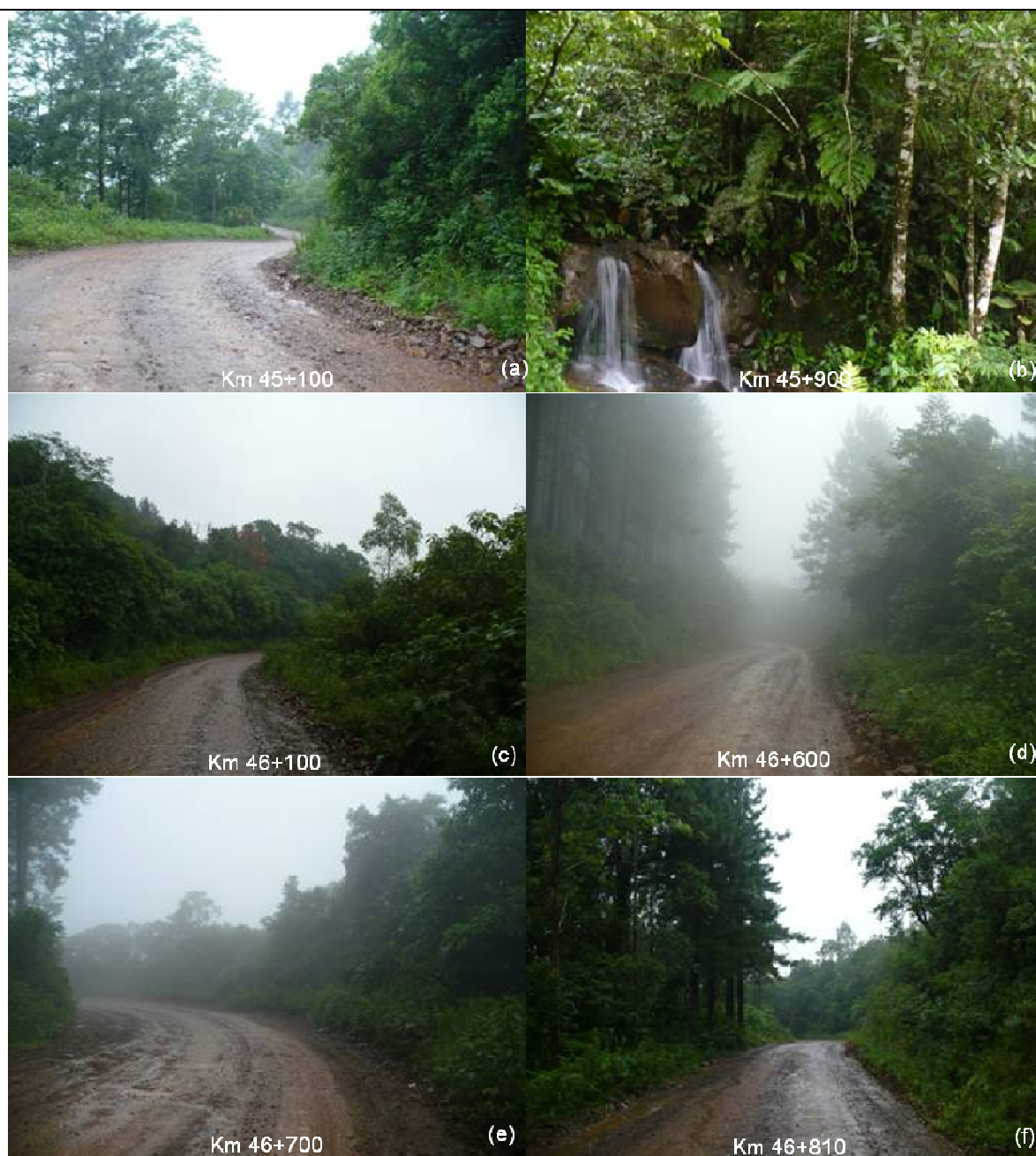
FIGURA 5.2.44 – (a) DETALHE DO TRECHO; (b) DETALHE DE UM DOS CORPOS HÍDRICOS PRESENTES AO LONGO DA RODOVIA. PRESENÇA DE VEGETAÇÃO ARBÓREA PRESERVANDO A MATA CILIAR NESSE PONTO; (c) DETALHE DO SEGMENTO, AO CENTRO UM EXEMPLAR DE Erithryna falcata ; (d) DETALHE DO SEGMENTO, APRESENTANDO NESSE PONTO PLANTIOS COMERCIAIS DE PINHEIRO-AMERICANO ( Pinus elliottii ); (e) E (f) DETALHE DO TRECHO.
