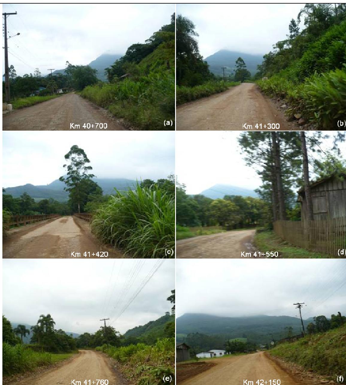
FIGURA 5.2.41 – (a) DETALHE DO TRECHO; (b) DETALHE DO TRECHO. COMEÇA A DIMINUIR O NÚMERO DE RESIDÊNCIAS, MAS OS IMPACTOS CAUSADOS NO MEIO DEVIDO A PLANTIOS DE CULTURAS ANUAIS PERMANECEM OS MESMOS; (c) PONTE SOBRE O RIO SERRA VELHA, HAVENDO NECESSIDADE DE RECUPERAÇÃO DA VEGETAÇÃO CILIAR; (d), (e) E (f) DETALHE DO TRECHO.
