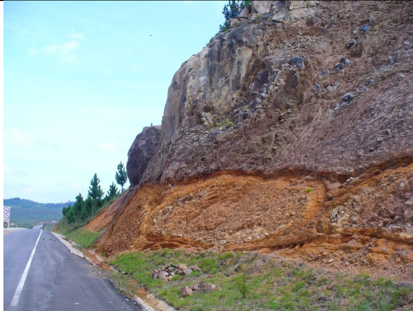
FIGURA 5.1.23 - DESLIZAMENTOS DE MATERIAL INTEMPERIZADO (ELÚVIO) SOB BLOCOS ROCHOSOS EM CORTE – ENTRE A SEDE DE SÃO JOSÉ DOS AUSENTES E A PEDREIRA
