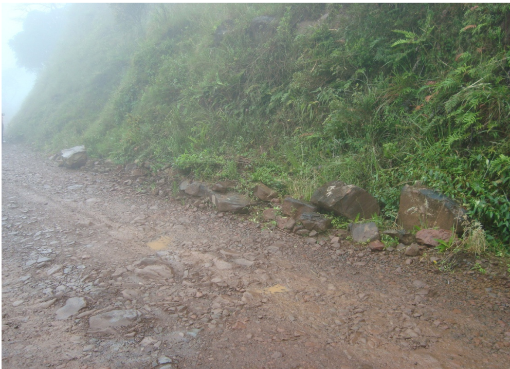
FIGURA 5.1.28 - FOTO: ESCORREGAMENTO DE SOLO E BLOCOS DE ROCHA COORDENADAS: LAT.: 6.813.587 N / LONG.:602.619 E / ALTITUDE: 1.112 M
