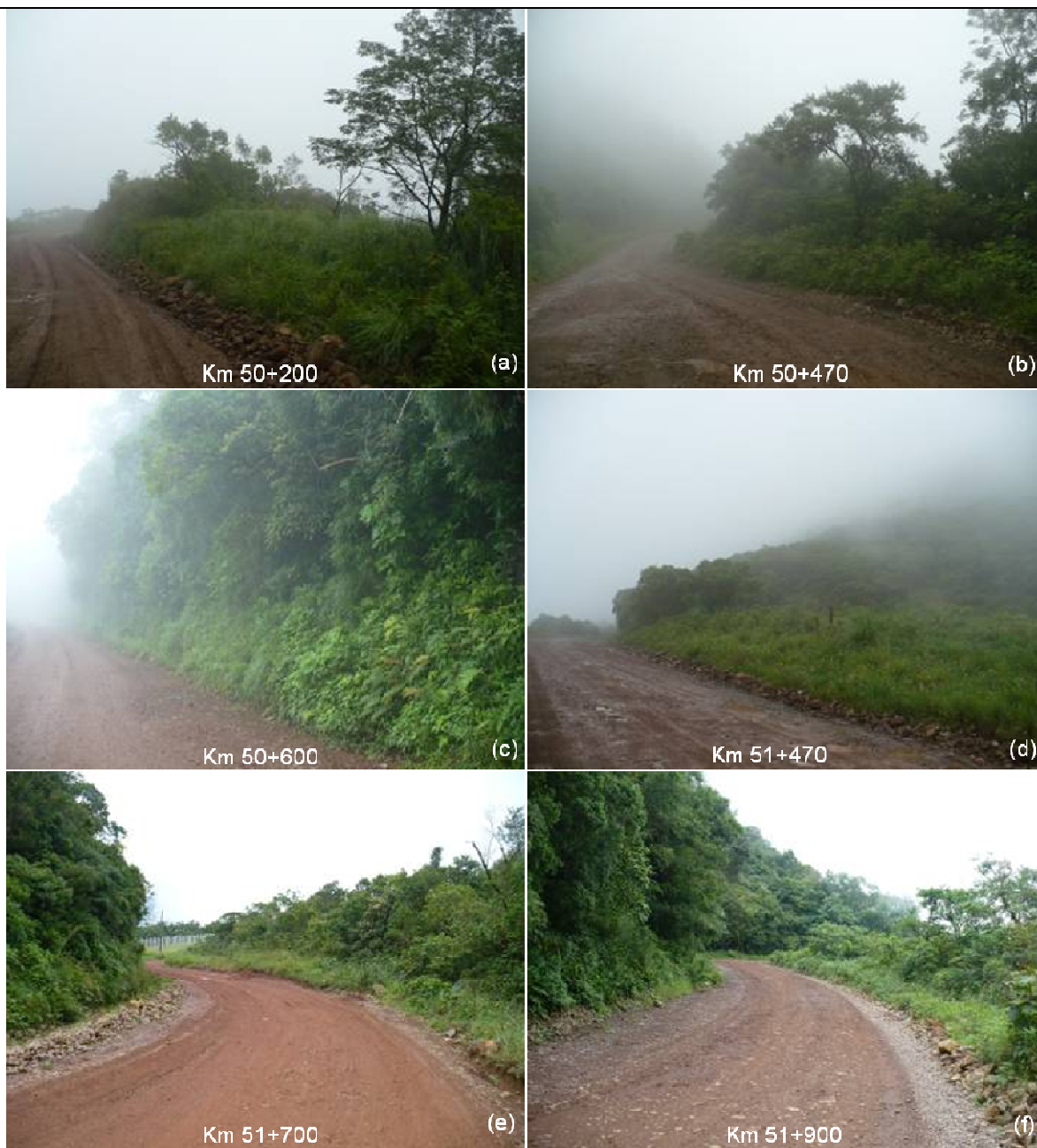
FIGURA 5.2.46.B – (A), (B) E (C) DETALHE DO TRECHO; (D) DETALHE DO TRECHO. NESSE PONTO EXISTE O TÚNEL DO GASBOL; (E) E (F) DETALHE DO TRECHO.
