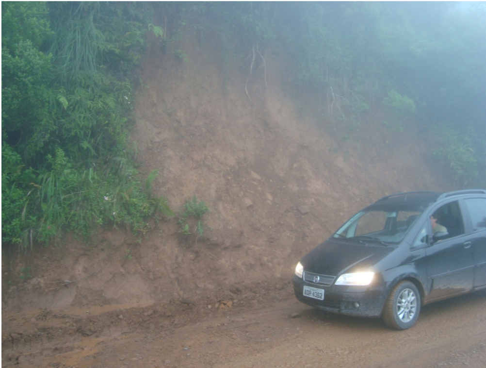
FIGURA 5.1.31 - FOTO: ESCORREGAMENTO DE SOLO COORDENADAS: LAT.: 6.813.150 N / LONG.:604.560 E / ALTITUDE: 650 M
