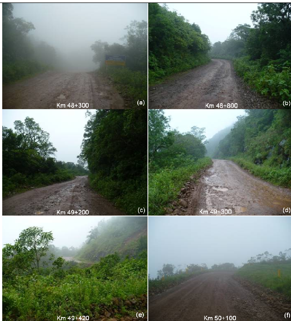
FIGURA 5.2.46.A – (a) PROXIMIDADES DO POSTO DE FISCALIZAÇÃO SANITÁRIA; (b) DETALHE DO TRECHO. VEGETAÇÃO EM ESTÁGIO INICIAL EM TODO O TRECHO, SALIENTANDO QUE ESTE ESTÁGIO SOMENTE NA ÁREA DA FAIXA DE DOMÍNIO; (c) E (d) DETALHE DO TRECHO; (e) DETALHE DE UM SEGMENTO ONDE DEVERÁ HAVER RETIFICAÇÃO, NESSE PONTO A RODOVIA SEGUIRÁ RETA. A VEGETAÇÃO EXISTENTE NO VALE É COMPOSTA BASICAMENTE POR ESTÁGIO INICIAL DE REGENERAÇÃO E (f) UM DOS PONTOS ONDE A RODOVIA É CORTADA PELO GASBOL.
