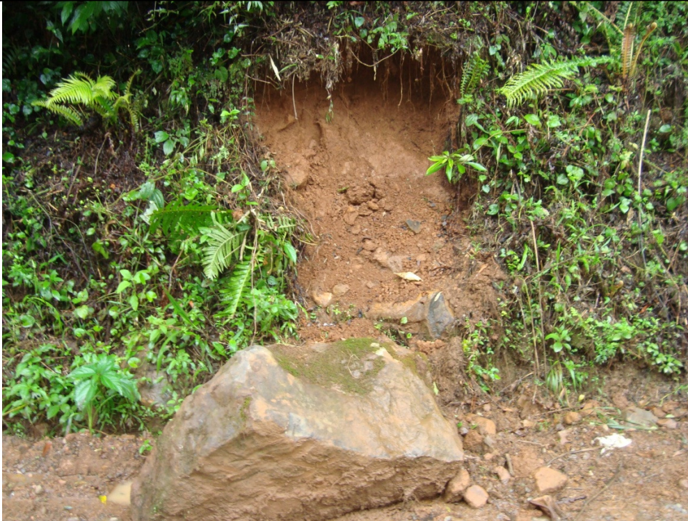
FIGURA 5.1.32 - FOTO: BLOCO DE ROCHA CAÍDO SOBRE A ESTRADA COORDENADAS: LAT.: 6.812.890 N / LONG.:605.334 E / ALTITUDE: 374 M
