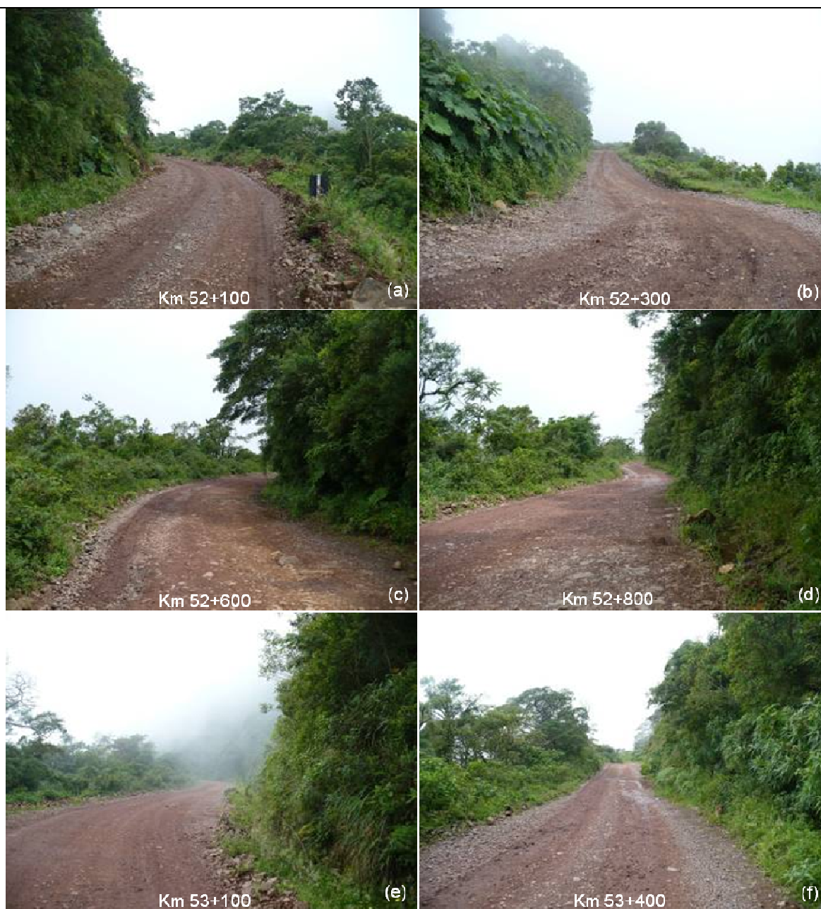
FIGURA 5.2.47 A – (A) DETALHE DO TRECHO; (B) DETALHE DO TRECHO. DETALHE DA OCORRÊNCIA DE GUNERA SP.; (C), (D), (E) E (F) DETALHE DO TRECHO.
