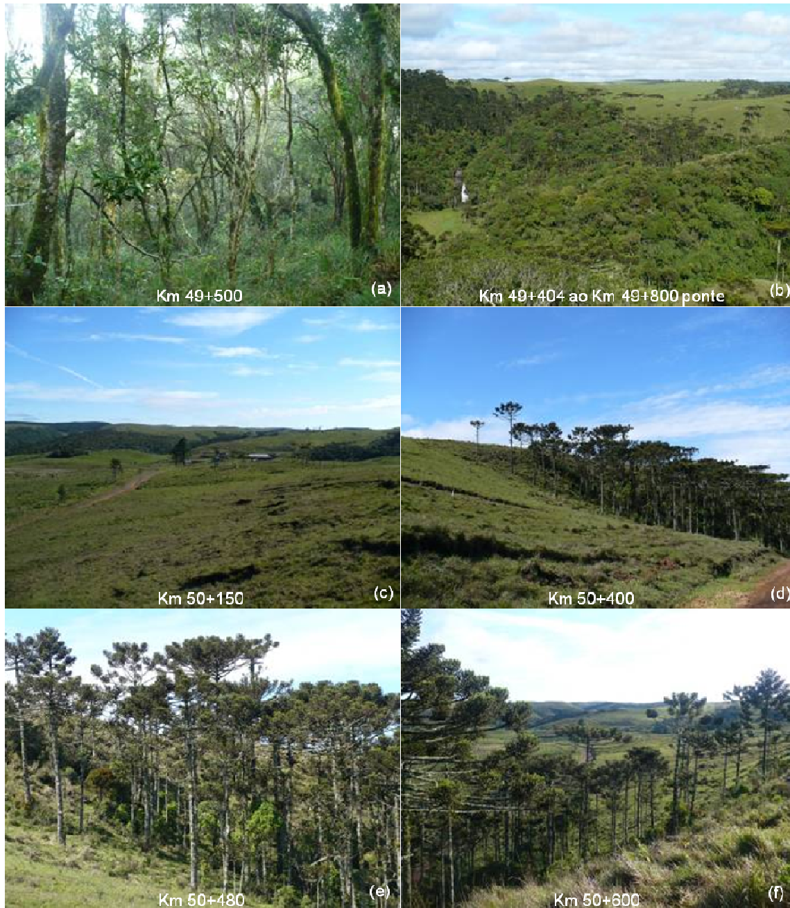
FIGURA 5.2.37 – (a) DETALHE DE UM DOS SEGMENTOS ONDE DEVERÁ SER CONSTRUÍDO UM DOS PILARES DO VIADUTO SOBRE O RIO DAS ANTAS (COMPRIMENTO DE APROXIMADAMENTE 400 METROS); (b) DETALHE DO LOCAL ONDE SERÁ IMPLANTADO O VIADUTO; (c) APÓS A SAÍDA DO VIADUTO UMA PEQUENA ÁREA COM CAMPO; (d) NA SEQUÊNCIA O TRAÇADO DA RODOVIA INTERCEPTA (À ESQUERDA) UM PEQUENO FRAGMENTO DE Araucaria angustifolia , SEM SUBOSQUE; (e) E (f) DETALHE DO FRAGMENTO A SER INTERCEPTADO.
