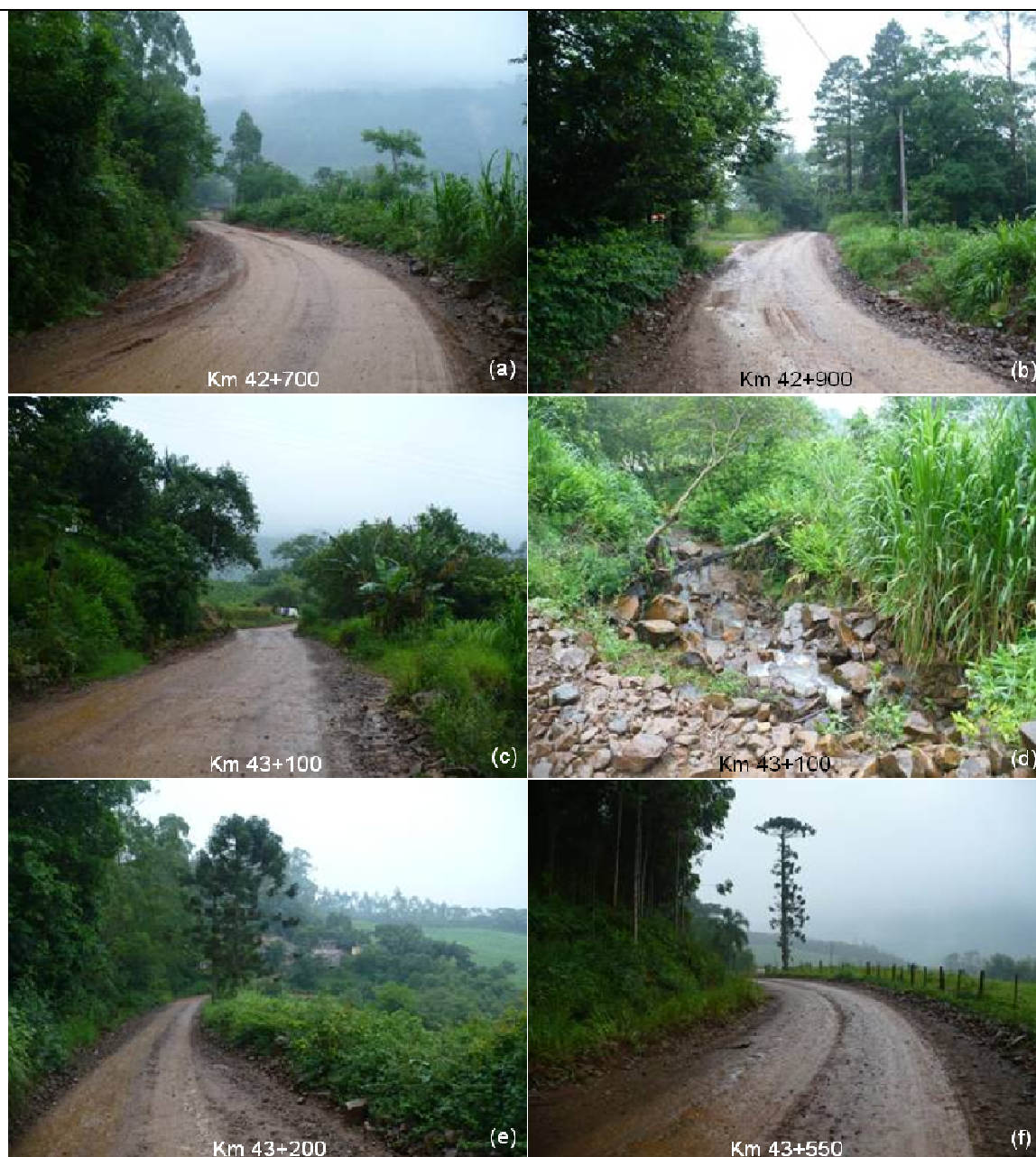
FIGURA 5.2.42 – (a) INÍCIO DA PARTE DA SERRA, O NÚMERO DE RESIDÊNCIAS SE REDUZ DRÁSTICAMENTE DEVIDO AS DIFICULDADES DE ACESSIBILIDADE DE TERRENO. MAS A VEGETAÇÃO AO LONGO DE TODO O SEGMENTO ESTÁ MUITO ALTERADA, OCORRENDO, NA SUA MAIOR PARTE VEGETAÇÃO EM ESTÁGIO INICIAL DE REGENERAÇÃO, NA FAIXA DE DOMÍNIO DA RODOVIA; (b) DETALHE DO TRECHO; (c) DETALHE DO TRECHO, SALIENTA-SE QUE A RODOVIA É RECORTADA POR INÚMEROS ARROIOS DEVIDO A REGIÃO SER PROVIDA DE BASTANTES CORPOS HÍDRICOS (NASCENTES), COMO PODE SER OBSERVADO NA FOTO APRESENTADA A SEGUIR; (d) DETALHE DE UM DOS CORPOS HÍDRICOS; (e) DETALHE DO TRECHO E (f) DETALHE DO TRECHO. OBSERVA-SE CAMPO E PLANTIO DE EUCALIPTO.
