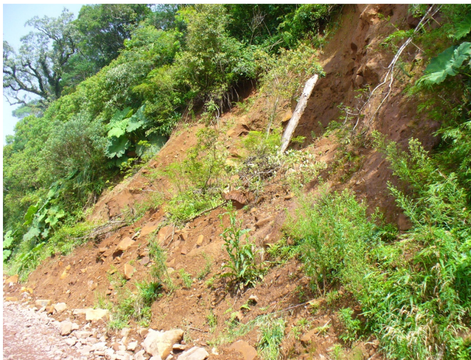
FIGURA 3.1.13 – FOTO: PONTO SUSCETÍVEL A DESLIZAMENTOS FREQUENTES
