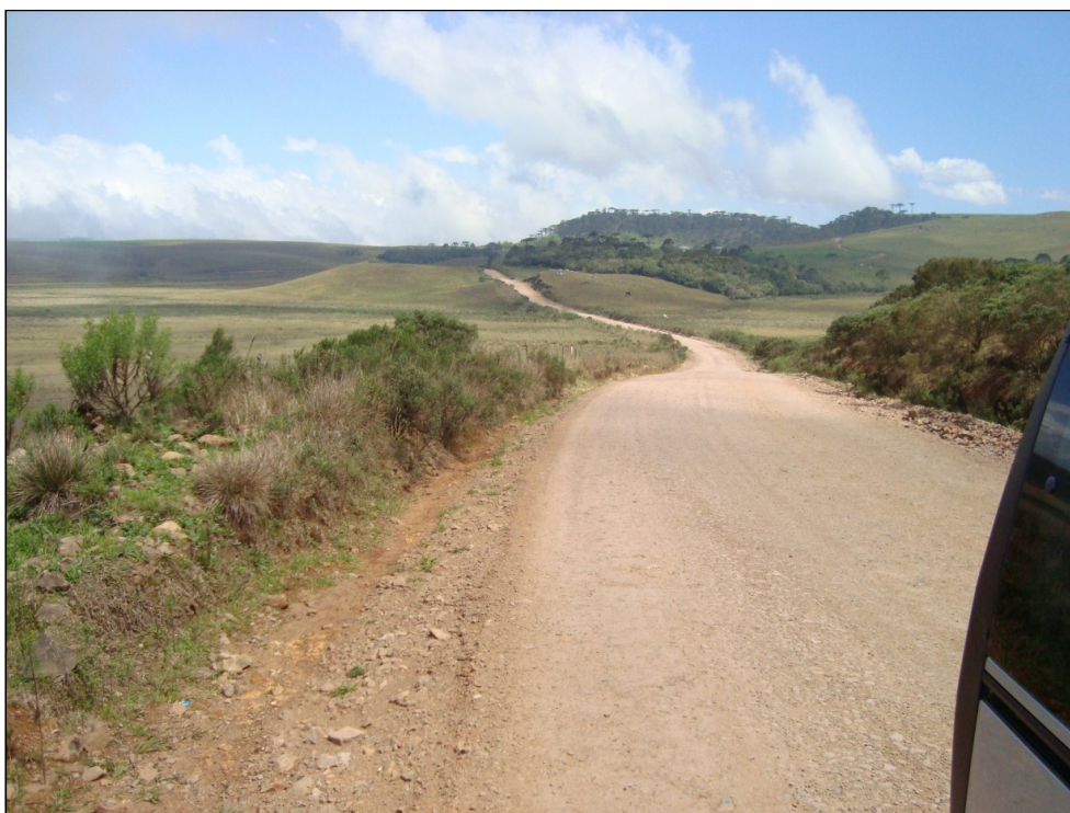
FIGURA 2.1.2 – FOTO: CONDIÇÃO ATUAL DA BR-285 NO RIO GRANDE DO SUL
