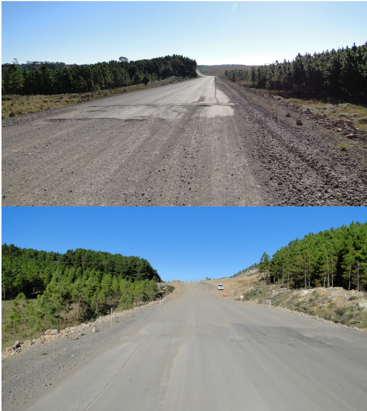
FIGURA 3.1.9 – FOTO: FINAL DO TRECHO PAVIMENTADO – KM 45+800,00 M
