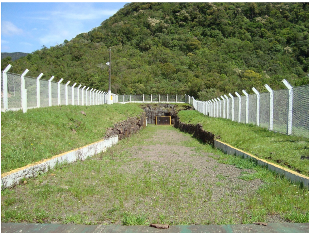
FIGURA 3.1.12 – FOTO: TÚNEL DO GASBOL
