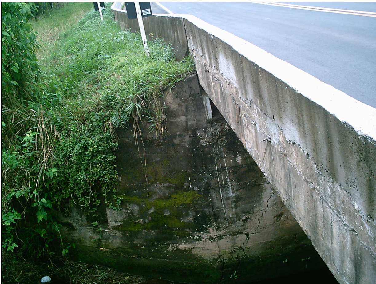
Figura 10 – Ponte sobre o rio km 25 – Araquari.
