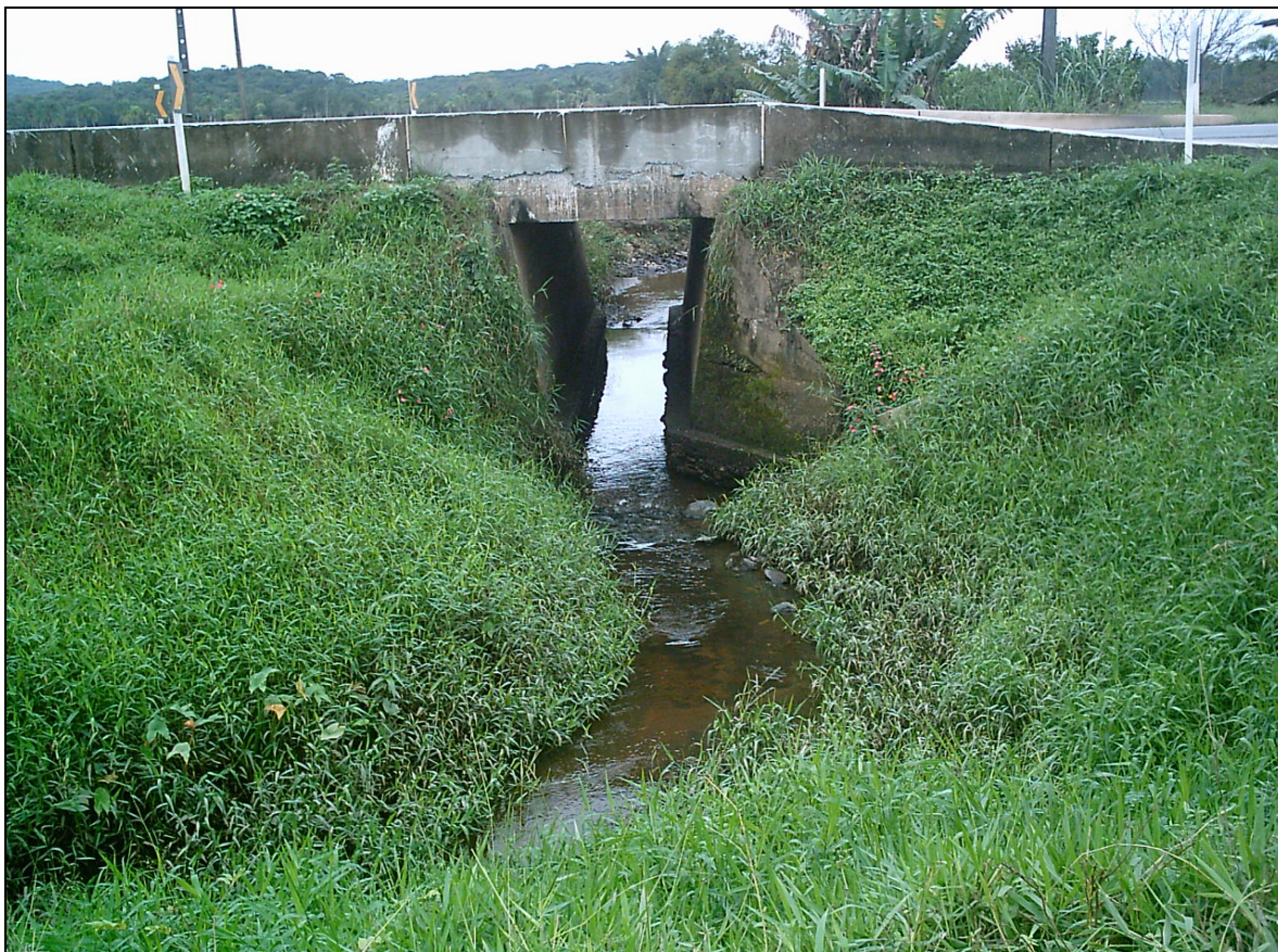
Figura 7 – Ponte sobre o rio Parati.
