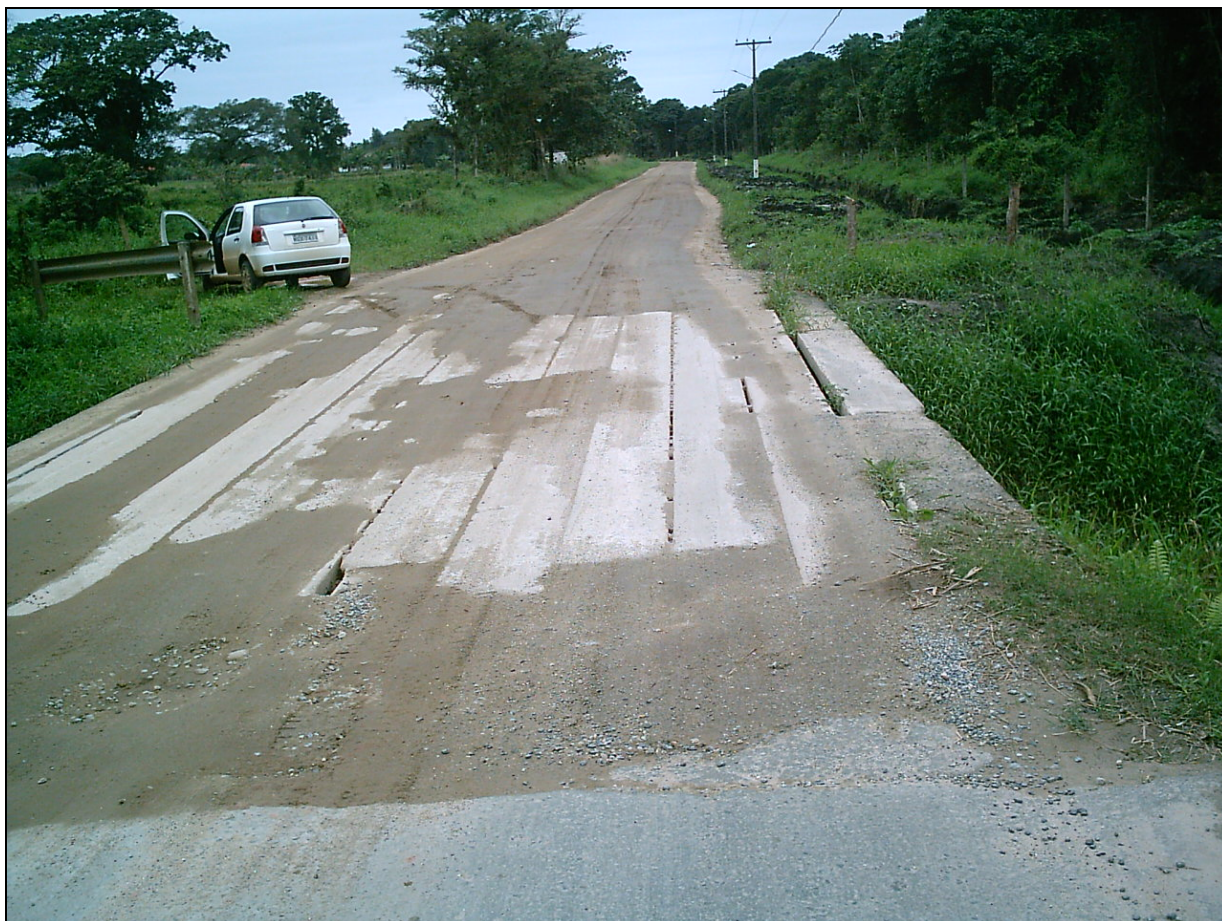
Figura 18 – Ponte sobre o rio Taperá.
