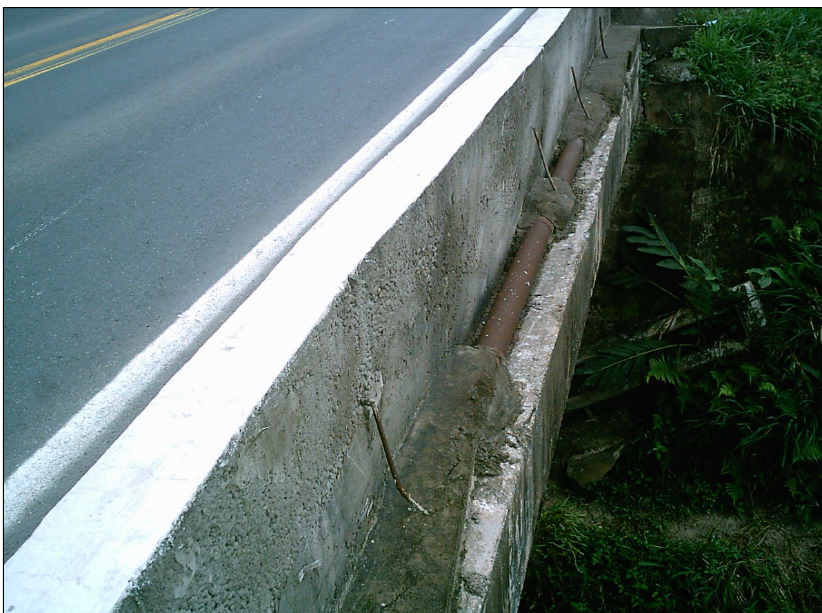
Figura 13 – Ponte sobre o canal Miranda.
