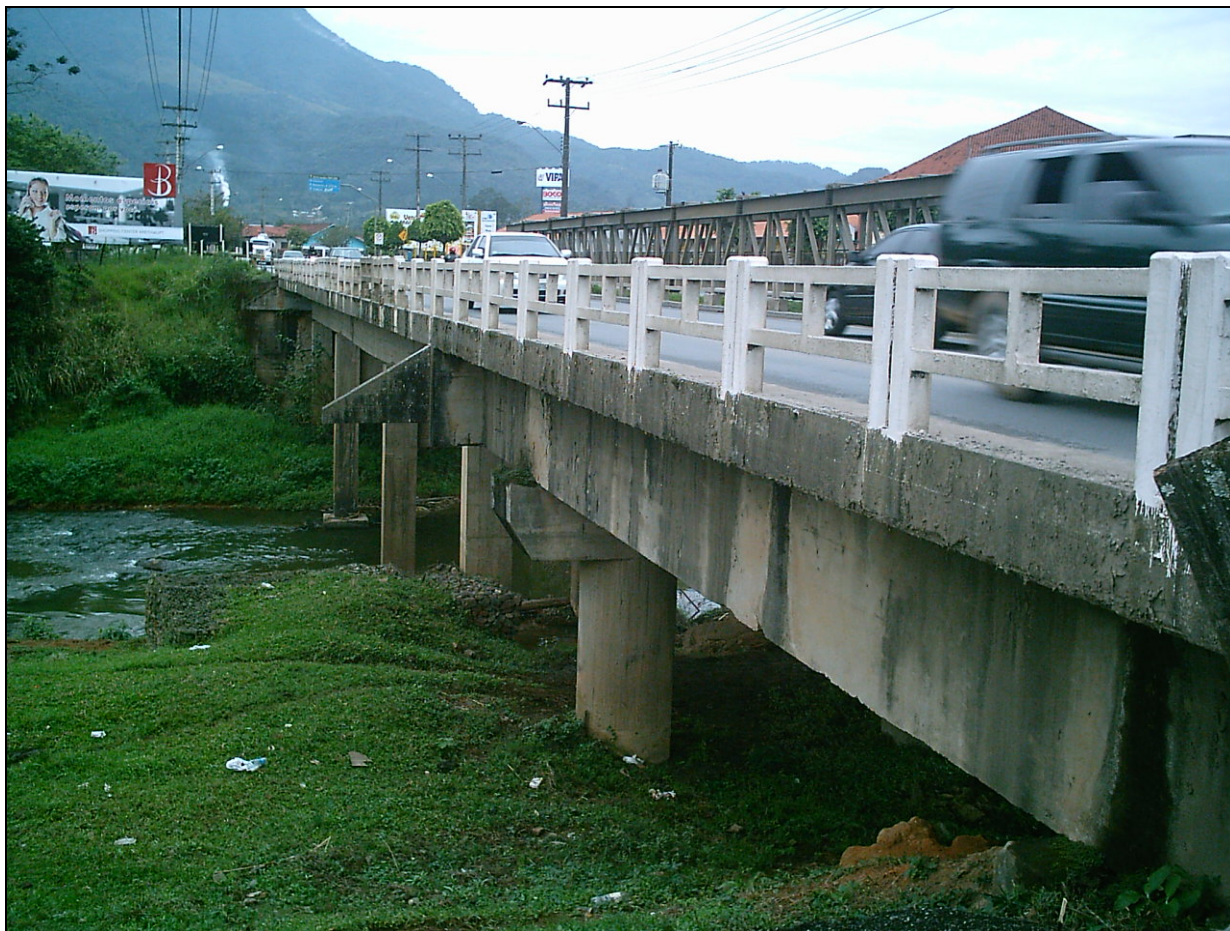
Figura 3 – Ponte sobre rio Itapocuzinho (divisa dos municípios Guramirim/Jaraguá do Sul).
