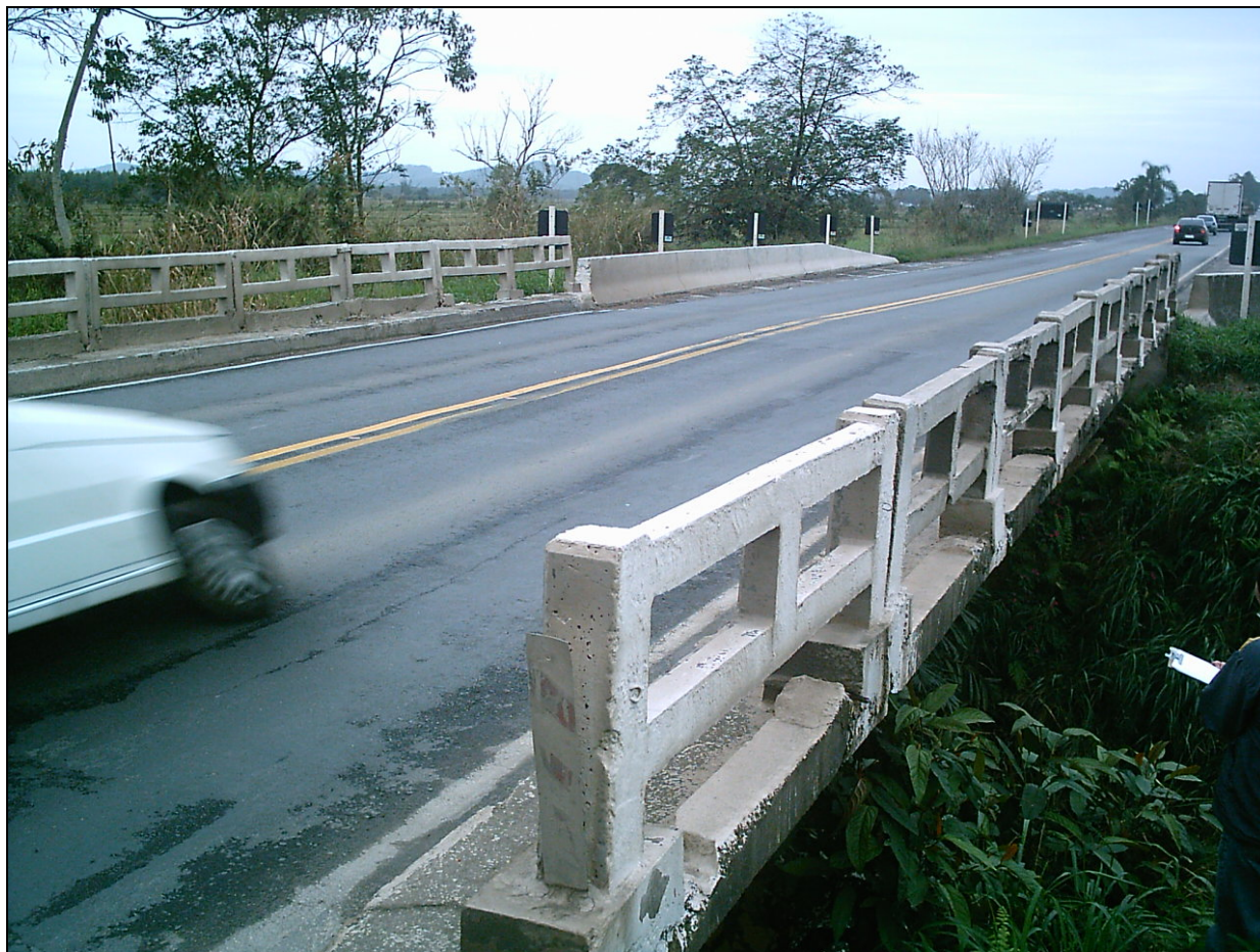
Figura 5 – Ponte sobre o Rio Corticeirinha.
