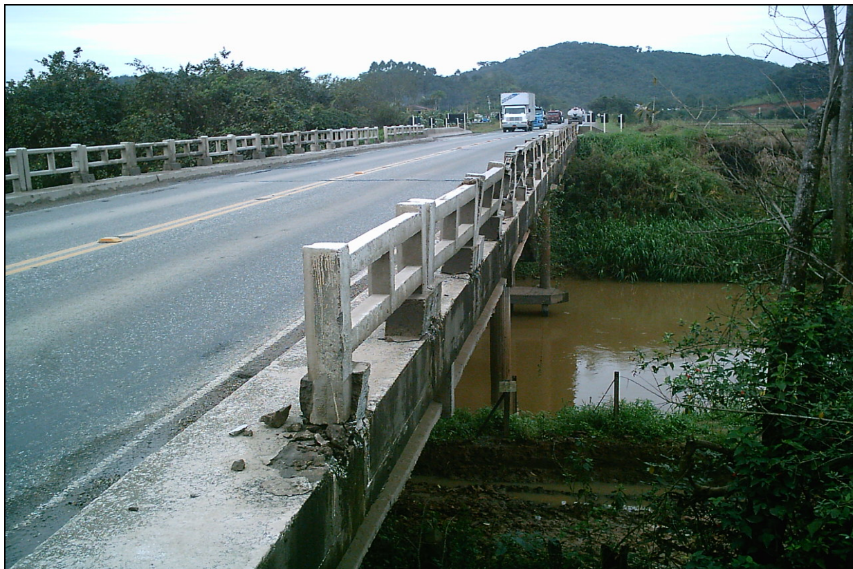
Figura 6 – Ponte sobre o rio Pirai.
