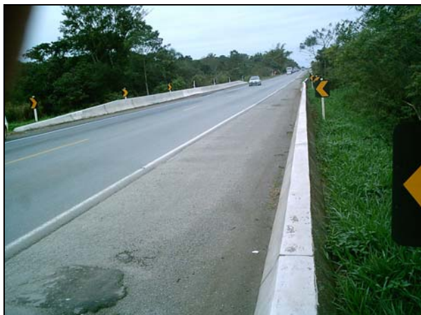
Figura 11 – Ponte canal no km 22 – Araquari. Fonte: Primária, 2008.
