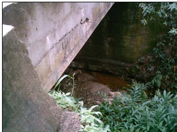
Figura 16 – Córrego canal km 10.
