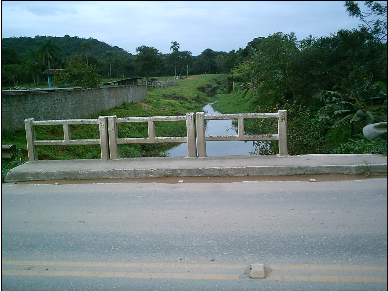
Figura 19 – Ponte sobre o rio Monte de Trigo.
