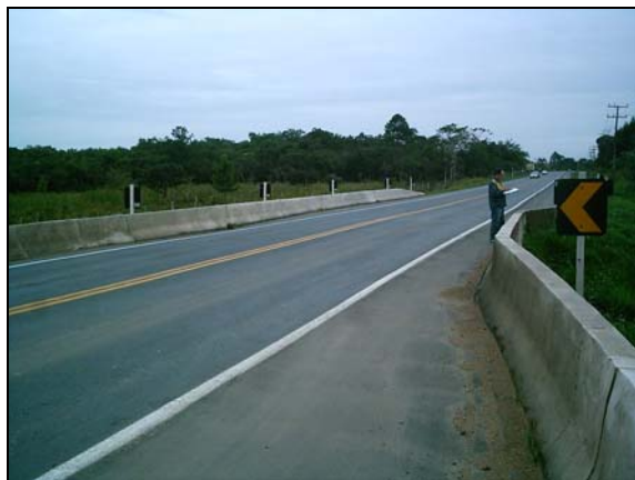
Figura 8 – Ponte canal km 28.
