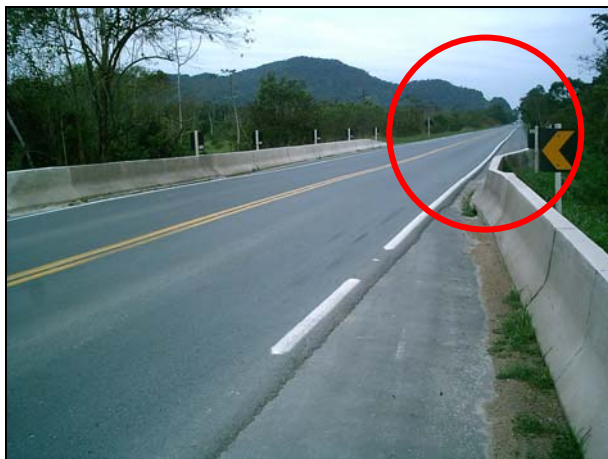
Figura 14 – Ponte canal km 14.
