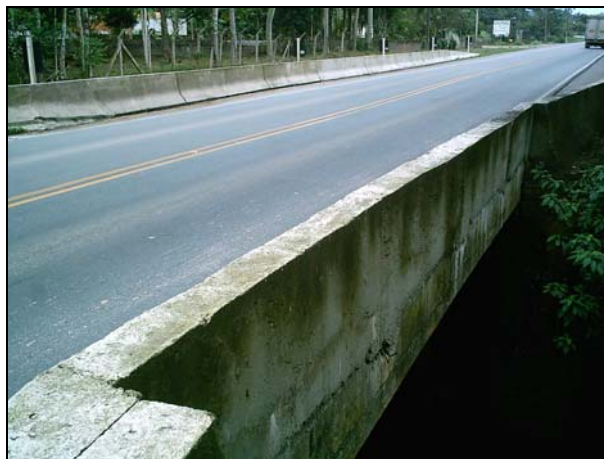
Figura 17 – Ponte canal km 10.
