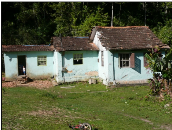
Figura 6.219 – Lote 1. Trecho 1. Unidade residencial próxima à sondagem 2, na ADA (ALVES, 2008).
