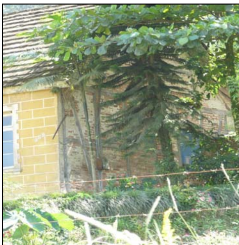
Figura 6.249 – Lote 2. Trecho 3. Casa em enxaimel, com reboco disfarçando fachada, em Schroeder I, UTM 693868 – 7074111, na AID (ALVES, 2008).
