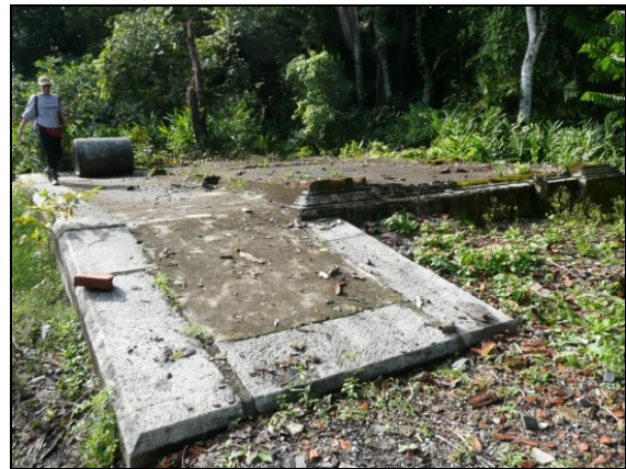
Figura 6.233 – Lote 1. Trecho 4. A base da pequena estação do Linguado indica que se tratava de prédio de alvenaria de tijolo (ALVES, 2008).
