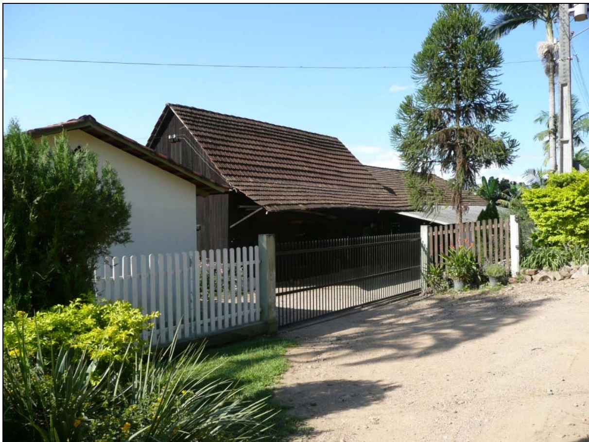
Figura 6.263 – Lote 2. Trecho 6. Propriedade de Moacir Mezadri, Rua Alvin Koch nº 982, na ADA (ALVES, 2008).
