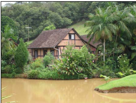
Figura 6.241 – Lote 1. Trecho 6. Casa em enxaimel, da família Bohn, UTM 719493 – 707335, na BR-101, em antigo traçado da estrada Catharina, localidade de Corveta, na AID (ALVES, 2008).
