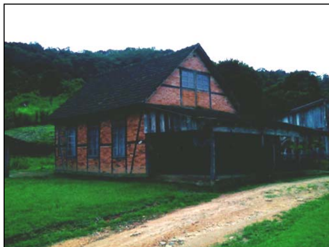
Figura 6.250 – Lote 2. Trecho 3. Primeira escola de Schroeder I, em enxaimel, relocada para a Vila Amizade, para uso residencial, pelo comprador, família Lombardi, UTM 696999 – 7072024, na AID (BANDEIRA, 2008).
