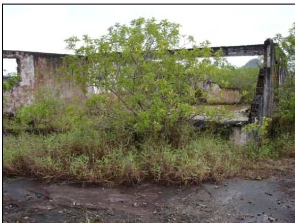
Figura 6.224 – Lote 1. Trecho 2. Ruína de construção recente, em área próxima à sondagem 6, na ADA (ALVES, 2008).
