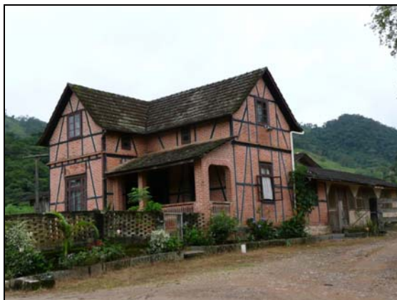
Figura 6.261 – Lote 2. Trecho 5. Enxaimel próxima da ADA, UTM 689253 – 7074424. Cadastro IPHAN JGS022 (ALVES, 2008).
