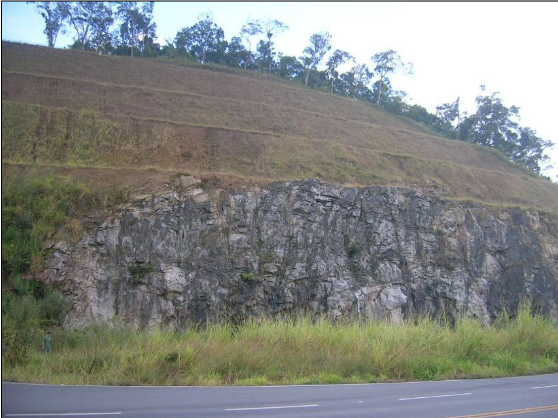
Figura 6.31 – Afloramento rochoso de gnaisses do Complexo Luís Alves em talude à margem da rodovia SC-413, ponto 1.
