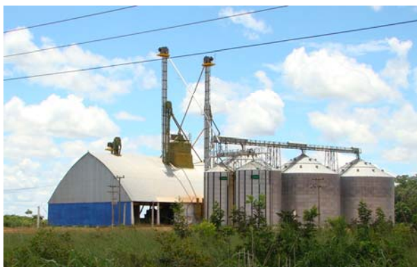
Figura 7-17: Silo - Nova Ubitatã, início do traçado da BR-242.
