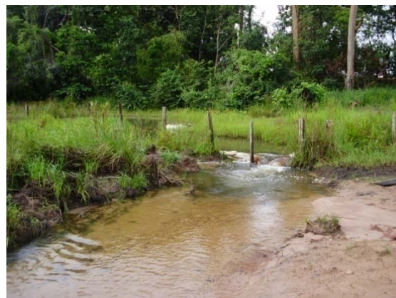
Figuras 5-79 e 80: Terreno mal drenado sem dispositivos de drenagem (bueiros) na travessia da planície alagadiça da margem direita do rio Curisevo (foto esquerda) e junto a seu afluente nas imediações da Faz. Toca da Onça.
