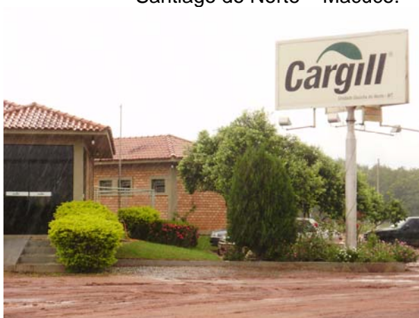
Figura 7-21: Armazém da Cargil em Gaúcha do Norte.
