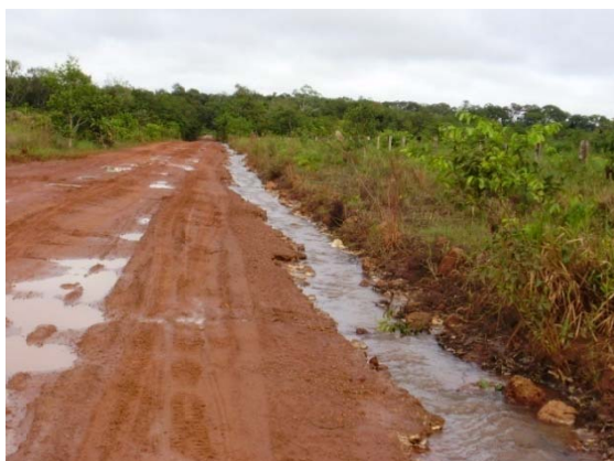
Figuras 5-79 e 80: Terreno mal drenado sem dispositivos de drenagem (bueiros) na travessia da planície alagadiça da margem direita do rio Curisevo (foto esquerda) e junto a seu afluente nas imediações da Faz. Toca da Onça.
