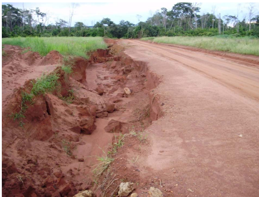
Figura 5-83: Feição erosiva linear na estrada existente que antecede a travessia do ribeirão grande no município de Nova Uiratã.
