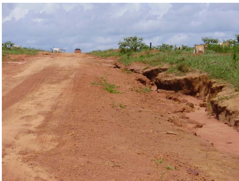
Figura 5-33: Detalhe da presença de feições de ravinamento devido à leve inclinação da rampa ao longo da vertente.
