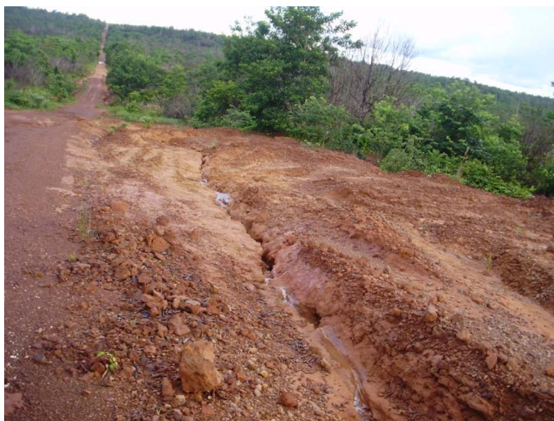
Figura 5-31: Vertentes com inclinação média de 10% na estrada rural entre a Faz. São Fco. e Faz. Ronuro, em ambientes arenosos, que refere-se ao trecho descartado pela Alternativa “C” corta os vales dos rios Ronuro e Capitão Noronha.
