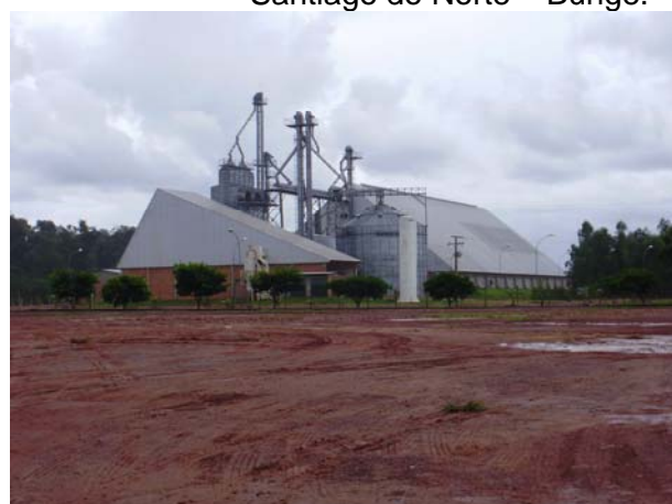
Figura 7-22: Armazém da Cargil em Gaúcha do Norte.
