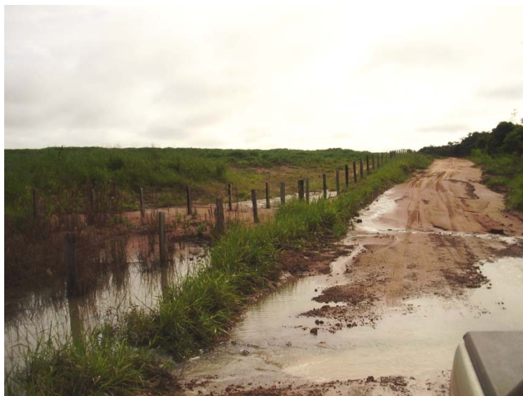
Figura 5-78: Assoreamento e criação de áreas úmidas no traçado existente junto a Faz. Barraca do Norte, município de G.Norte, a ser evitado na fase de construção do empreendimento.
