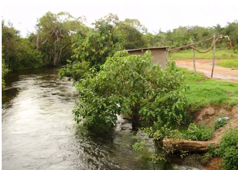
Figura 5-85: Equipamento de captação no rio Água Limpa para abastecimento de pipa.
