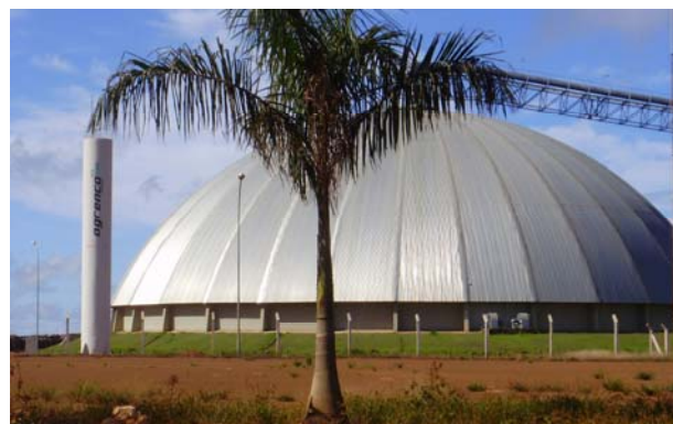
Figura 7-18: Silo da Agreenco - Nova Ubitatã.
