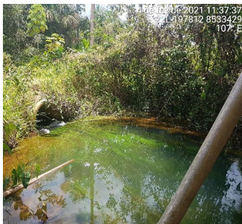
Figura 13. Captação de água da APP.
