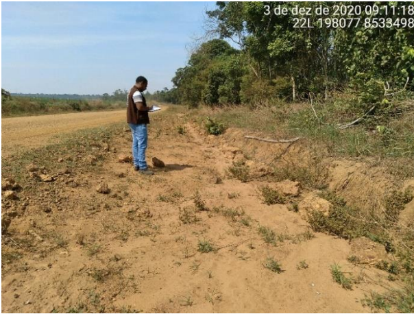
Figura 23: Ponto próximo ao eixo do traçado, ocorrência de cascalho laterítico e início de ravinamento.
