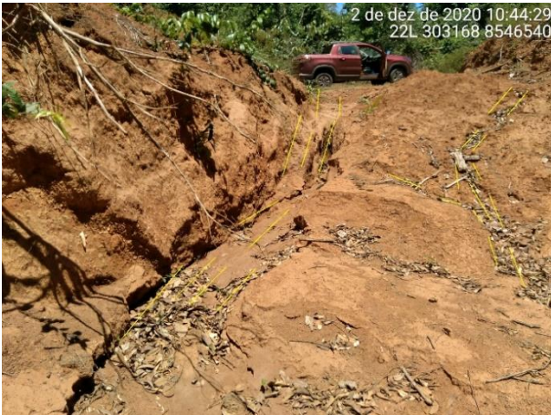
Figura 25: Corte de estrada, com presença de erosão proveniente de uso de máquinas pesadas.
