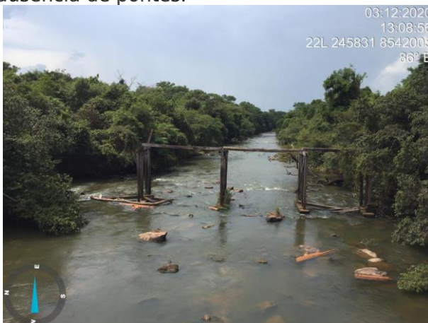
Figura 33: Ponte de madeira sobre o rio Pacuneiro. Há uma ponte transitável no local, que deverá ser reformada para a implantação do empreendimento.
