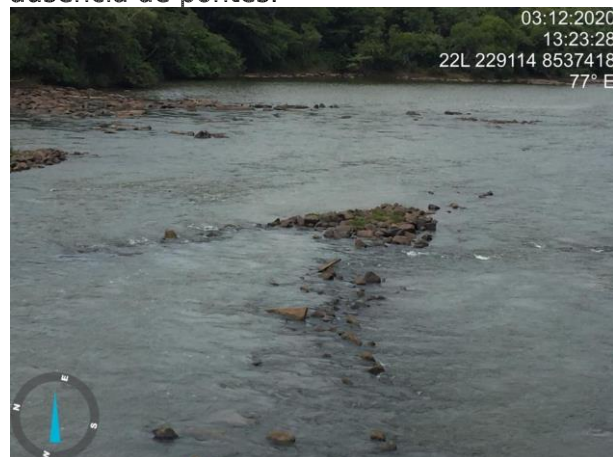
Figura 34: Ponte sobre o rio Curisevo. Há uma ponte transitável no local da foto, que deverá ser reformada para a implantação do empreendimento.
