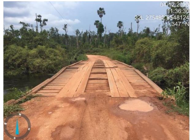
Figura 36: Ponte de madeira existente no traçado previsto da BR-242/MT. Ela deverá ser adequada durante as obras de implantação do empreendimento.
