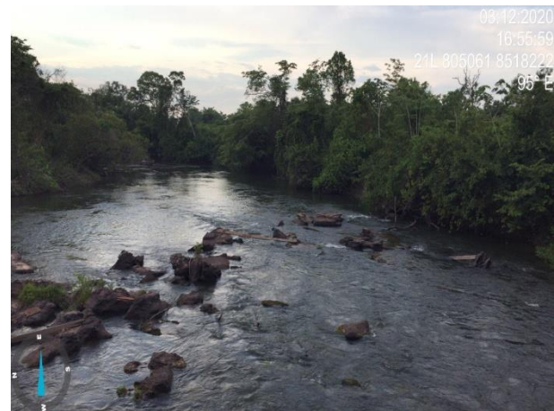
Figura 7. Rio Jatobá, onde é necessário construir uma obra de arte especial.
