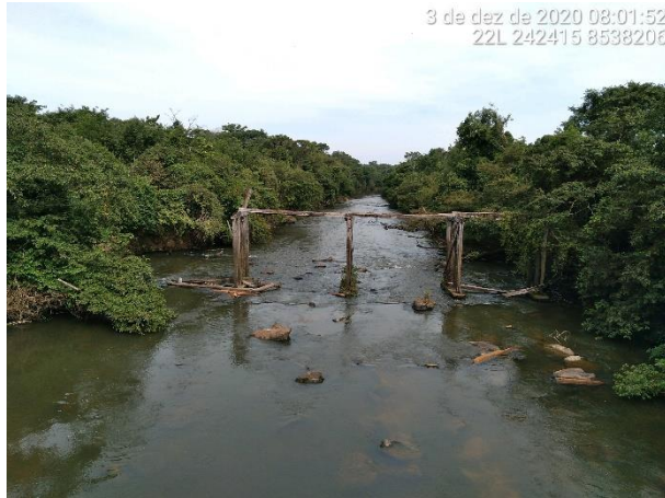
Figura 4. Ponte existente sobre o rio Pacuneiro.
