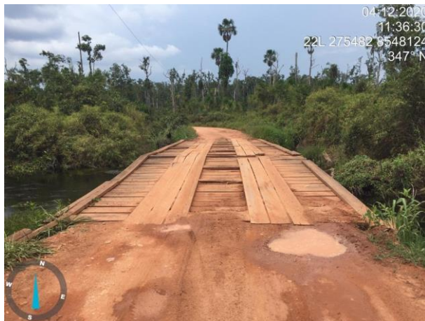
Figura 6. Ponte existente sobre o rio Mirassol.
