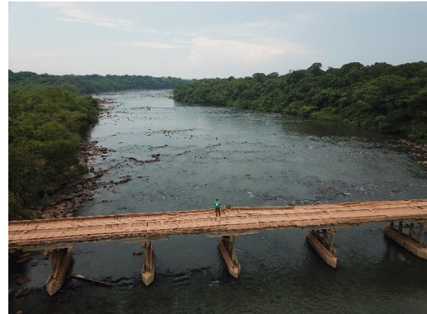
Figura 5. Ponte existente sobre o rio Curisevo.
