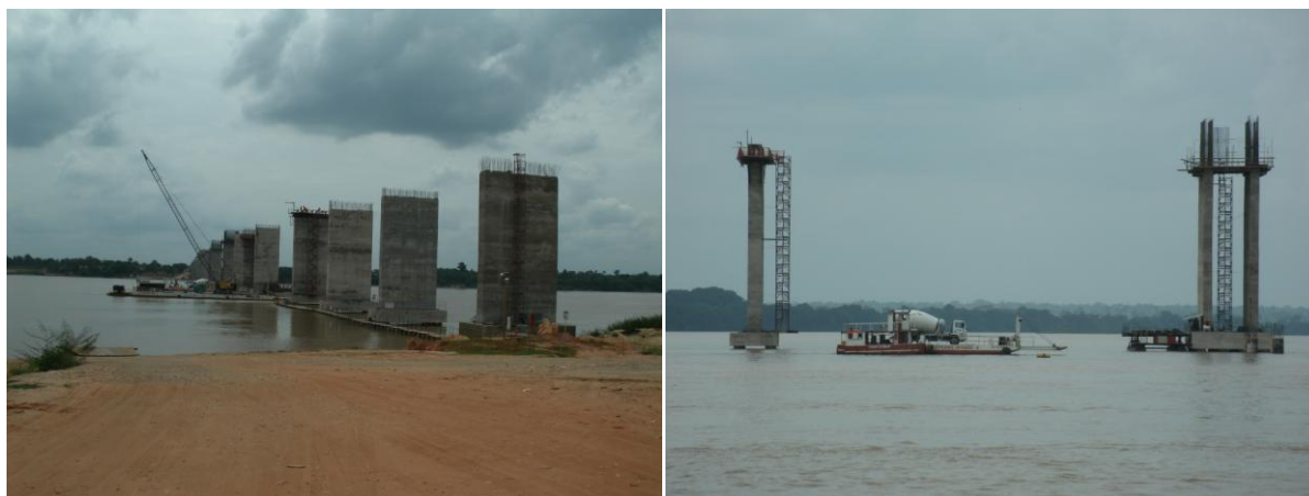
FIGURA 4 – CONSTRUÇÃO DA PONTE SOBRE O RIO ARAGUAIA
