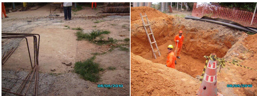
FIGURA 11 – FOSSA DE DESTINAÇÃO DE EFLUENTES SÓLIDOS. ESCAVAÇÃO DE FOSSA
