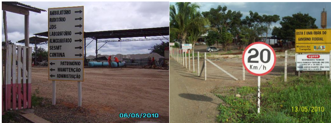
FIGURA 18 – SINALIZAÇÃO DE TRÁFEGO NO CANTEIRO DE OBRAS
