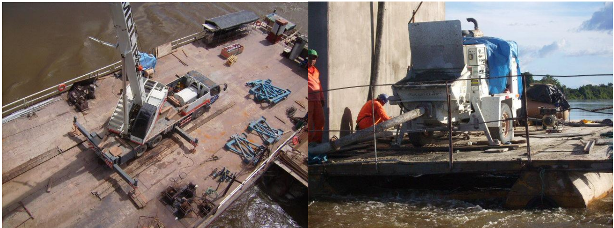
FIGURA 8 – EQUIPAMENTOS TRABALHANDO SOBRE AS BALSAS
