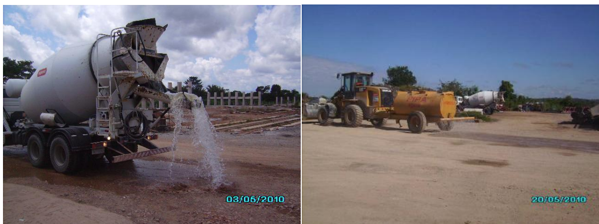
FIGURA 19 – CAMINHÃO BETONEIRA E CAMINHÃO PIPA UMEDECENDO O SOLO DO CANTEIRO
