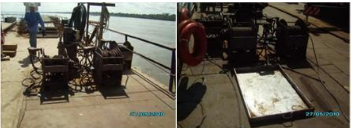
FIGURA 9 – EQUIPAMENTOS QUE DERRAMAM ÓLEO SEM BANDEJA DE CONTENÇÃO E BANDEJA CONFECCIONADA PRONTA PARA USO
