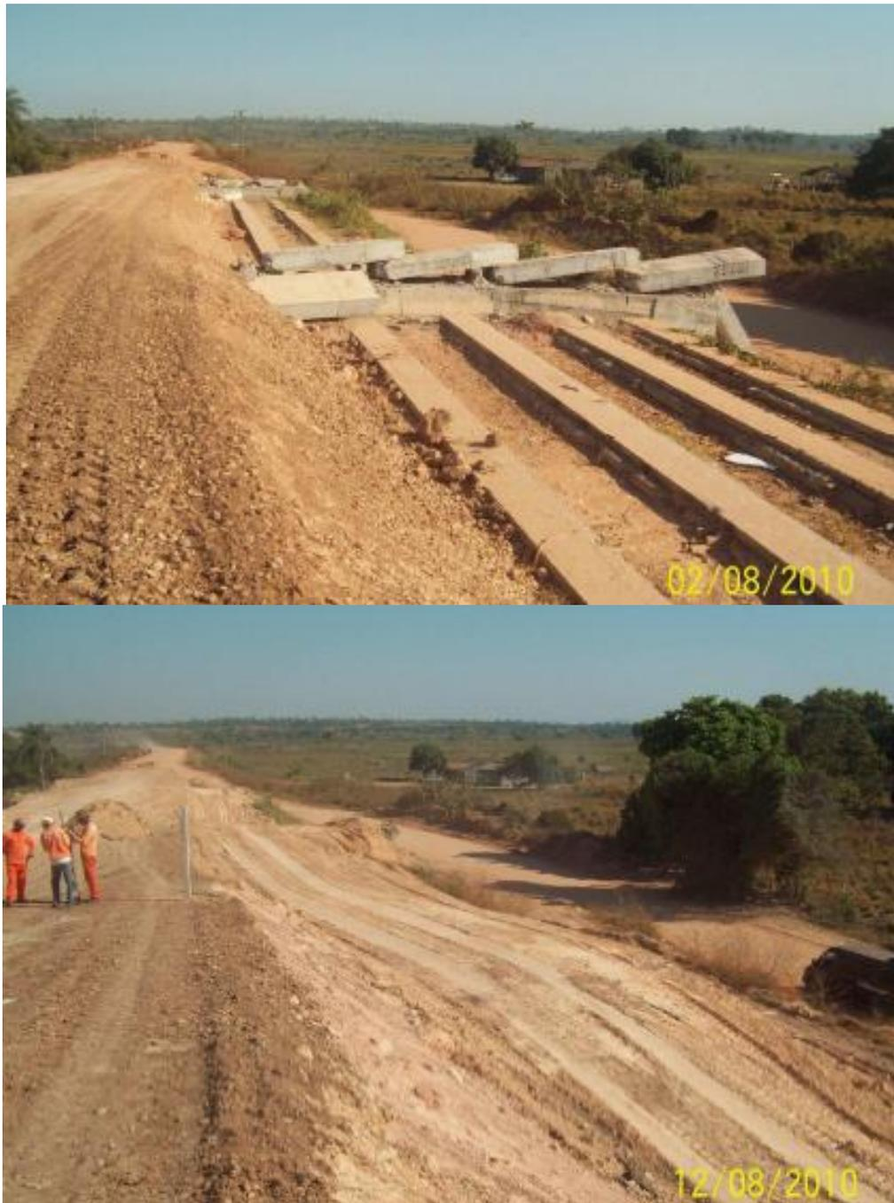
FIGURA 24 – AS ESTRUTURAS DE CONCRETO DEMOLIDAS FORAM REUTILIZADAS NOS ATERROS DA CABECEIRA DA PONTE
