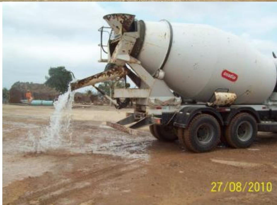
FIGURA 21– UMEDECIMENTO DO SOLO PARA DIMINUIÇÃO DA POEIRA
