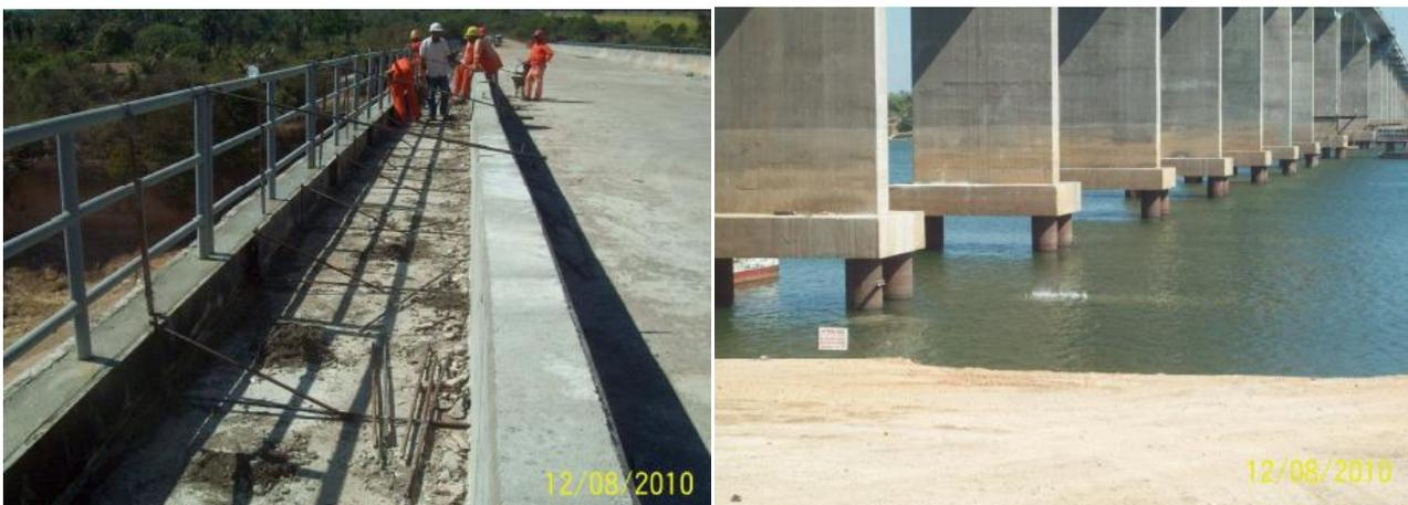
FIGURA 10 – RECOLHIMENTO DOS RESÍDUOS DE CONCRETO E SUA DESTINAÇÃO INCORRETA, ONDE ALGUNS FORAM LANÇADOS NO RIO
