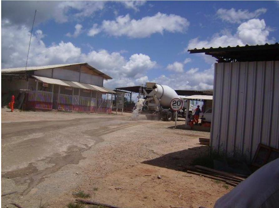
FIGURA 13 – UMEDECIMENTO UTILIZANDO CAMINHÃO BETONEIRA
