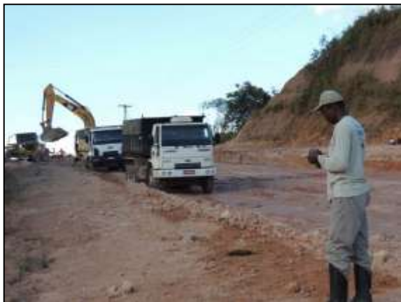
Figura 150. Acompanhamento de rebaixamento de pista, trecho entre Itupiranga e Cajazeiras – Lote 01. Data: 02/06/2014 _22M 0671839 E / 9446396 N
