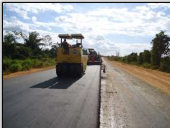
Foto 551 – Atividades de compactação asfáltica. Lado direito. S 05.26207° W 049.32039° 10/06/2014
