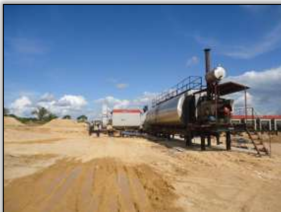
Foto 509 – Usina de asfalto móvel. Lado esquerdo. S 05.21944° W 049.34484° 07/05/2014
