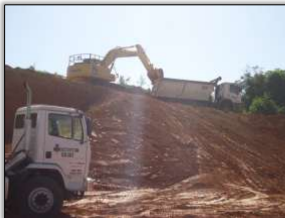
Foto 574 – Reconformação em talude na área da britagem. Lado direito. S 04.90479° W 049.47627° 04/06/2014
