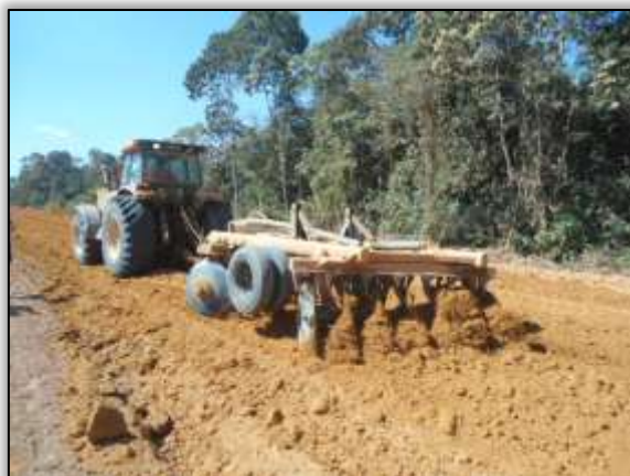
Foto 1132 – Terraplenagem. Estaca 8837. S 03.88825° W 054.29148° 30/07/2014.
