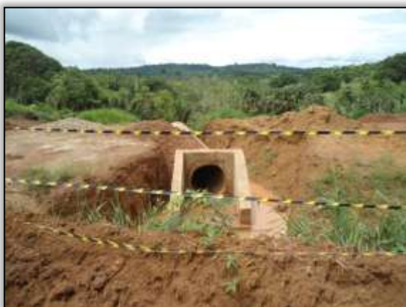
Foto 1067 - Implantação de bueiro. Estaca 8950. S 03.89113° W 054.31150°. 25/02/2014.
