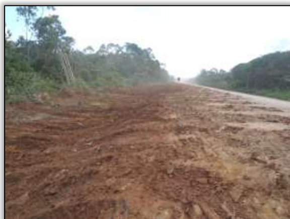
Foto 1644 – Supressão vegetal na faixa de domínio Lado esquerdo. Estaca 8810 a 8850. S 03.88926° W 054.28759° 07/07/2014.
