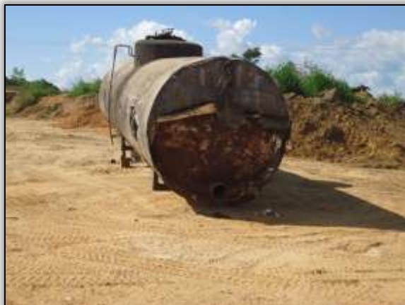
Foto 514 – Tanque de R1 sem sinalização e caixa de proteção. Lado esquerdo. S 05.22060° W 049.34463° 03/06/2014
