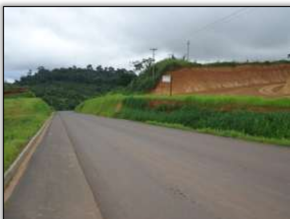
Foto 1263 – Talude após o revestimento vegetal. Ambos os lados. S 04.05647° W 050.24566° 18/02/2014
