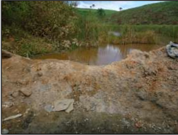
Foto 614 – Barramento em corpo hídrico para instalação de reforço em bueiro. Lado direito. S 05.01652° W 049.45953° 06/05/2014
