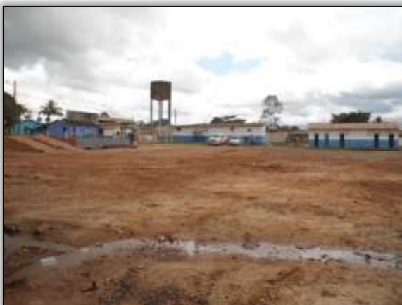
Foto 777– Canteiro de obras sendo desativado. Lado esquerdo. Estaca 1827. S 03.30872° W 052.53631° 23/05/2014.
