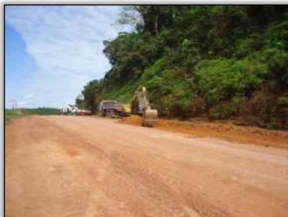
Foto 649 – Corte no corpo estradal. Lado direito. S 05.36685° W 049.12091° 09/06/2014
