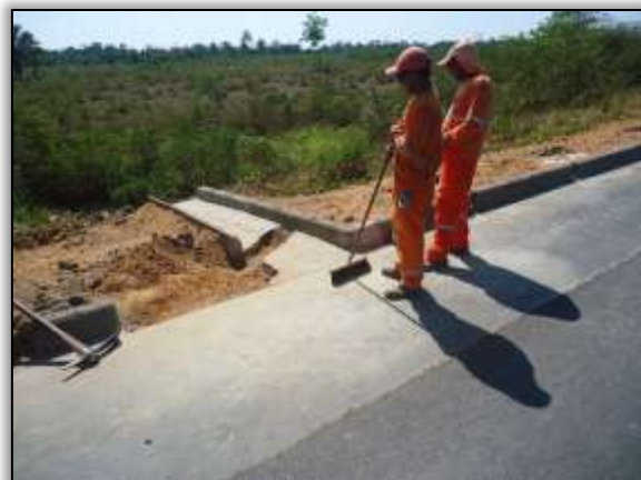
Foto 539 – Instalação de descida d'água. Lado esquerdo. S 05.26186° W 049.32054° 29/06/2014
