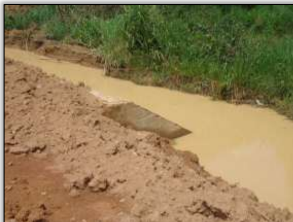
Foto 1012 – Construção de bueiro. S 03.86298° W 054.10196° 14/05/2014.
