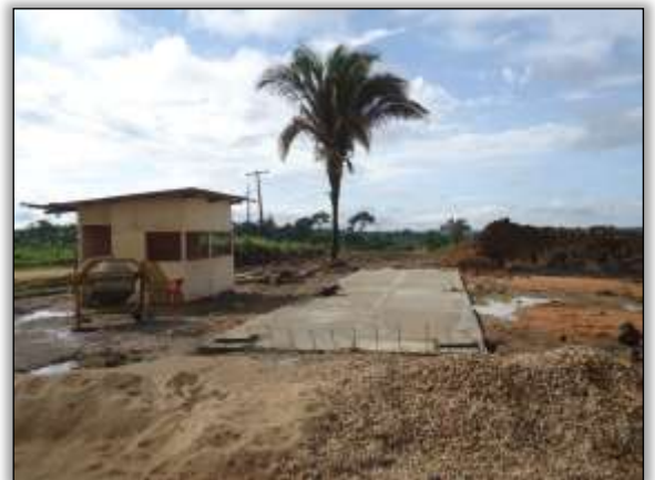
Foto 508 – Balança de pesagem. Lado esquerdo. S 05.21947° W 049.34481° 25/03/2014
