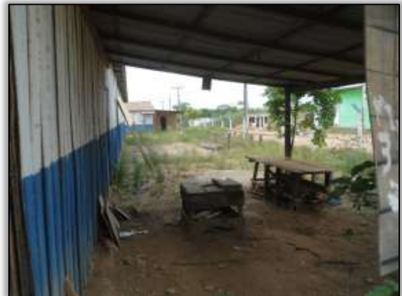
Foto 782. Canteiro de obras. Lado esquerdo. Estaca 1827. S 03.30872° W 052.53631° 10/07/2014.
