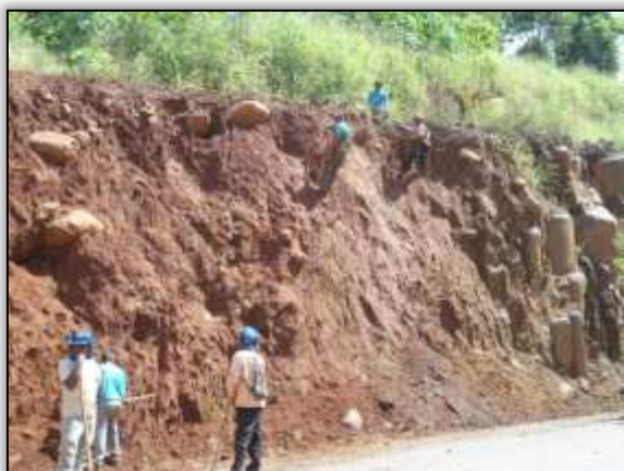
Foto 1308 – Preparo para hidrossemeadura. Lado esquerdo. Estaca 3712. S 03.44142° W 052.84032° 26/03/2014.
