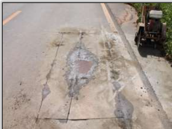
Foto 731– Recuperação Pista de Rolamento. Lado Direito. S 03.35637° W 051.34161° 24/04/2014.
