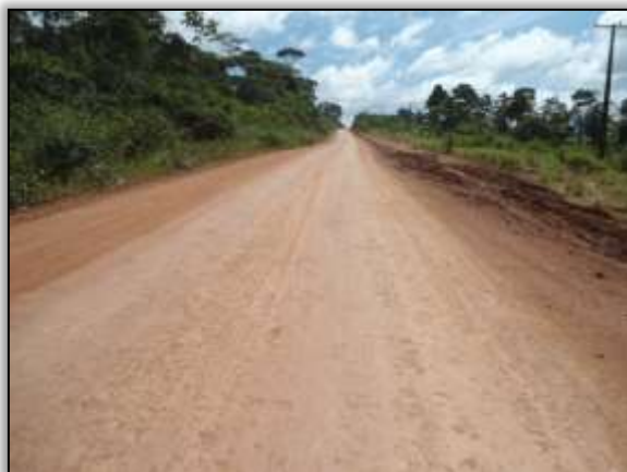
Foto 1155 - Pista reconformada. S 03.52766° W 053.16335°. 26/02/2014.
