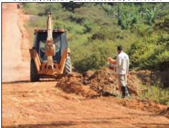
Figura 144. Acompanhamento de limpeza lateral e rebaixamento de pista, trecho entre Marabá e Itupiranga – Lote Único. Data: 27/05/2014 _22M 0683123 E / 9423276 N
