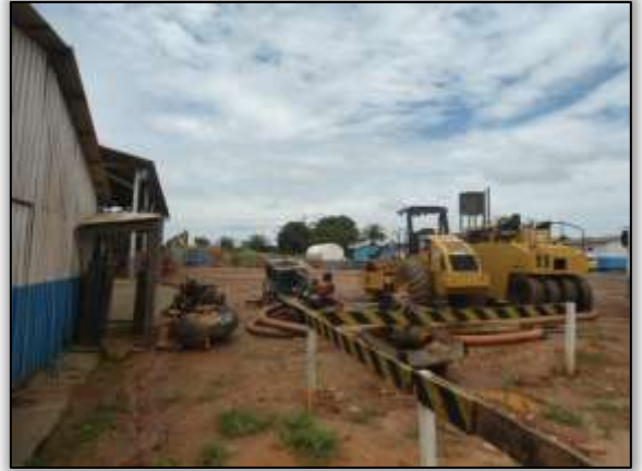
Foto 774 – Canteiro de obras. Lado esquerdo. Estaca 1827. S 03.30872° W 052.53631° 25/02/2014.
