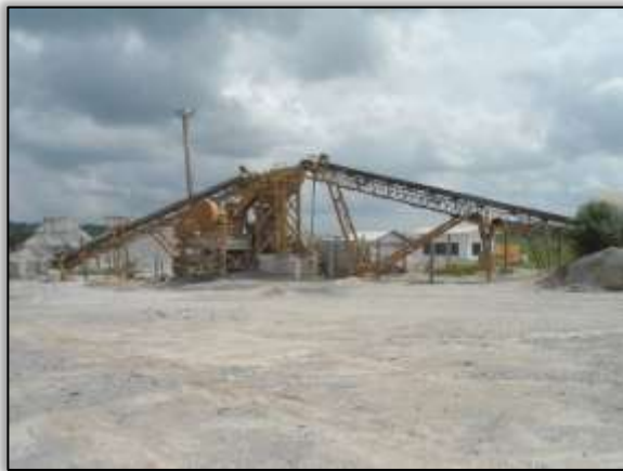
Foto 668 – Área da britagem. S 04.16308° W 050.17271° 27/11/2013
