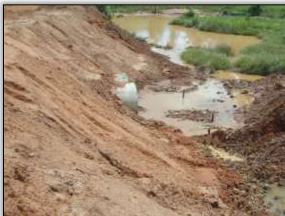
Foto 1007 – Bueiro concluído. S 03. 85307° W 054. 16079° 22/04/2014
