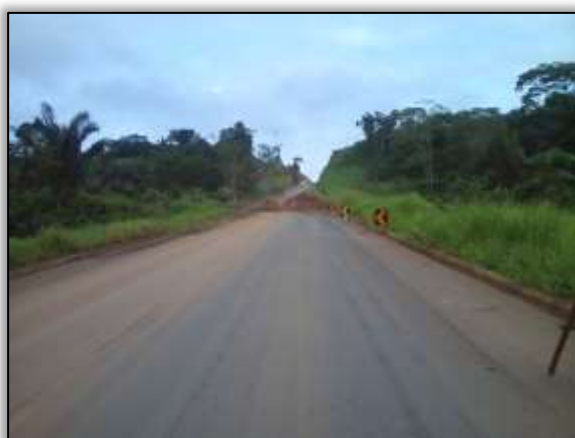
Foto 896. Sinalização com delineadores e placas refletivas- Dnit. Estaca 3700. S 03.44083° W 052.84990° 21/07/2014.
