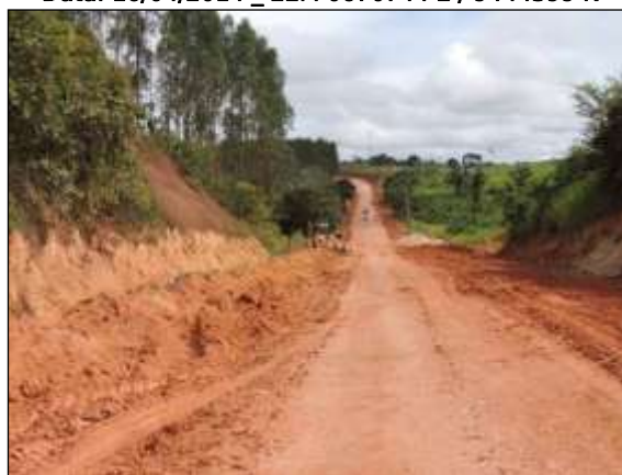
Figura 107. Colocação de dreno no trecho entre Marabá e Itupiranga – Lote único. Data: 17/04/2014 _ 22M 0679561 E / 9428917 N
