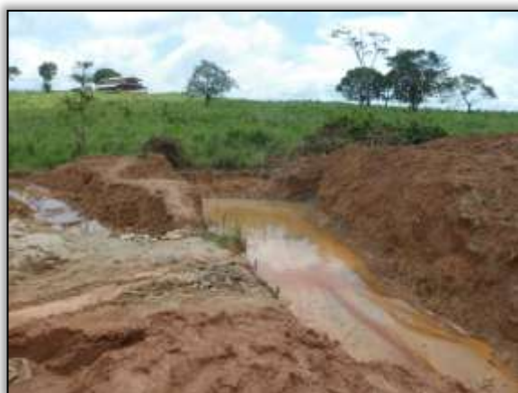
Foto 977 - Implantação de bueiro. Estaca 7799. S 03.85727° W 054.11505°. 25/02/2014.
