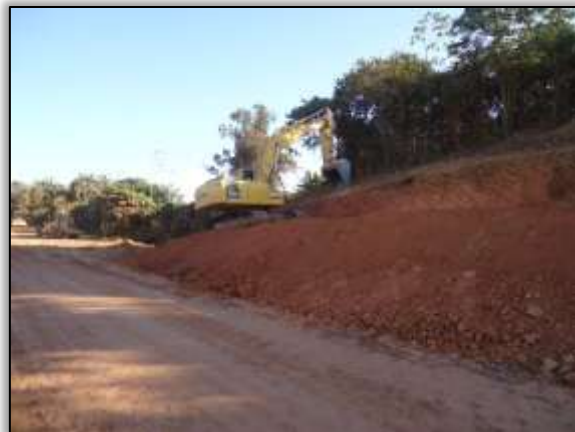
Foto 651 – Atividade de corte em talude. Lado esquerdo. S 04.94161° W 049.46921° 16/07/2014
