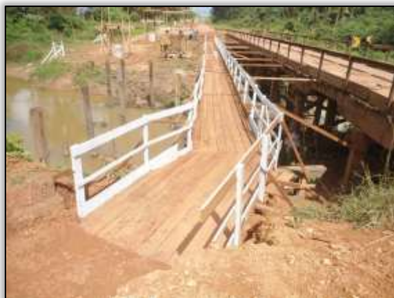
Foto 917 – Passarela pronta. Lado esquerdo. S 03.31975° W 052.56762° 03/07/2014.
