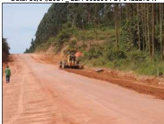
Figura 118. Manutenção da pista, trecho entre Marabá e Itupiranga – Lote único.
