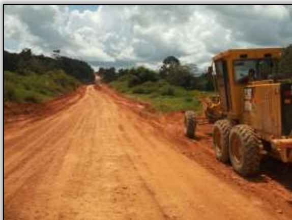
Foto 1168 – Terraplenagem. Lado esquerdo. S 03.657518° W 050.16606° 28/03/2014
