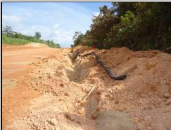
Foto 1255 – Alocação de dreno longitudinal. Lado esquerdo. S 05.73356° W 049.37149° 19/02/2014
