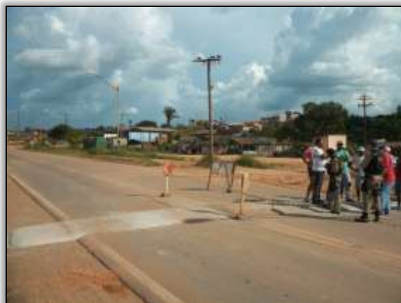
Foto 764 – Construção de lombada rodovia (área urbana de Anapu). Lado Direito e esquerdo. S 03.46050° W 051.20865° 28/03/2014.
