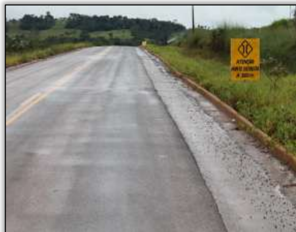
Foto 846 – Reforço sinalização em ponte. Lado Direito. S 03.38460° W 052. 68286° 17/04/2014.
