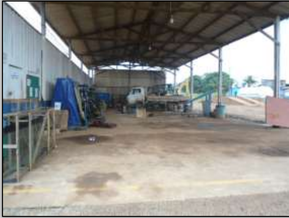
Foto 773 – Canteiro de obras. Lado esquerdo. Estaca 1827. S 03.30872° W 052.53631° 25/02/2014.
