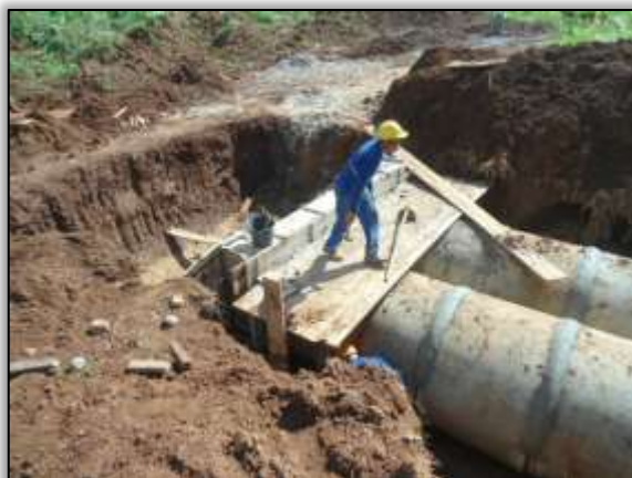
Foto 1090 – Construção de bueiro. Estaca 9568. S 03.88942° W 054.41806° 24/04/2014.
