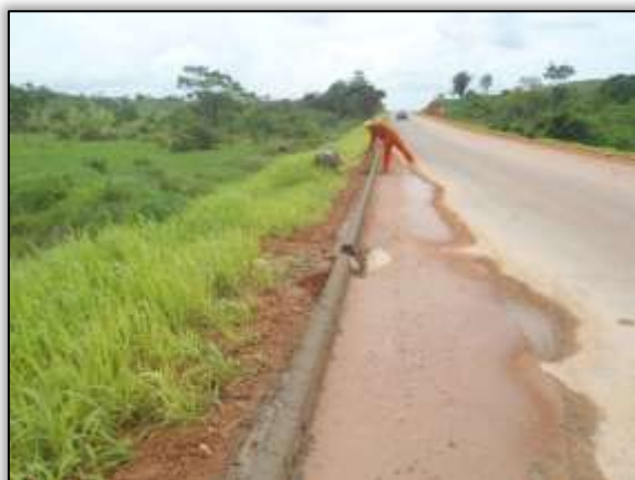
Foto 1268 – Construção de meio fio. Lado esquerdo. Estaca 4465. S 03.60177° W 051.03867° 25/02/2014
