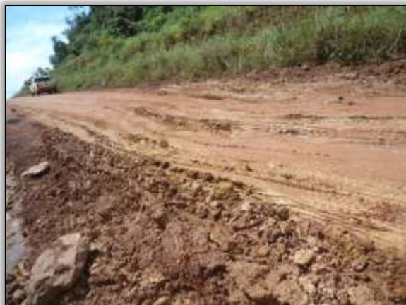
Foto 1153 - Formação de buracos em declive. S 03.49970° W 053.08954°. 24/02/2014.
