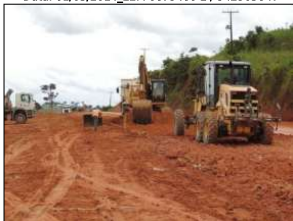
Figura 120. Obra de terraplenagem no trecho entre Marabá e Itupiranga – Lote único.
