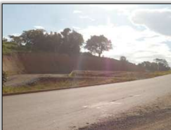
Foto 475- Acesso ao porto do CCBM. Lado direito. Estaca 4572. S 03.12021° W 051.79644° 02/06/2014
