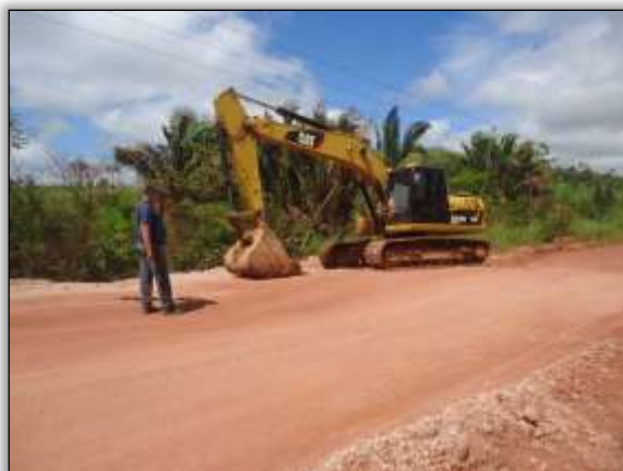
Foto 1215 – Trecho em conservação. Lado direito. S 04.21486° W 049.91790° 29/04/2014
