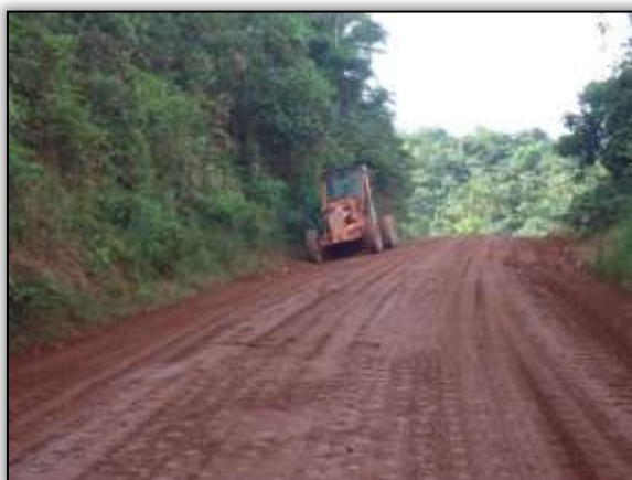
Foto 1184 – Atividade de terraplenagem. Lado esquerdo. S 04.80974° W 049.56691° 23/04/2014
