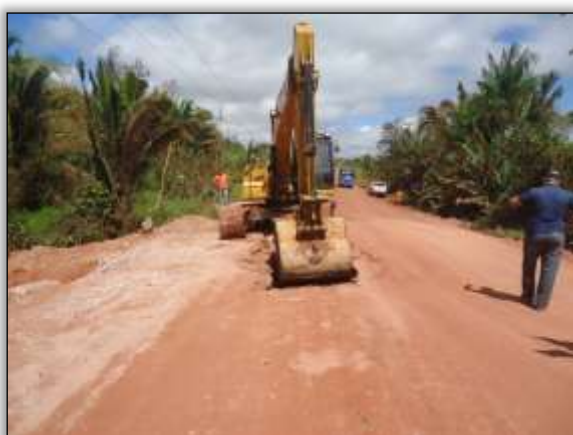
Foto 1216 – Trecho em conservação. Lado direito. S 04.21486° W 049.91790° 29/04/2014
