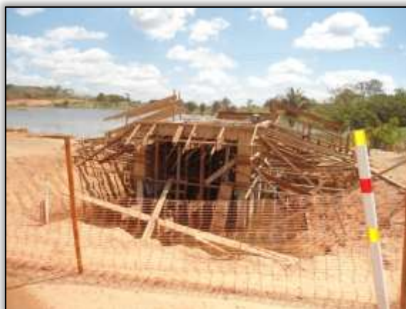
Foto 1122 – Construção de galeria. Estaca 8710. S 03.89008° W 054.27016° 15/07/2104.
