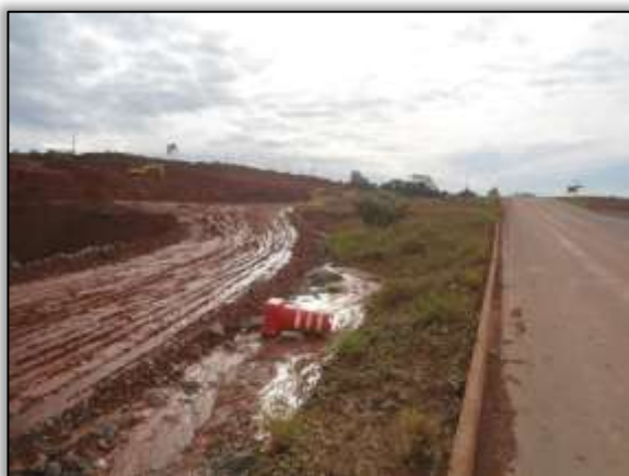
Foto 483- Acesso ao porto do CCBM. Lado direito. Estaca 4572. S 03.12021° W 051.79644° 02/06/2014
