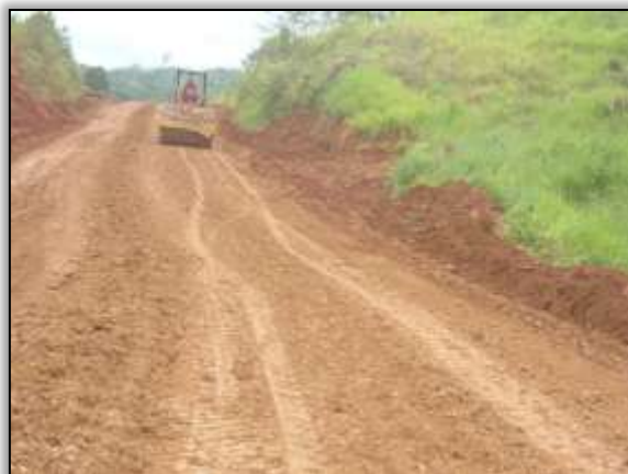
Foto 1136 - Máquinas da empresa CCM fazendo a reconformação de buracos. S 03.91413° W 054.55127° 11/03/2014.
