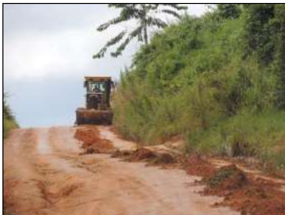
Figura 134. Manutenção da pista no trecho entre Uruará e Placas – Lote 02.
