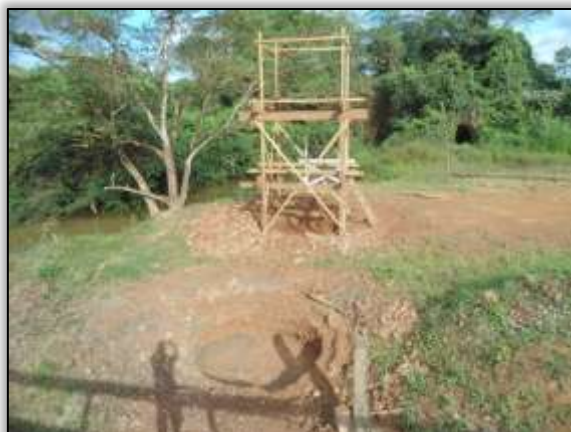
Foto 911. Canteiro de obras. Lado esquerdo. Estaca 1827. S 03.30872° W 052.53631° 11/06/2014.
