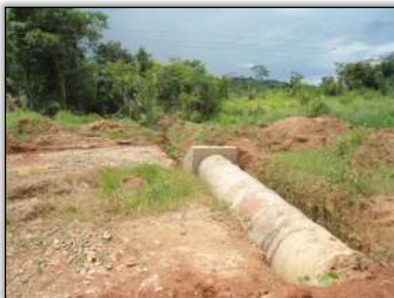
Foto 990 - Bueiro concluído. S 03.85769° W 054.11750°. 19/03/2014.
