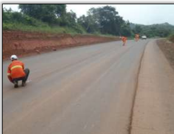
Foto 825 – Marcação de alocação no eixo da pista para implantação de sinalização. S 03.43562° W 052.81929° 18/02/2014.
