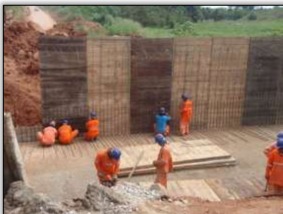
Foto 1015 – Construção de bueiro celular. S 03.86443° W 054.20402° 14/05/2014.
