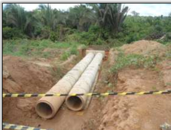
Foto 1004 – Construção de bueiro. S 03. 86309° W 054. 10414° 15/04/2014
