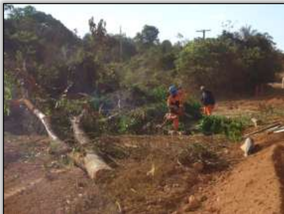
Foto 1474 - Supressão vegetal com a utilização de motosserra. Lado esquerdo. S 04.93669° W 049.46981° 21/07/2014
