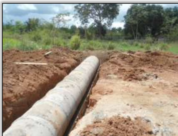
Foto 984 - Construção de bueiro. S 03.86223° W 054.08433°. 13/03/2014.
