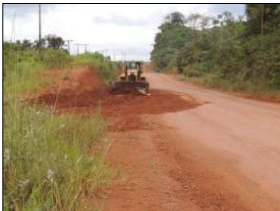
Figura 128. Limpeza de lateral no trecho entre Itupiranga e Cajazeiras - Lote 01. Data: 08/05/2014_22M 0672087 E / 9446940 N
