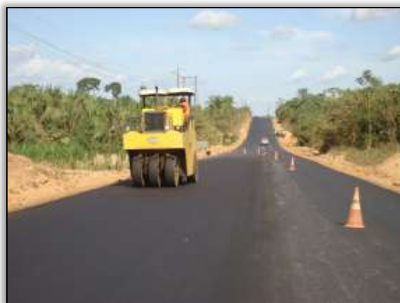
Foto 561 – Atividades de compactação asfáltica. Lado esquerdo. S 05.17931° W 049.37038° 21/07/2014
