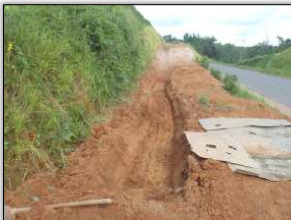
Foto 702 – Construção de valeta. Lado direito. Estaca 4765. S 03.57200° W 051.08290° 18/06/2014
