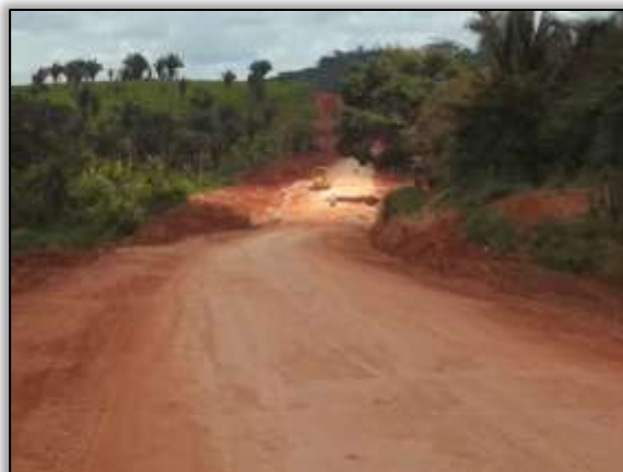
Foto 722 – (Depois) Passivo corrigido. Estaca 4348. S 03.61337° W 051.02332° 28/03/2014
