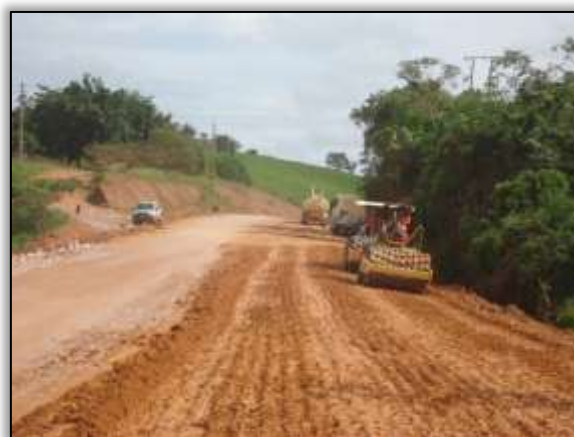
Foto 595 – Atividades de compactação. S 05.17790° W 049.36180° 13/03/2014
