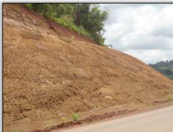
Foto 1284 – Hidrossemeadura. Lado esquerdo. S 03.43050° W 052.81358° 26/02/2014.
