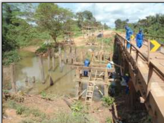
Foto 916 – Construção de passarela. Lado esquerdo. S 03.31975° W 052.56762° 13/06/2014.
