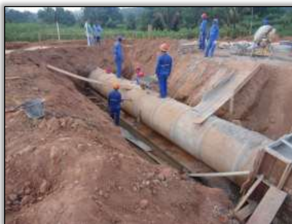
Foto 1110 – Implantação de bueiro. S 03.89237° W 054.45609° 24/06/2014.
