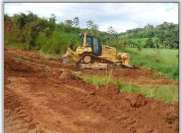
Foto 1380 – Limpeza no bordo da pista. Lado esquerdo. S 05.00772° W 049.45065° 06/05/2014
