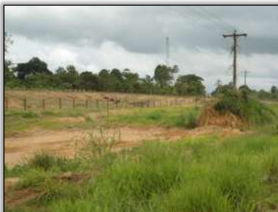
Foto 792 – Jazida na faixa de domínio próximo a vila 50. Lado direito. Estaca 2931. S 03.36099° W 052.63371° 11/02/2014.
