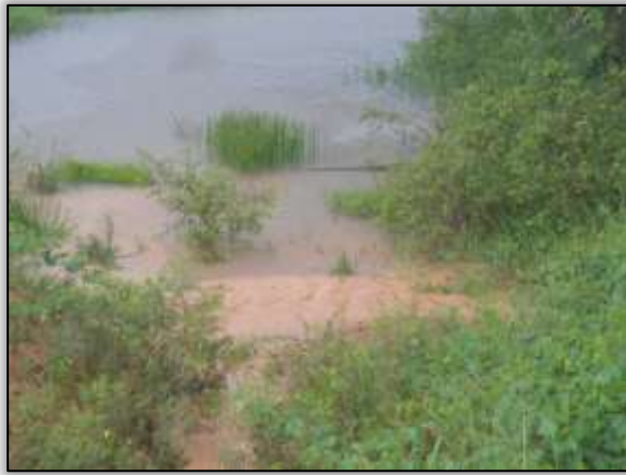
Foto 1914 – Ponto 34 com a observação de material inconsolidado das obras inacabadas sendo carregado para dentro do açude
