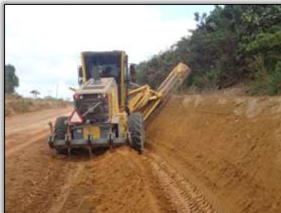
Foto 1102 – Corte em talude. Lado direito. Estaca 9075. S 03.89196° W 054.33186° 06/06/2014.
