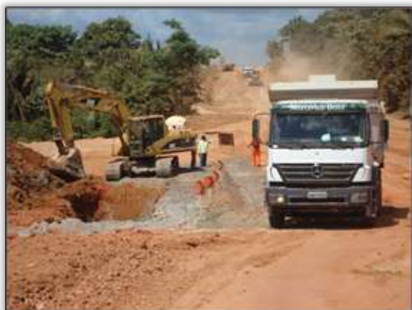
Foto 421 – Trecho em obras. Anapú/PA, 10/07/2014.
