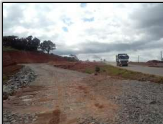
Foto 462- Rotatório para o acesso ao porto do CCBM. Lado esquerdo. Estaca 4572. S 03.12021° W 051.79644° 03/04/2014
