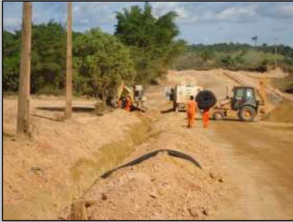
Foto 1347 – Abertura para instalação de dreno profundo. Lado direito. S 04.96703° W 049.44820° 21/07/2014
