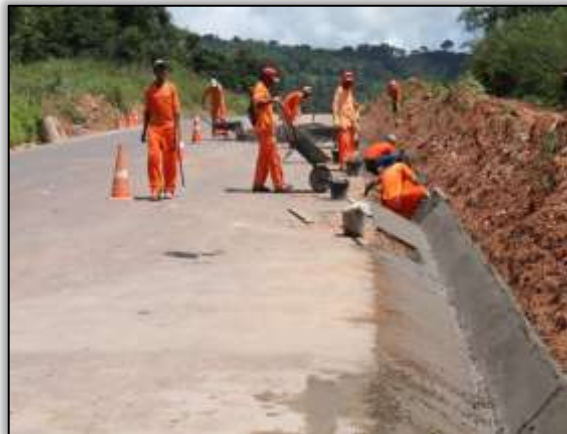
Foto 1324 – Construção do dispositivo de drenagem. Lado direito. S 03.55733° W 051.09763° 29/04/2014
