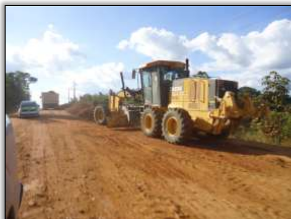
Foto 525 – Atividades de terraplenagem. Lado direito. S 05.18179° W 049.36861° 03/06/2014
