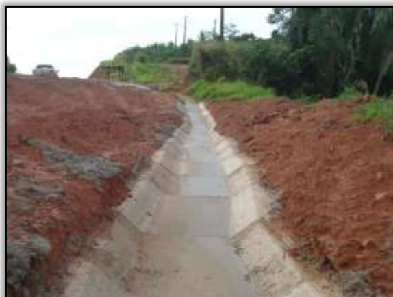
Foto 1319 – Bueiro reconstruído. Lado esquerdo (depois). S 04.19449º W 050.01511º 24/04/2014
