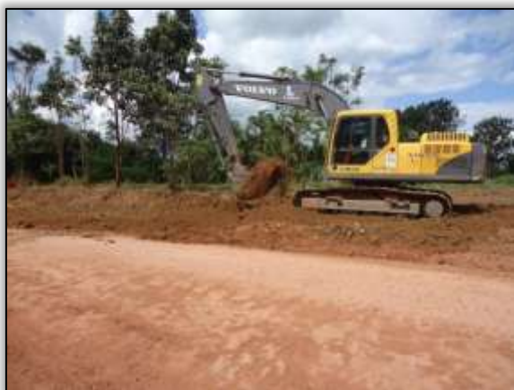
Foto 1018 – Corte de talude. Lado esquerdo. Estaca 8601. S 03.88074° W 054.25333° 27/05/2014.
