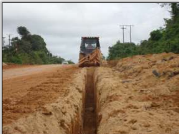
Foto 1295 – Alocação de dreno longitudinal. Lado esquerdo. S 05.17695° W 049.37176° 25/03/2014
