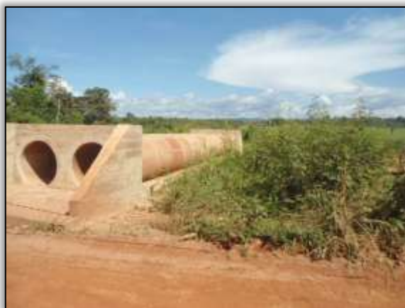
Foto 1086 – Bueiro concluído S 03.89174° W 054.33481° 14/04/2014
