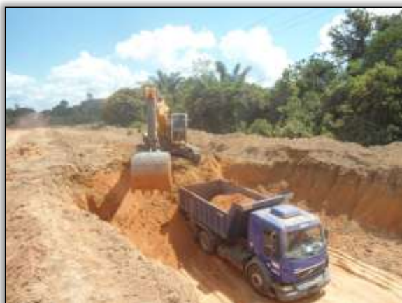
Foto 1050 - Corte em talude. Lado direito. Estaca 8578. S 03.87887° W 054.25011° 17/07/2014.
