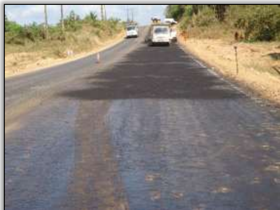
Foto 556 – Emulsão asfáltica. Lado esquerdo. S 05.18520° W 049.36640° 17/07/2014
