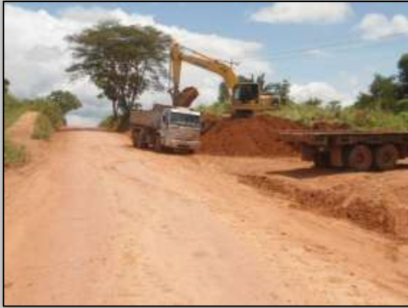
Foto 1201 – Corte em talude. Lado direito. S 03. 86026° W 054. 07432° 14/04/2014
