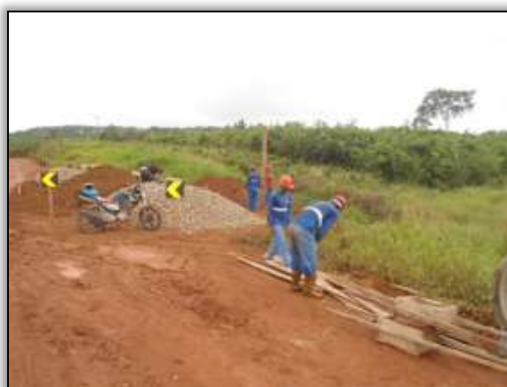
Foto 1080 - Construção de bueiro. S 03.89207° W054. 43005°. 25/03/2014.
