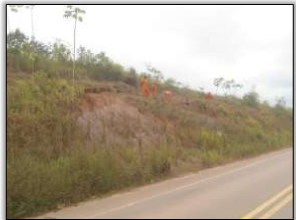
Foto 739 –Reconformação de valeta no talude de corte.Lado direito. S 03.16633° W 053.00728° 29/07/2014
