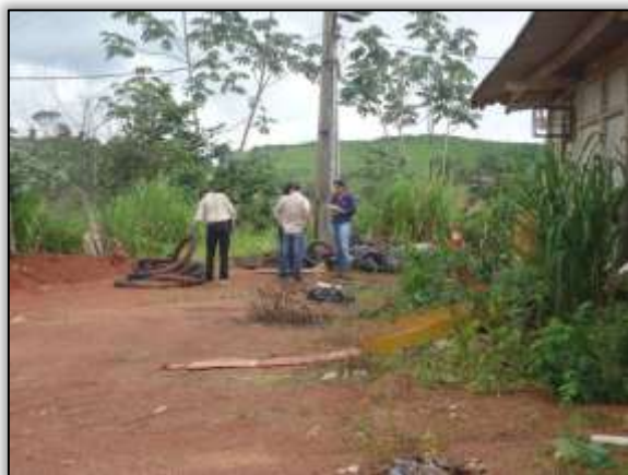
Foto 664 – Acondicionamento irregular de dreno longitudinal. S 04.23923° W 049.95534° 12/05/2014
