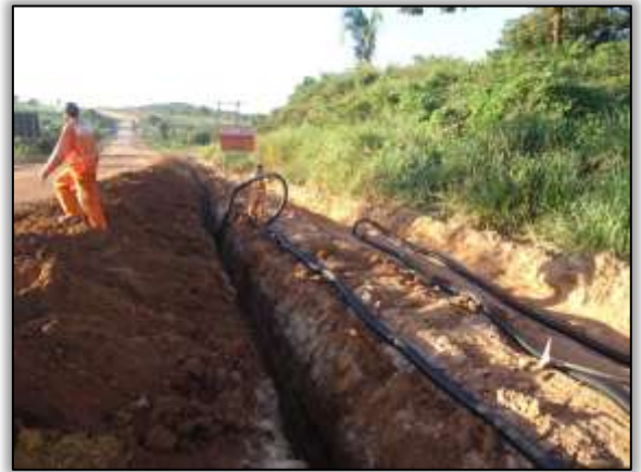
Foto 1341 – Fixação de dreno profundo. Lado direito. S 05.15319° W 049.38892° 14/05/2014
