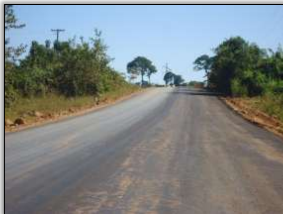
Foto 545 – Rodovia pavimentada. S 05.23078° W 049.33691° 24/06/2014
