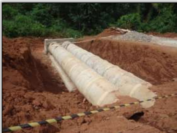
Foto 1077 – Construção de bueiro. S03. 88962° W 054.41409°. 19/03/2014.
