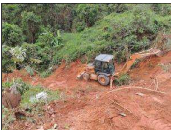
Figura 62. Acompanhamento da construção de escada d'água entre Marabá e Itupiranga – Lote Único. Data: 13/01/2014_22M 0671028 E / 9442088 N
