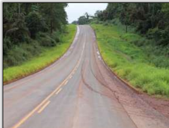
Foto 1326 – Hidrossemeadura. Lado esquerdo e direito. Estaca 3302. S 03.41037° W 052.77415° 17/04/2014.
