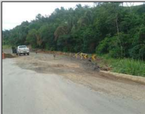
Foto 841- Nivelamento do desvio. Lado esquerdo e direito. Estaca 1904. S 03.31088° W 052.54976° 11/04/2014.
