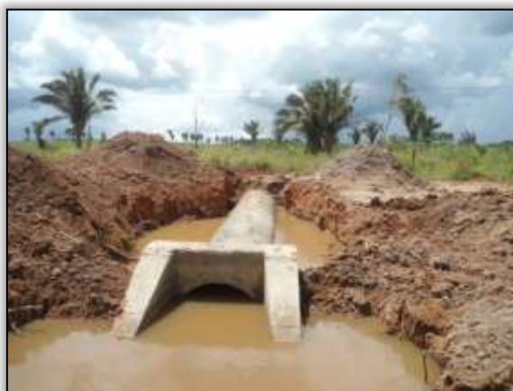
Foto 986 - Construção de bueiro. S 03.86239° W 054.08888°. 13/03/2014.
