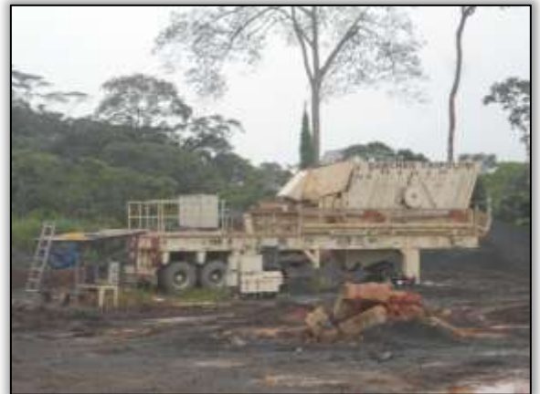
Foto 772 – Britador em desmobilização. Lado direito. Estaca 3775. S 03.44206° W 052.85213° 25/02/2014.
