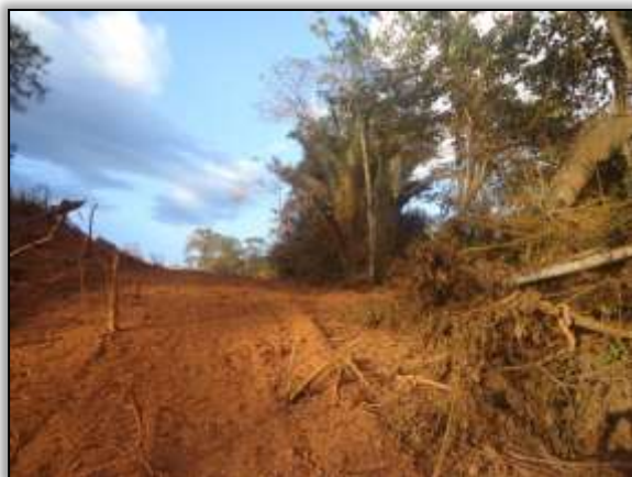
Foto 1642 - Supressão na faixa de domínio. Lado esquerdo. S 03.75057° W 053.83060° 22/07/2014.
