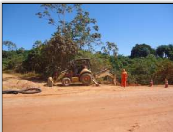
Foto 1344 – Abertura para instalação de dreno profundo. Lado esquerdo. S 04.99725° W 049.44659° 30/06/2014
