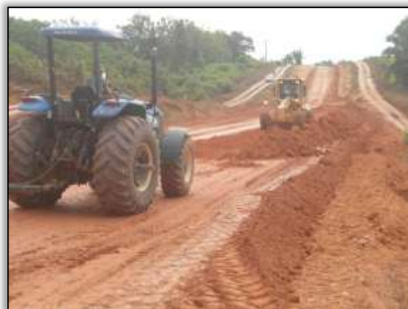
Foto 712 – Terraplenagem. Lado direito. Estaca 3729. S 03.68210º W 050.93491º 25/06/2014
