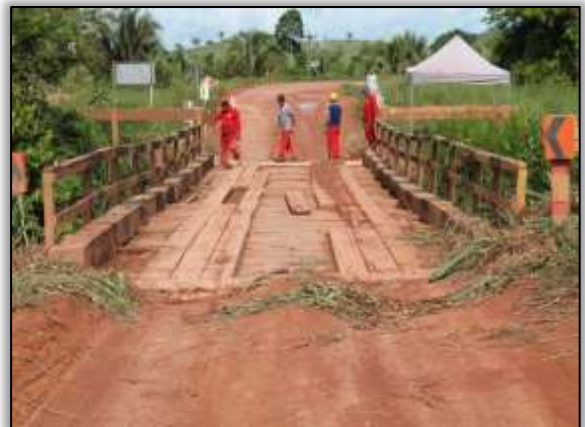
Foto 728– Reforma de ponte. Lado Direito e esquerdo. S 03.32244° W 051.38041°23/04/2014.
