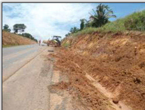
Foto 827 – Construção de valeta. Lado esquerdo. Estaca 2540. S 03.36740° W 052.64540° 18/02/2014.
