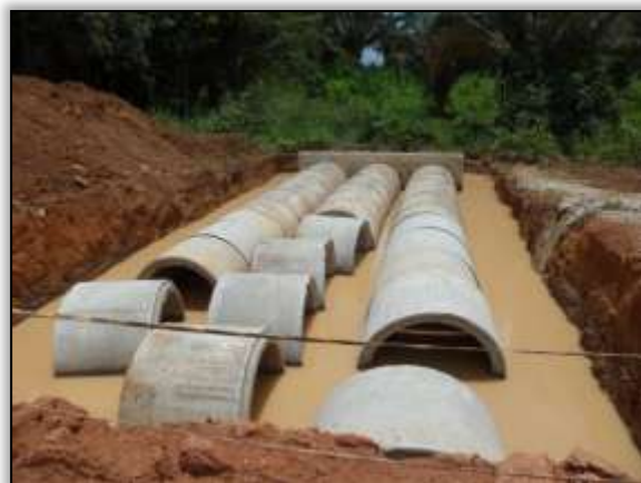
Foto 976 - Implantação de bueiro. Estaca 7715. S 03.86298° W 054.10204°. 19/02/2013
