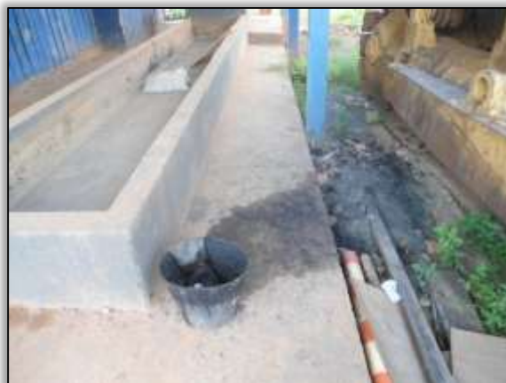
Foto 784. Canteiro de obras. Lado esquerdo. Estaca 1827. S 03.30872° W 052.53631° 10/07/2014.
