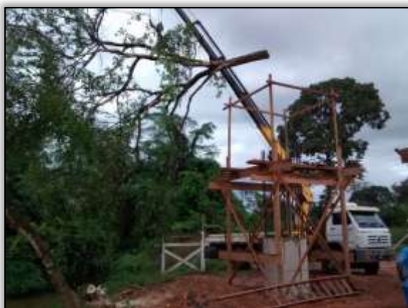
Foto 1448 – Retirada da árvore com auxílio de guindaste. Lado esquerdo. S 03.31975° W 052.56762° 24/06/2014.
