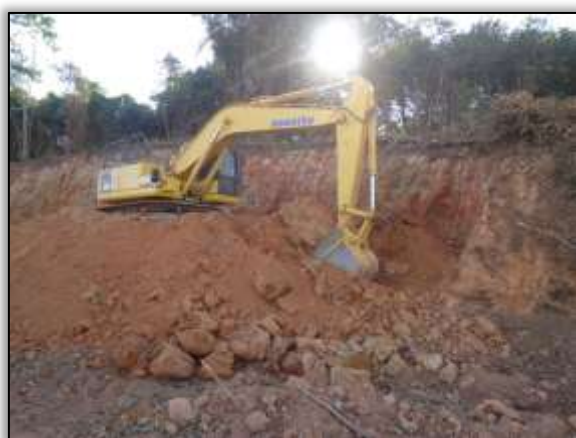
Foto 652 – Corte em talude. Lado esquerdo. S 04.94161° W 049.46921° 16/07/2014
