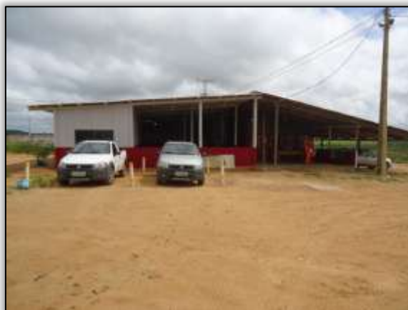
Foto 492 – Escritório de Canteiro. S 05.14399° W 049.35741° 23/04/2014
