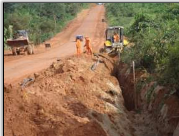
Foto 1293 – Alocação de dreno longitudinal. Lado esquerdo. S 05.17695° W 049.37176° 13/03/2014
