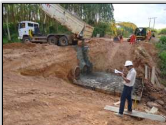
Foto 535 – Substituição de bueiro triplo tubular de concreto. Lado direito. S 05.15319° W 049.38892° 14/05/2014
