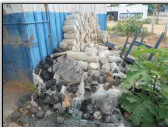
Foto 785. Canteiro de obras. Lado esquerdo. Estaca 1827. S 03.30872° W 052.53631° 10/07/2014.
