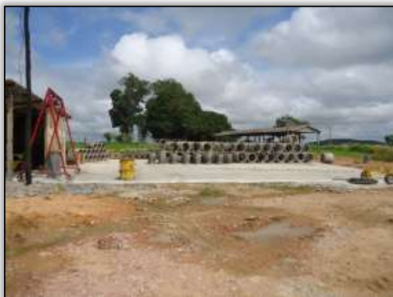
Foto 491 – Fabricação de bueiro simples tubulares de concreto. S 05.17695° W 049.37176° 23/04/2014
