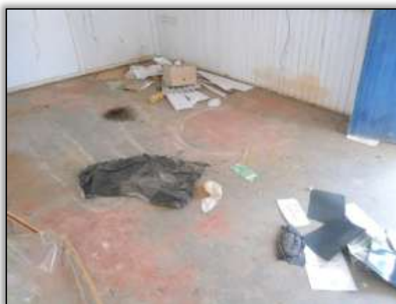
Foto 786. Canteiro de obras. Lado esquerdo. Estaca 1827. S 03.30872° W 052.53631° 10/07/2014.
