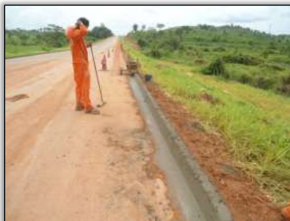
Foto 1269 – Construção de meio fio. Lado direito. Estaca 4465. S 03.60177° W 051.03867° 25/02/2014
