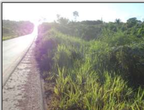
Foto 1360 – (Depois) Reconformação da área, plantio com hidrossemeadura, condução da revegetação natural. 05/06/2014
