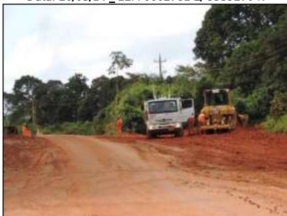
Figura 82. Acompanhamento de terraplenagem na BR-230/PA entre Itupiranga e Cajazeiras – Lote 01.
