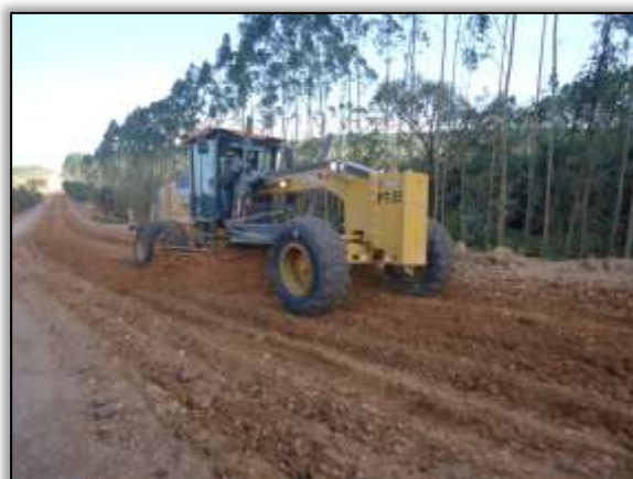
Foto 531 – Atividades de terraplenagem. Lado esquerdo. S 05.16033° W 049.36858° 28/07/2014
