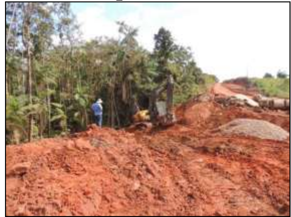
Figura 173. Abertura de vala para locação de bueiros entre Uruará e Placas – Lote 02. Data: 25/06/2014 _ 21M 0815345 E / 9573552 N
