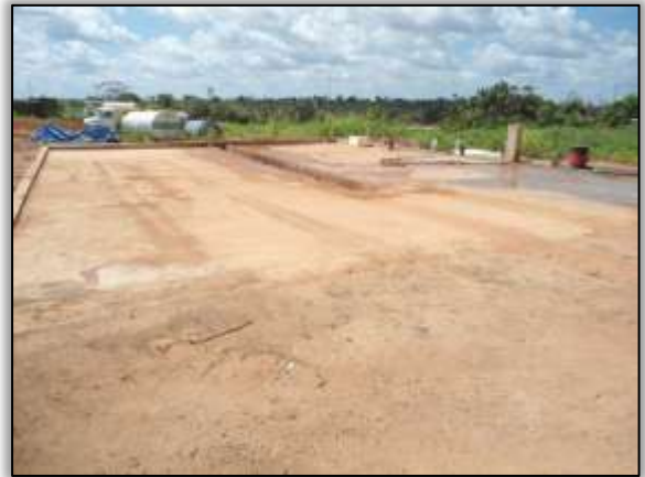
Foto 750 – Lava a jato. Lado esquerdo. Estaca 561 S 03.45172° e W 051.21874° 09/07/2014
