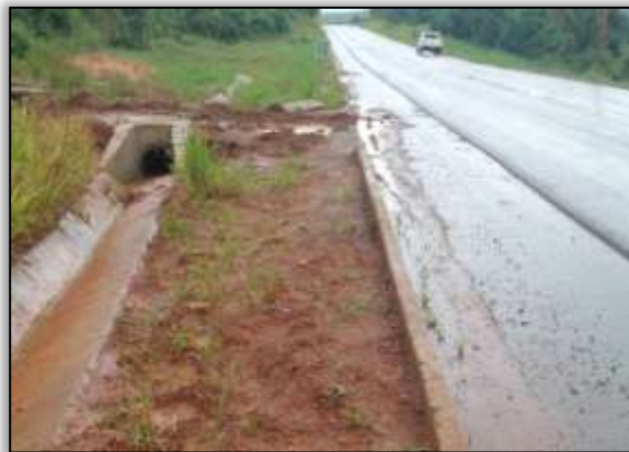
Foto 834 – Bueiro simples de concreto. Lado esquerdo. S 03.32404° W 052.57419° 17/04/2014.
