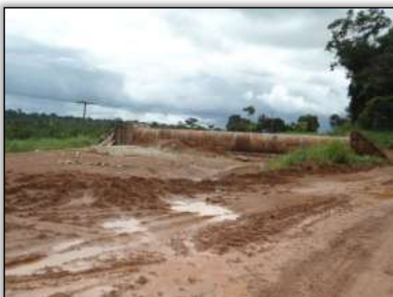
Foto 1069 - Implantação de bueiro. S 03.89168° W 054.33116°. 25/02/2014.
