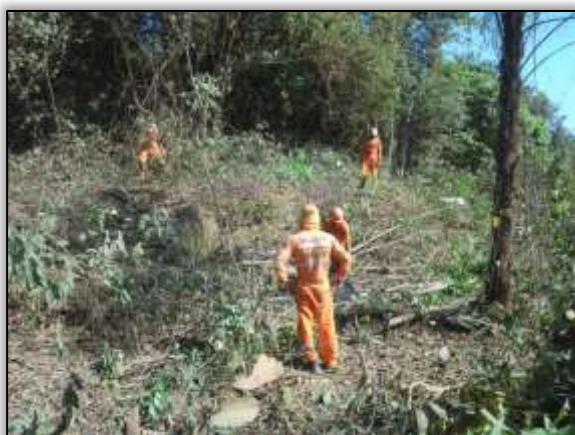
Foto 1476 - Supressão vegetal com a utilização de motosserra. Lado esquerdo. S 04.96055° W 049.47822° 08/07/2014.
