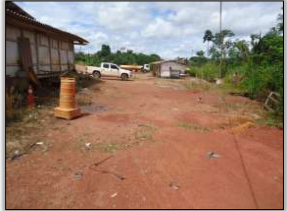
Foto 667 – Canteiro organizado. S 04.23923° W 049.95534° 16/05/2014
