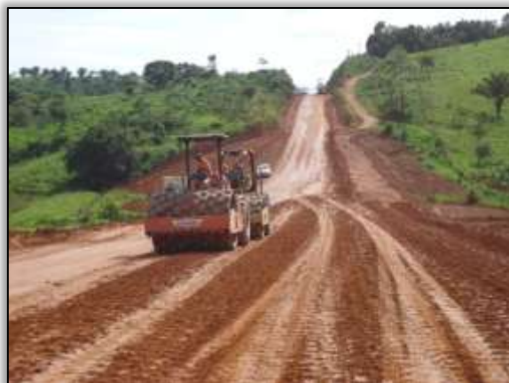
Foto 599 – Atividade de compactação na rodovia. Lado esquerdo. S 05.01727° W 049.45705° 06/05/2014
