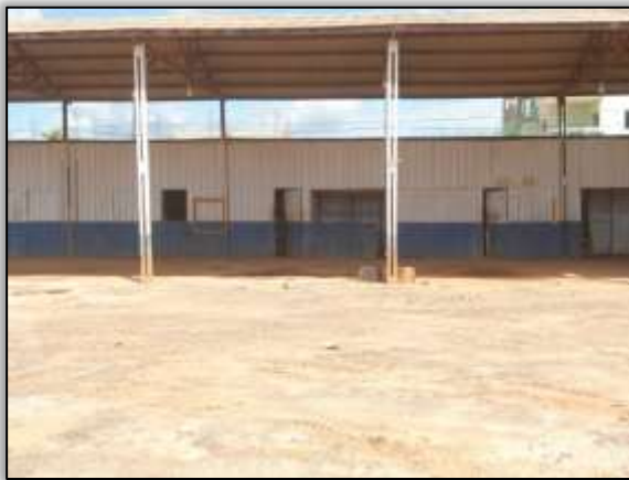
Foto 779. Canteiro de obras- mancha de óleo no chão da oficina. Lado esquerdo. Estaca 1827. S 03.30872° W 052.53631° 10/07/2014.
