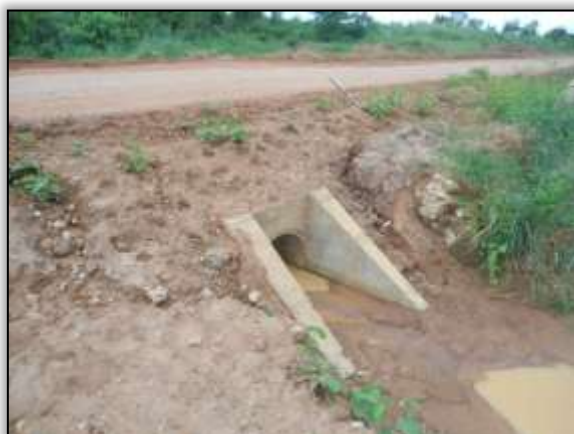
Foto 992 - Bueiro concluído. S 03.85448° W 054.13353°. 27/03/2014.
