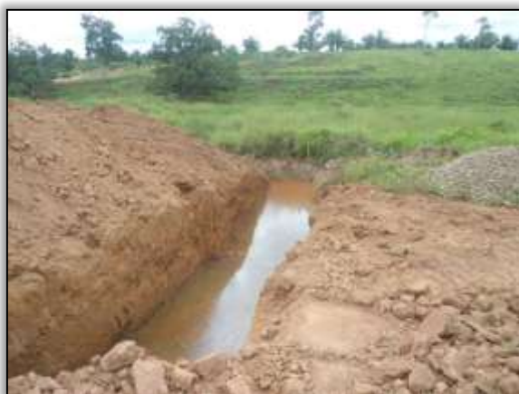
Foto 983 - Construção de bueiro. S 03.85928° W 054.06723°. 13/03/2014.
