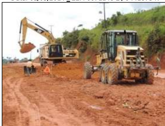
Figura 121. Rebaixamento da pista, trecho entre Itupiranga e Cajazeiras – Lote 01.
