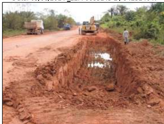
Figura 157. Acompanhamento de abertura de vala para instalação de colchão drenante, no trecho entre Itupiranga e Cajazeiras – Lote 01. Data: 06/06/2014 _22M 0672205 E / 9447972 N
