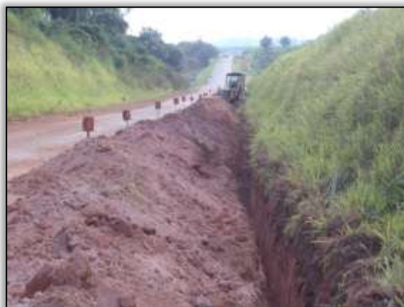
Foto 701 – Dreno profundo. Lado direito. Estaca 4450. S 03.60354° W 051.03651° 18/06/2014
