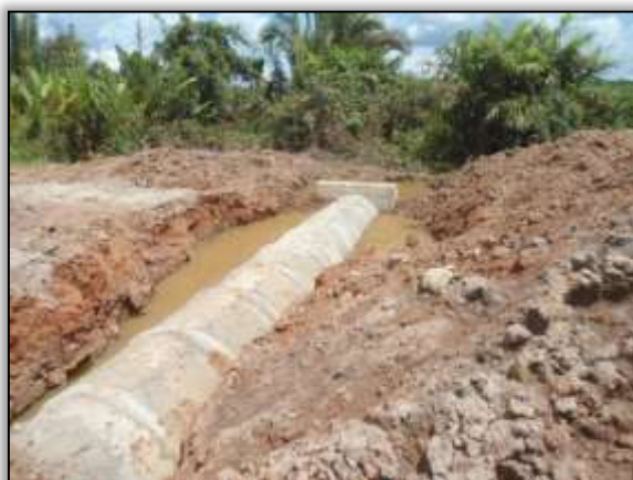
Foto 985 - Construção de bueiro. S 03.86239° W 054.08888°. 13/03/2014.
