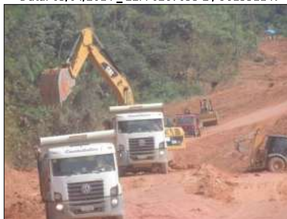
Figura 89. Obra de terraplenagem, entre Cajazeiras e Itupiranga – Lote 01.
