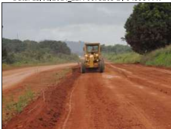
Figura 68. Acompanhamento da terraplenagem entre Uruará e Placas – Lote 02. Data: 18/01/2014 _ 21M 0755420 E / 9553688 N
