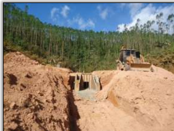
Foto 639 – Instalação de bueiro simples tubular de concreto. Lado esquerdo. S 05.02727° W 049.45987° 21/07/2014
