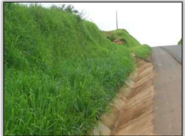
Foto 1260 – Aplicação de hidrossemeadura. Lado esquerdo. S 03.94304° W 050.30402° 18/02/2014
