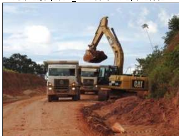
Figura 93. Obra de terraplenagem no trecho entre Itupiranga e Cajazeiras – Lote 01. Data: 11/04/2014 _ 22M 0670747 E / 9444436 N
