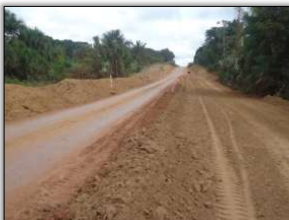
Foto 1098 - Terraplanagem. Estaca 9201. S 03.8858° W 054.35342° 27/05/2014.
