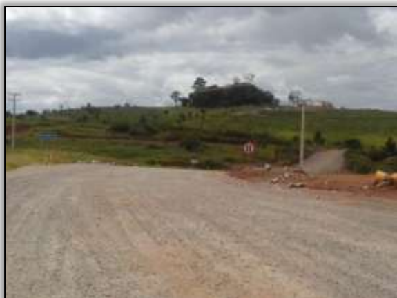
Foto 461- Acesso ao porto do CCBM. Lado direito. Estaca 4572. S 03.12021° W 051.79644° 03/04/2014
