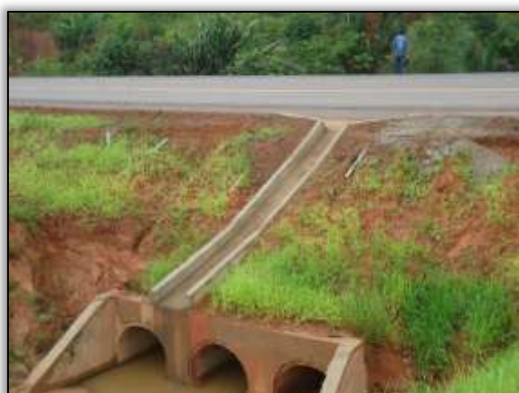
Foto 1302 – Bueiro desobstruído 19/03/2014. Lado direito. S 04.19449° W 050.01511°
