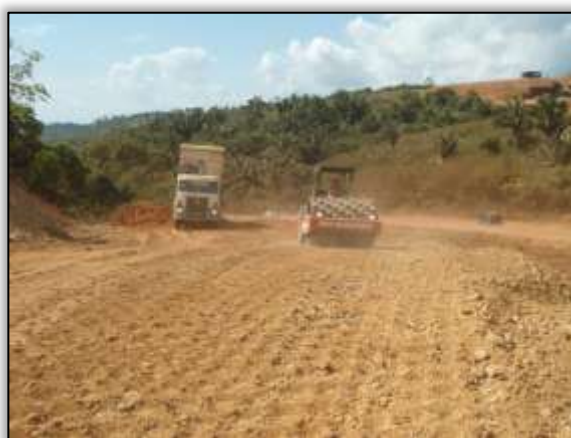
Foto 612 – Atividade de compactação. Lado esquerdo. S 04.90677° W 049.47849° 24/07/2014
