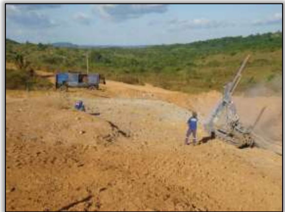
Foto 589 – Atividades de perfuração na pedra. Lado direito. S 04.90683° W 049.47833° 21/07/2014
