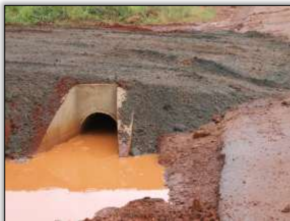
Foto 836 – Bueiro simples de concreto. Lado Esquerdo. Estaca 3488. S 03.42519° W 052.80470° 17/04/2014.
