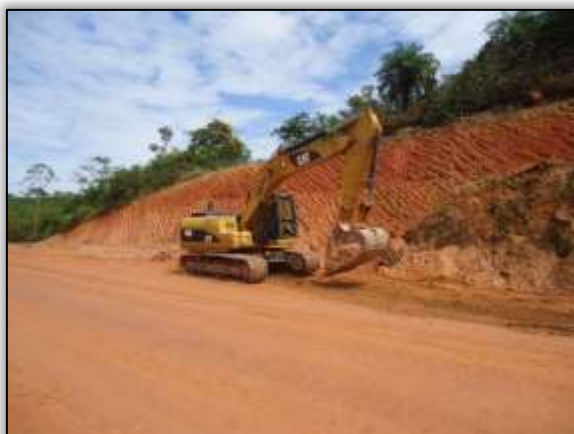
Foto 648 – Corte em talude. Lado direito. S 05.36685° W 049.12091° 09/06/2014
