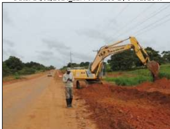
Figura 65. Acompanhamento da abertura de canaletas entre Itupiranga e Cajazeiras – Lote 01. Data: 15/01/2014_22M 0673513 E / 9439078 N
