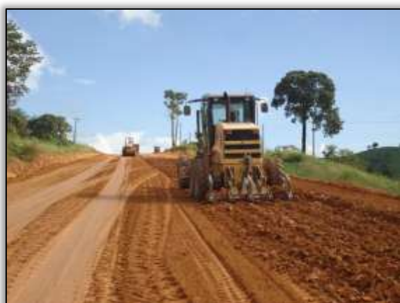
Foto 601 – Gradeamento no solo. Lado esquerdo. S 05.01727° W 049.45705° 06/05/2014
