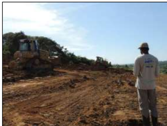
Figura 147. Acompanhamento de limpeza de área no britador, próximo a Cajazeiras – Lote 01. Data: 31/05/2014 _22M 0668932 E / 9457671 N
