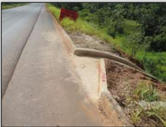
Foto 850– Reconstrução de descida d'água. Lado esquerdo. Estaca 1930. S 03.31346° W 052.55519° 02/06/14
