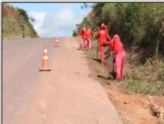
Foto 1186 – Limpeza do dispositivo de drenagem. Lado direito. S 03.83617° W 050.61493° 29/04/2014
