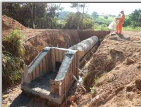
Foto 636 – Bueiro simples tubular de concreto. Lado esquerdo. S 04.94710° W 049.46670° 08/07/2014
