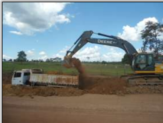
Foto 1120– Corte na pista. Estaca 8693. S 03.88795° W 054.26840° 07/07/2014.
