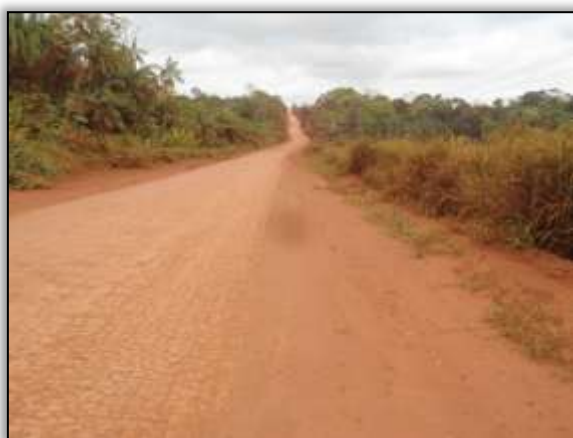
Foto 1242 – Pista reconformada. S 03.46675° W 052.94277° 10/07/2014.
