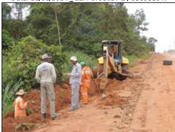
Figura 74. Biólogo acompanhando abertura de vala entre Marabá e Itupiranga – Lote Único.
