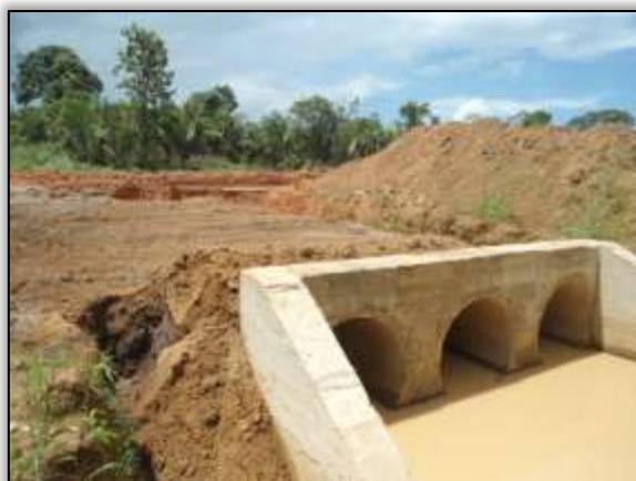
Foto 988 - Construção de bueiro. S 03.86299° W 054.10212°. 19/03/2014.
