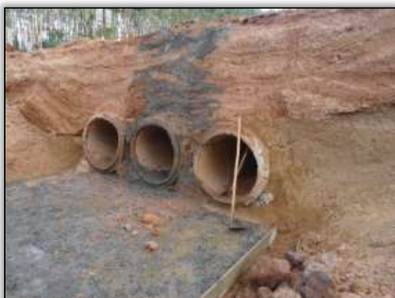
Foto 534 – Substituição de bueiro triplo tubular de concreto. Lado direito. S 05.15319° W 049.38892° 14/05/2014
