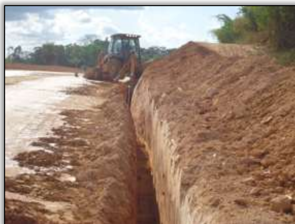
Foto 1346 – Abertura para instalação de dreno profundo. Lado direito. S 05.96945° W 049.44672° 17/07/2014
