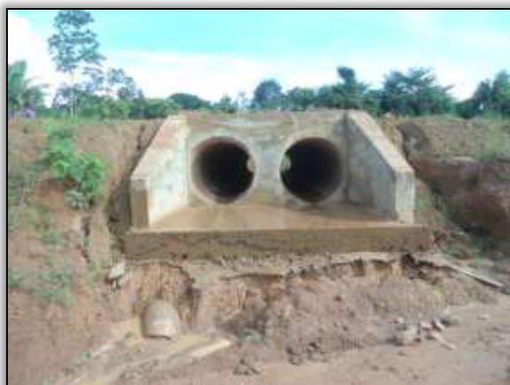
Foto 999 – Bueiro concluído. S 03.87593° W 054.24353°. 27/03/2014.
