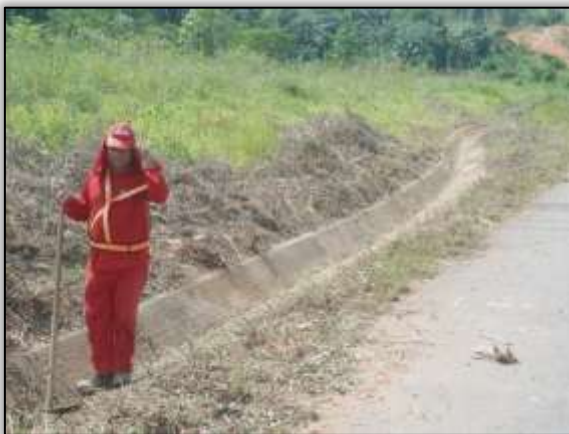
Foto 1141 – Limpeza de sarjeta. Lado esquerdo. Estaca 2890. S 03.77023° W 050.82005° 25/02/2014
