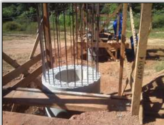
Foto 913 – Parte da coluna concretada. Lado esquerdo. Estaca 1827. S 03.30872° W 052.53631° 11/06/2014.
