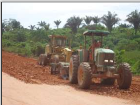
Foto 604 – Atividade de gradeamento no solo. Lado direito. S 04.99355°W 049.44596 09/06/2014
