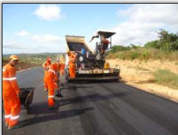
Foto 548 – Atividade de pavimentação por Vibroacabadora. Lado esquerdo. S 05.24718° W 049.32998° 30/06/2014
