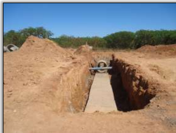
Foto 623 – Instalação de bueiro. Ambos os lados. S 04.95963° W 049.45843° 18/06/2014
