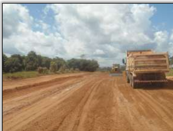
Foto 1049 - Terraplenagem. Estaca 8354. S 03.86679° W 054.21174° 17/07/2014.
