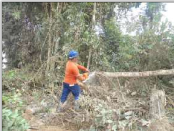
Foto 1646 – Supressão vegetal na faixa de domínio. Lado direito. Estaca 8994. S 03.88741° W 054.31959° 28/07/2014.
