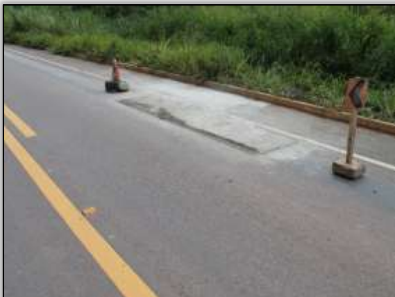
Foto 727– Recuperação pista de rolamento. Estaca 9013 Lado Direito. S 03.411225° W 051.26749°23/04/2014.
