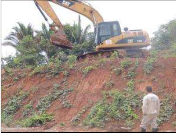
Figura 50. Acompanhamento da reconfirmação de talude entre Araguatins e Palestina. Data: 10/01/14 _ 22M 0797466 E / 9370362 N
