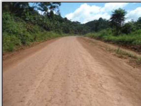
Foto 1158 - Pista reconformada. S 03.57969° W 053.21487°. 26/02/2014.
