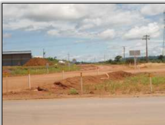
Foto 463. Acesso ao canteiro Bela Vista – Canais e Diques. Lado esquerdo. Estaca 4258. S 03.12479° W 051.73776° 24/04/2014
