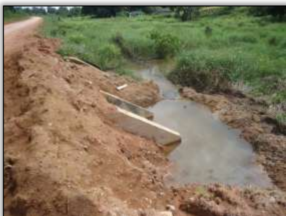
Foto 1009 – Construção de bueiro. S 03.85927° W 054.06721° 14/05/2014.
