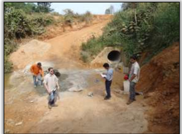
Foto 629 – Equipe de supervisão orientando técnicos da Tamasa. Lado direito. S 05.04689° W 049.45644° 17/06/2014
