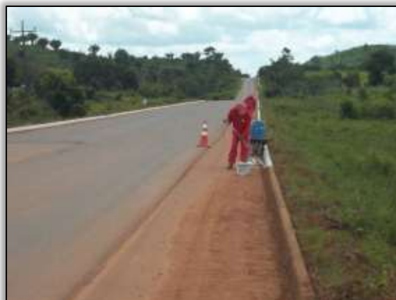
Foto 1169 – CCM realizando a caiação do meio fio. Estaca 2070. S 03.82561° W 050.68848° 28/03/2014
