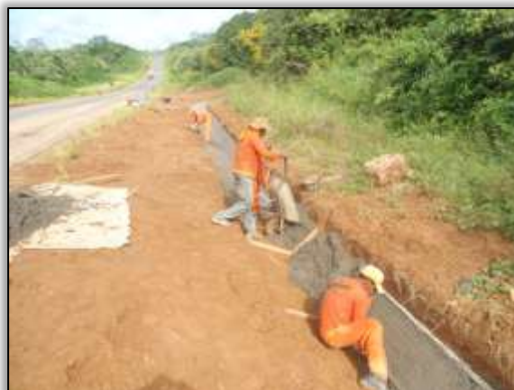
Foto 705 – Construção de sarjeta. Lado esquerdo. Estaca 5027. S 03.54511º W 051.11832º 25/06/2014
