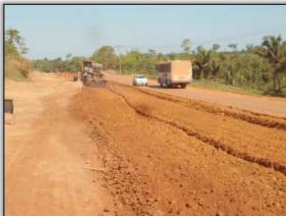
Foto 1044 - Terraplenagem. Estaca 8520. S 03.87557° W 054.24002° 15/07/2014.
