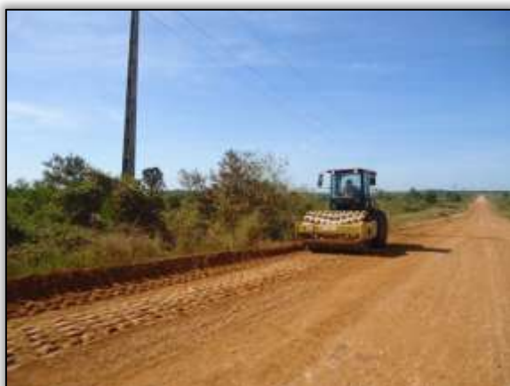
Foto 524 – Compactação de solo. Lado direito. S 05.18591° W 049.36599° 03/06/2014
