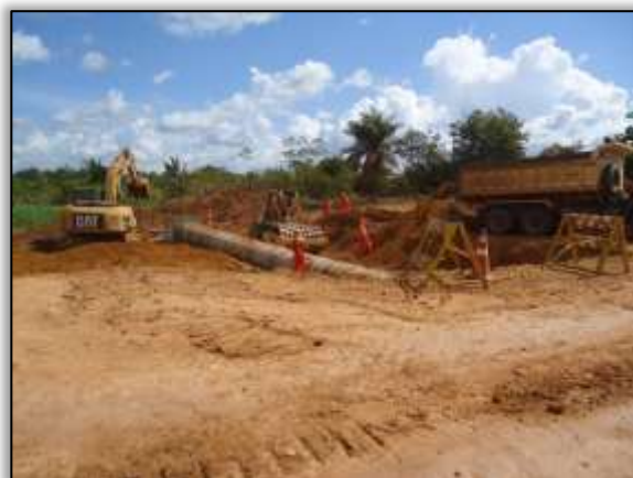
Foto 625 – Instalação de bueiro simples tubular de concreto. Lado esquerdo. S 04.95963° W 049.45843° 30/06/2014
