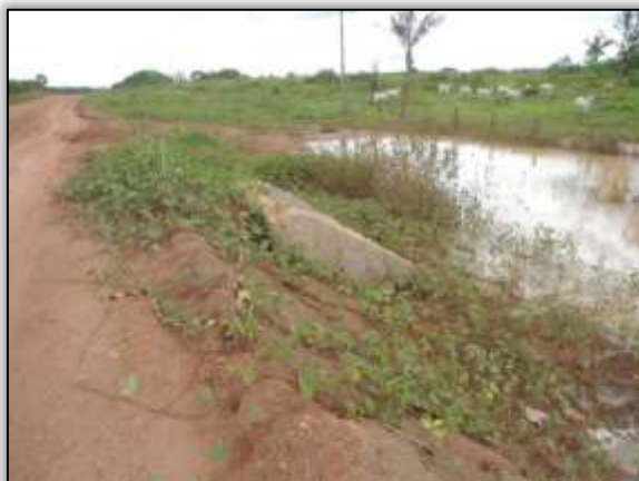
Foto 1081 – Bueiro concluído. S 03.88639° W 054.26505° 10/04/2014.
