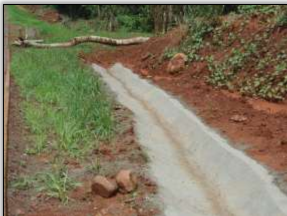
Foto 822 – Valeta concluída. Lado direito. Estaca 3464. S 03.42258° W 052.80099° 18/02/2014.
