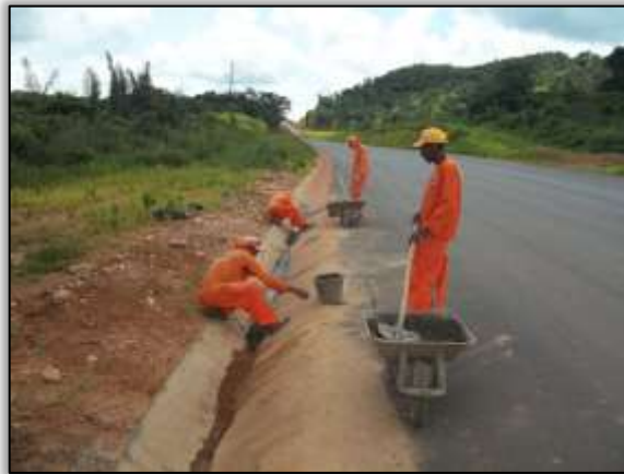
Foto 1307 – Conclusão do dispositivo de drenagem. Lado esquerdo. Estaca 4671. S 03.53154° W 051.06193° 28/03/2014
