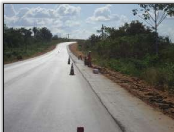
Foto 537 – Corte asfalto para alocação de meio fio. Lado direito. S 05.26145° W 049.32113° 16/07/2014
