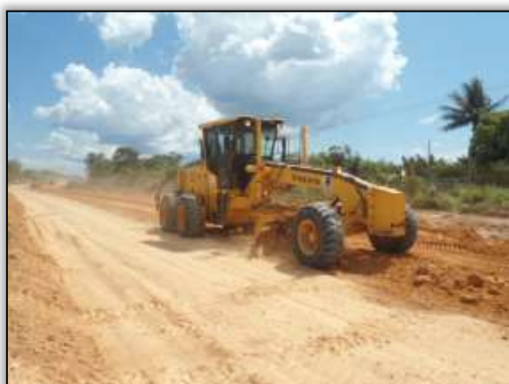
Foto 1039 - Terraplenagem. Estaca 8507. S 03.87477° W 054.23750° 07/07/2014.
