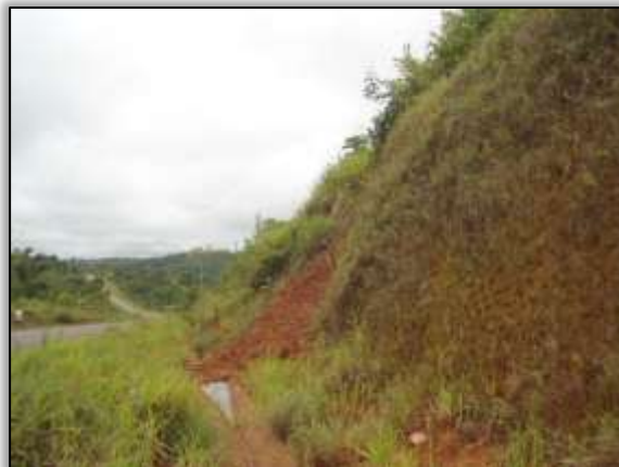
Foto 865 – Desmoronamento de talude de corte e obstrução de sarjeta. Lado direito. Estaca 2134. S 03. 34745° W 052. 61386° 25/03/2014.
