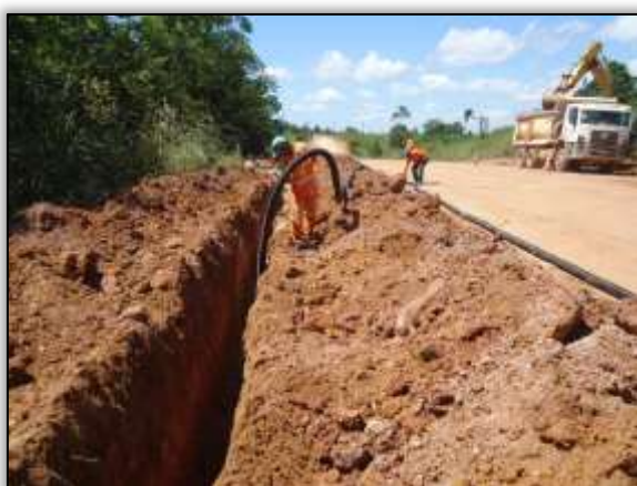
Foto 1314 – Alocação de dreno profundo. Lado direito. S 05.22487° W 049.34043° 30/04/2014
