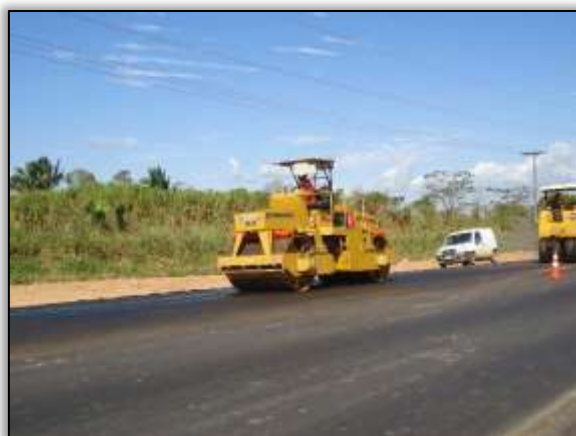
Foto 560 – Atividades de compactação asfáltica. Lado direito. S 05.19663° W 049.36039° 16/07/2014
