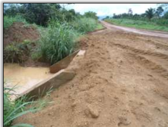
Foto 1068 - Bueiro concluído. S 03.88810° W 054.29900°. 25/02/2014.
