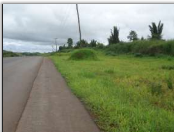
Foto 1264 – Aplicação de hidrossemeadura. Ambos os lados. S 04.06377° W 050.24388° 18/02/2014
