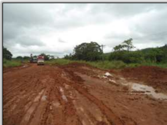
Foto 981 - Atoleiro em caminho de serviço. S 03.85085° W 054.15346°. 19/02/2014.
