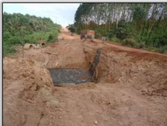
Foto 533 – Substituição de bueiro triplo tubular de concreto. Lado direito. S 05.15319° W 049.38892° 14/05/2014
