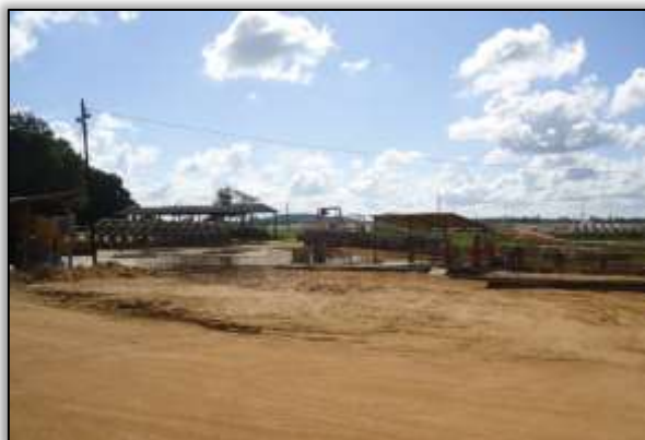
Foto 501 – Fabricação de bueiros. S 05.14409° W 049.35769° 30/06/2014
