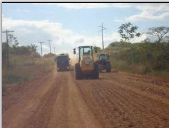
Foto 526 – Compactação de solo. Lado direito. S 05.24605° W 049.33047° 18/06/2014
