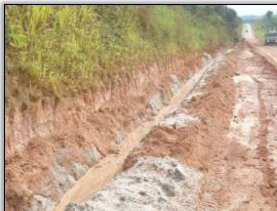
Foto 703 – Dreno profundo. Lado esquerdo. Estaca 4456. S 03.60283° W 051.03676° 25/06/2014
