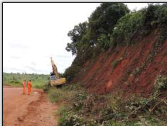
Foto 1369 – Limpeza em talude. Lado esquerdo. S 05.18701° W 049.36444° 02/05/2014
