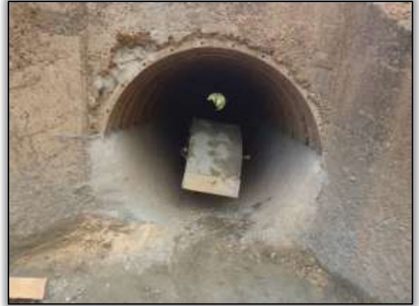
Foto 615 – Reforço de concreto em bueiro ARMCO. Lado direito. S 05.01652° W 049.45953° 06/05/2014
