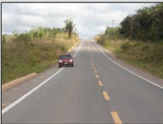
Foto 1349 – Revestimento vegetal em saia de aterro. S 05.36075° W 049.12300° 02/07/2014
