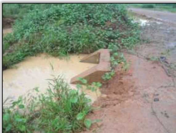
Foto 998 - Bueiro concluído. S 03.86096° W 054.18912°. 27/03/2014.
