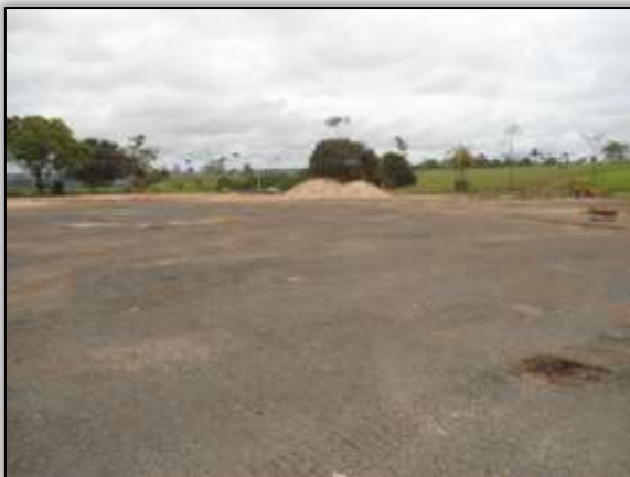
Foto 775– Área industrial desmobilizada. Lado Direito. Estaca 1880. S 03.30814° W 052.54790° 23/05/2014.
