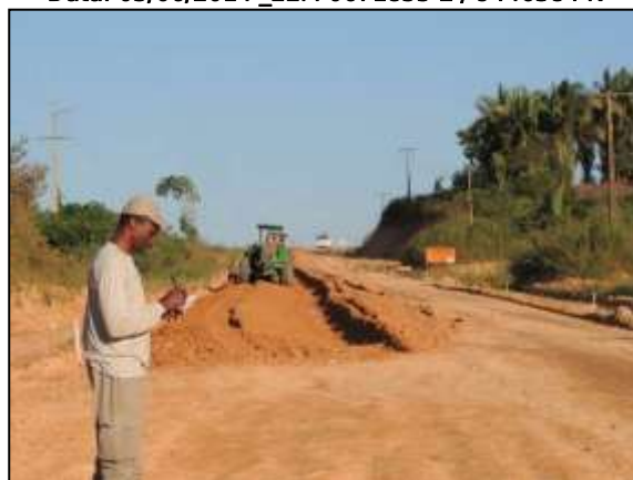
Figura 155. Equipe acompanhando terraplenagem no trecho entre Marabá e Itupiranga – Lote Único. Data: 05/06/2014 _22M 0683145 E / 9423246 N
