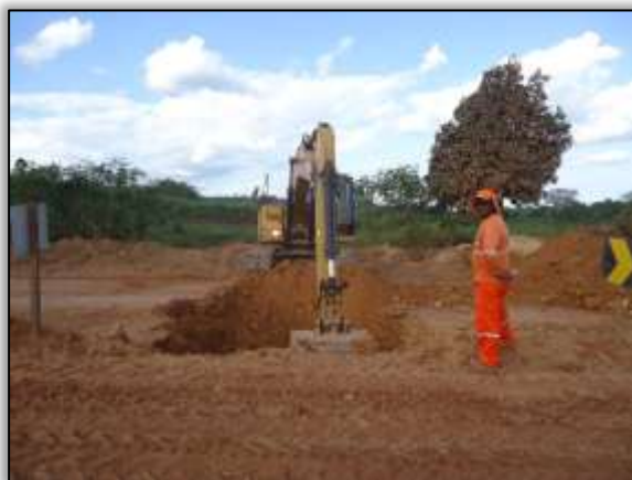
Foto 622 – Instalação de bueiro simples tubular de concreto. Lado esquerdo. S 04.95963° W 049.45843° 13/06/2014
