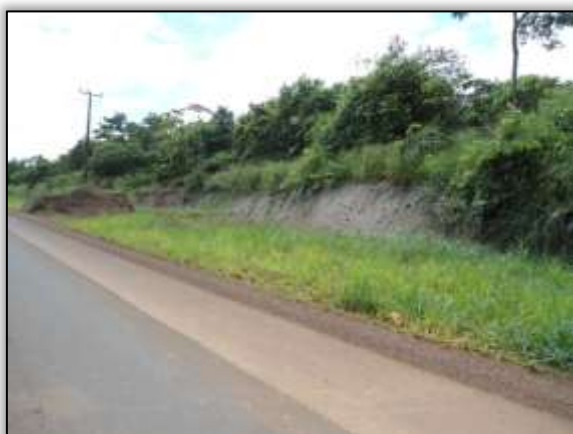
Foto 1310 – Hidrossemeadura em talude de corte. Lado direito. Estaca 3404. S 03.41724° W 052.79204° 27/03/2014.
