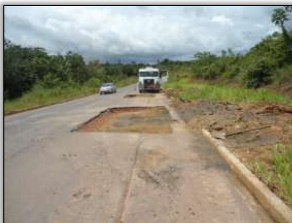
Foto 832 – Recuperação da pista. Lado Direito. Estaca 3545. S 03.43034° W 052.81159° 26/03/2014.
