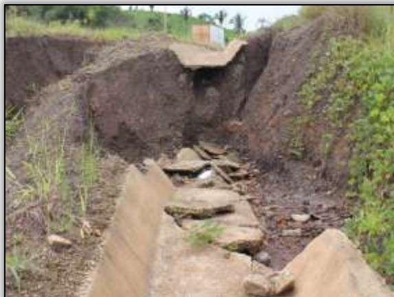
Foto 1334 – Erosão no aterro e danificação de sarjeta. Lado Esquerdo. Estaca 2683. S 03. 38001° W 052. 66970° 17/04/2014.
