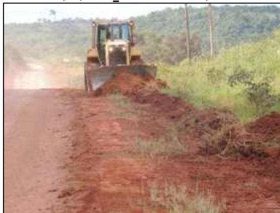
Figura 127. Limpeza de lateral, no trecho entre Itupiranga e Cajazeiras – Lote 01. Data: 07/05/2014 _ 22M 0671872 E / 9446435 N
