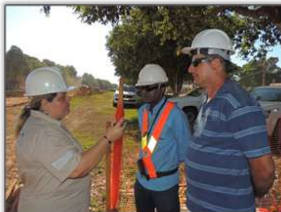
Foto 424 – Trecho em obras supervisionado pelos Técnicos Seg. do trabalho. Placas/PA, 15/07/2014.
