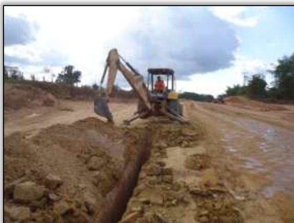
Foto 1345 – Abertura para instalação de dreno profundo. Lado esquerdo. S 05.96978° W 049.44634° 17/07/2014
