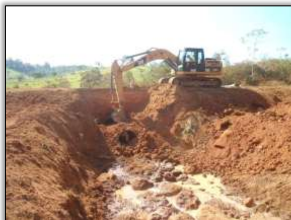
Foto 637 – Abertura para instalação de bueiro. Lado esquerdo. S 04.94230° W 049.46908° 08/07/2014
