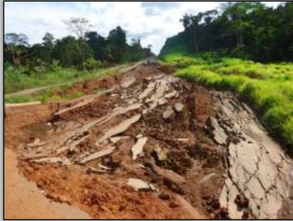
Foto 900. Área de estudos geotécnicos- rebaixamento corpo estradal. Estaca 3700. S 03.44083° W 052.84990° 18/07/2014.
