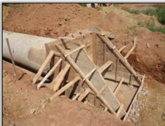
Foto 1100 - Construção de bueiro. Estaca 8949. S 03.89122° W 054.31115° 27/05/2014.
