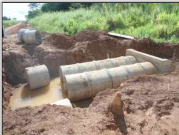
Foto 1093 – Construção de bueiro. S 03.89319° W 054.44006 24/04/2014.
