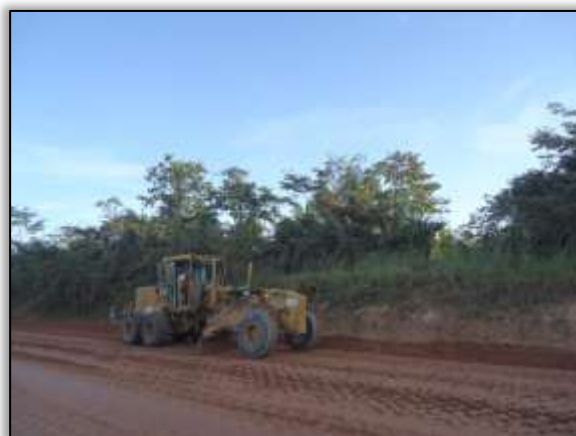
Foto 523 – Terraplanagem. Lado esquerdo. S 05.18179° W 049.36861° 14/05/2014
