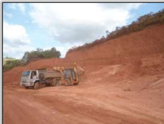
Foto 1251 – Caixa de empréstimo. Lado esquerdo. S 03.84880º W 050.92962º 29/07/2014
