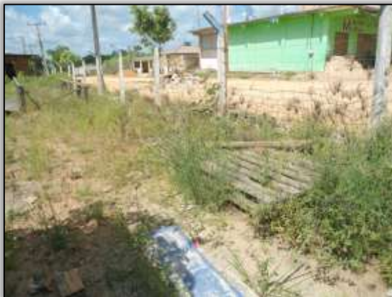
Foto 781. Canteiro de obras. Lado esquerdo. Estaca 1827. S 03.30872° W 052.53631° 10/07/2014.
