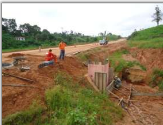
Foto 613 – Construção de bueiro. Lado esquerdo. S 05.08455° W 049.42826° 23/04/2014
