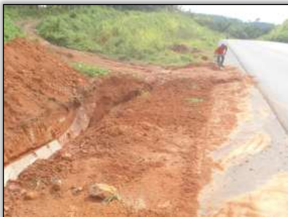
Foto 704 – Construção de sarjeta. Lado esquerdo. Estaca 4942. S 03.55487º W 051.10637º 25/06/2014
