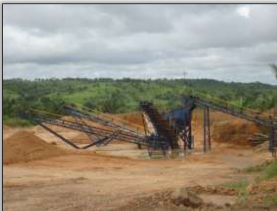
Foto 507 – Instalação do separador de agregado. Lado esquerdo. S 05.21944° W 049.34484° 25/03/2014
