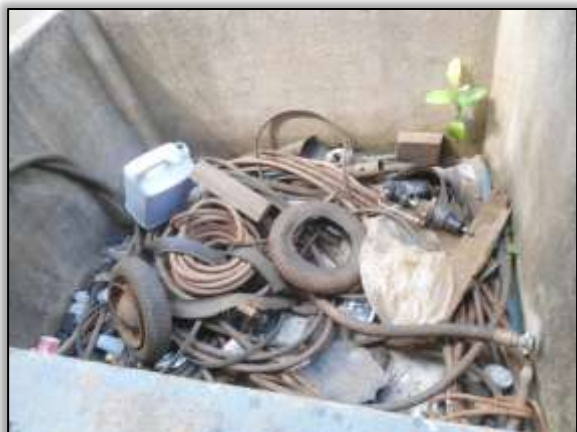
Foto 783. Canteiro de obras. Lado esquerdo. Estaca 1827. S 03.30872° W 052.53631° 10/07/2014.
