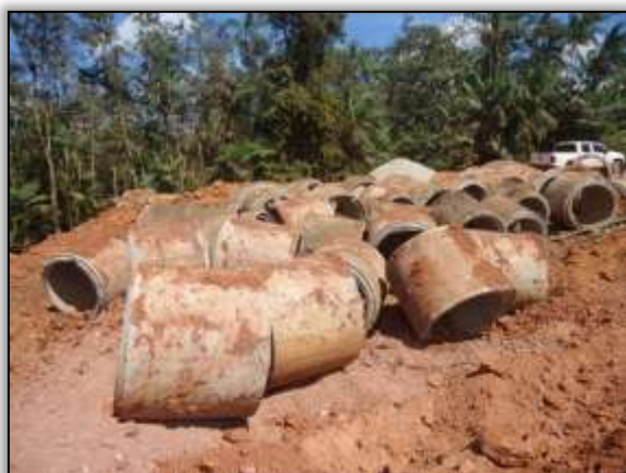
Foto 1030 - Remoção de bueiro. S 03.85325° W 054.16119° 24/06/2014
