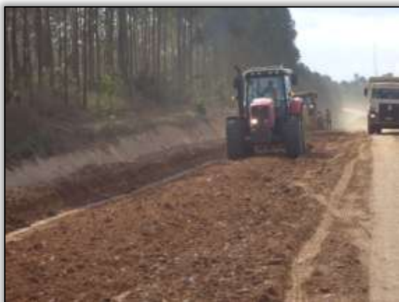
Foto 528 – Gradeamento. Lado esquerdo. S 05.16740° W 049.37820° 18/06/2014
