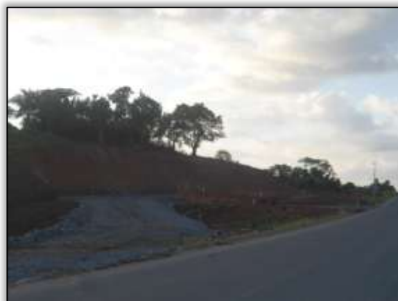
Foto 454- Rotatório para o acesso ao porto do CCBM. Lado esquerdo. Estaca 4572. S 03.12021° W 051.79644° 26/02/2014
