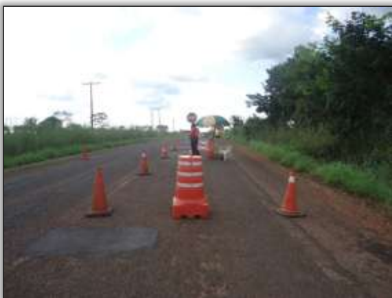
Foto 1181 – sinalização adequada. Lado direito. S 05.67409° W 048.38511° 22/04/2014
