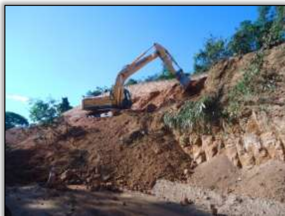
Foto 655 – Corte de talude. Lado direito. S 04.94474° W 049.46816° 21/07/2014
