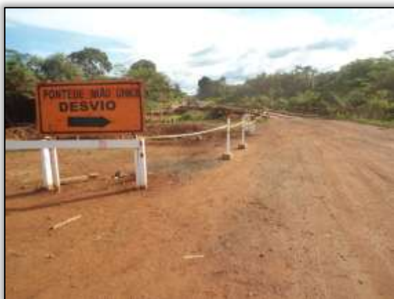
Foto 918 – Sinalização horizontal. Lado esquerdo. S 03.31975° W 052.56762° 11/06/2014.
