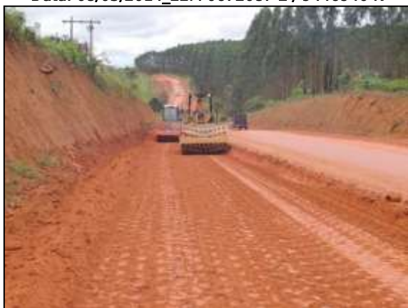
Figura 130. Terraplanagem no trecho entre Marabá e Itupiranga - Lote único. Data: 09/05/2014_22M 0678730 E / 9429899 N
