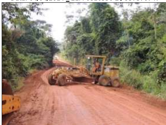
Figura 88. Manutenção do traçado, entre Novo Repartimento e Cajazeiras – Lote 01.
