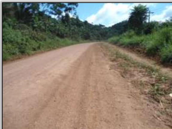
Foto 1157 - Pista reconformada. S 03.57969° W 053.21487°. 26/02/2014.
