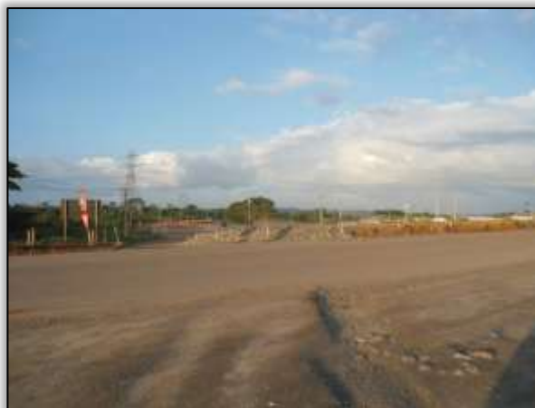
Foto 450 – Final do desvio da rodovia. Lado direito. S 03.12383° W 051.78881° 26/02/2014
