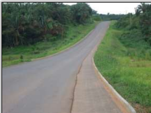
Foto 1261 – Aplicação de hidrossemeadura. Ambos os lados. S 03.97070° W 050.26173° 18/02/2014
