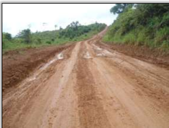
Foto 1175 – Buracos na pista e formação de atoleiro. S 03.49541° W 053.09735° 19/03/2014.
