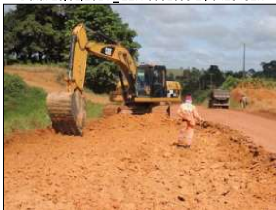
Figura 75. Obras de terraplenagem na rodovia entre Itupiranga e Cajazeiras – Lote 01.
