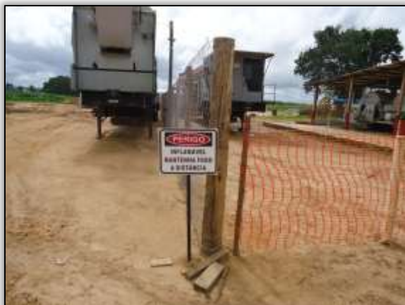
Foto 493 – Base Usina de Asfalto. S 05.14373° W 049.35671° 23/04/2014
