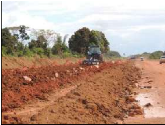
Figura 172. Acompanhamento de terraplenagem na rodovia, trecho entre Uruará e Placas – Lote 02. Data: 25/06/2014 _ 21M 0811013 E / 9572418 N
