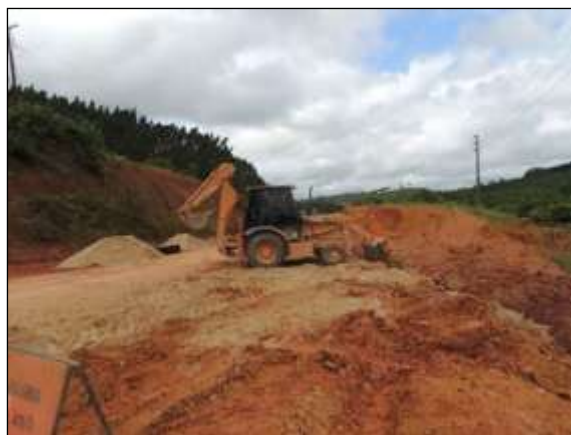
Figura 97. Reconformação da bota fora, no trecho entre Itupiranga e Cajazeiras – Lote único. Data: 14/04/2014 _ 22M 0673970 E / 9440895 N
