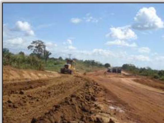
Foto 1034 - Terraplanagem. Estaca 8218. S 03.86058° W 054.18610° 24/10/2014.
