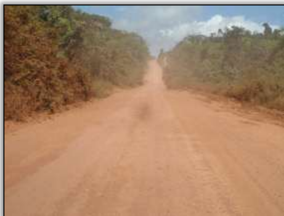
Foto 1244 - Pista reconformada. S 03.53567° W 053.17023° 10/07/2014.
