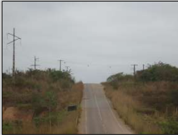
Foto 439 – Entrada para áreas de apoio do canteiro de obras. S 05.14985°W 049.38852° 29/07/2014
