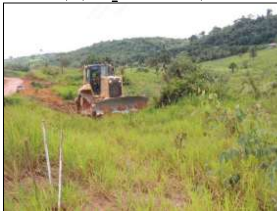
Figura 139. Supressão de vegetação em área lateral da rodovia, trecho entre Itupiranga e Cajazeiras – Lote 01.
