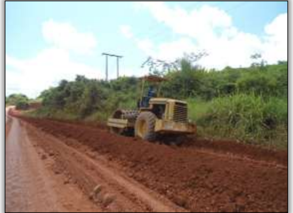
Foto 1221 – Atividades de compactação do solo. S 04.21397° W 049.51707° 02/07/2014
