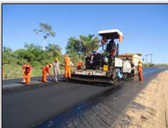
Foto 546 – Atividade de pavimentação por Vibroacabadora. S 05.25899° W 049.32444° 24/06/2014
