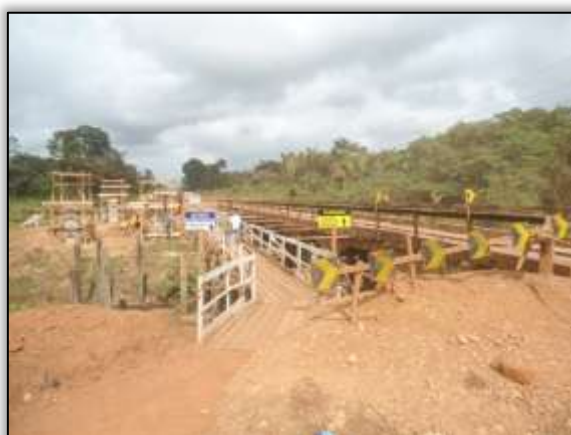
Foto 927 - Sinalização da ponte com delineadores refletivos. Estaca 1827. S 03.30872° W 052.53631° 30/07/2014.
