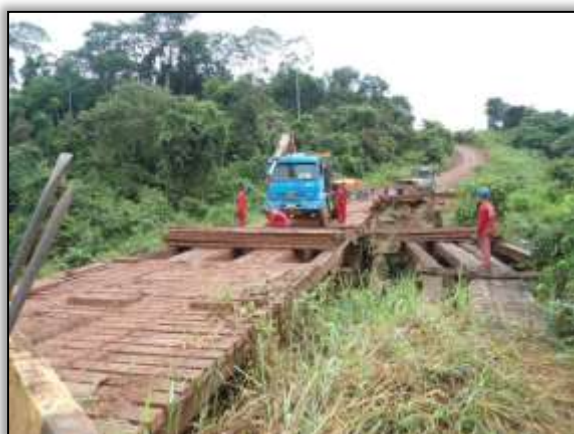
Foto 1133 - Reforma na ponte do Ig. Ganzer I. S 04.060383°W 54.748033°. 11/02/2014.
