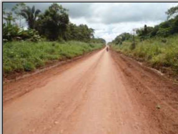
Foto 1151 - Pista reconformada. S 03.48131° W 052.95565°. 19/02/2014.
