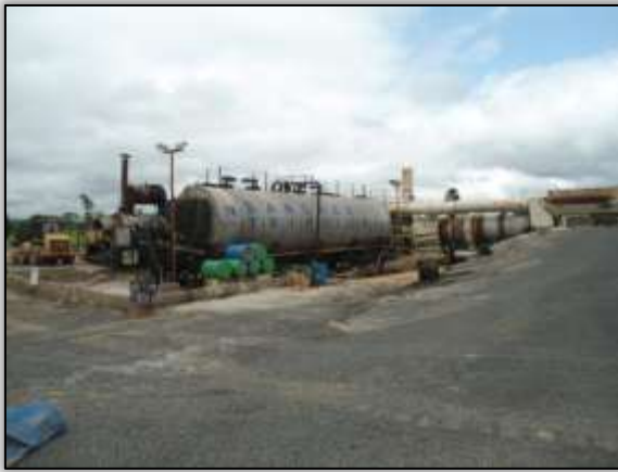
Foto 769 – Usina de asfalto. Lado direito. Estaca 1880. S 03.30814° W 052.54790° 25/02/2014.
