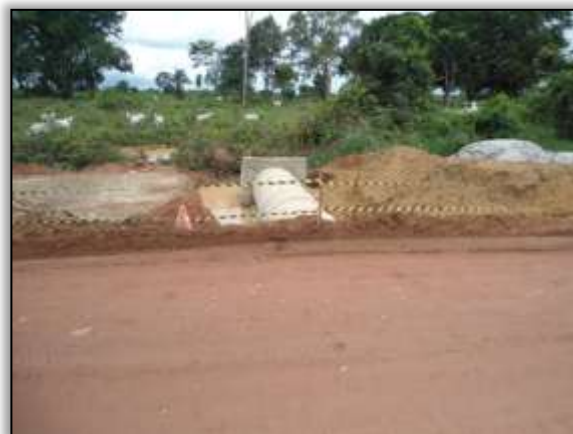
Foto 1066 - Bueiro concluído. Estaca 8673. S 03.88657° W 054.26540°. 19/02/2014.
