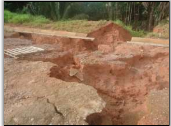
Foto 688 – Rompimento de dreno/aterro de bota fora solto. Lado esquerdo. S 03.94136º W 050.30764º 18/02/2014
