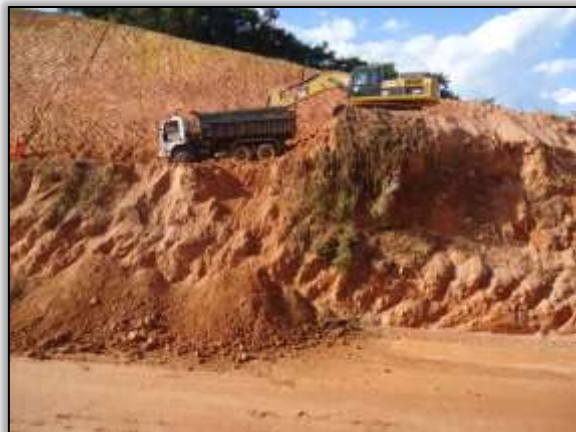
Foto 650 – Atividade de corte em talude. Lado direito. S 04.95595° W 049.46061° 16/07/2014
