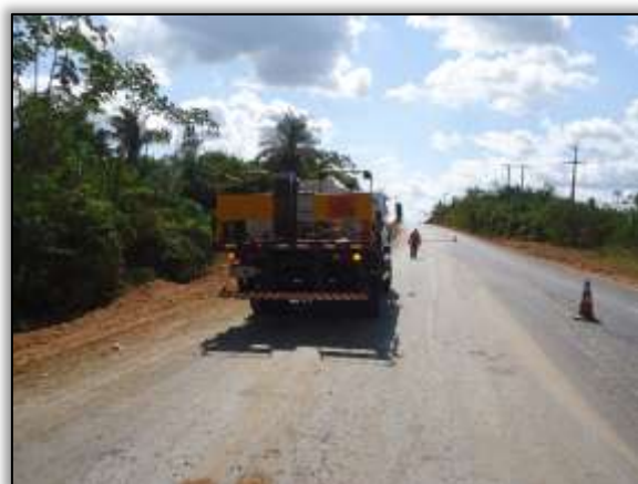
Foto 555 – Aplicação de emulsão asfáltica. Lado esquerdo. S 05.18539° W 049.36637° 17/07/2014
