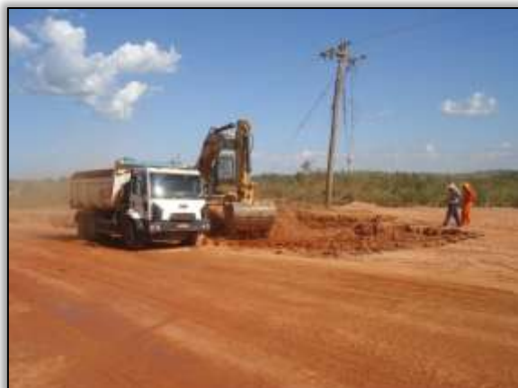
Foto 656 – Corte em corpo estradal. Lado esquerdo. S 04.95726° W 049.45836° 28/07/2014
