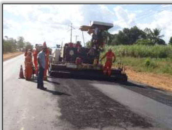
Foto 558 – Atividade de pavimentação. Lado direito. S 05.19647° W 049.36045° 16/07/2014
