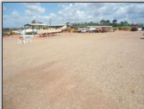
Foto 756 – Visão geral do pátio do canteiro. Lado esquerdo. Estaca 561 S 03.45172° e W 051.21874° 30/07/2014
