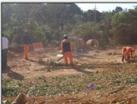
Foto 1472 - Supressão vegetal com a utilização de motosserra. Lado esquerdo. S 04.93669° W 049.46981° 21/07/2014
