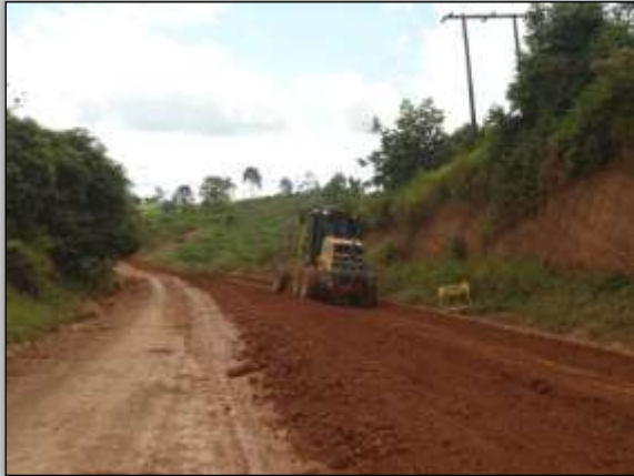
Foto 1220 – Atividades de terraplenagem. S 04.24230° W 049.93637° 02/07/2014
