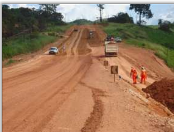
Foto 600 – Atividade de escalonamento. Lado esquerdo. S 05.01727° W 049.45705° 06/05/2014
