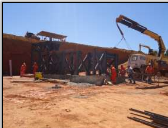
Foto 576 – Montagem do britador. Lado direito. S 04.90479° W 049.47627° 01/07/2014
