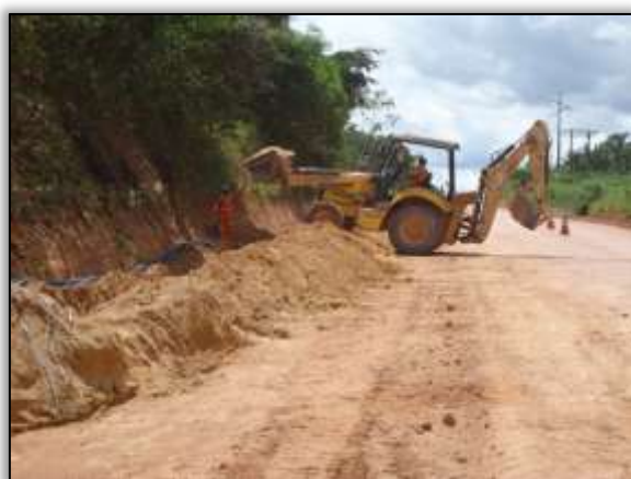
Foto 1297 – Alocação de dreno longitudinal. Lado esquerdo. S 05.040081° W 049.45913° 18/03/2014
