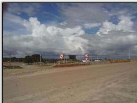
Foto 458 – Final do desvio da rodovia. Lado direito. Estaca 4370. S 03.12383° W 051.78881° 03/04/2014
