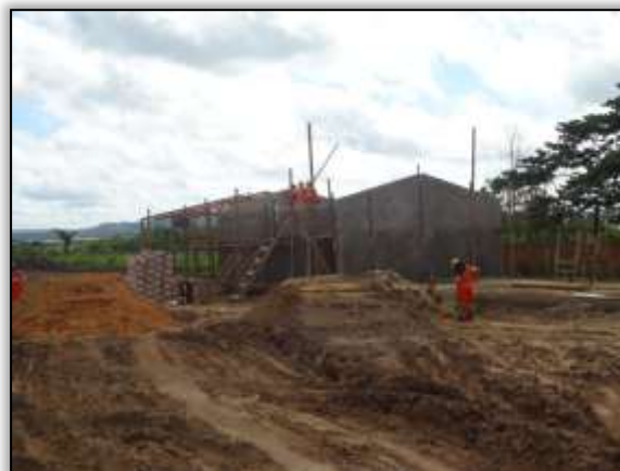
Foto 948 - Construção do alojamento. Lado direito. S 03.87007° W 054.22316° 10/06/2014.
