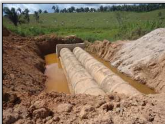
Foto 1024 – Construção de bueiro. Estaca 7800. S 03.85744° W 054.11480° 24/06/2014.
