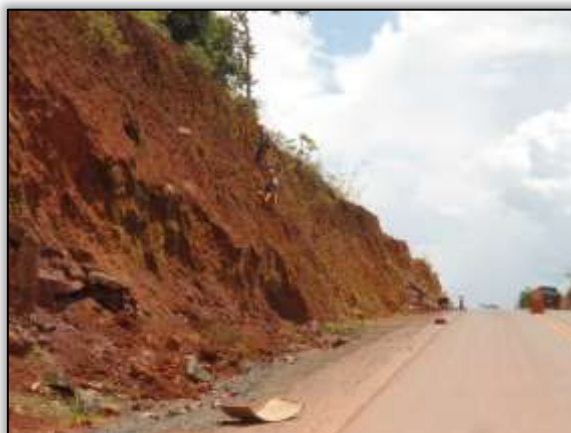
Foto 1309 – Preparo para hidrossemeadura. Lado esquerdo. Estaca 3722. S 03.44171° W 052.84215° 27/03/2014.
