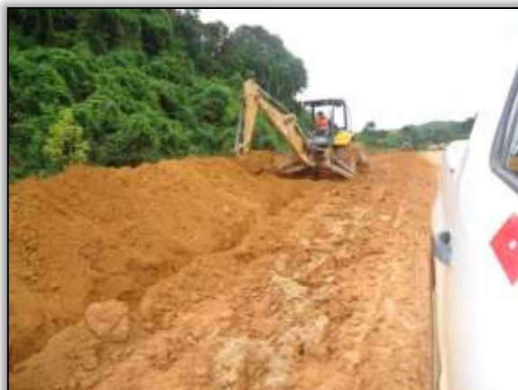
Foto 1296 – Alocação de dreno longitudinal. Lado direito. S 05.04950° W 049.45440° 25/03/2014
