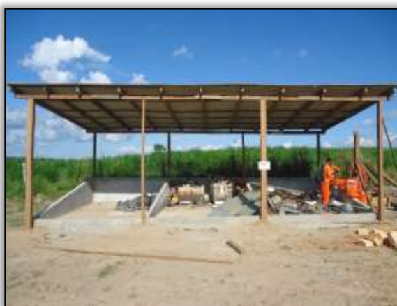
Foto 497 – Construção de cobertura na baia de resíduos metálicos. S 05.14417° W 049.35648° 03/06/2014 (depois)
