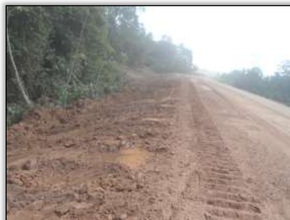
Foto 1645 – Supressão vegetal na faixa de domínio. Lado esquerdo. Estaca 8810 a 8850. S 03.88926° W 054.28759° 07/07/2014.
