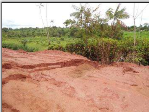
Foto 1361 – (Antes) Processo erosivo na saída do aterro. Lado esquerdo. Estaca 4109. UTM E 418238 N 9654567 09/02/2012
