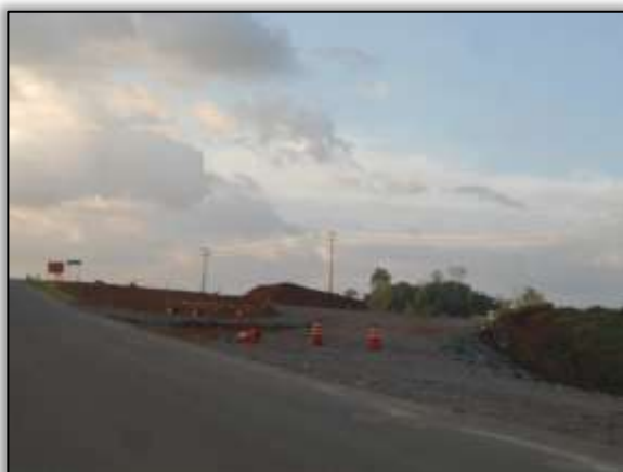
Foto 453- Acesso ao porto do CCBM. Lado direito. Estaca 4572. S 03.12021° W 051.79644° 26/02/2014
