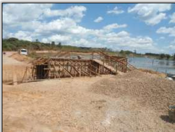
Foto 1121 – Construção de galeria. Estaca 8710. S 03.89008° W 054.27016° 15/07/2104.
