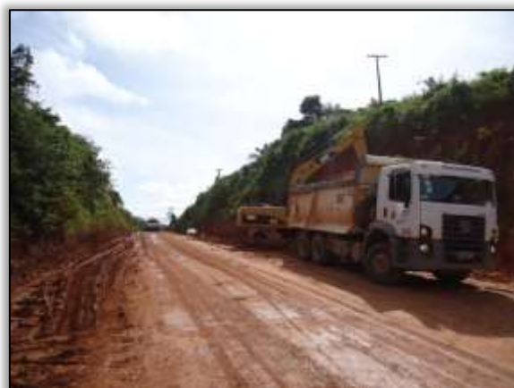
Foto 643 – Atividade de corte na rodovia. Lado direito. S 05.18313° W 049.36771° 15/05/2014
