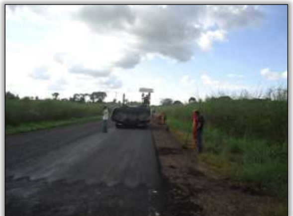
Foto 1182 – Acabamento na junta longitudinal. Lado direito. S 05.67229° W 048.38637° 22/04/2014
