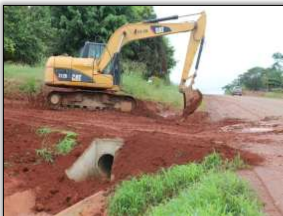
Foto 835 – Bueiro simples de concreto. Lado Esquerdo. Estaca 2206. S 03.34083° W 052.59320° 17/04/2014.
