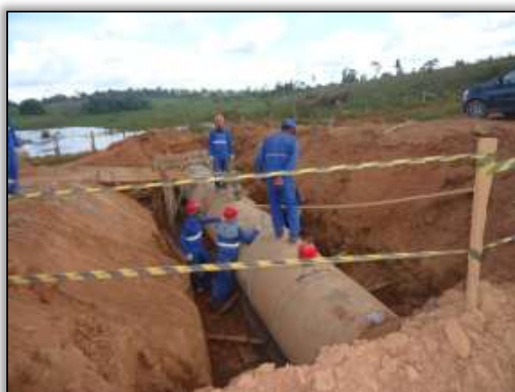
Foto 1109 – Implantação de bueiro. S 03.89237° W 054.45609° 24/06/2014.
