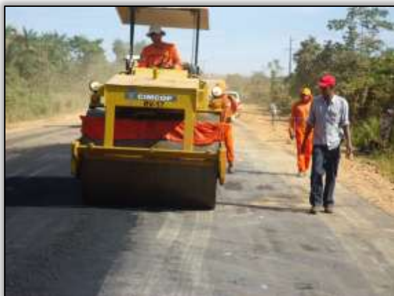
Foto 550 – Atividades de compactação asfáltica. Lado direito. S 05.26069° W 049.322121° 10/06/2014
