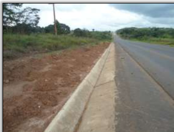
Foto 1278 – Sistema de drenagem. Lado direito. Estaca 2239. S 03.34240° W 052.59805° 25/02/2014.
