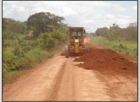
Foto 1202 – Reconformação da pista. S 03. 85930° W 054. 05264° 14/04/2014
