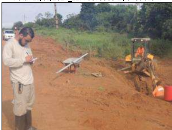
Figura 56. Acompanhamento da construção de escada d'água entre Marabá e Itupiranga – Lote Único. Data: 11/01/2014_22M 0686896 E / 9417598 N
