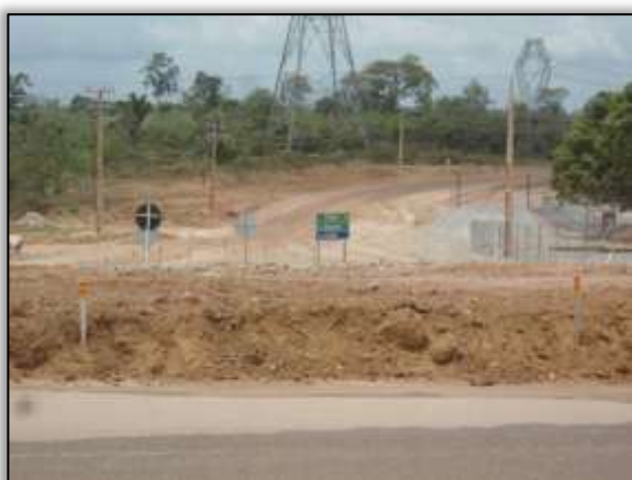
Foto 465 – Final do desvio da rodovia. Lado direito. S 03.12383° W 051.78881° 24/04/2014
