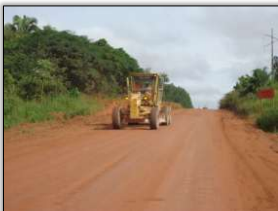
Foto 518 – Regularização do corpo estradal da rodovia. Lado esquerdo. S 05.03587° W 049.45863° 13/03/2014
