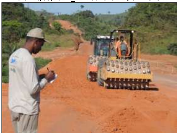
Figura 148. Acompanhamento de terraplenagem entre Itupiranga e Cajazeiras - Lote 01. Data: 31/05/2014 _22M 0671819 E / 9446336 N
