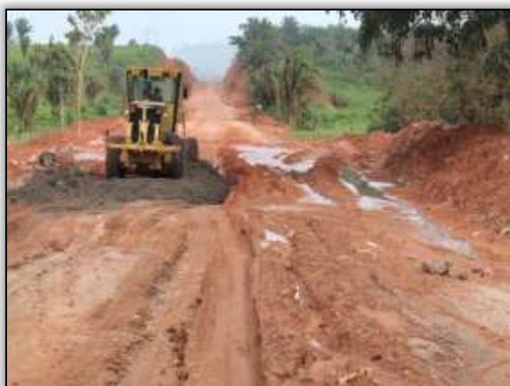
Foto 1188 – CCM realizando a reconformação da via. Lado esquerdo. S 03.84568° W 050.56306° 29/04/2014
