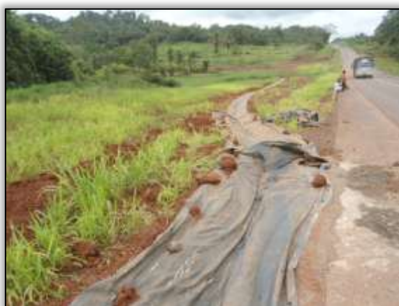
Foto 831 – Construção de sarjeta. Lado esquerdo. Estaca 3618. S 03.43746° W 052.82408° 25/03/2014.
