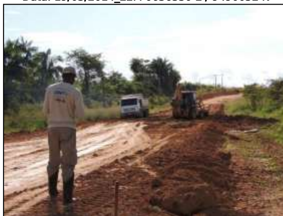
Figura 137. Biólogo acompanhando frente de serviço, terraplenagem no trecho entre Marabá e Itupiranga – Lote único.
