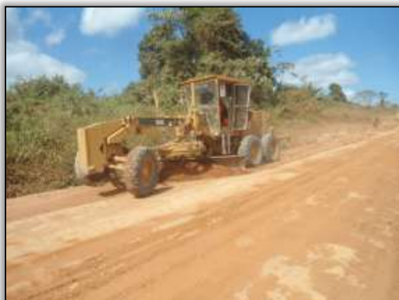
Foto 1230 - Conservação da pista. S 03.70932° W 053.70361° 17/07/2014.
