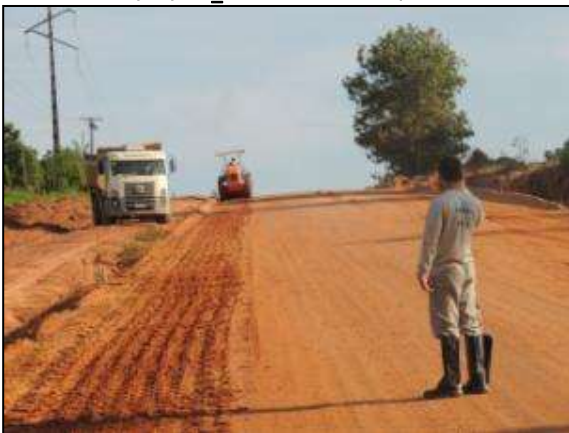
Figura 52. Acompanhamento de terraplenagem entre Itupiranga e Cajazeiras – Lote 01. Data: 10/01/2014 _ 22M 0672574 E / 9440404 N
