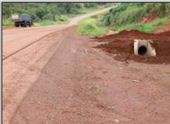
Foto 837 – Bueiro simples de concreto. Lado Direito. S 03.42693° W 052.80714° 17/04/2014.
