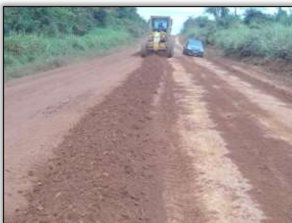
Foto 1226 - Reconformação na pista. S 03. 59775° W 053. 23524° 01/07/2014
