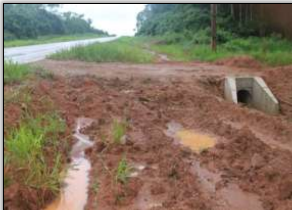
Foto 833 – Bueiro simples de concreto. Lado direito. Estaca 2040. S 03.32191° W 052.57093° 17/04/2014.
