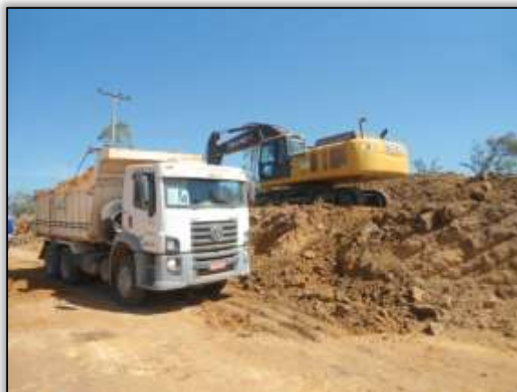
Foto 1130 – Corte em talude. Lado direito. Estaca 8893. S 03.88862° W 054.30147° 30/07/2014.
