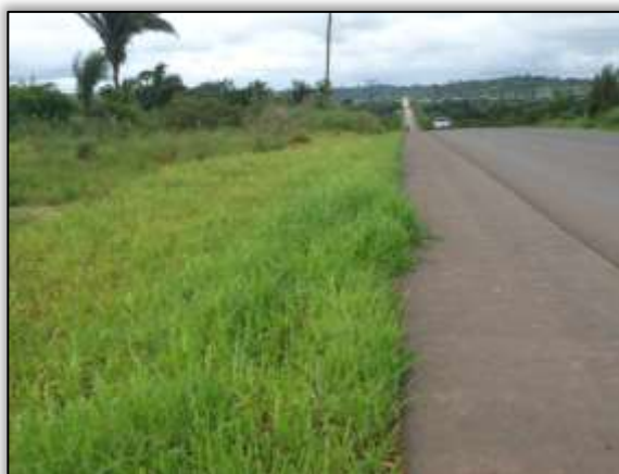
Foto 1265 – Aplicação de hidrossemeadura. Ambos os lados. S 04.09267° W 050.27821° 18/02/2014
