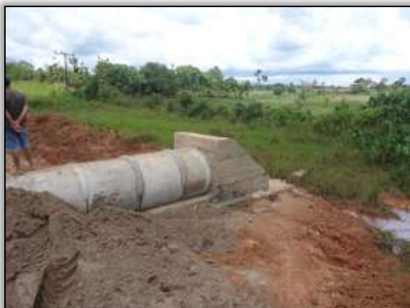
Foto 1095 – Construção de bueiro. S 03.89241° W 054. 45519° 15/05/2014.
