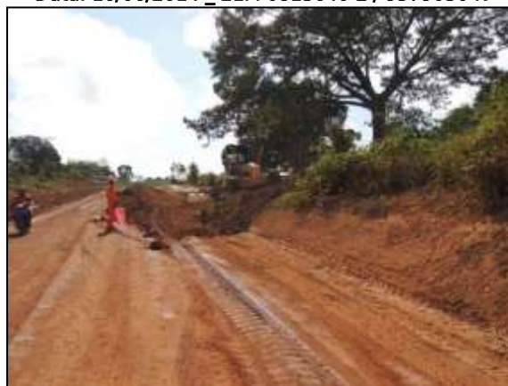
Figura 169. Acompanhamento de limpeza lateral na rodovia, entre Placas e Rurópolis – Lote 03. Data: 18/06/2014 _ 21M 0803194 E / 9569574 N
