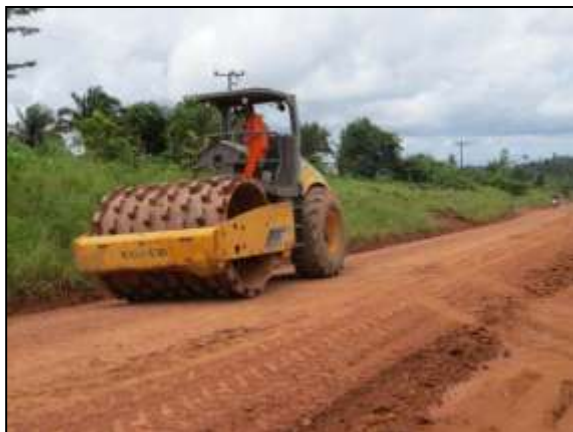
Figura 78. Terraplenagem em área da rodovia BR-422/PA entre Novo Repartimento e Tucuruí.
