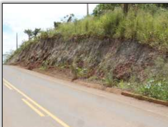
Foto 1311 – Hidrossemeadura em talude de corte. Lado direito. Estaca 3345. S 03.41409° W 052.78305° 27/03/2014.
