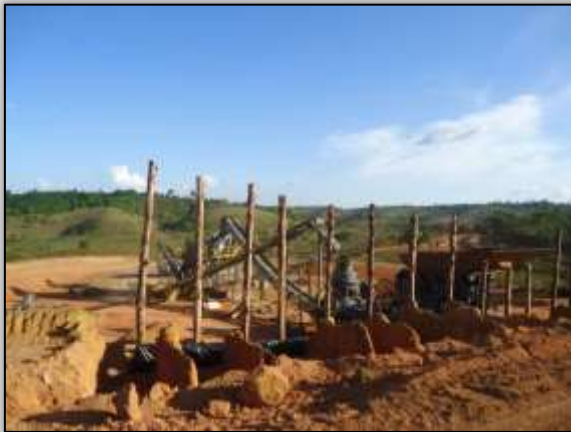
Foto 586 – instalação do britador. Lado direito. S 04.90479° W 049.47627° 16/07/2014
