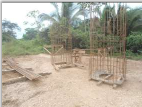
Foto 925 – Armação das colunas e ferros retirados do contato direto no solo. Lado esquerdo. Estaca 1827. S 03.30872° W 052.53631° 30/07/2014.
