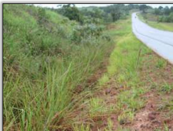
Foto 1327 – Hidrossemeadura em talude de corte. Lado esquerdo. Estaca 3424. S 03.41842° W 052.79490° 17/04/2014.
