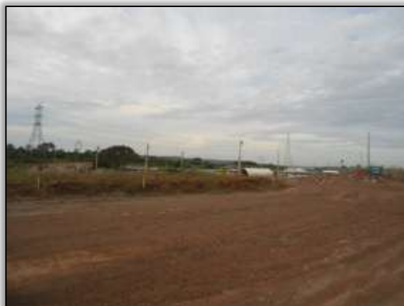
Foto 480 – Final do desvio da rodovia. Lado direito. S 03.12383° W 051.78881° 02/06/2014
