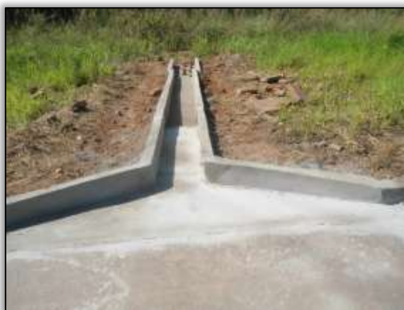
Foto 735 –Reconformação da descida d' água danificada.lado esquerdo. S 03.10419° W 053.90980° 09/07/2014
