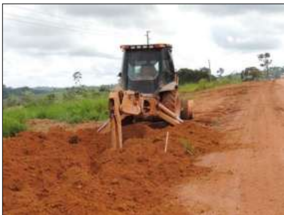
Figura 102. Colocação de dreno, entre Itupiranga e Cajazeiras – Lote 01. Data: 15/04/2014 _ 22M 0670838 E / 9444781 N
