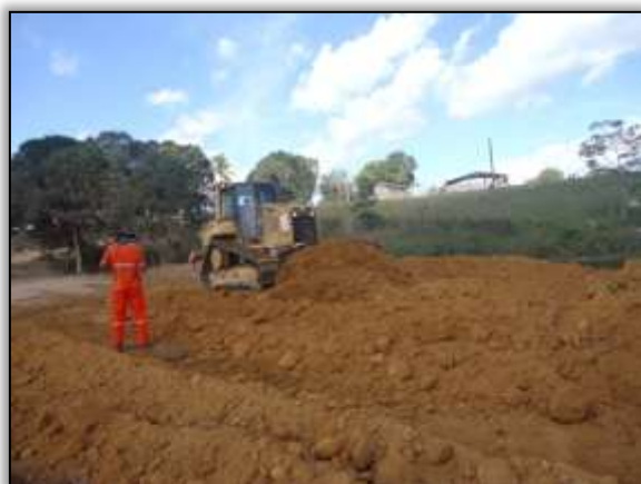
Foto 1036 - Aterro para construção do caminho de serviço. Lado esquerdo. Estaca 8588. S 03.87970° W 054.25177° 24/06/2014.
