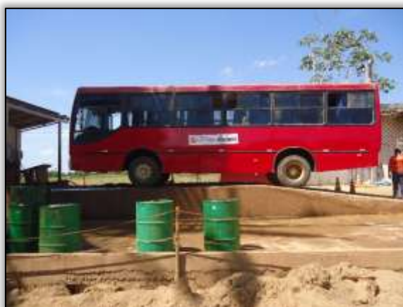
Foto 503 – Posto de Lavagem do canteiro. S 05.14436° W 049.35702° 29/07/2014
