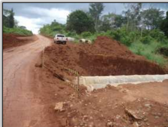
Foto 1078 - Construção de bueiro. S03. 88962° W 054.41409°. 19/03/2014.
