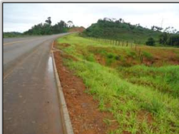
Foto 1300 – Processo erosivo recuperado 19/03/2014. Lado direito. S 04.19449° W 050.01511°
