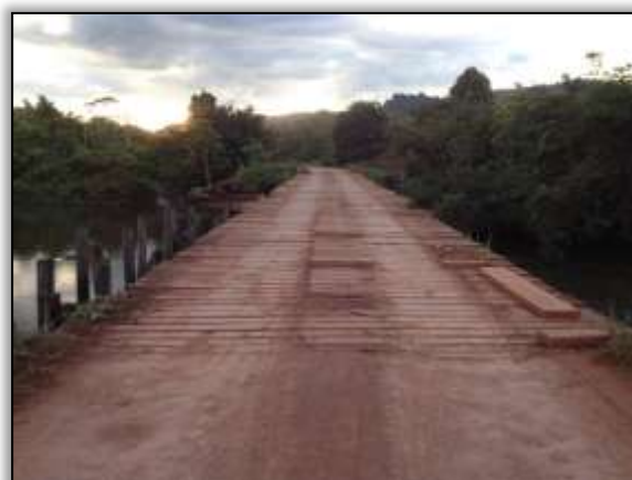
Foto 1134 – Reforma na ponte do Ig. Curuatinga. S 4.03420° W 54.69883° 24/02/2014.
