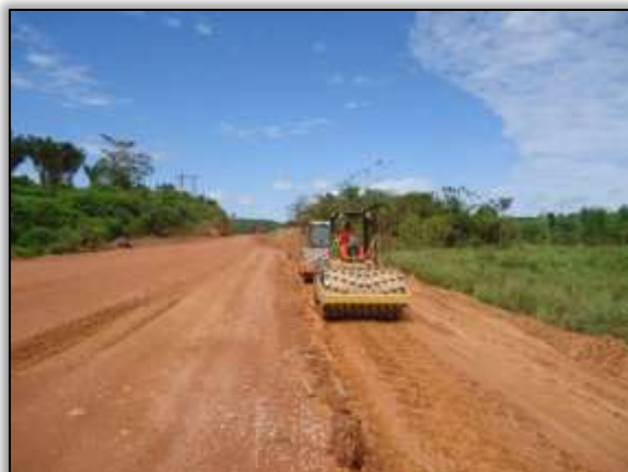
Foto 605 – Atividade de compactação na rodovia. Lado direito. S 04.99261° W 049.44595° 09/06/2014
