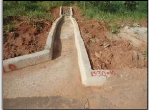
Foto 849– Reconstrução de descida d'água. Lado esquerdo. Estaca 1930. S 03.31346° W 052.55519° 02/06/14
