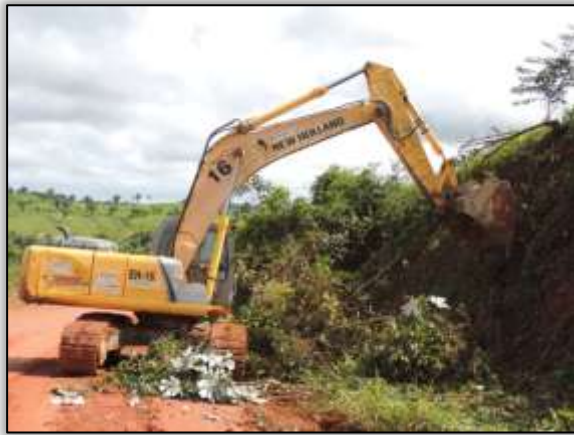
Foto 1375 – Limpeza em talude. Lado esquerdo. S 05.18701° W 049.36444° 02/05/2014
