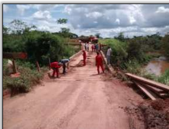
Foto 02 – Manutenção de ponte do igarapé Buriti. S 03.90535° W 050. 36314°. 08/05/2014.
