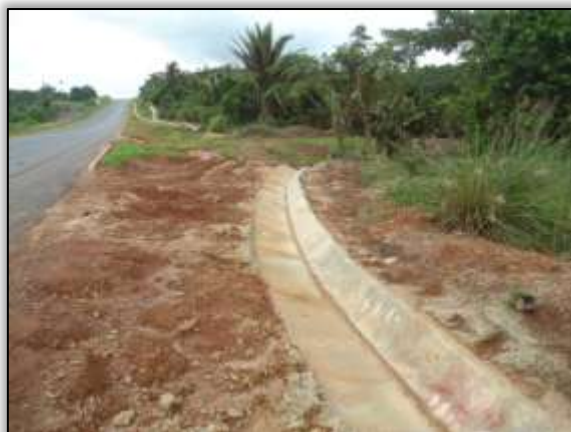
Foto 823 – Valeta concluída. Lado esquerdo. Estaca 2212. S 03.34094° W 052.59367° 18/02/2014.
