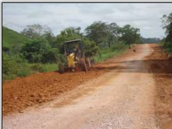
Foto 598 – Atividades de terraplenagem. S 05.03687° W 049.46009° 13/03/2013
