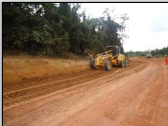
Foto 1101 – Corte em talude. Lado direito. Estaca 9075. S 03.89196° W 054.33186° 06/06/2014.
