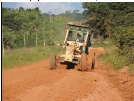
Figura 86. Limpeza lateral e manutenção do traçado entre Uruará e Placas – Lote 02.
