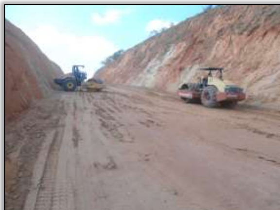
Foto 717 – Compactação da rodovia. S 03.65029° W 050.97474° 30/07/2014
