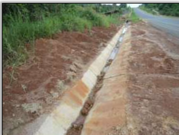
Foto 1277 – Valeta concluída. Lado direito. Estaca 2212. S 03.34094° W 052.59367° 25/02/2014.
