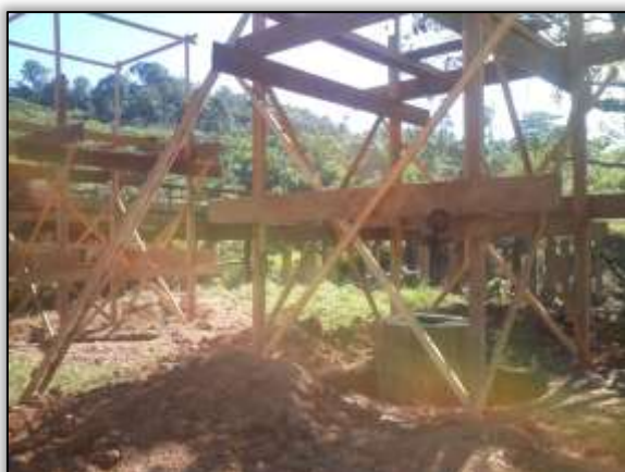
Foto 914 – Forma para base de pilares. Lado esquerdo. S 03.31975° W 052.56762° 13/06/2014.
