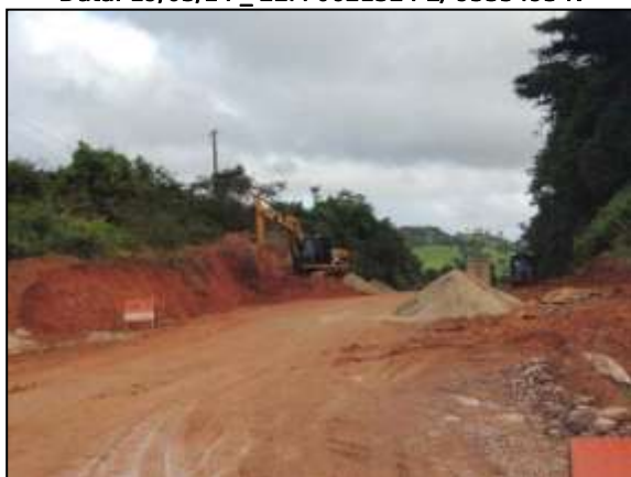
Figura 80. Atividade de bota fora em área da rodovia entre Itupiranga e Cajazeiras – Lote 01.
