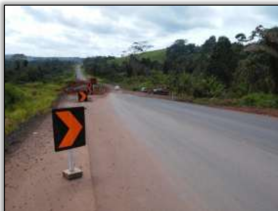
Foto 899. Sinalização com delineadores e placas refletivas- Dnit. Estaca 3700. S 03.44083° W 052.84990° 31/07/2014.
