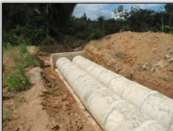
Foto 989 - Construção de bueiro. Estaca 7729. S 03.86309° W 054.10452°. 19/03/2014.
