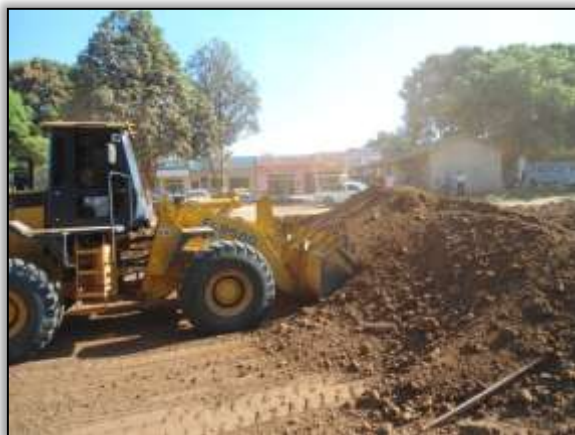
Foto 1042 - Terraplenagem. Estaca 8594. S 03.86898° W 054.21849° 15/07/2014.
