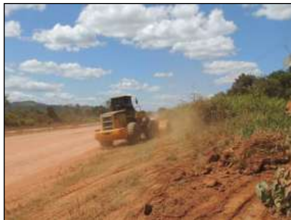
Figura 165. Acompanhamento de limpeza lateral da rodovia entre Uruará e Placas – Lote 02 Data: 13/06/2014 _ 21M 0811340 E / 9572503 N
