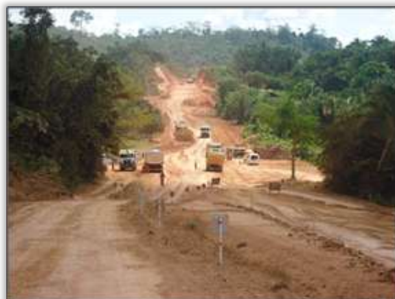
Foto 422 – Trecho em obras. Anapú/PA, 10/07/2014.
