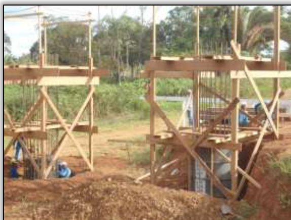
Foto 912 – Forma pronta para receber o concreto. Lado esquerdo. Estaca 1827. S 03.30872° W 052.53631° 11/06/2014.
