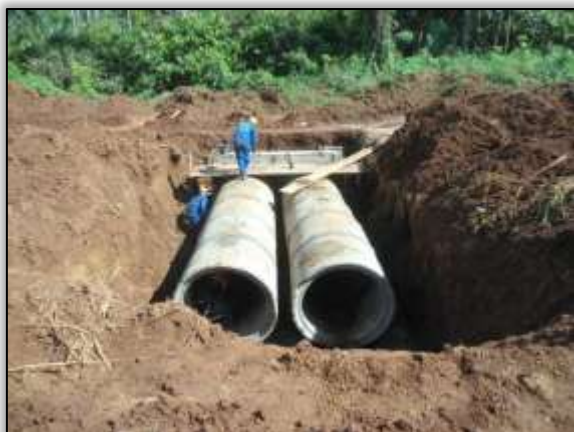
Foto 1089 – Construção de bueiro. Estaca 9568. S 03.88942° W 054.41806° 24/04/2014.
