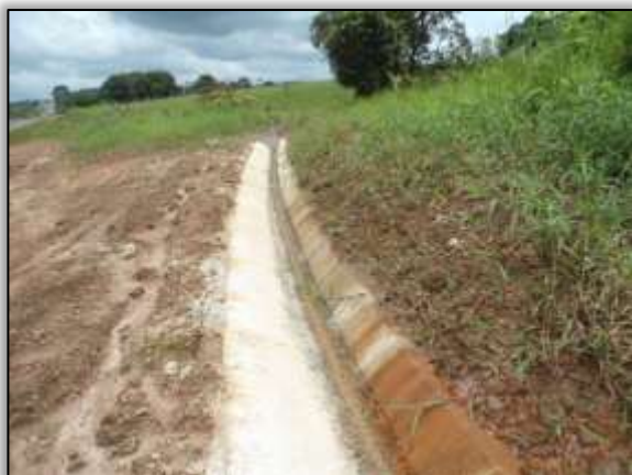
Foto 1279 – Valeta concluída e processo de germinação de gramíneas. Lado esquerdo. Estaca 2257. S 03.34337° W 052.60199° 26/02/2014.
