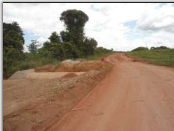
Foto 1082 – Bueiro concluído. S 03.88639° W 054.26505° 10/04/2014.
