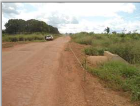
Foto 1084 – Bueiro. S 03.89041° W 054.27712° 10/04/2014.
