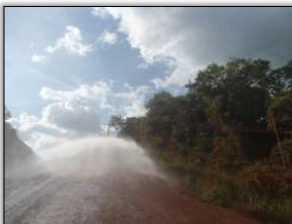
Foto 1252 – Aspersão de água com caminhão pipa. Lado direito/esquerdo. S 03.84908º W 050.51406º 29/07/2014
