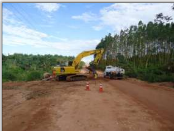
Foto 532 – Corte na rodovia para substituir bueiro triplo de concreto. Lado direito. S 05.15319° W 049.38892° 14/05/2014
