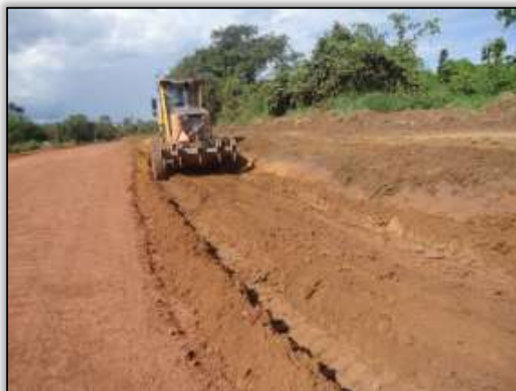
Foto 1021 – Terraplanagem e corte. Estaca 8545. S 03.87663° W 054.24520° 30/05/2014.
