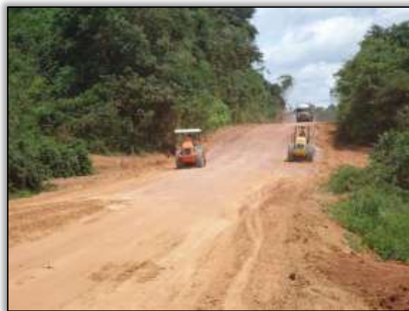
Foto 597 – Atividades de compactação. S 05.03979° W 049.45448° 13/03/2014
