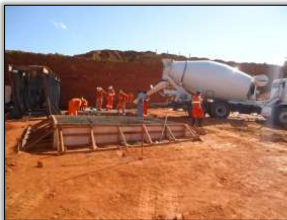
Foto 572 – Colaboradores na instalação do britador. Lado direito. S 04.90479° W 049.47627° 04/06/2014
