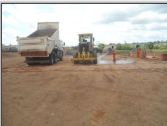
Foto 753 – Lava a jato. Lado esquerdo. Estaca 561 S 03.45172° e W 051.21874° 24/07/2014
