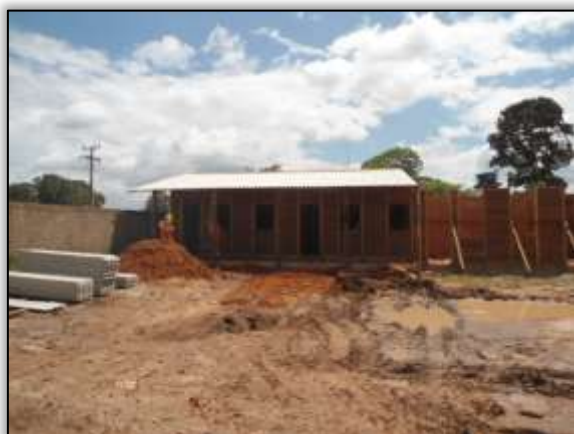
Foto 935 - Construção de alojamento. Lado direito. S 03. 87008° W 054. 22321° 14/04/2014
