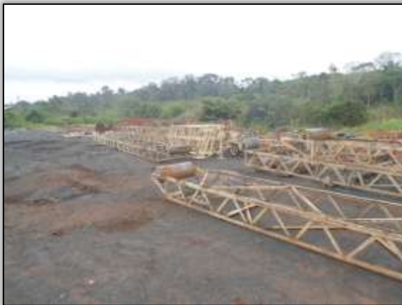
Foto 771 – Britador em desmobilização. Lado direito. Estaca 3775. S 03.44206° W 052.85213° 25/02/2014.
