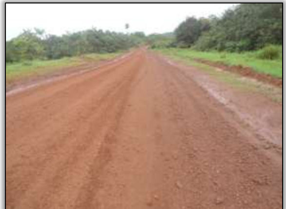
Foto 1223 – Pista reconformada. S 03. 47573° W 052. 95026° 27/06/2014
