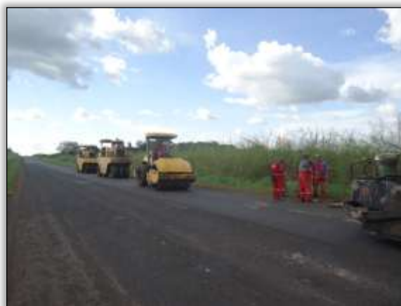
Foto 1183 – compactação asfáltica. Lado direito. S05.67216° W 048.38651° 22/04/2014
