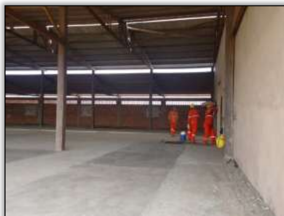
Foto 946 - Galpão na área onde está sendo construído o canteiro de obras. Lado esquerdo. S 03.87131° W 054.22242° 10/06/2014.
