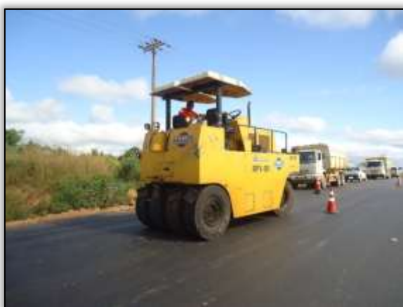
Foto 552 – Atividades de compactação asfáltica. S 05.14409° W 049.33047° 30/06/2014
