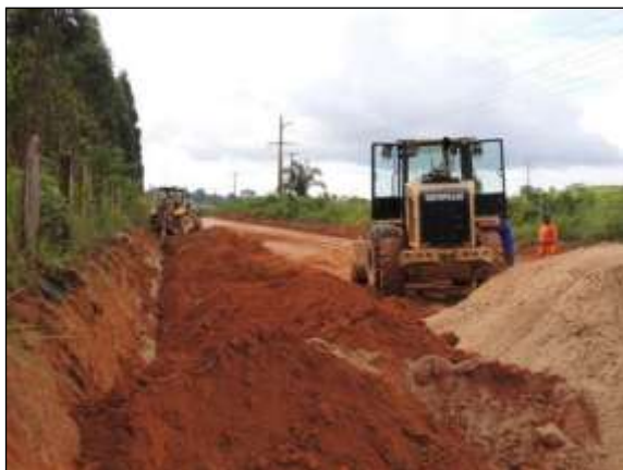
Figura 90. Abertura de vala para locação de dreno, trecho entre Itupiranga e Marabá – Lote único. Data: 10/04/2014 _ 22M 0679773 E/ 9428587 N
