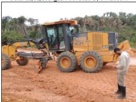
Figura 64. Acompanhamento da terraplenagem entre Itupiranga e Cajazeiras – Lote 01. Data: 14/01/2014_22M 0672739 E / 9440255 N
