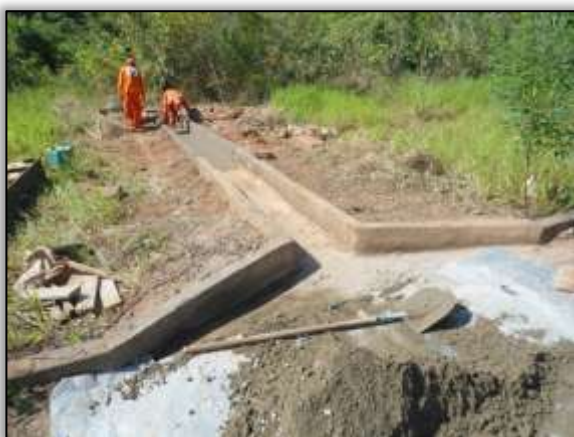
Foto 734 –Reconformação da descida d' água danificada.Lado esquerdo. S 03.10379° W 053.90953° 09/07/2014
