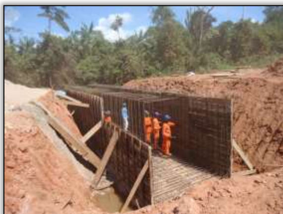
Foto 1025 - Construção de galeria. Estaca 8046. S 03.85236° W 054.15849° 24/06/2014.
