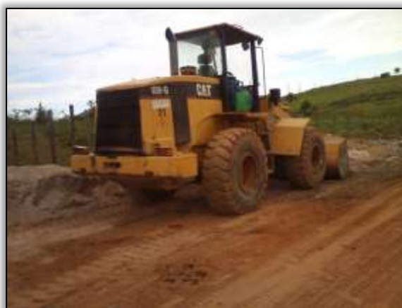
Foto 808. Exploração por proprietário da Jazida Campina. S 03.36808° W 051.55446° 16/06/2014
