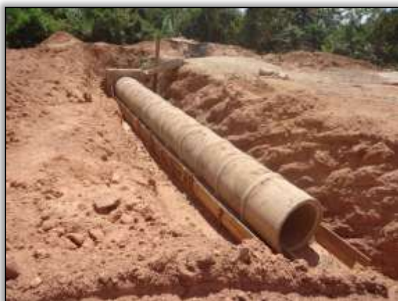
Foto 1048 - Construção de bueiro. S 03.85801° W 054.03431° 24/07/2014.
