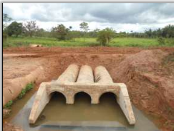
Foto 993 – Bueiro Concluído. S 03. 85093° W 054.15306°. 27/03/2014.
