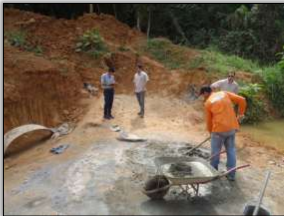
Foto 628 – Equipe de supervisão orientando técnicos da tamasa. Lado direito. S 05.04689° W 049.45644° 17/06/2014
