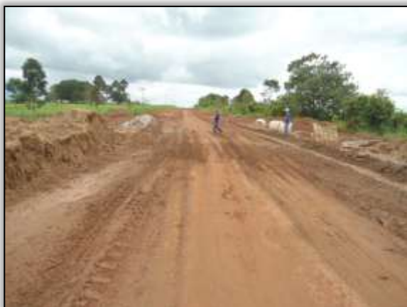
Foto 1071 - Bueiro concluído. S 03.88969° W 054.34094°. 11/02/2014.
