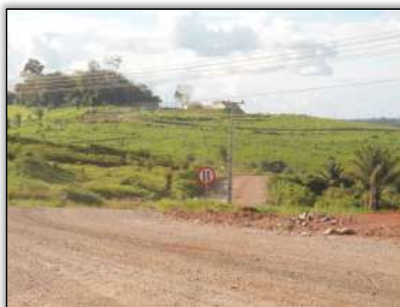
Foto 476- Rotatório para o acesso ao porto do CCBM. Lado esquerdo. Estaca 4572. S 03.12021° W 051.79644° 02/06/2014
