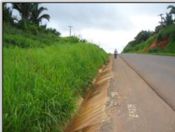
Foto 1262 – Aplicação de hidrossemeadura. Lado esquerdo. S 04.04263° W 050.24110° 18/02/2014
