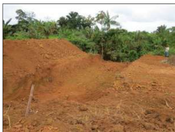
Figura 443. Obras de execução de bueiro celular entre as cidades de Placas e Rurópolis – Lote 03.
