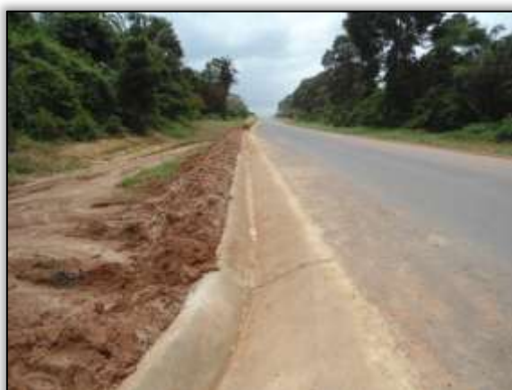
Foto 819 – Valeta concluída. Lado esquerdo. Estaca 2030. S 03.32099° W 052.56949° 18/02/2014.
