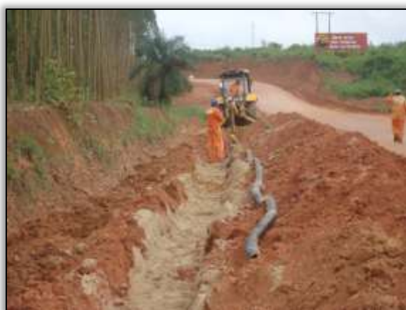
Foto 1315 – Dreno longitudinal profundo. Lado esquerdo. S 05.07308° W 048.38580° 23/04/2014
