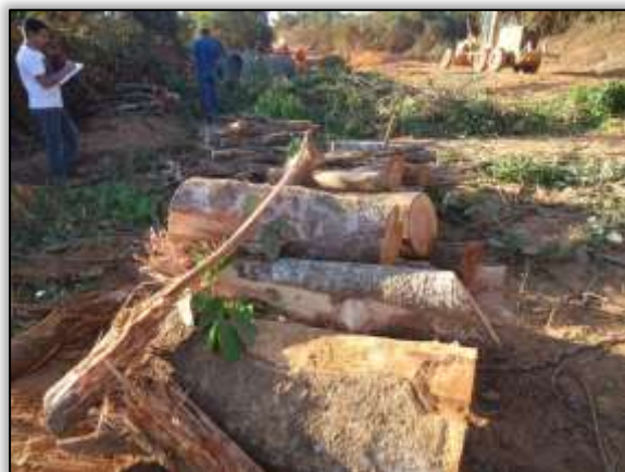
Foto 1559 - Indivíduos seccionados e enleirados. Lado direito. S 04.93693° W 049.46986° 18/07/2014.
