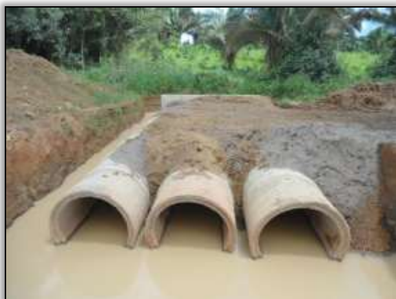
Foto 987 - Construção de bueiro. S 03.86299° W 054.10212°. 19/03/2014.
