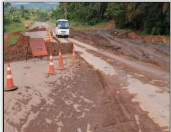
Foto 842- Nivelamento do desvio à Rodovia, Lado esquerdo e direito. Estaca 1904. S 03.31088° W 052.54976° 14/04/2014.
