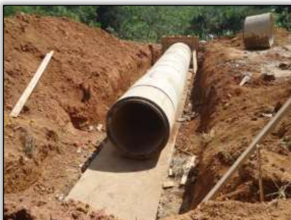
Foto 1099 – Construção de bueiro. Estaca 8949. S 03.89122° W 054.31115° 27/05/2014.
