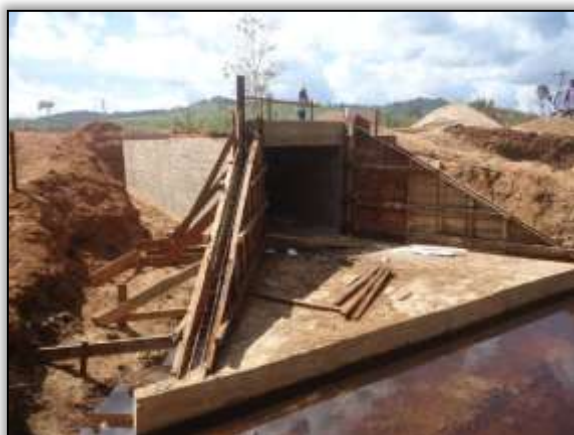
Foto 1031 - Construção de bueiro celular. S 03.85455° W 054.16874° 24/06/2014..
