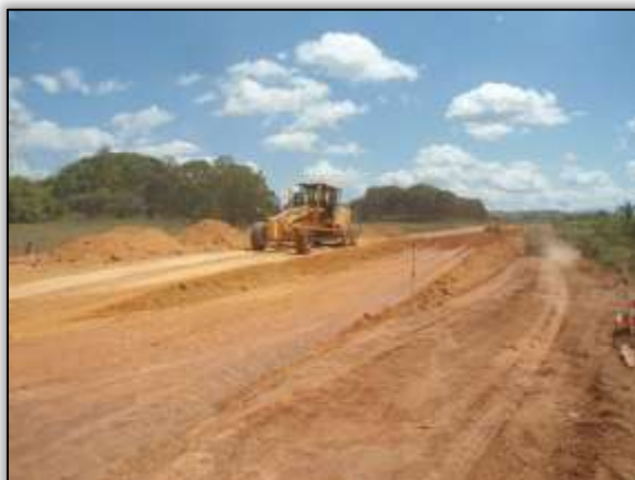
Foto 1123 – Terraplenagem. Estaca 8745. S 03.89105° W 054.27605° 15/07/2014.
