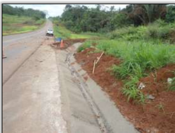
Foto 830 – Construção de sarjeta. Lado Direito. Estaca 3618. S 03.43746° W 052.82408° 25/03/2014.
