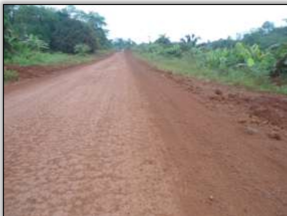
Foto 1224 – Pista reconformada. S 03. 50405° W 053. 01817° 27/06/2014
