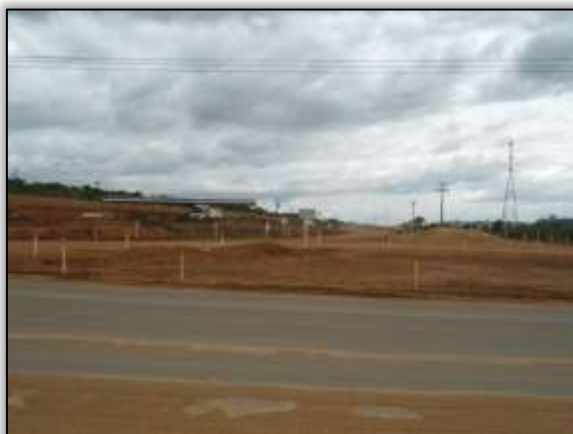
Foto 441 – Acesso ao Canteiro Bela Vista - canais e diques. Lado Esquerdo. Estaca 4258. S 03.12479° W 051.73776° 31/01/2014
