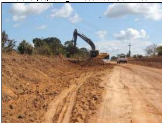
Figura 161. Acompanhamento de terraplenagem no trecho entre Placas e Rurópolis – Lote 03
