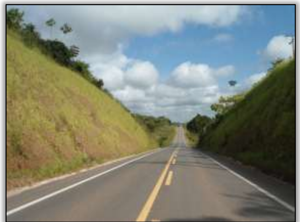
Foto 1350 – Revestimento vegetal em talude de corte. S 04.11540° W 050.05214° 02/07/2014
