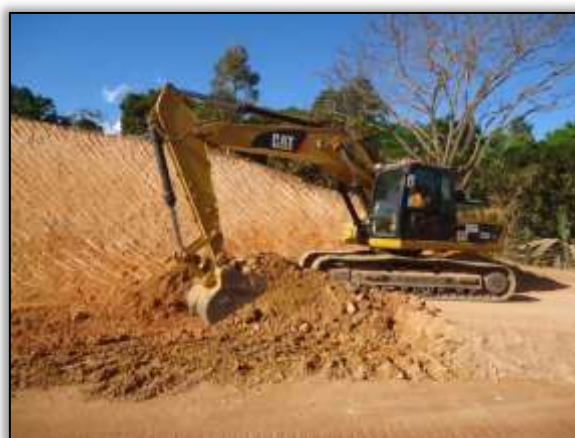
Foto 653 – Corte no corpo estradal. Lado direito. S 04.95149° W 049.46421° 16/07/2014
