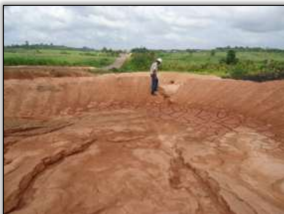
Foto 1303 – Rompimento de bacia de contenção. 12/12/2013 Lado direito. S 04.18025° W 050.03599°
