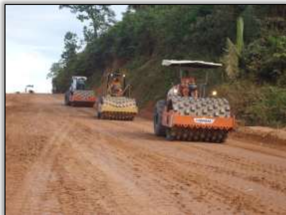
Foto 521 – Compactação de solo. Lado esquerdo. S 05.18591° W 049.36599° 14/05/2014
