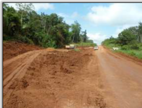
Foto 1076 - Construção de caminho de serviço. Lado esquerdo. S 03.88961° W 054.41402°. 25/02/2014.
