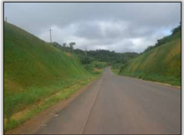
Foto 1258 – Talude com revestimento vegetal. Ambos os lados. S 03.92923° W 050.33564° 18/02/2014
