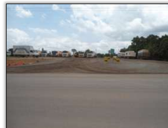
Foto 466 – Entrada para o estacionamento do CCBM. Lado direito. S 03.12371° W 051.78945° 24/04/2014
