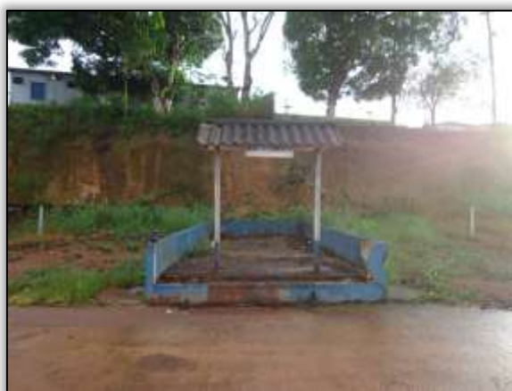
Foto 658 – Antigas instalações do tanque de combustível. S 04.23928° W 049.95531° 28/05/2014
