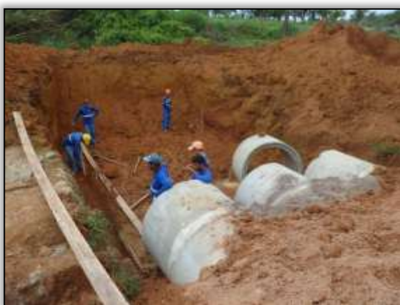
Foto 1073 - Implantação de bueiro. Estaca. 9437. S 03.88789° W 054.39499°. 11/02/2014.
