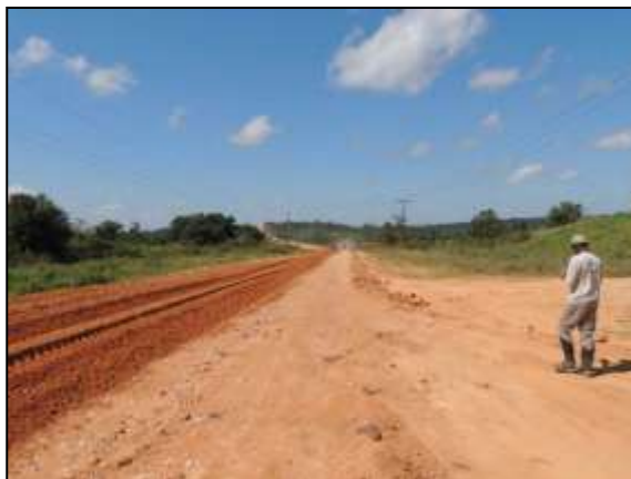
Figura 159. Acompanhamento de terraplenagem, no trecho entre Marabá e Itupiranga – Lote Único.
