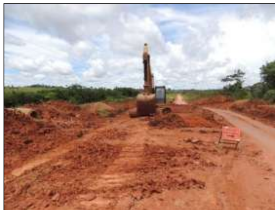
Figura 85. Aterro de bueiro, no trecho entre Uruará e Placas – Lote 02
