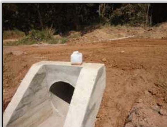
Foto 1106 – Construção de bueiro. Estaca 8951. S 03.89117° W 054.31110° 06/06/2014.
