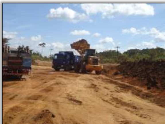
Foto 1032 – Retirada de material para terraplanagem. Estaca 8208. S 03.86011° W 054.18610° 24/06/2014.
