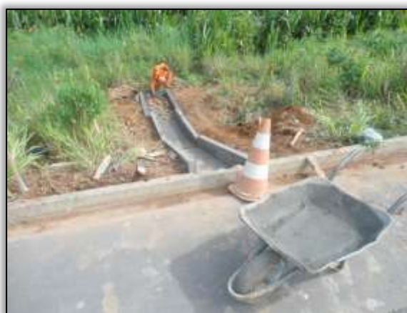
Foto 707 – Construção de descida d'água. Lado esquerdo. Estaca 5159. S 03.53063º W 051.13655º 25/06/2014
