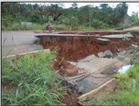
Foto 884 – Processo erosivo na saída do aterro. Lado direito. Estaca 3700. S 03.44083° W 052.83850° 02/04/2014.
