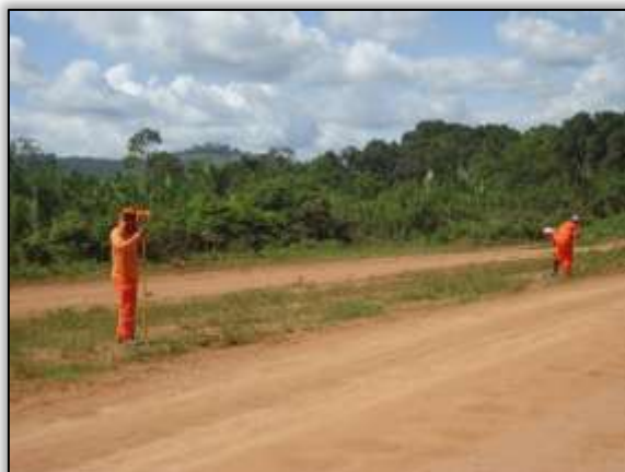
Foto 1023 – Serviços de topografia. S 03.86459° W 054.19079° 27/05/2014.
