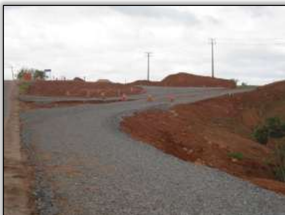
Foto 445 – Acesso ao porto do CCBM. Lado direito. Estaca 4572. S 03.12021° W 051.79644° 31/01/2014
