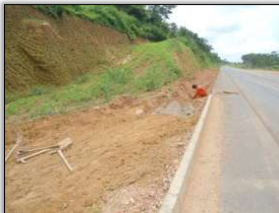
Foto 1267 – Sistema de drenagem. Lado direito. Estaca 5186. S 03.52867° W 051.14092° 25/02/2014
