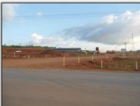
Foto 447. Acesso ao canteiro Bela Vista – Canais e Diques. Lado esquerdo. Estaca 4258. S 03.12479° W 051.73776° 26/02/2014
