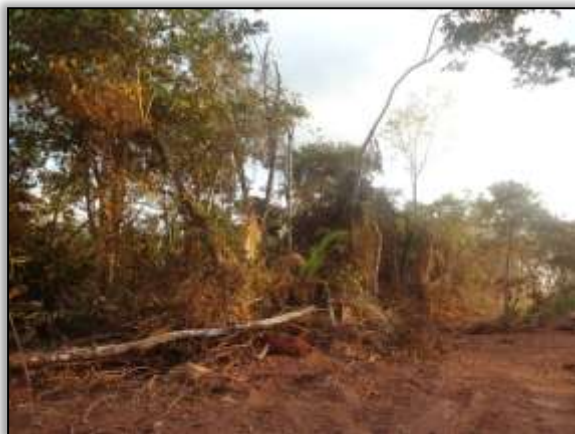
Foto 1640 - Supressão na faixa de domínio. Lado esquerdo. S 03.75057° W 053.83060° 22/07/2014.
