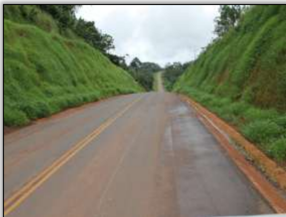
Foto 1325 – Hidrossemeadura. Lado esquerdo e direito. Estaca 2132. S 03.33265° W 052.58328° 17/04/2014.
