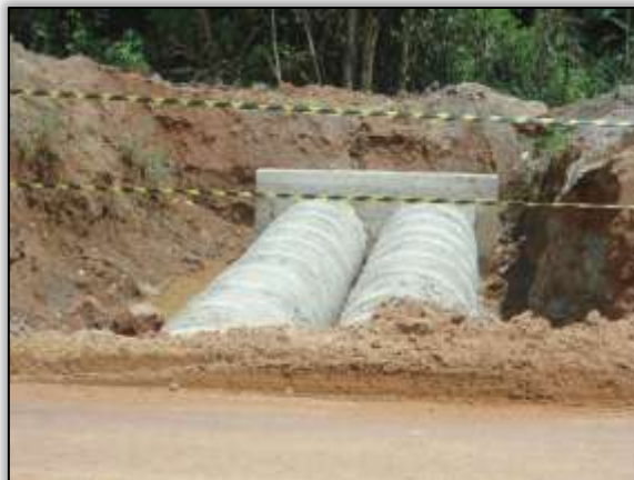
Foto 1006 - Bueiro. S 03.85557° W 054. 12645° 22/04/2014
