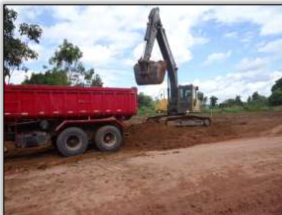
Foto 1019 – Corte de talude. Lado esquerdo. Estaca 8601. S 03.88074° W 054.25333° 27/05/2014.
