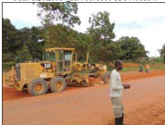
Figura 57. Acompanhamento da terraplenagem no trecho entre Marabá e Itupiranga – Lote Único. Data: 11/01/2014_22M 0681630 E / 9425577 N
