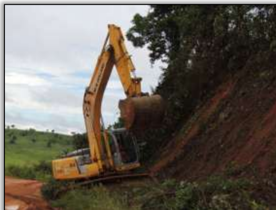
Foto 1370 – Limpeza em talude. Lado esquerdo. S 05.18701° W 049.36444° 02/05/2014
