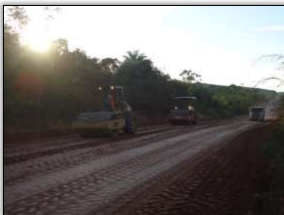
Foto 522 – Compactação de solo. Lado esquerdo. S 05.18591° W 049.36599° 14/05/2014
