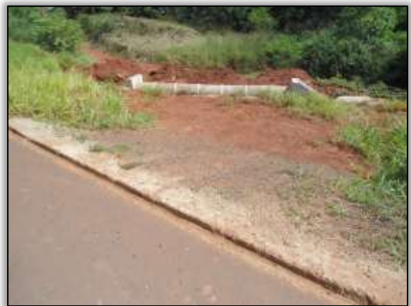
Foto 851– Reconstrução de descida d'água. Lado esquerdo. Estaca 1930. S 03.40962° W 052.77176° 02/06/14
