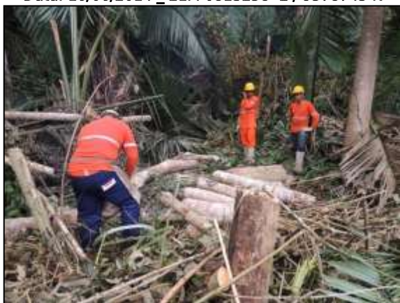
Figura 168. Enleiramento de material vegetal suprimido na via de acesso à pedreira – Lote 02. Data: 16/06/2014 _ 21M 0813640 E / 9579030 N
