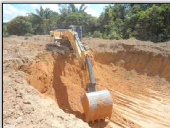
Foto 1051 - Corte em talude. Lado direito. Estaca 8578. S 03.87887° W 054.25011° 17/07/2014.
