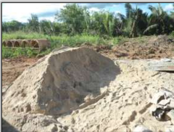
Foto 953 - Areia utilizada na obra. S 03.85568° W 054.12645° 19/02/2014.
