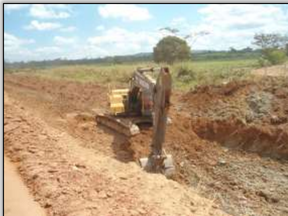
Foto 1125 – Corte na pista. Lado Direito. Estaca 8788. S 03.88898° W 054.28270° 15/07/2014.
