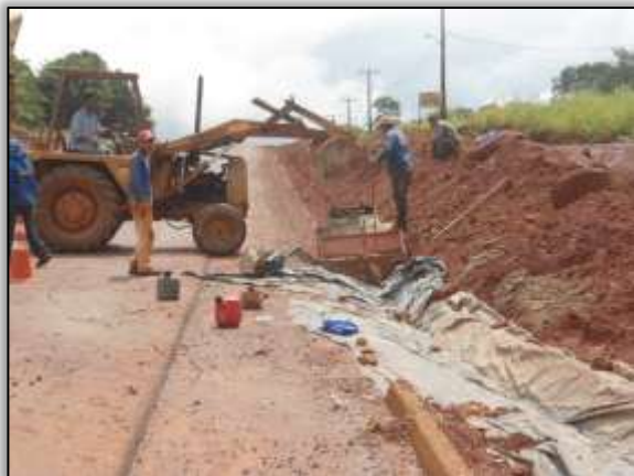
Foto 1285 – Construção de valeta. Lado direito. Estaca 3480. S 03.42417° W 052.78316° 26/02/2014.
