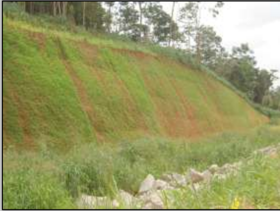
Foto 1270 – Hidrossemeadura no talude. Lado esquerdo. Estaca 5040. S 03.54315° W051. 12033° 25/02/2014
