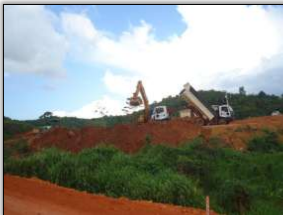
Foto 646 – Atividade de corte em talude. Lado esquerdo. S 04.99999° W 049.41693° 13/06/2014
