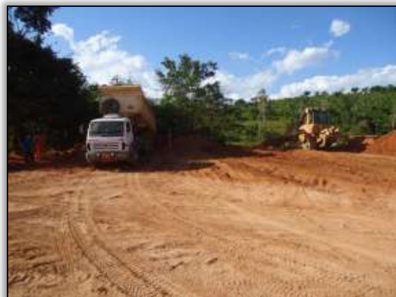
Foto 657 – Atividade de aterro. Lado direito. S 04.95068° W 049.46461° 16/07/2014
