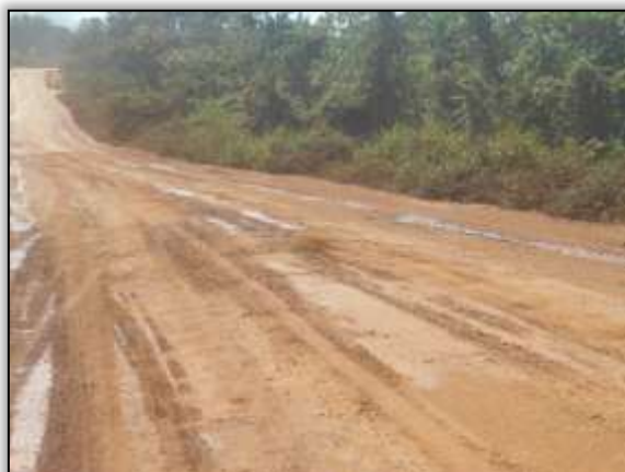
Foto 1231 - Conservação da pista. S 03.70932° W 053.70361° 17/07/2014.
