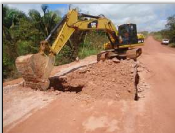
Foto 1217 – Trecho em conservação. Lado direito. S 04.21486° W 049.91790° 29/04/2014
