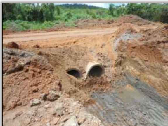
Foto 991 - Bueiro em construção. S 03.85566° W 054.12616°. 19/03/2014.
