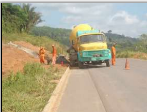
Foto 708 – Construção de valeta. Lado direito. S 03.55616º W 051.10273º 30/07/2014
