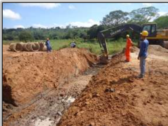
Foto 1107 – Construção de bueiro. E 9868. S 03.89333° W 054.47083° 24/06/2014.
