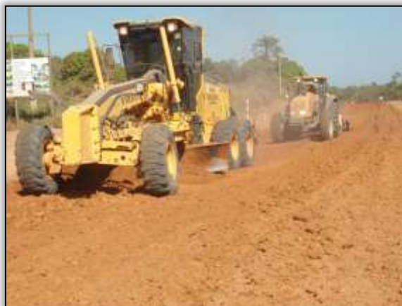
Foto 1045 - Terraplenagem. Estaca 8520. S 03.87557° W 054.24002° 15/07/2014.
