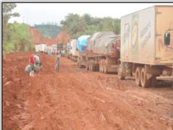
Foto 721 – (Antes) Ponto de atoleiro na via. Estaca 4348. S 03.61337° W 051.02332° 12/03/2014
