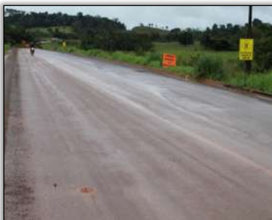
Foto 847 – Reforço sinalização em ponte. Lado Direito. S 03.38794° W 052. 69039° 17/04/2014.
