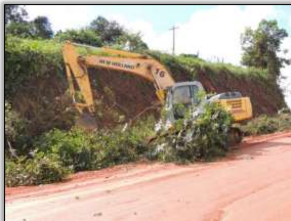
Foto 1374 – Limpeza em talude. Lado esquerdo. S 05.18701° W 049.36444° 02/05/2014
