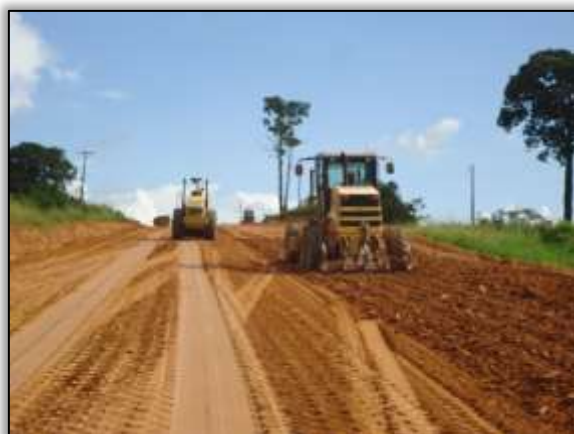
Foto 603 – Gradeamento no solo. Lado esquerdo. S 05.01727° W 049.45705° 06/05/2014
