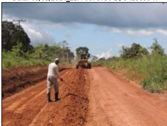
Figura 132. Manutenção da pista, trecho próximo à Rurópolis - Lote 03. Data: 13/05/2014_21M 0803255 E / 9569629 N
