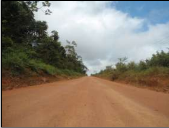
Foto 1177 – Pista reconformada. S 03.55522° W 053.19004° 19/03/2014.
