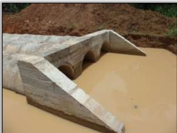
Foto 975 - Implantação de bueiro. Estaca 7715. S 03.86298° W 054.10204°. 19/02/2013
