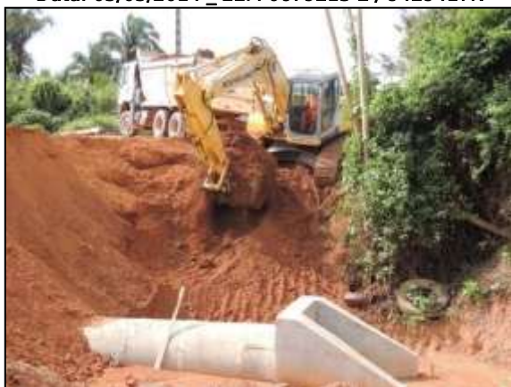
Figura 124. Limpeza da saída do bueiro, trecho entre Marabá e Itupiranga – Lote único. Data: 06/05/2014 _ 22M 0680177 E / 9427962 N
