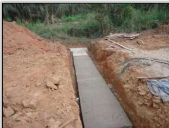
Foto 1016 – Construção de bueiro. Estaca 7391. S 03.85775° W 054.03535° 27/05/2014.
