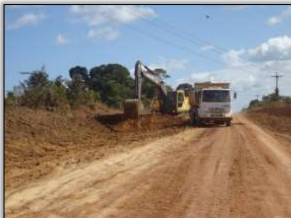
Foto 1026 - Corte em talude. Lado esquerdo Estaca 8620. S 03.88208° W 054.25644° 10/06/2014.
