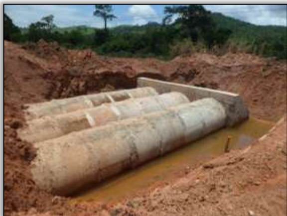
Foto 979 - Implantação de bueiro. S 03.85092° W 054.15307°. 25/02/2014.
