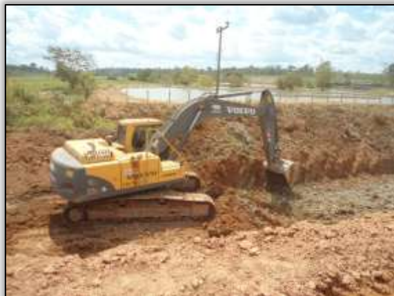
Foto 1126 – Corte na pista. Lado Direito. Estaca 8788. S 03.88898° W 054.28270° 15/07/2014.
