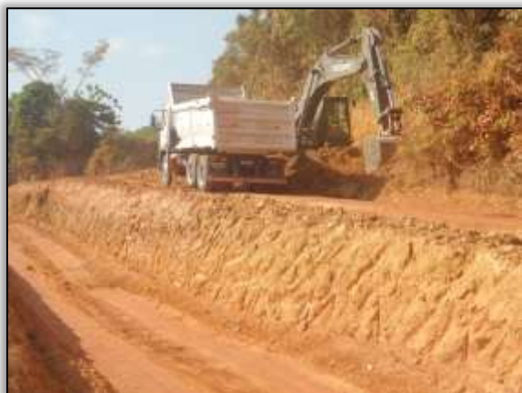
Foto 716 – Conformação do off set da rodovia. Lado esquerdo. S 03.66617° W 050.95354° 30/07/2014
