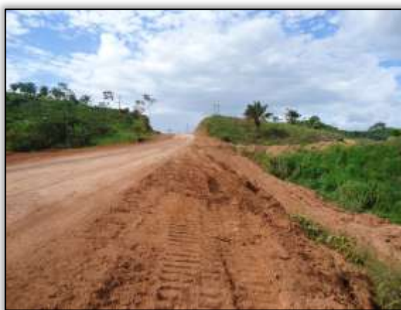
Foto 1383 – Limpeza no bordo da pista. Lado direito. S 05.00772° W 049.45090° 06/05/2014
