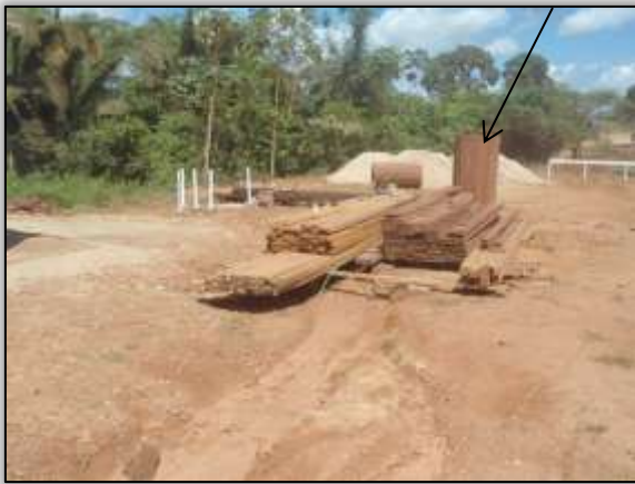
Foto 908 - Formas para base dos pilares. Lado esquerdo. S 03.31975° W 052.56762° 02/06/2014
