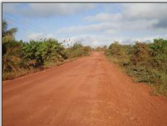
Foto 1240 – Rodovia em ótimas condições de trafegabilidade. Ambos os Lados. 04.00675° W 049.77441 24/07/2014
