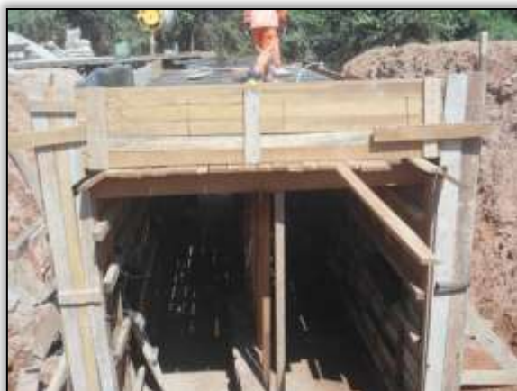
Foto 1047 - Construção de bueiro. S 03.85233° W 054.15846° 16/07/2014.
