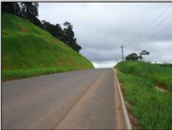
Foto 1259 – Talude após o revestimento vegetal. Ambos os lados. S 04.05621° W 050.24565° 18/02/2014
