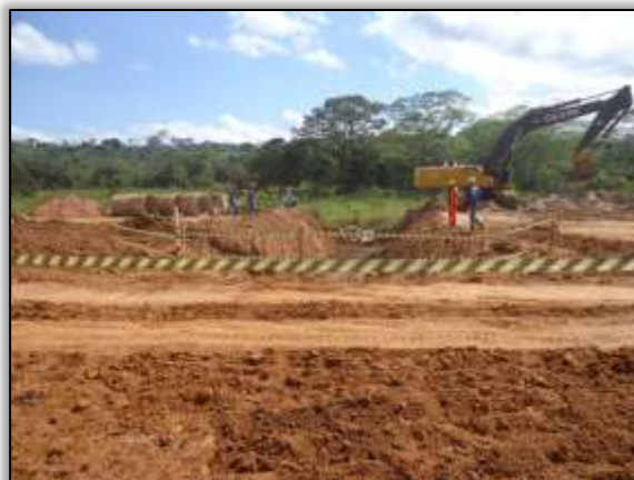
Foto 1108 – Sinalização e construção de bueiro. E 9868. S 03.89333° W 054.47083° 24/06/2014.
