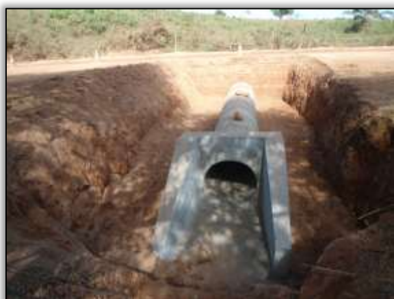
Foto 634 – Bueiro simples tubular de concreto. Lado direito. S 04.95267° W 049.46346° 08/07/2014
