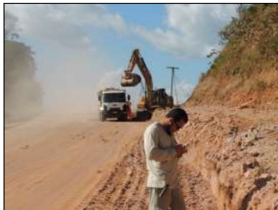
Figura 153. Acompanhamento de rebaixamento de pista e terraplenagem – Lote 01. Data: 03/06/2014 _22M 0671855 E / 9446384 N
