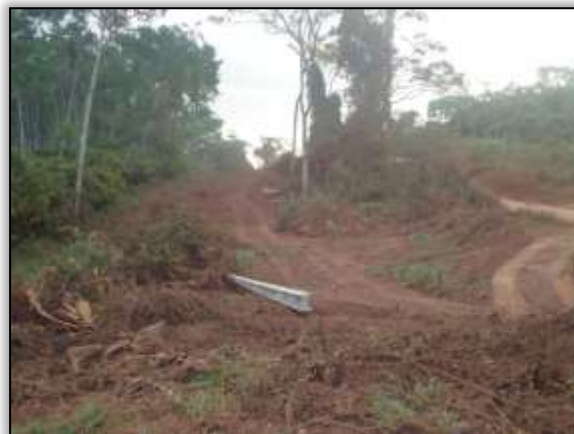
Foto 1641 - Supressão na faixa de domínio. Lado esquerdo. S 03.75057° W 053.83060° 22/07/2014.
