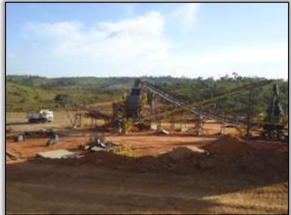
Foto 587 – Instalação do britador. Lado direito. S 04.90479° W 049.47627° 16/07/2014
