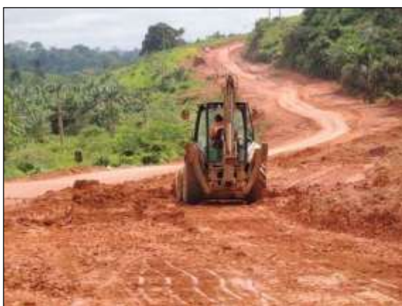
Figura 112. Manutenção do traçado, trecho entre Itupiranga e Cajazeiras – Lote 01. Data: 23/04/2014 _ 22M 0670687 E / 9443636 N
