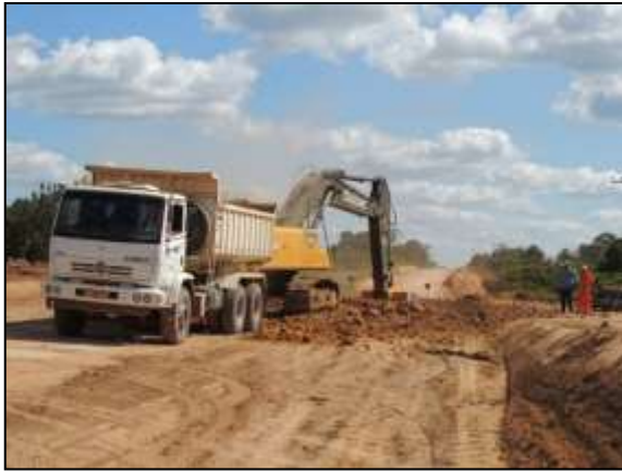
Figura 170. Acompanhamento de rebaixamento de pista, entre Placas e Rurópolis – Lote 03. Data: 23/06/2014 _ 21M 0804994 E / 9570516 N
