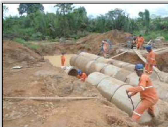
Foto 1003 – Construção de bueiro. S 03. 86296° W 054. 10209° 15/04/2014
