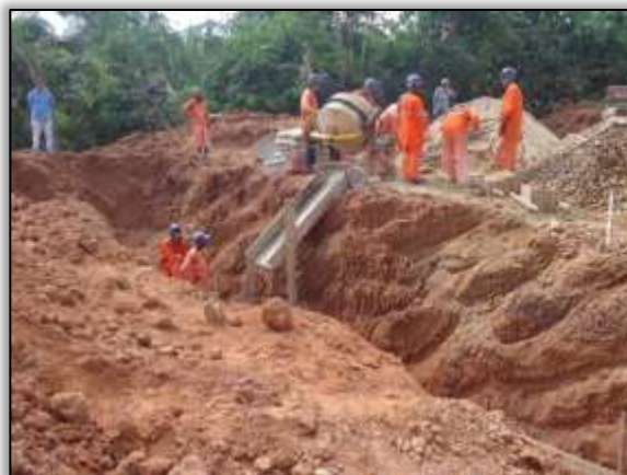
Foto 1017 – Implantação de bueiro. Estaca 7333. S 03.85777° W 054.03400° 27/05/2014.
