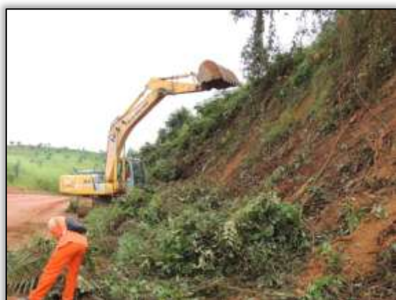
Foto 1371 – Limpeza em talude. Lado esquerdo. S 05.18701° W 049.36444° 02/05/2014
