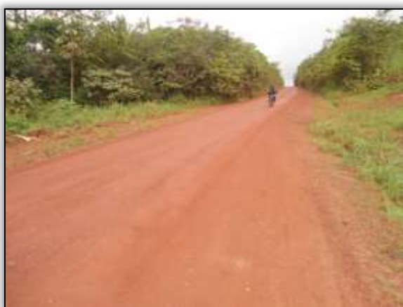
Foto 1173 – Declive em boas condições de trafegabilidade. S 03.50136° W 053.04350° 19/03/2014.
