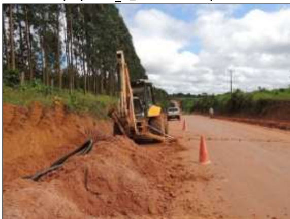
Figura 100. Colocação de dreno, entre Marabá e Itupiranga – Lote único. Data: 15/04/2014 _ 22M 0679625 E / 9428799 N
