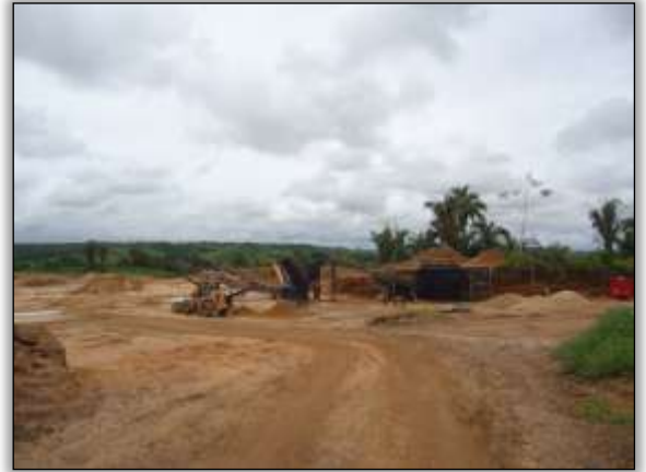
Foto 506 – Instalação da britagem. Lado esquerdo. S 05.21944° W 049.34484° 24/02/2014
