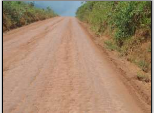
Foto 1192 – Pista em boas condições de tráfego. S 03.68645° W 053.58185° 15/04/2014.
