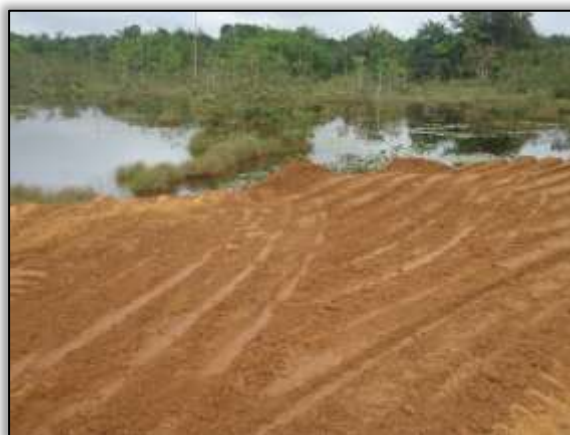
Foto 1112 – Implantação de caminho de serviço. Lado esquerdo. Estaca 9201. S 03.88532° W 054.35342° 26/06/2014.
