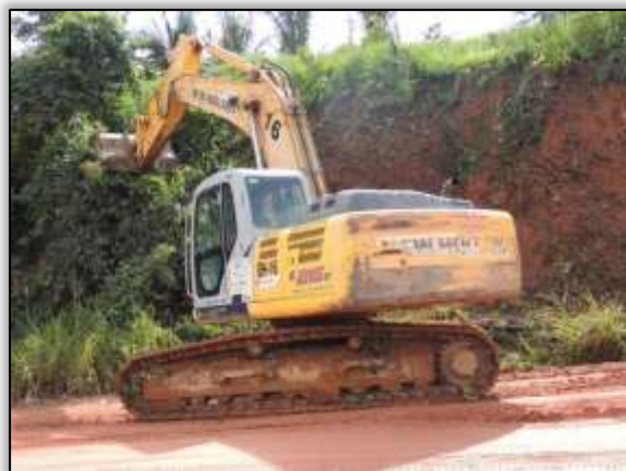
Foto 1373 – Limpeza em talude. Lado esquerdo. S 05.18701° W 049.36444° 02/05/2014
