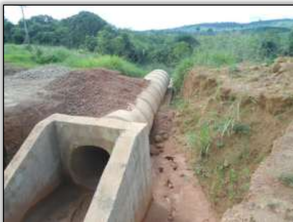
Foto 1085 – Construção de bueiro. S 03.89108° W 054.31106° 14/04/2014.
