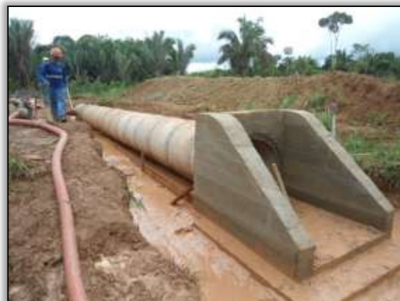
Foto 1072 - Implantação de bueiro. S03. 88411° W 054.36081°. 11/02/2014.
