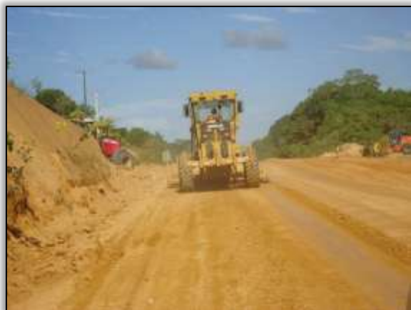
Foto 610 – Atividade de terraplanagem. Lado direito. S 05.05482° W 049.45007° 16/07/2014
