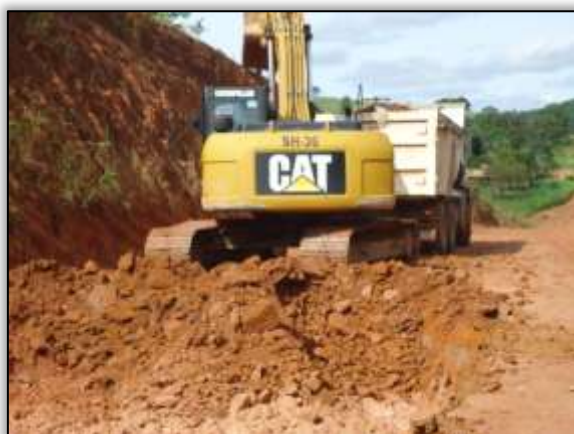
Foto 642 – Atividade de corte na rodovia. Lado esquerdo. S 05.18313° W 049.36771° 15/05/2014
