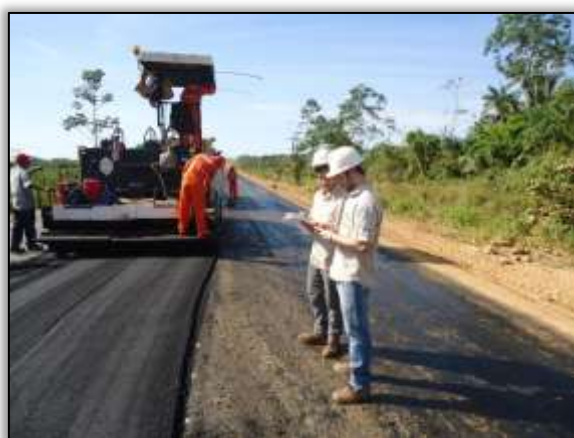
Foto 547 – Atividade de pavimentação. Lado direito. S 05.26075° W 049.32211° 16/06/2014
