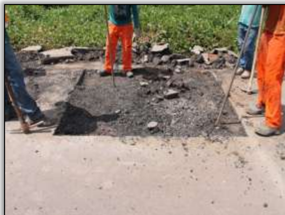
Foto 732– Recuperação Pista de Rolamento. Lado Direito. S 03.35637° W 051.34161° 24/04/2014.
