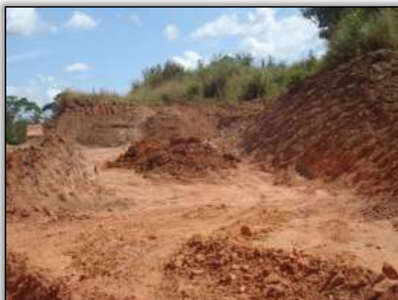
Foto 1028 – Corte em talude. S 03.85258° W 054.15938° 24/06/2014.
