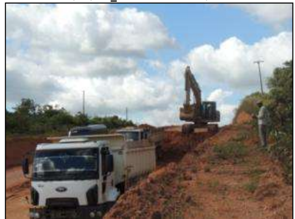
Figura 53. Acompanhamento de empréstimo de material entre Itupiranga e Cajazeiras – Lote 01. Data: 10/01/2014 _ 22M 0673309 E / 9439628 N
