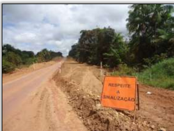
Foto 1097 - Terraplanagem. Estaca 9201. S 03.8858° W 054.35342° 27/05/2014.
