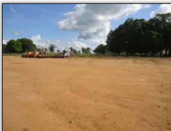
Foto 499 – Visão ampla do canteiro. S 05.14419° W 049.35743° 30/06/2014
