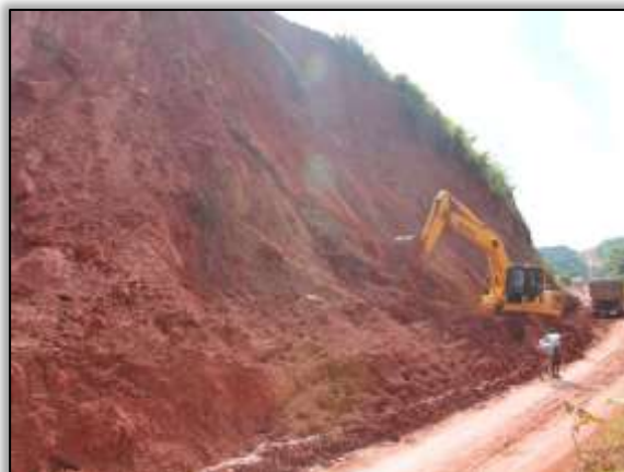
Foto 1187 – CCM realizando a reconformação do talude de corte. S 03.84560° W 050.52524° 29/04/2014
