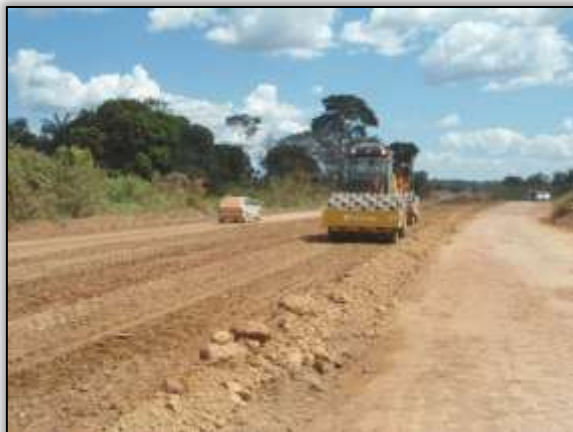
Foto 1119 – Terraplenagem. Estaca 8663. S 03.88571° W 054.26364° 07/07/2014.
