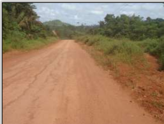
Foto 1211 – Pista em bom estado de conservação. S 03.60304° W 053.25905° 14/05/2014..
