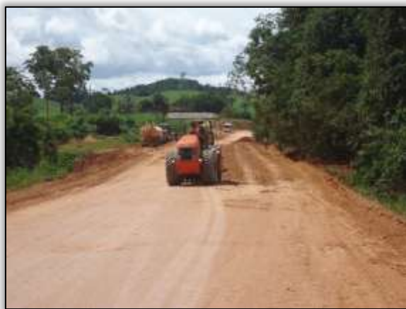
Foto 596 – Atividades de compactação. S 05.03979° W 049.45448° 13/03/2014
