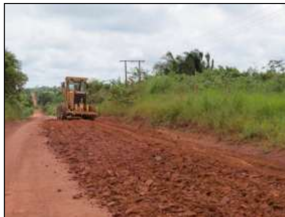
Figura 79. Obras de terraplenagem na BR-422/PA entre Novo Repartimento e Tucuruí.
