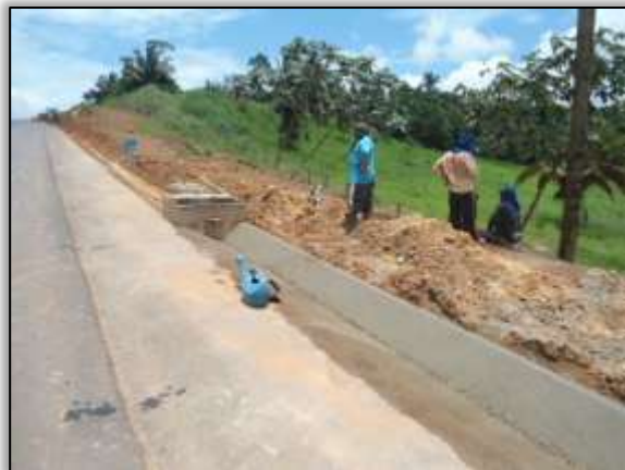
Foto 1286 – Construção de valeta. Lado esquerdo. Estaca 2540. S 03.36740° W 052.64540° 26/02/2014.
