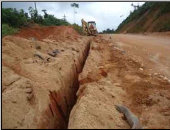
Foto 1253 – Alocação de dreno longitudinal. Lado esquerdo. S 05.06100° W 049.44297° 19/02/2014
