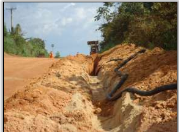
Foto 1256 – Alocação de dreno longitudinal. Lado esquerdo. S 05.18368° W 049.36735° 19/02/2014
