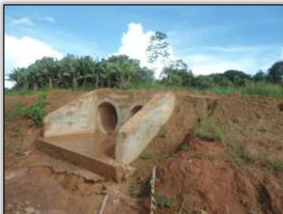
Foto 1000 - Bueiro concluído. S 03.87593° W 054.24353°. 27/03/2014.
