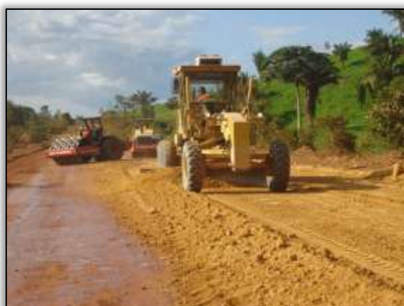
Foto 607 – Atividade de Terraplenagem. Lado esquerdo. S 04.98547°W 049.44616° 30/06/2014
