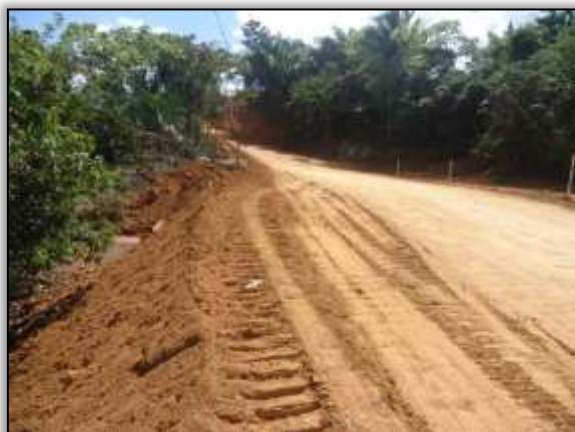
Foto 1232 - Bueiro construído na vicinal 235 norte. S 03.81395° W 054.18826° 09/07/2014.
