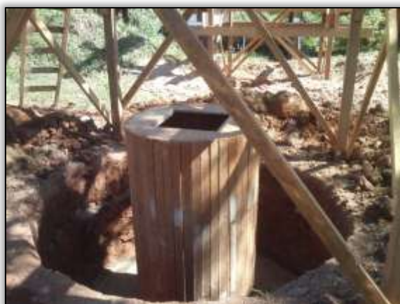
Foto 915 – Forma para base de pilares. Lado esquerdo. S 03.31975° W 052.56762° 13/06/2014.
