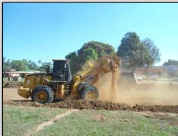
Foto 1043 - Terraplenagem. Estaca 8594. S 03.86898° W 054.21849° 15/07/2014.
