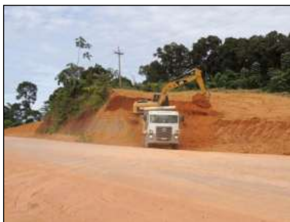
Figura 119. Empréstimo de material, trecho entre Itupiranga e Cajazeiras – Lote 01.
