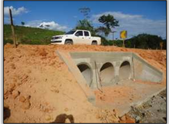
Foto 627 – Instalação de galeria de bueiro triplo. Lado esquerdo. S 04.97325°W 049.44329° 18/06/2014
