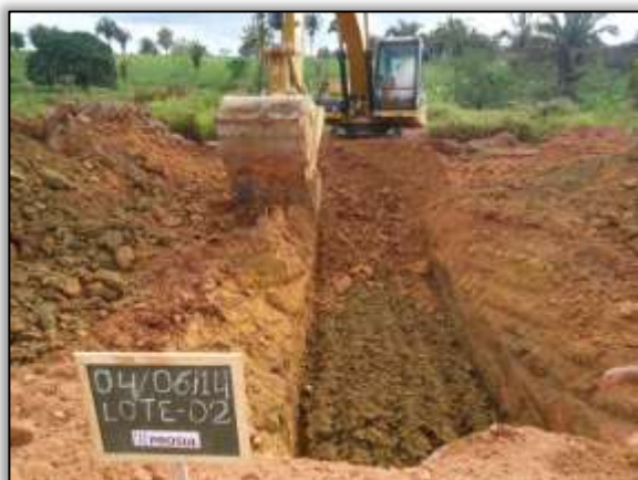
Foto 620 – Início de instalação de bueiro. Lado direito. S 04.98435° W 049.44617° W 049.44617° 04/06/2014
