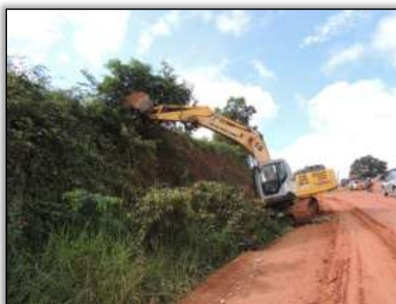
Foto 1372 – Limpeza em talude. Lado esquerdo. S 05.18701° W 049.36444° 02/05/2014
