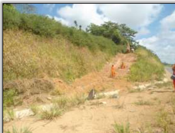
Foto 709 – Construção de valeta. Lado esquerdo. Estaca 4966. S 03.55299º W 051.11059º 30/07/2014
