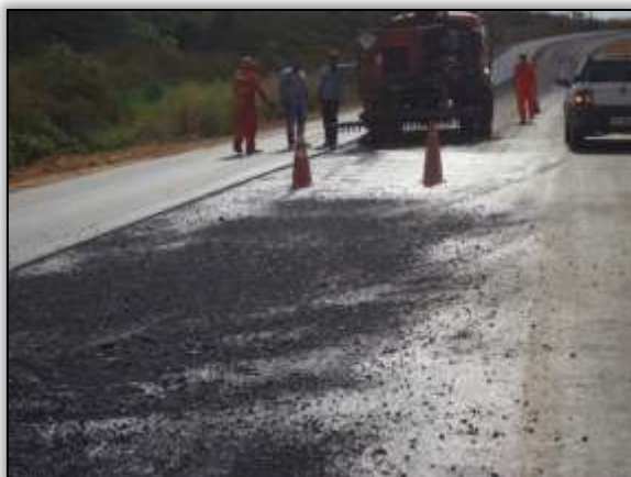
Foto 544 – Aplicação de emulsão asfáltica. Lado esquerdo. S 05.26000° W 049.23213° 18/06/2014
