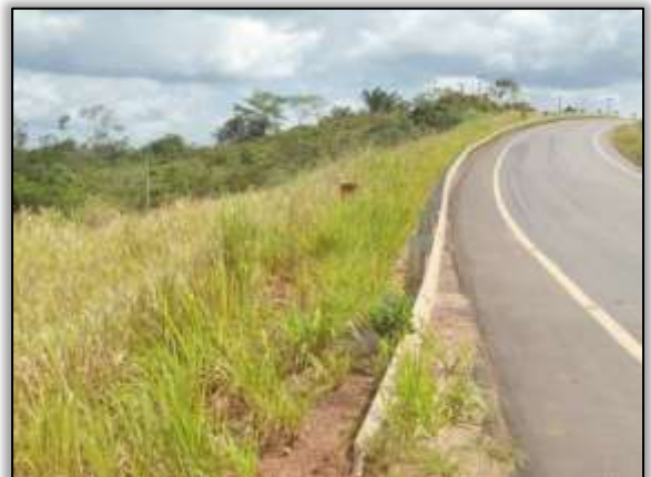
Foto 1354 – (Depois) Pista de rolamento reconformada e plantio com hidrossemeadura na saia de aterro. 05/06/2014
