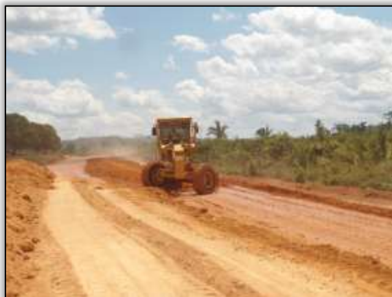
Foto 1124 – Terraplenagem. Estaca 8745. S 03.89105° W 054.27605° 15/07/2014.
