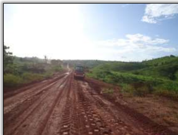
Foto 1185 – Compactação do solo. Lado direito. S 04.79850° W 049.57257° 23/04/2014
