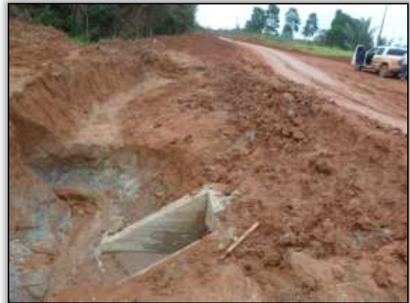
Foto 972 - Implantação de bueiro. Estaca 7680. S 03.86257° W 054.09534°. 19/02/2014
