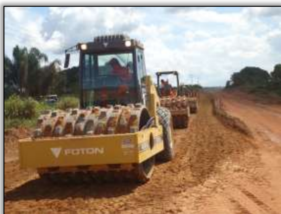
Foto 1115 – Terraplanagem. Estaca 9123. S 03.88984° W 054.34034° 26/06/2014.
