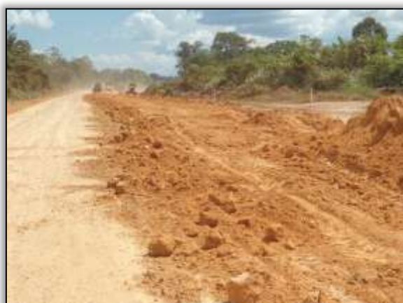
Foto 1038 - Terraplenagem. Estaca 8507. S 03.87477° W 054.23750° 07/07/2014.
