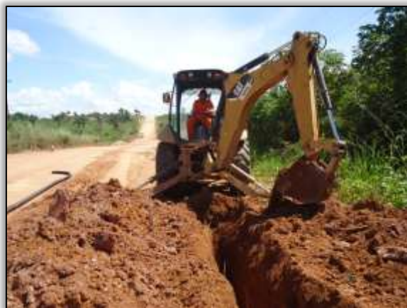
Foto 1313 – Abertura de corte dreno profundo longo. Lado direito. S 05.22470° W 049.34056° 30/04/2014
