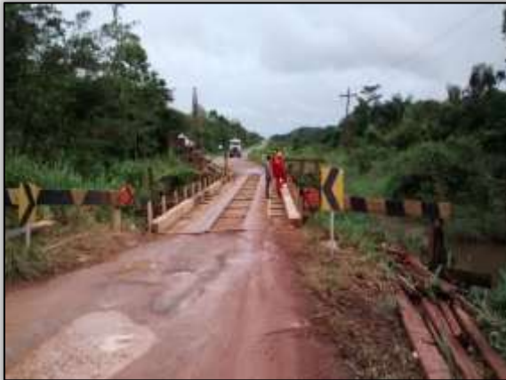
Foto 725– Reforma de ponte. Lado Direito e esquerdo. S 03.36171° W 051.33531° 17/04/2014.
