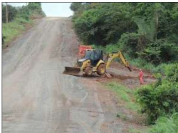
Figura 72. Abertura de vala para locação de dreno na rodovia entre Araguatins e Palestina.
