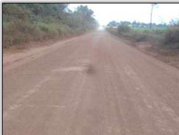
Foto 1247 - Pista reconformada. S 03.60824° W 053.28580° 10/07/2014.
