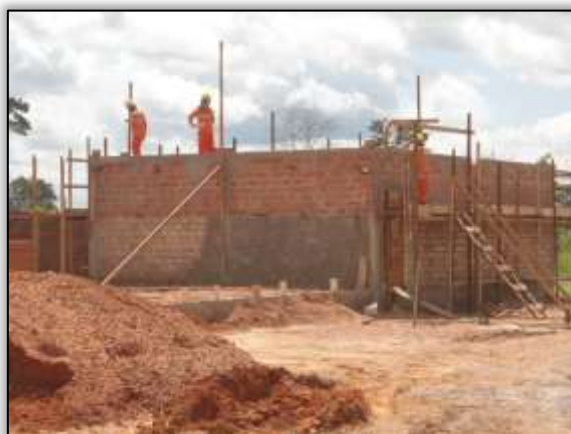
Foto 936 - Construção de alojamento. Lado direito. S 03. 87008° W 054. 22321° 14/04/2014
