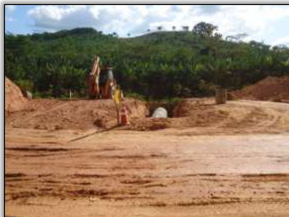
Foto 638 – Instalação de bueiro simples tubular de concreto. Lado esquerdo. S 05.02727° W 049.45987° 21/07/2014
