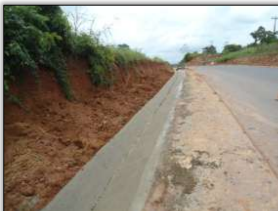
Foto 821 – Construção de valeta. Lado esquerdo. S 03.31800° W 052.56408° 18/02/2014.
