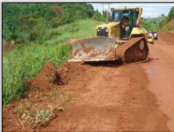
Foto 1377 – Limpeza no bordo da pista. Lado esquerdo. S 05.00772° W 049.45065° 06/05/2014
