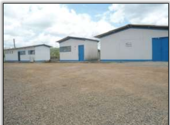
Foto 754 – Instalações pintadas. Lado esquerdo. Estaca 561 S 03.45172° e W 051.21874° 30/07/2014
