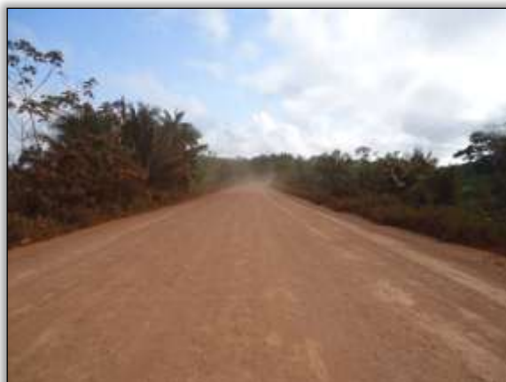
Foto 1241 – Rodovia em ótimas condições de trafegabilidade. Ambos os Lados. 04.09986° W 049.85526 24/07/2014
