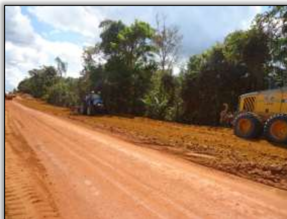
Foto 1118 – terraplanagem. Estaca 9201. S 03.88532° W 054.35343° 26/06/2014.
