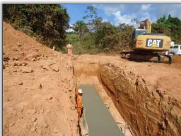
Foto 640 – Instalação de bueiro simples tubular de concreto. Lado direito. S 04.93702° W 049.46974° 29/07/2014
