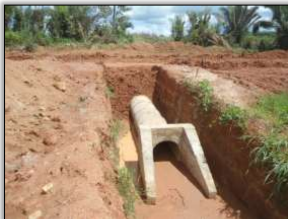
Foto 982 - Bueiro concluído. S 03.86257° W 054.09540°. 13/03/2014.
