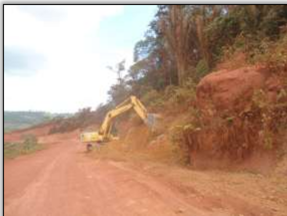
Foto 1250 – Conformação de talude. Lado esquerdo. S 03.84908º W 050.51406º 29/07/2014
