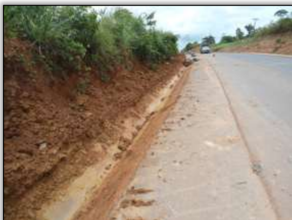
Foto 820 - Construção de valeta. Lado esquerdo. S 03.31800° W 052.56408° 18/02/2014.
