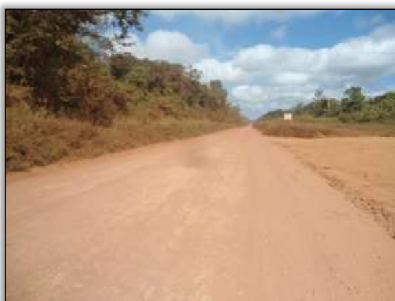
Foto 1248 – Pista reconformada. S 03.61693° W 053.33403° 17/07/2014.
