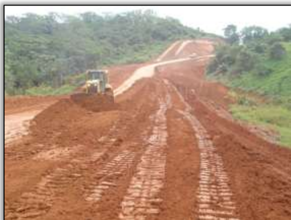
Foto 711 – Terraplenagem. Lado direito. Estaca 3667. S 03.69149º W 050.92935º 25/06/2014
