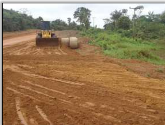
Foto 1111 – Implantação de caminho de serviço. Lado esquerdo. Estaca 9201. S 03.88532° W 054.35342° 26/06/2014.
