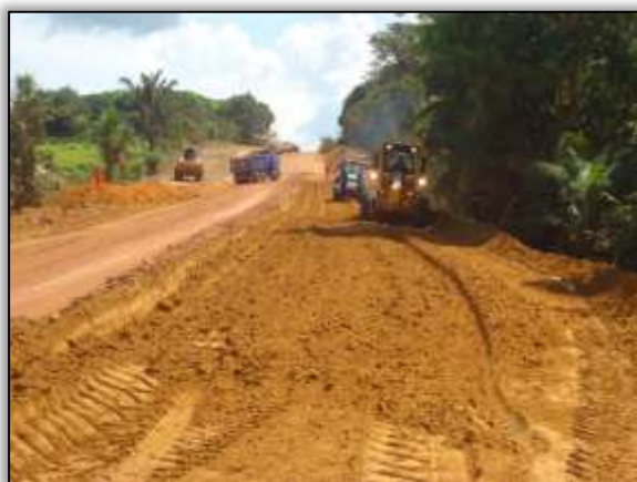
Foto 1117 – terraplanagem. Estaca 9201. S 03.88532° W 054.35343° 26/06/2014.
