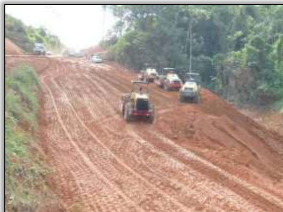
Foto 714 – Compactação do aterro. Lado direito. Estaca 3675. S 03.69122° W 050.93105° 18/06/2014
