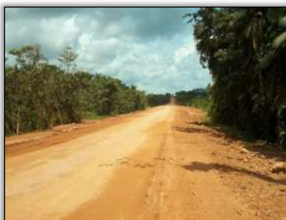
Foto 144 – O DNIT, a construtora TORC normalizaram e liberaram o trecho do Lote 3 entre Pacajá e Anapú. 02/04/2014
