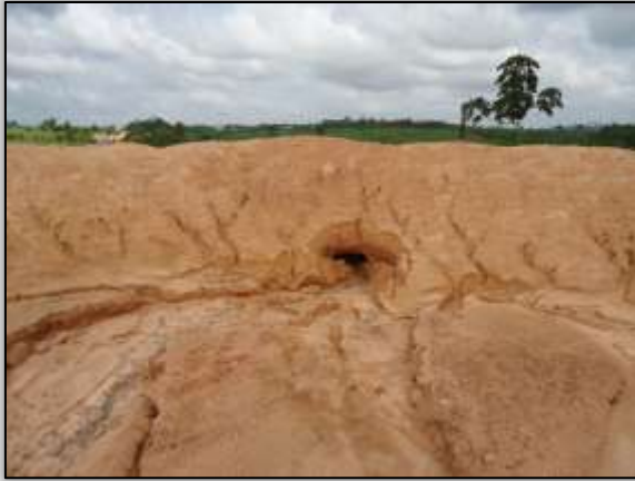
Foto 1305 – Rompimento de bacia de contenção. 12/12/2013 Lado direito. S 04.18025° W 050.03599°
