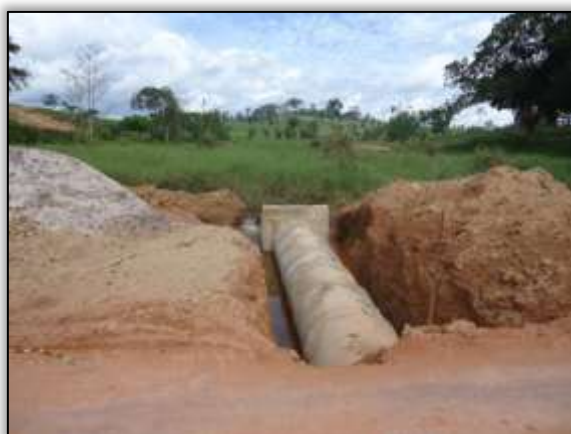
Foto 1010 – Construção de bueiro. S 03.85927° W 054.06721° 14/05/2014
