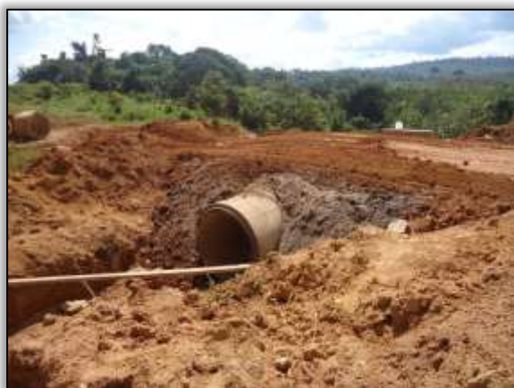
Foto 1105 – Construção de bueiro. Estaca 8951. S 03.89117° W 054.31110° 06/06/2014.
