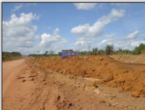
Foto 1035 - Terraplanagem. Estaca 8242. S 03.86141° W 054.19191° 24/06/2014.
