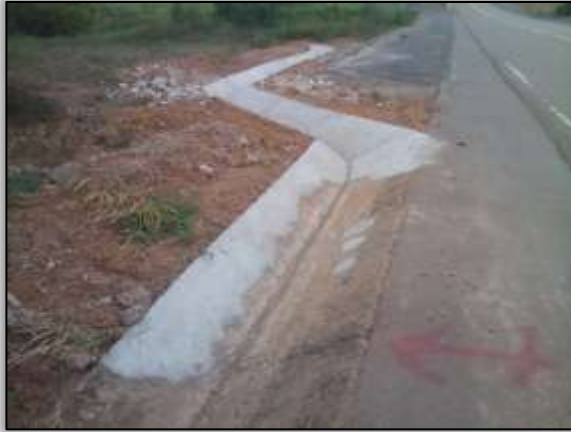
Foto 736 –Reconformação de sarjeta.Lado esquerdo. S 03.15009° W 053.97679° 30/07/2014
