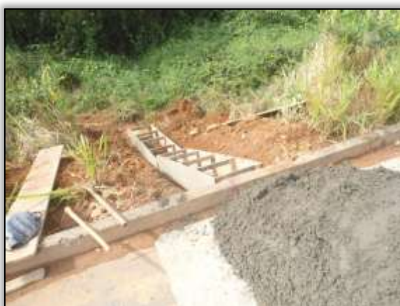
Foto 706 – Construção de descida d'água. Lado direito. Estaca 5159. S 03.53063º W 051.13655º 25/06/2014
