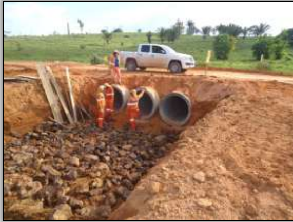
Foto 626 – Instalação de bueiro triplo tubular de concreto. Lado direito. S 04.97325°W 049.44329° 18/06/2014
