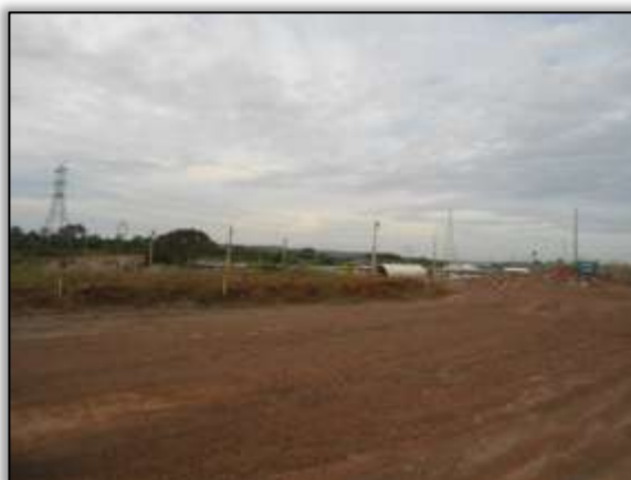
Foto 488 – Final do desvio da rodovia. Lado direito. S 03.12383° W 051.78881° 30/07/2014
