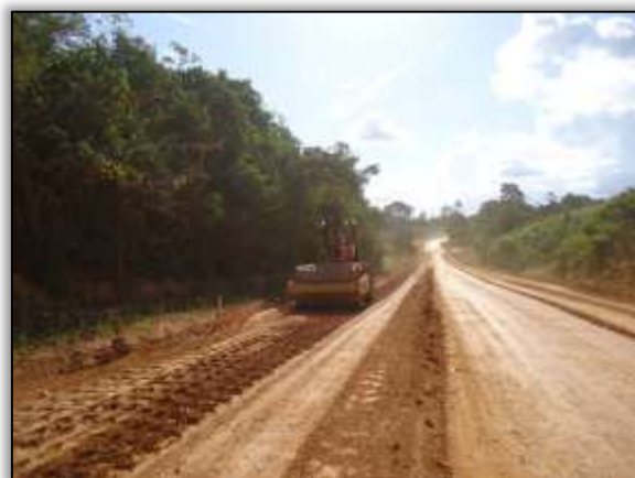
Foto 609 – Atividade de compactação na rodovia. Lado esquerdo. S 05.05362° W 049.45149 16/07/2014
