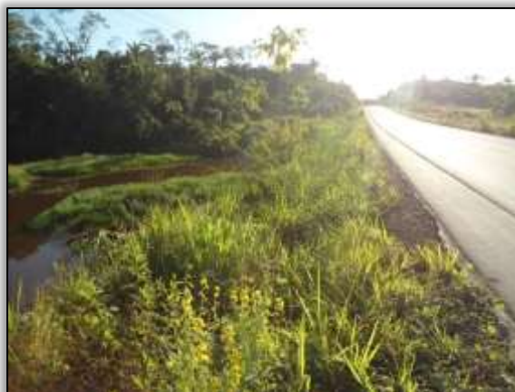
Foto 1356 – (Depois) Reconformação da área, plantio com hidrossemeadura no aterro e condução da revegetação natural. 05/06/2014
