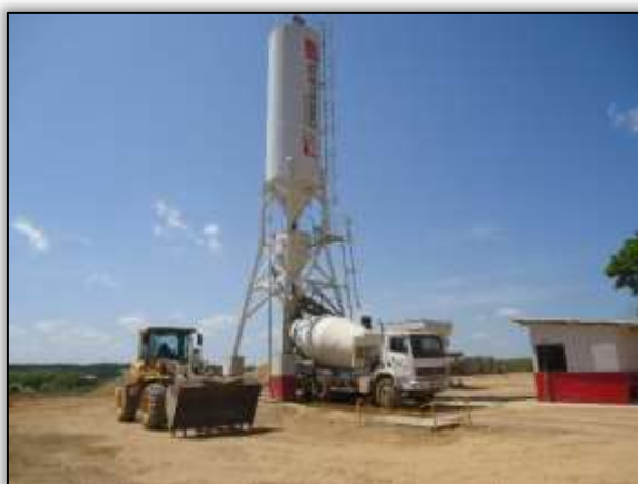
Foto 502 – Usina de concreto do canteiro. S 05.14387° W 049.35688° 29/07/2014
