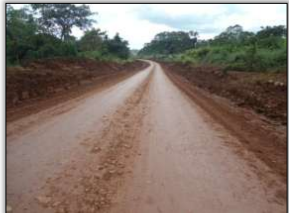
Foto 1152 - Pista reconformada. S 03.50177° W 053.01260°. 24/02/2014.
