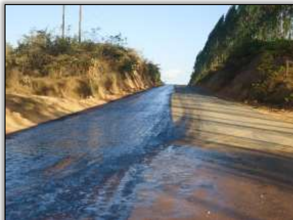
Foto 557 – Emulsão asfáltica. Lado direito. S 05.16386° W 049.38056° 28/07/2014
