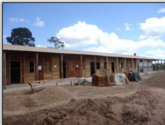
Foto 947 - Construção do alojamento. Lado direito. S 03.87007° W 054.22316° 10/06/2014.
