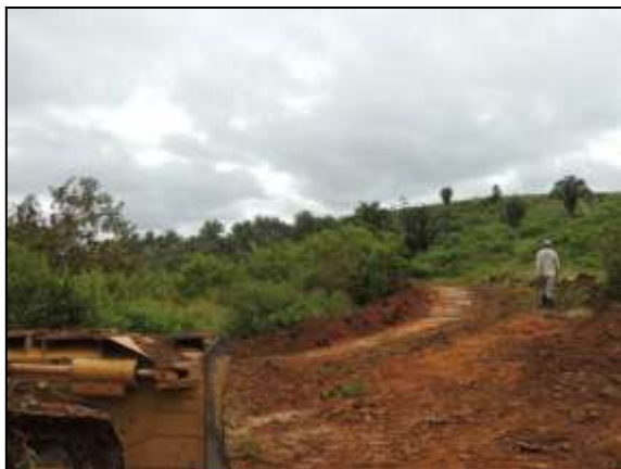
Figura 140. Biólogo acompanhando supressão vegetal em via de acesso ao britador, Cajazeiras – Lote 01. Data: 22/05/2014 _22M 0668720 E / 9457432 N
