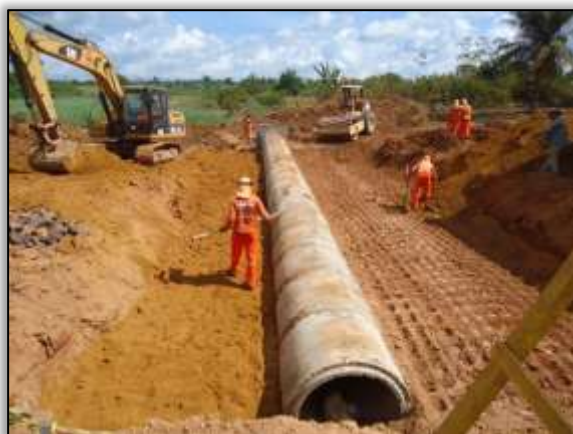
Foto 624 – Instalação de bueiro triplo tubular de concreto. Lado direito. S 04.95963° W 049.45843° 24/06/2014
