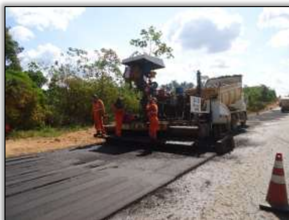
Foto 559 – Atividade de pavimentação. Lado esquerdo. S 05.18616° W 049.36592° 17/07/2014
