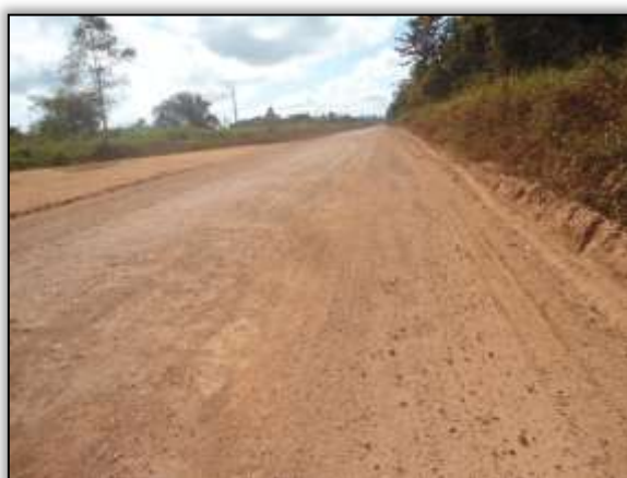
Foto 1249 - Pista reconformada. S 03.61693° W 053.33403° 17/07/2014.
