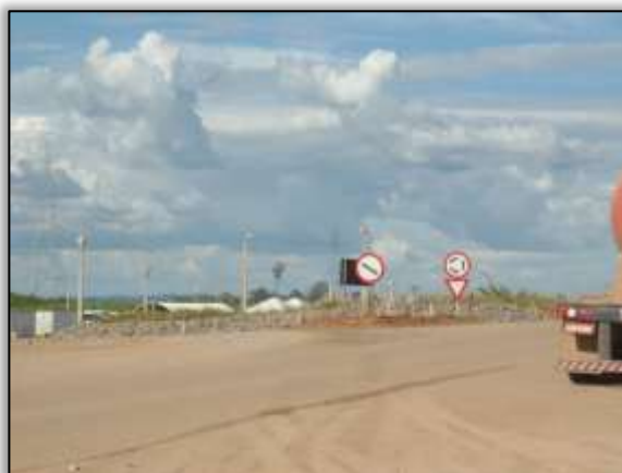
Foto 472 – Final do desvio da rodovia. Lado direito. S 03.12383° W 051.78881° 02/06/2014
