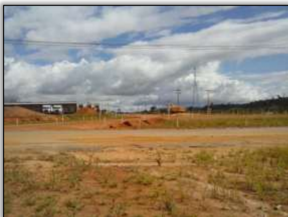
Foto 455. Acesso ao canteiro Bela Vista – Canais e Diques. Lado esquerdo. Estaca 4258. S 03.12479° W 051.73776° 03/04/2014
