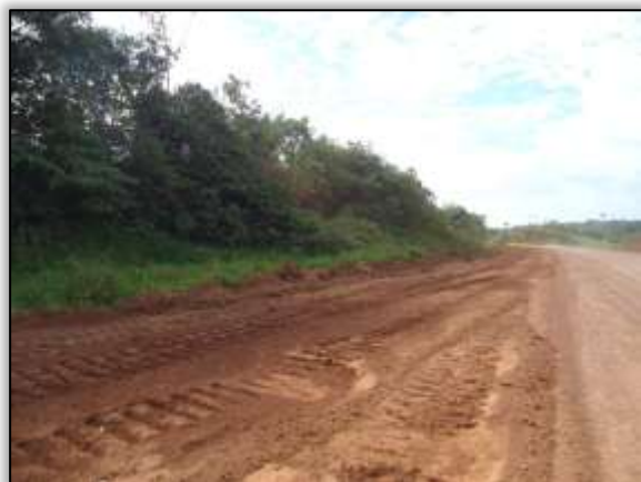
Foto 1381 – Limpeza no bordo da pista. Lado esquerdo. S 05.01727° W 049.45705° 06/05/2014
