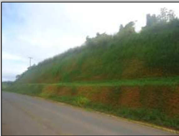
Foto 1257 – Talude com revestimento vegetal. Lado esquerdo. S 03.92569° W 050.34081° 18/02/2014
