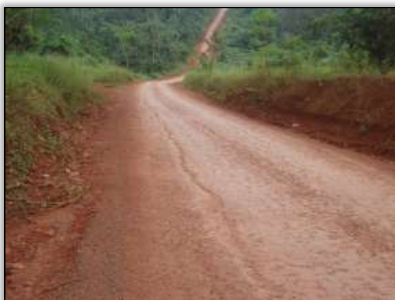
Foto 1208 – Pista em boas condições de tráfego. S 03.50614° W 052.02569° 07/05/2014.
