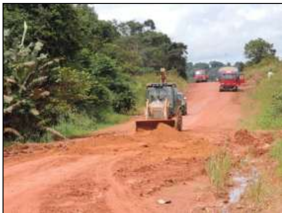
Figura 84. Atividades de manutenção do traçado no trecho entre Medicilândia e Uruará – Lote 01
