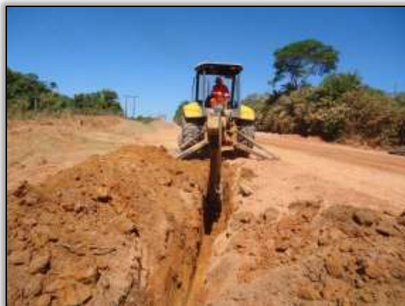
Foto 1343 – Abertura para instalação de dreno profundo. Lado esquerdo. S 04.99738° W 049.44621° 30/06/2014
