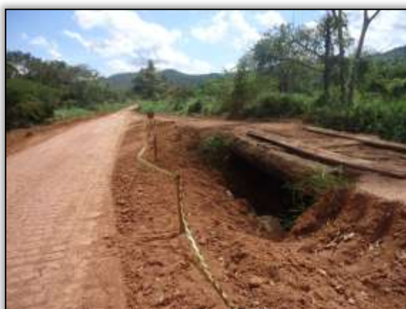
Foto 1235 - Bueiro construído na vicinal 235 norte. S 03.84421° W 054.18067° 09/07/2014.
