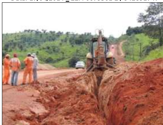
Figura 109. Abertura de vala para locação de dreno, entre Itupiranga e Cajazeiras – Lote 01. Data: 21/04/2014 _ 22M 0670952 E / 9445106 N
