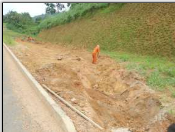
Foto 1266 – Construção de sarjeta. Lado esquerdo. Estaca 4966. S 03.55265° W 051.11026° 25/02/2014
