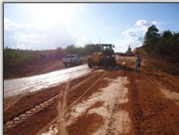
Foto 611 – Atividade de Terraplenagem. Ambos os Lados. S 04.94990° W 049.46620° 16/07/2014
