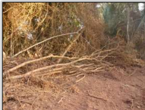
Foto 1643 - Supressão na faixa de domínio. Lado esquerdo. S 03.75057° W 053.83060° 22/07/2014.
