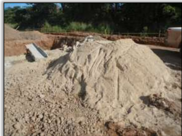
Foto 954 - Areia utilizada na obra. S 03.85568° W 054.12645° 19/02/2014.
