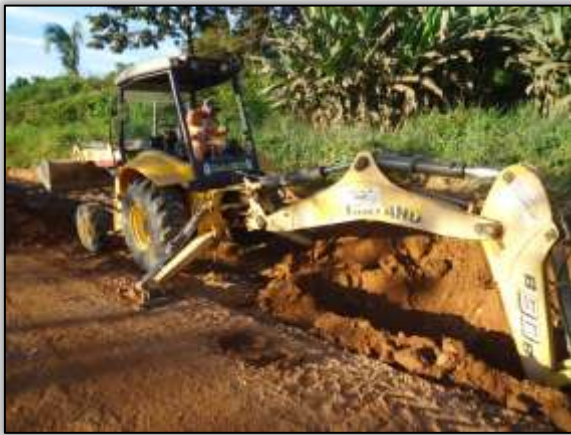
Foto 1340 – Abertura de vala para alocação de dreno profundo. Lado direito. S 05.15319° W 049.38892° 14/05/2014
