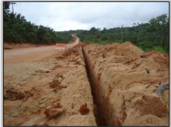
Foto 1254 – Alocação de dreno longitudinal. Lado direito. S 05.04684° W 049.45674° 19/02/2014
