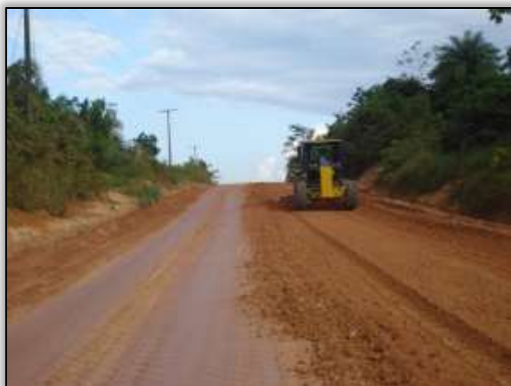
Foto 520 – Terraplanagem. Lado esquerdo. S 05.18179° W 049.36861° 14/05/2014
