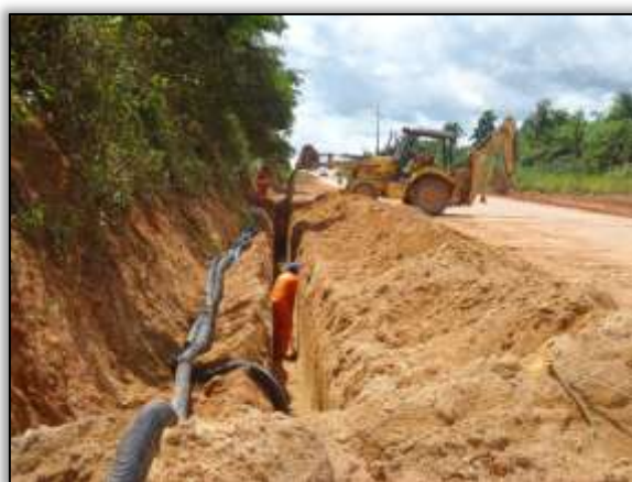
Foto 1298 – Alocação de dreno longitudinal. Lado esquerdo. S 05.040081° W 049.45913° 18/03/2014
