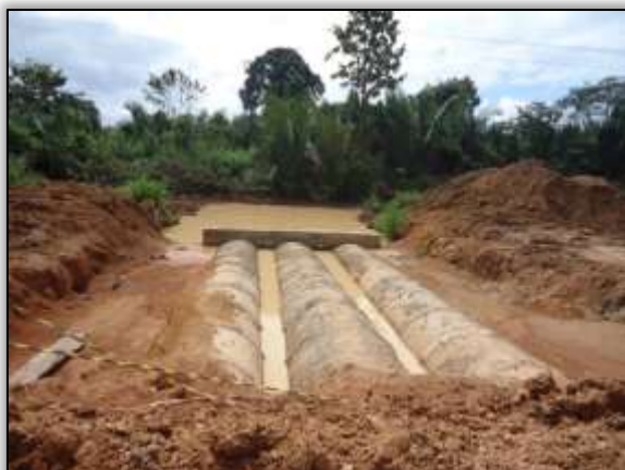
Foto 1011 – Construção de bueiro. S 03.86298°W 054.10196° 14/05/2014.
