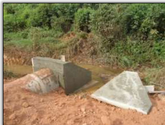
Foto 621 – Bueiro simples tubular. Lado direito. S 05.04689° W 049.45644° 03/06/2014
