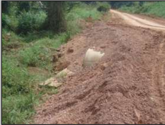
Foto 1236 - Bueiro construído na vicinal 235 norte. S 03.84750° W 054.17996°09/07/2014.
