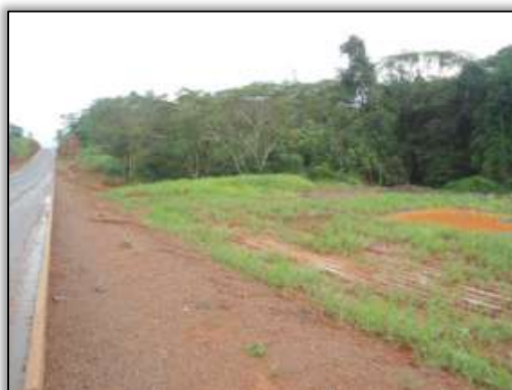
Foto 1282 – Crescimento de gramíneas. Lado esquerdo. Estaca 3326. S 03.41199° W 052.77843° 26/20/2014.
