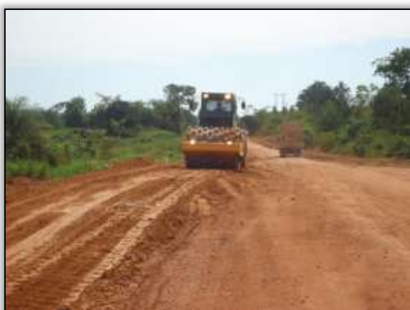
Foto 606 – Atividade de compactação na rodovia. Lado direito. S 04.98913°W 049.44595° 09/06/2014
