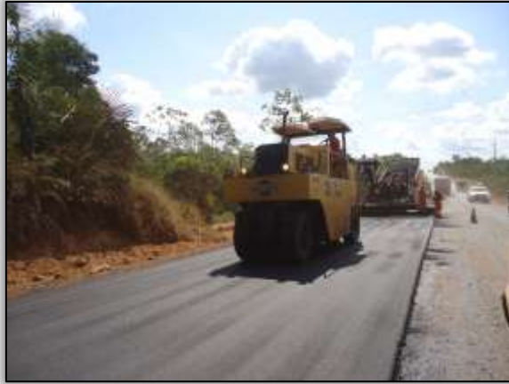
Foto 562 – Atividades de compactação asfáltica. Lado direito. S 05.18965° W 049.36403° 17/07/2014
