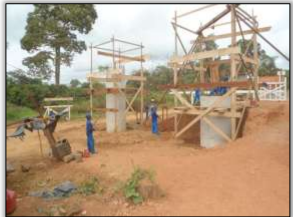
Foto 923 – Concretagem da coluna. Lado esquerdo. Estaca 1827. S 03.30872° W 052.53631° 30/07/2014.
