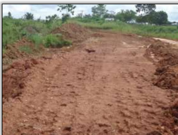
Foto 1013 – Desvio para implantação de bueiro. S 03.85756° W 054.11496° 14/05/2014.
