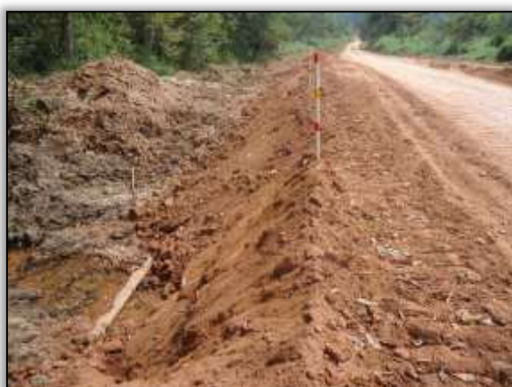
Foto 1234 - Bueiro construído na vicinal 235 norte. S 03.84421° W 054.18067° 09/07/2014.
