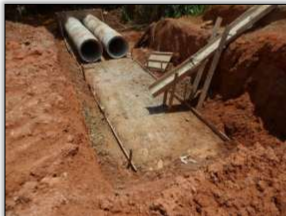
Foto 980 - Implantação de bueiro. S 03.85313° W 054.16103°. 25/02/2014.
