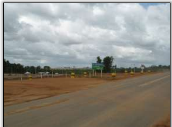
Foto 442 - Acesso a vila residencial CCBM. Lado direito. Estaca 4230. S 03.1251° W 051.74237° 31/01/2014
