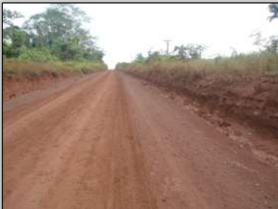
Foto 1222 – Declive reconformado. S 03. 46150° W 052. 93457° 27/06/2014
