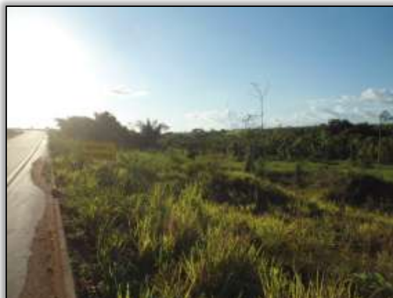
Foto 1362 – (Depois) Reconformação da área, plantio com hidrossemeadura e condução da revegetação natural. 05/06/2014
