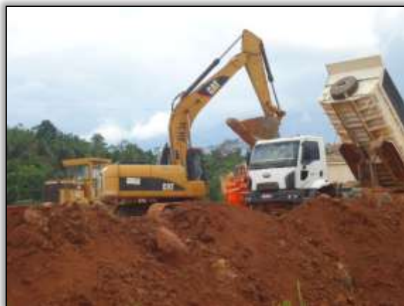
Foto 647 – Visão aproximada da atividade de corte em talude. Lado esquerdo. S 04.99999° W 049.41693° 13/06/2014
