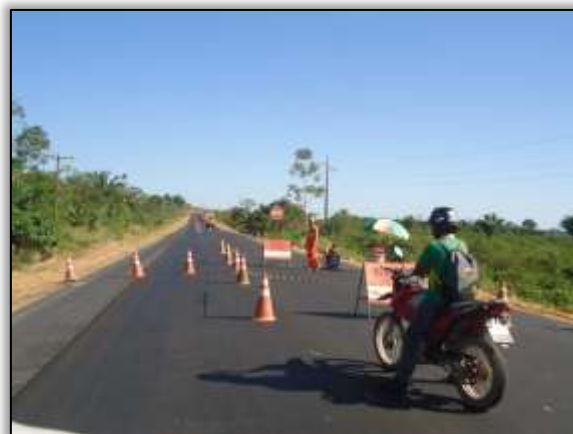
Foto 541 – Sinalização da rodovia. Lado direito. S 05.21010° W 048.83597° 24/06/2014
