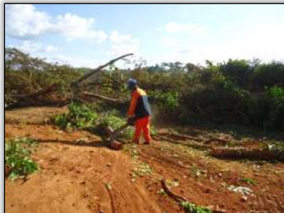
Foto 1475 - Supressão vegetal com a utilização de motosserra. Lado esquerdo. S 04.93674° W 049.46941° 21/07/2014
