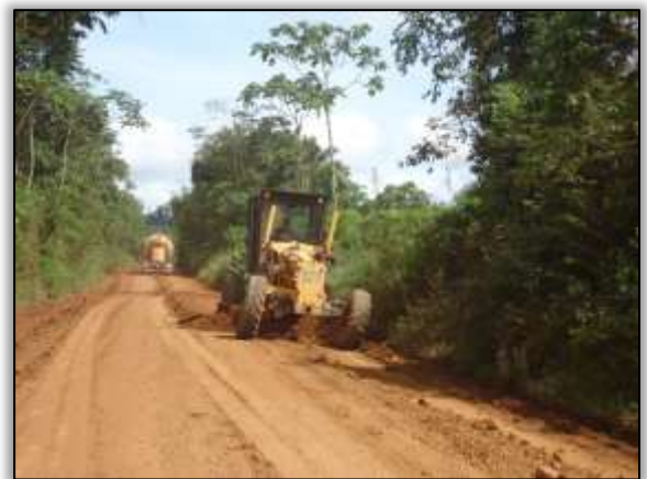
Foto 1378 – Limpeza no bordo da pista. Lado direito. S 04.86206° W 049.53254° 06/05/2014
