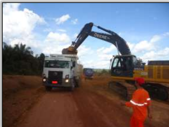
Foto 1113 – Corte na pista. Lado esquerdo. Estaca 9100. S 03.89115° W 054.33719° 26/06/2014.
