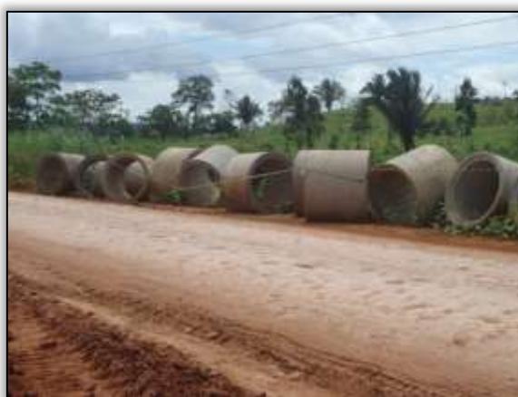
Foto 1014 Manilha para construção de bueiro. S 03.85756° W 054.11496° 14/05/2014.
