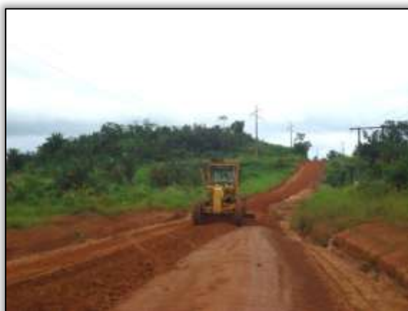
Foto 519 – Atividades de terraplanagem. Lado esquerdo. S 05.04190° W 049.45770° 13/03/2014
