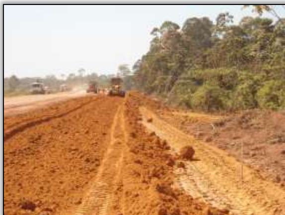
Foto 1131 – Terraplenagem. Estaca 8837. S 03.88825° W 054.29148° 30/07/2014.
