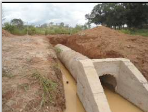
Foto 1002 - Construção de bueiro. S 03. 85926° W 054. 06721° 14/04/2014
