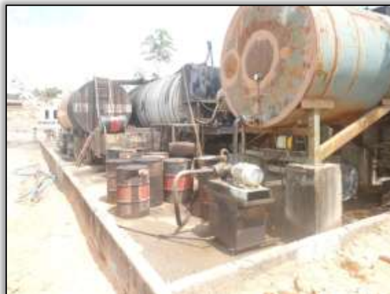
Foto 760 – Recipientes com efluentes dentro da caixa de contenção. Lado esquerdo. Estaca 589. S 03.44761° e W 051.22448° 29/07/2014
