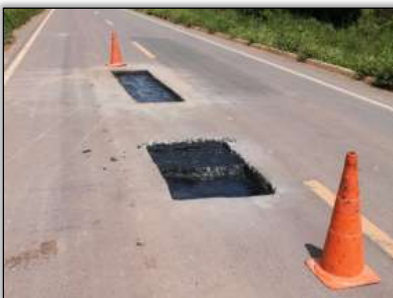
Foto 729– Recuperação Pista de Rolamento. Estaca 1413. Lado Esquerdo. S 03.35765° W 051.34013° 24/04/2014.
