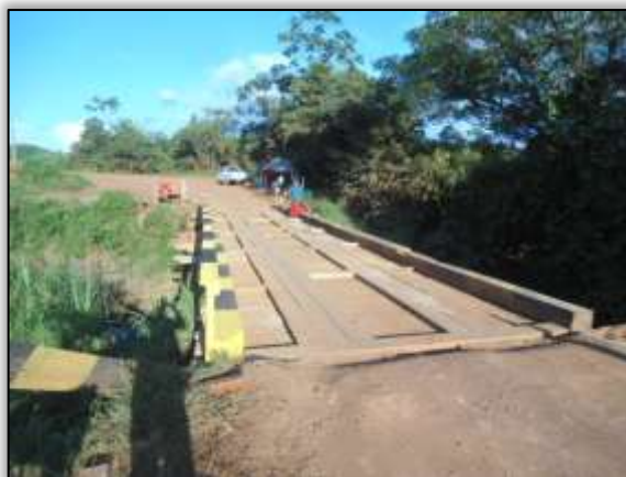
Foto 12052 – Reforma da Ponte sobre o Rio Jacarezinho.
