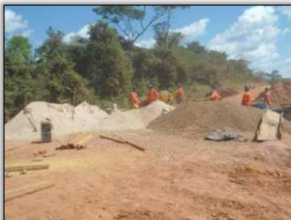
Foto 1046 - Construção de bueiro. S 03.85233° W 054.15846° 16/07/2014.
