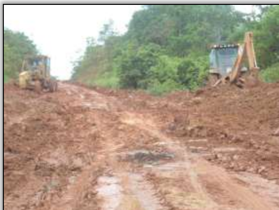
Foto 1135 – Máquinas da empresa CCM fazendo a reconformação de buracos. S 03.91413° W 054.55127° 11/03/2014.
