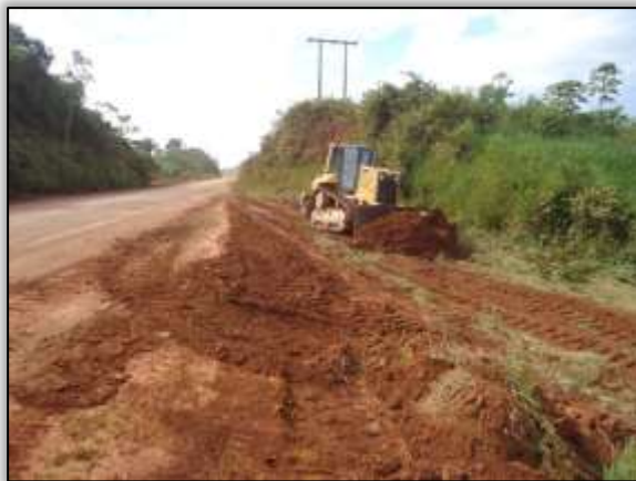
Foto 1379 – Limpeza no bordo da pista. Lado esquerdo. S 05.00772° W 049.45065° 06/05/2014
