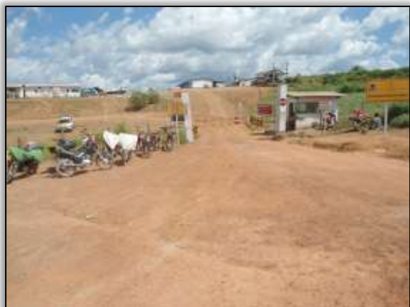
Foto 755 – Entrada do canteiro. Lado esquerdo. Estaca 561 S 03.45172° e W 051.21874° 30/07/2014
