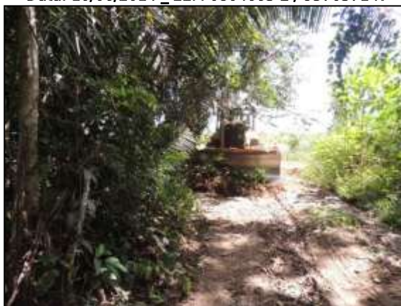
Figura 163. Supressão vegetal de via de acesso à pedreira, próximo a Placas – Lote 02
