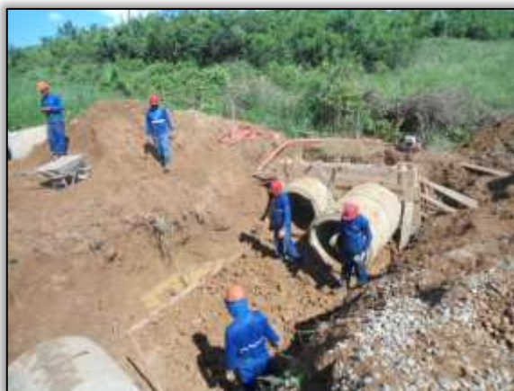
Foto 1092 – Construção de bueiro. S 03.89205° W 054.4300° 24/04/2014.
