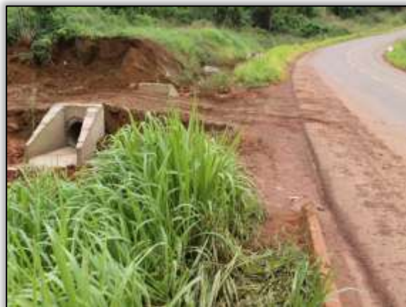
Foto 838 – Bueiro simples de concreto. Lado Esquerdo. Estaca 3530. S 03.42965° W 052.80794° 17/04/2014.
