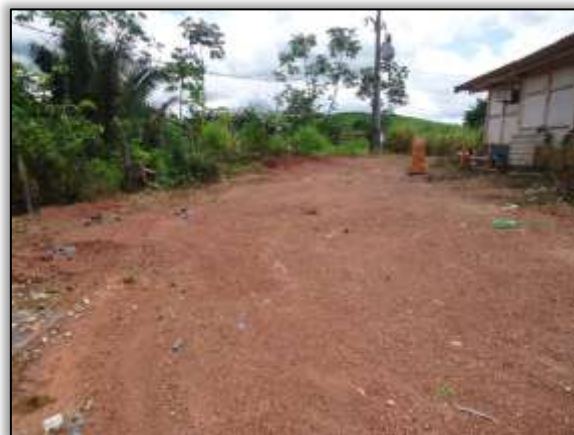
Foto 665 – Canteiro organizado. S 04.23923° W 049.95534° 16/05/2014
