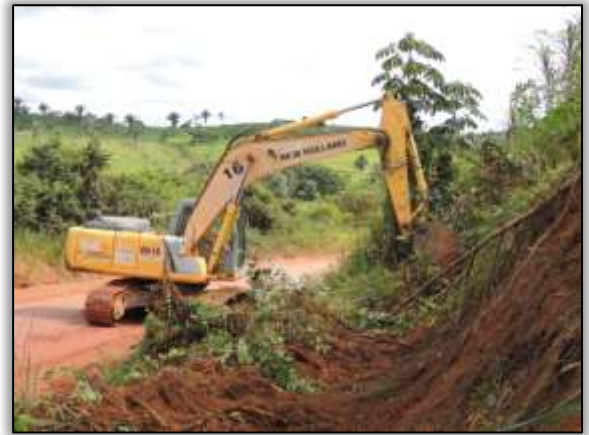
Foto 1376 – Limpeza em talude. Lado esquerdo. S 05.18701° W 049.36444° 02/05/2014
