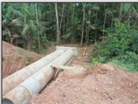
Foto 995 - Bueiro em construção. S 03.85328° W 054.16122°. 27/03/2014.
