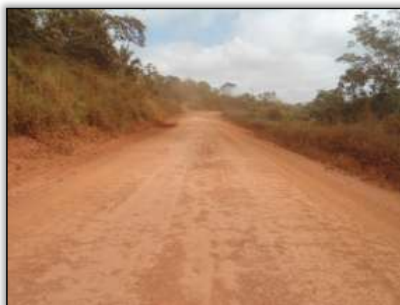
Foto 1243 - Pista reconformação. S 0350170° W 053.00808° 10/07/2014.
