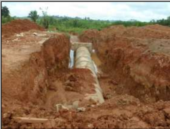
Foto 971 – Implantação de bueiro. Estaca 7680. S 03.86257° W 054.09534°. 19/02/2014.
