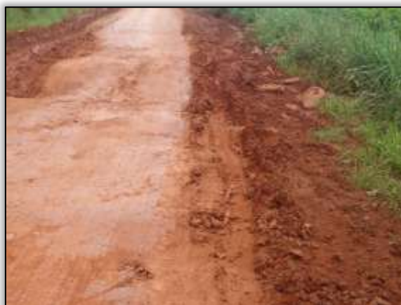
Foto 1207 – Buraco na pista. S 03.50161° W 053.00744° 07/05/2014.
