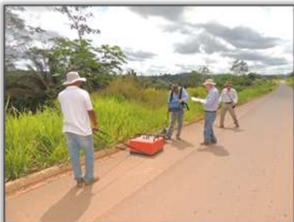
Foto 427 – Trecho com anomalia, km 85 rodovia BR-230/PA. Medicilândia/PA, 17/07/2014.
