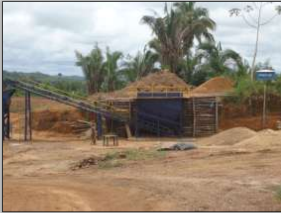
Foto 505 – Instalação da britagem. Lado esquerdo. S 05.21944° W 049.34484° 24/02/2014
