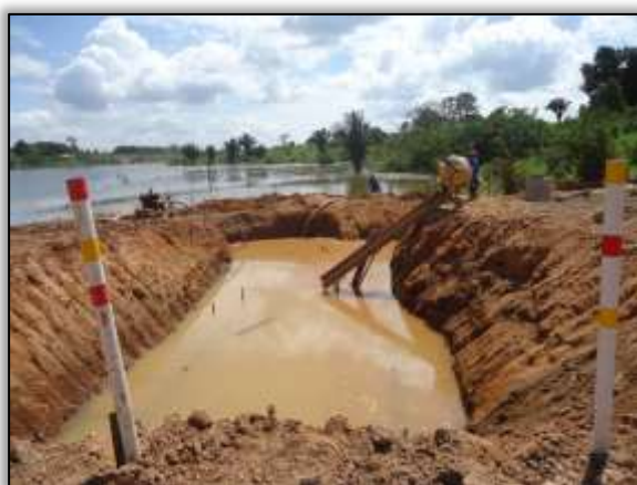
Foto 1103 – Construção de galeria. Estaca 8710. S 03.89008° W 054.27016° 06/06/2104.
