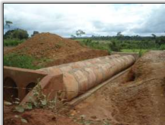
Foto 1070 - Implantação de bueiro. S 03.89173° W 054.33469°. 25/02/2014.
