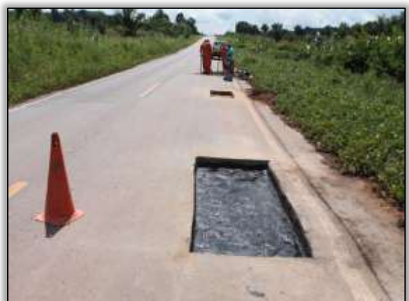
Foto 730– Recuperação Pista de Rolamento. Lado Direito. S 03.35637° W 051.34161° 24/04/2014.
