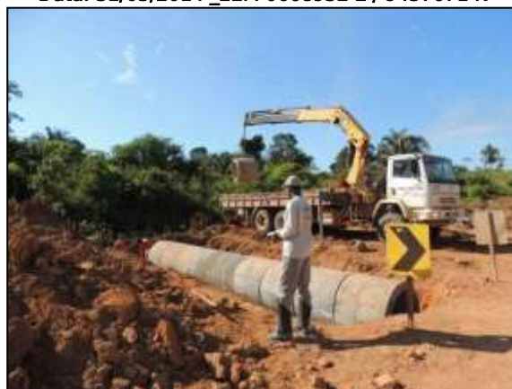
Figura 149. Equipe acompanhando abertura de vala e locação de bueiro no trecho entre Itupiranga e Cajazeiras _ Lote 01. Data: 31/05/2014 _22M 0672276 E / 9448890 N
