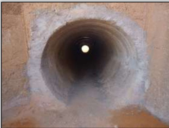
Foto 616 – Reforço de concreto em bueiro ARMCO concluído. Lado direito. S 05.01652° W 049.45953° 03/06/2014
