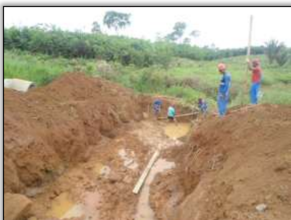
Foto 1079 - Construção de bueiro. Estaca 9636. S 03.89207° W054. 43005°. 25/03/2014.
