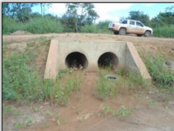
Foto 1083 – Bueiro concluído S 03.88821° W 054.29922° 10/04/2014.
