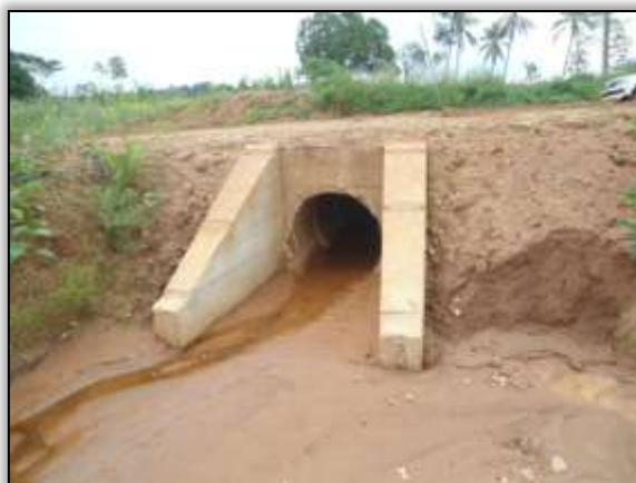
Foto 994 - Bueiro concluído. Estaca 7927. S 03.85407° W 054.13633°. 27/03/2014.
