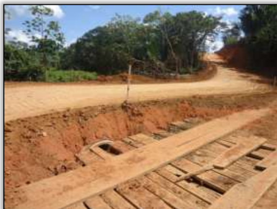
Foto 1233 - Bueiro construído pela na vicinal 235 norte. S 03.81395° W 054.18826° 09/07/2014.
