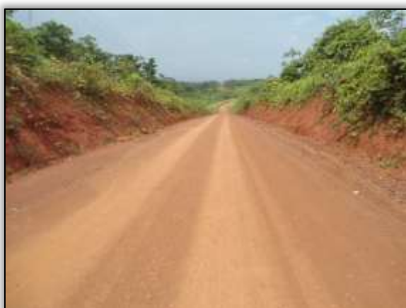
Foto 1197 – Declive em boas condições. S 03.65623° W 053.50130° 23/04/2014.
