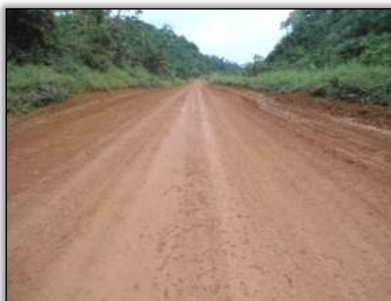
Foto 1227 - Pista reconformada. S 03. 56825° W 053. 21112° 01/07/2014
