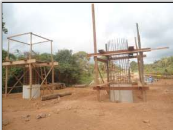
Foto 924 – Concretagem da coluna. Lado esquerdo. Estaca 1827. S 03.30872° W 052.53631° 30/07/2014.
