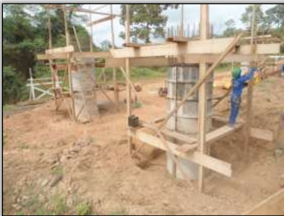
Foto 922 – Concretagem da coluna. Lado esquerdo. Estaca 1827. S 03.30872° W 052.53631° 30/07/2014.
