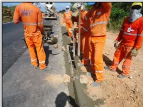
Foto 538 – Implantação de meio fio. Lado esquerdo. S 05.26055° W 049.32248° 21/07/2014
