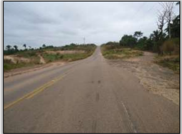
Foto 440 – Entrada para áreas de apoio do canteiro de obras. S 05.14985°W 049.38852° 29/07/2014
