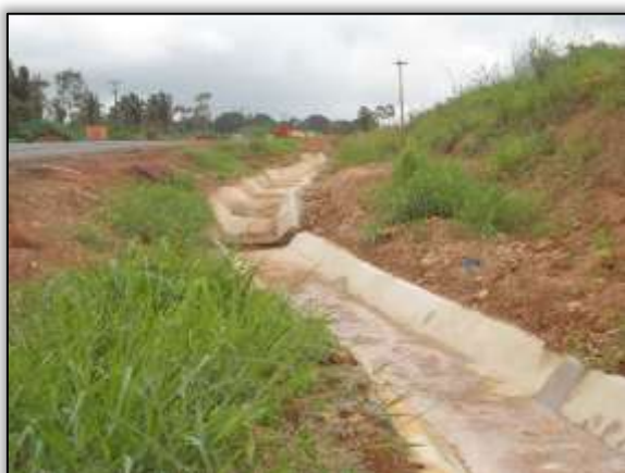
Foto 818 – Valeta concluída. Lado esquerdo. Estaca 1891. S 03.30983° W 052.54768° 18/02/2014.
