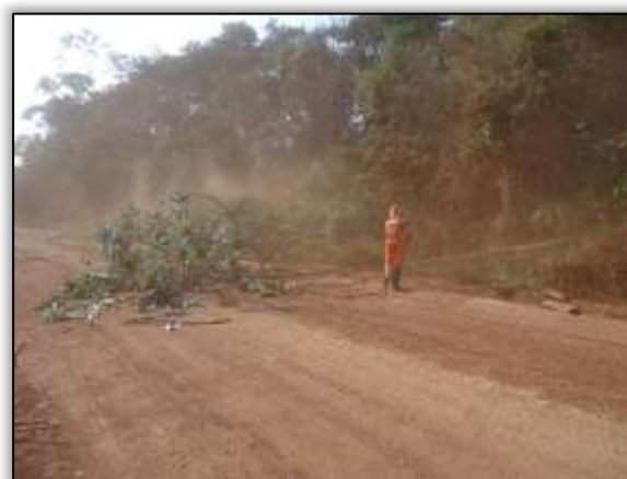
Foto 1467 - Supressão vegetal com a utilização de motosserra. Lado direito. S 04.90849° W 049.47625° 29/07/2014.
