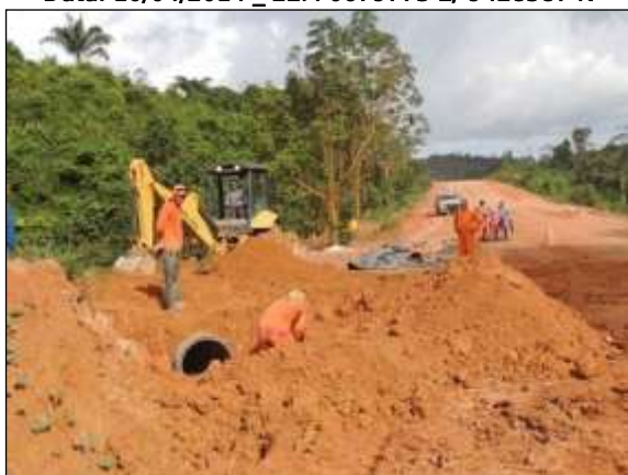
Figura 92. Colocação de dreno no trecho entre Itupiranga e Cajazeiras – Lote 01. Data: 11/04/2014 _ 22M 0672403 E/ 9440587 N
