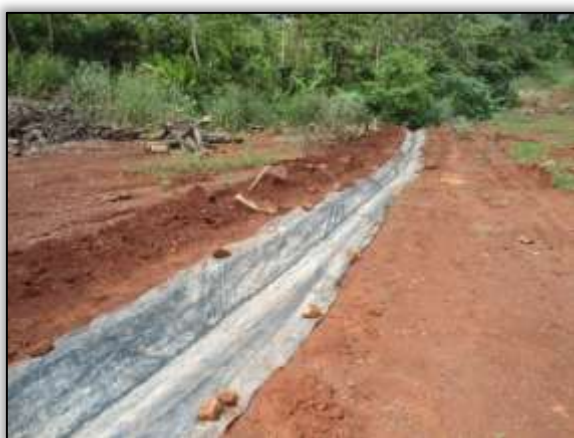
Foto 824 – Construção de valeta. Lado direito. Estaca 3480. S 03.42417° W 052.80323° 18/02/2014.
