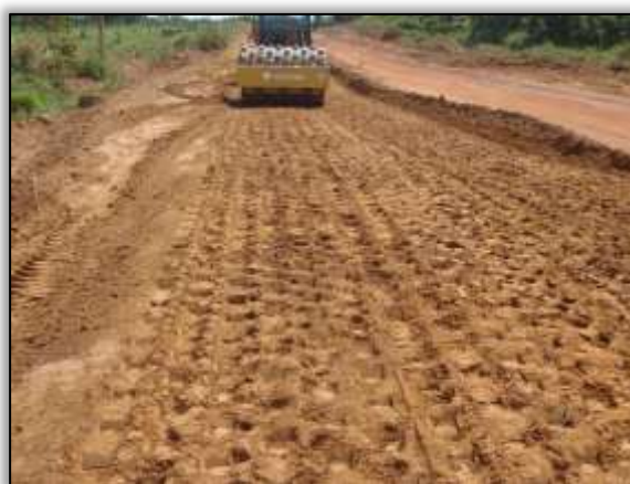
Foto 1116 – Terraplanagem. Estaca 9123. S 03.88984° W 054.34034° 26/06/2014.
