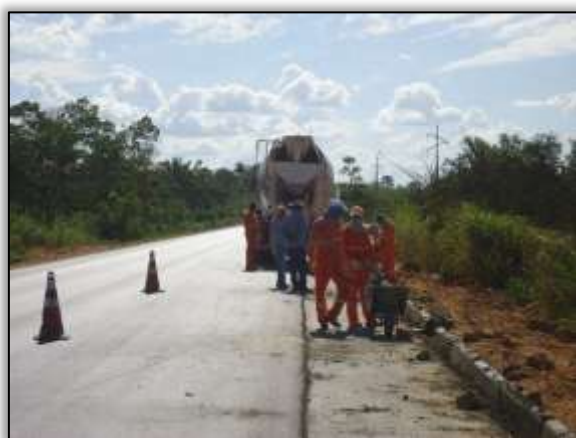
Foto 536 – Implantação de meio fio. Lado direito. S 05.26265° W 049.31952° 16/07/2014
