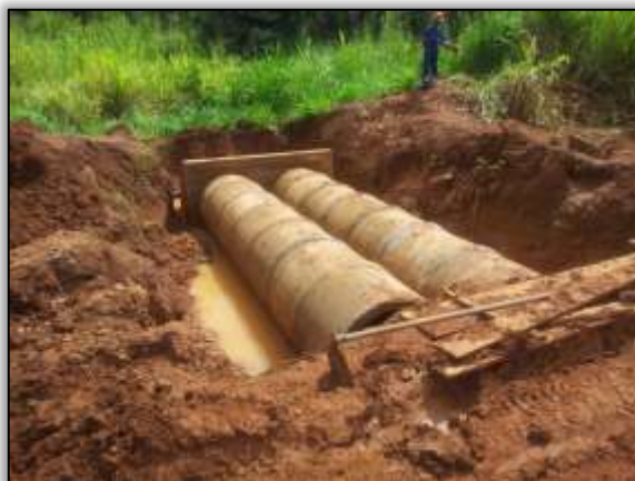
Foto 1094 – Construção de bueiro. S 03.89326° W 054.44053° 24/04/2014.
