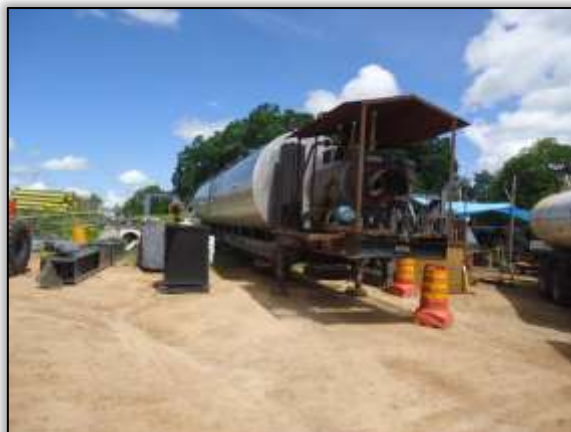
Foto 494 – Usina de asfalto móvel. S 05.14428° W 049.35740° 30/04/2014
