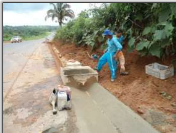
Foto 1274 – Construção de valeta. Lado esquerdo. S 03.31800° W 052.56408° 25/02/2014.
