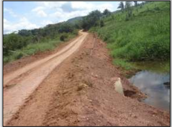
Foto 1237 - Bueiro construído na vicinal 235 norte. S 03.84750° W 054.17996°09/07/2014.
