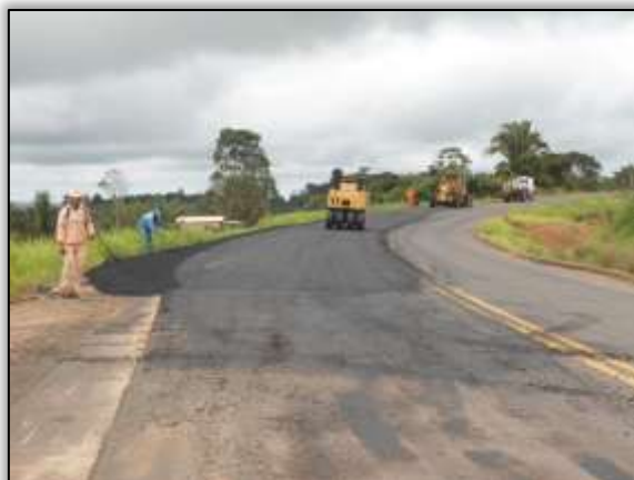
Foto 829 – Recuperação asfáltica. Lado esquerdo. S 03.36109° W 052.63305° 25/03/2014.
