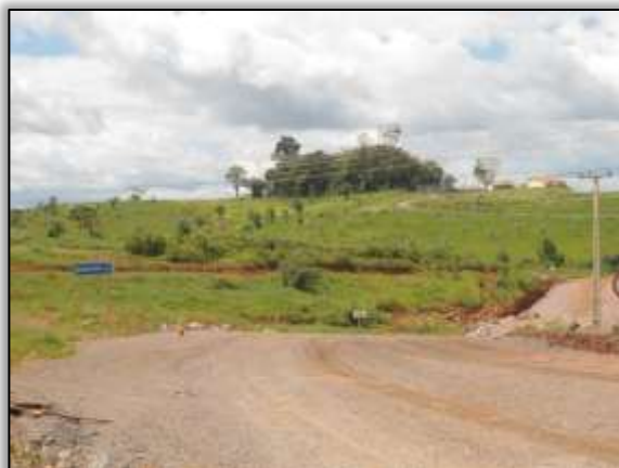
Foto 468- Acesso ao porto do CCBM. Lado direito. Estaca 4572. S 03.12021° W 051.79644° 24/04/2014
