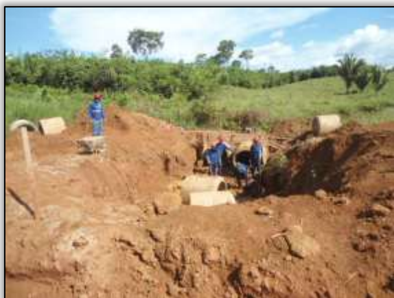
Foto 1091 – Construção de bueiro. S 03.89205° W 054.4300° 24/04/2014.
