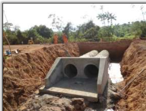
Foto 635 – Bueiro duplo tubular de concreto. Lado esquerdo. S 04.94990° W 049.46511° 08/07/2014
