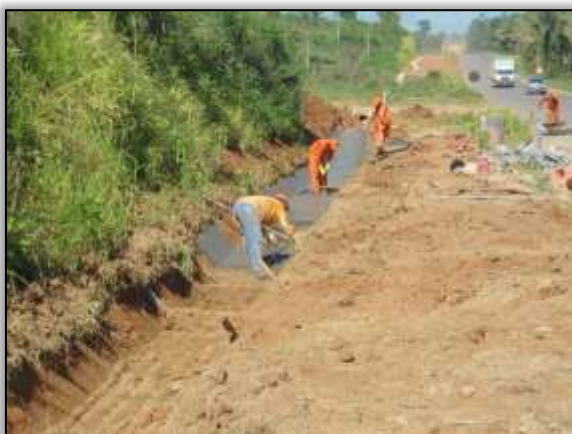
Foto 700 – Construção de valeta. Lado direito. Estaca 4497. S 03.59927° W 051.04525° 03/06/2014
