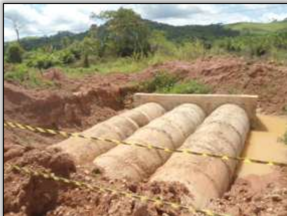
Foto 1005 – Construção de bueiro. S 03. 85093° W 054. 15306° 22/04/2014
