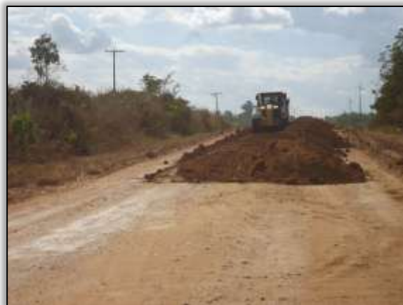
Foto 527 – Atividade de terraplenagem. Eixo. S 05.22607° W 049.33955° 18/06/2014
