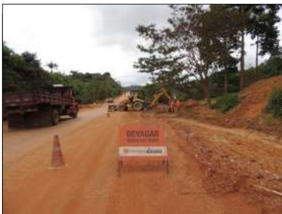
Figura 96. Empréstimo de material, entre Marabá e Itupiranga – Lote único. Data: 14/04/2014 _ 22M 0673970 E / 9440895 N
