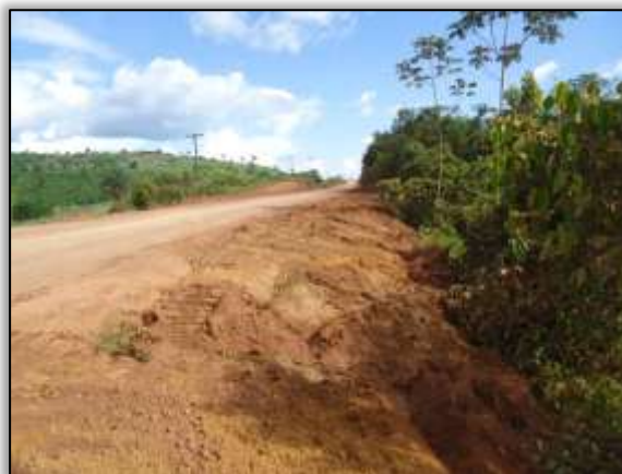
Foto 1382 – Limpeza no bordo da pista. Lado direito. S 05.01727° W 049.45705° 06/05/2014
