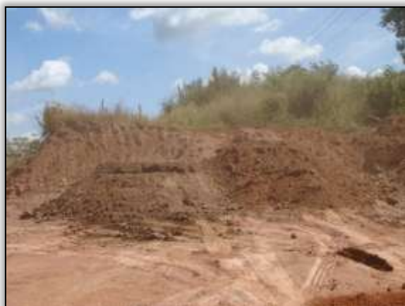
Foto 1029 - Corte em talude. S 03.85258° W 054.15938° 24/06/2014.
