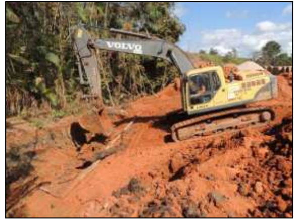
Figura 171. Abertura de vala para locação de bueiro, entre Uruará e Placas – Lote 02. Data: 24/06/2014 _ 21M 0815337 E / 9573550 N
