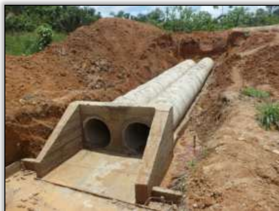
Foto 978 - Implantação de bueiro. Estaca. 7729. S 03.86311° W 054.10439°. 25/02/2014
