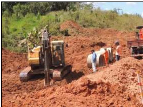
Figura 164. Acompanhamento de abertura de bueiro para locação de dreno, entre Uruará e Placas – Lote 02. Data: 12/06/2014 _ 21M 0815300 E / 9573545 N
