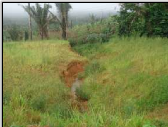
Foto 1321 – Processo erosivo após revestimento vegetal em 24/04/2014. Lado direito. S 03.93081º W 050.33004º
