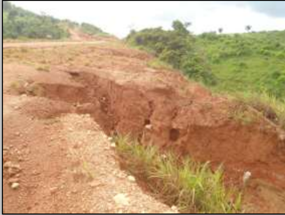
Foto 1144 – Erosão na saia de aterro. Lado esquerdo. S 03.72594° W 050.87890° 25/02/2014
