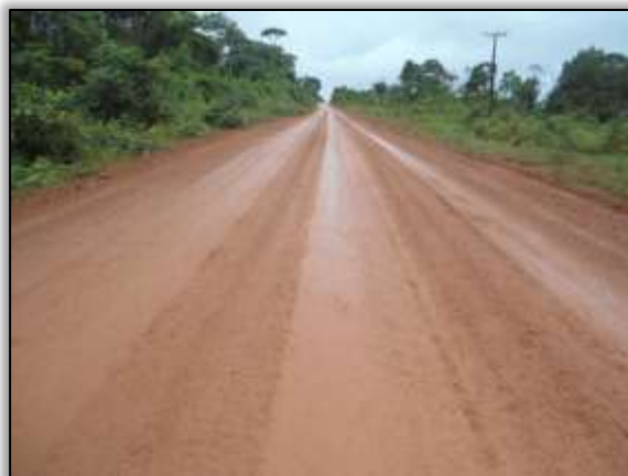
Foto 1225 - Declive reconformado. S 03. 52755° W 053. 16325° 01/07/2014
