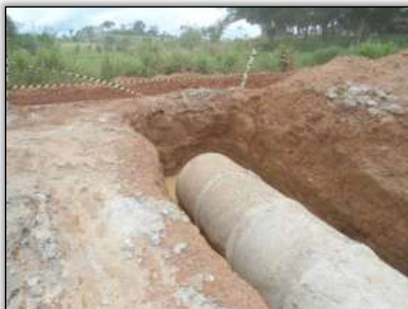
Foto 1001 – Construção de bueiro. S 03. 85926° W 054. 06721° 14/04/2014
