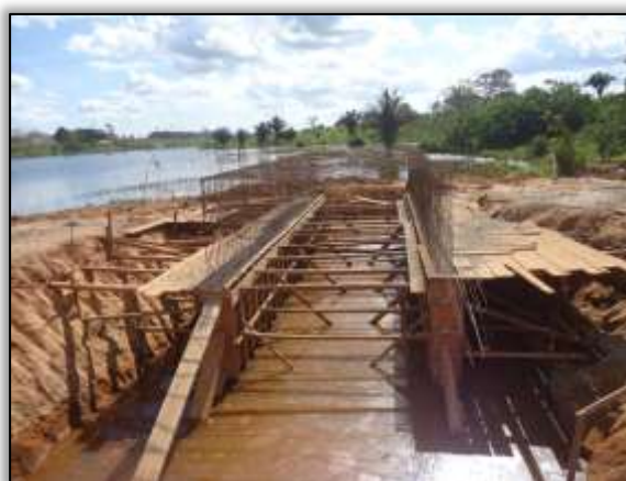
Foto 1104 – Construção de galeria. Estaca 8710. S 03.89008° W 054.27016° 06/06/2104.
