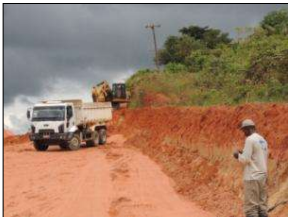
Figura 54. Acompanhamento de empréstimo de material entre Marabá e Itupiranga – Lote Único. Data: 11/01/2014_22M 0673308 E / 9439615 N
