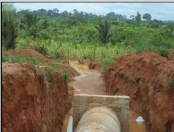
Foto 973 - Implantação de bueiro. Estaca 7680. S 03.86257° W 054.09534°. 19/02/2014.
