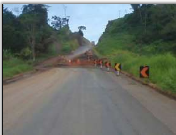
Foto 897. Sinalização com delineadores e placas refletivas- Dnit. Estaca 3700. S 03.44083° W 052.84990° 21/07/2014.
