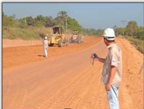
Foto 423 – Trecho em obras. Equipe de Supervisão Ambiental. Placas/PA, 15/07/2014.
