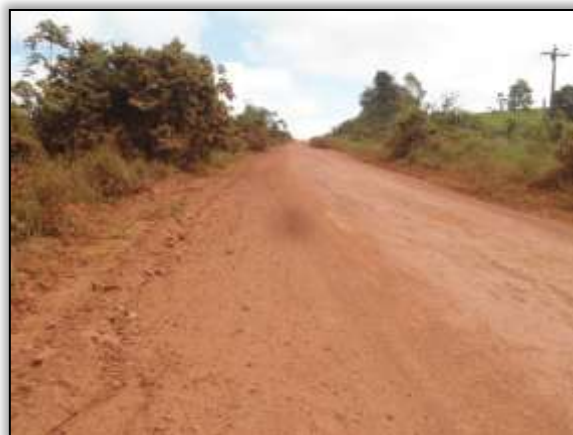
Foto 1245 - Declive reconformado. S 03.50327° W 0543.07527° 10/07/2014.
