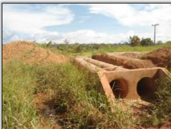
Foto 1087 – Bueiro. S 03.89173° W 054.33481° 14/04/2014.
