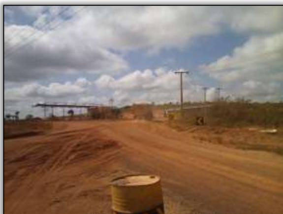
Foto 485. Acesso ao canteiro Bela Vista – Canais e Diques. Lado esquerdo. Estaca 4258. S 03.12479° W 051.73776° 30/07/2014
