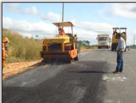
Foto 549 – Atividades de compactação asfáltica. Lado direito. S 05.24718° W 049.32989° 30/06/2014
