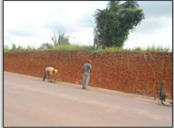
Foto 1271 – Preparo para hidrossemeadura no talude. Lado direito. Estaca 4739. S 03.57672° W 051.07888° 26/02/2014
