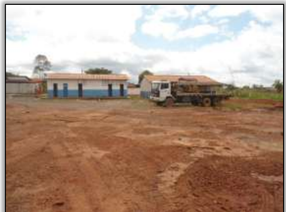
Foto 778– Canteiro de obras sendo desativado. Lado esquerdo. Estaca 1827. S 03.30872° W 052.53631° 23/05/2014.
