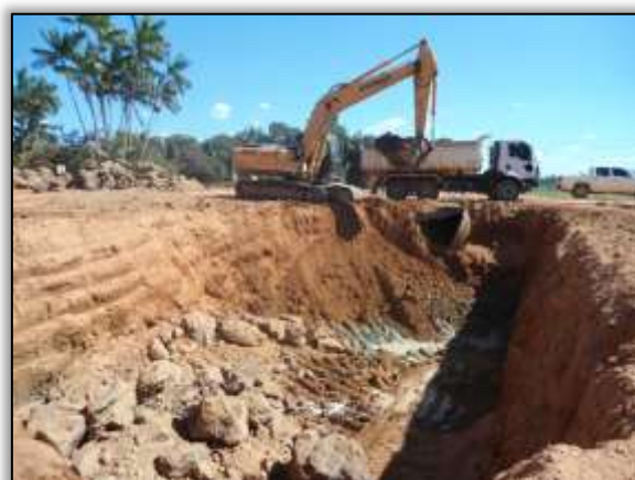
Foto 641 – Atividades de substituição de galeria. Lado direito. S 04.92653° W 049.47211° 30/07/2014
