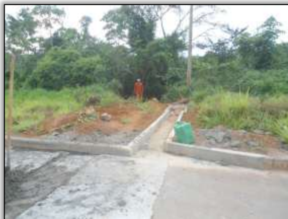
Foto 710 – Construção descida d’água. Lado direito. Estaca 5046. S 03.54303º W 051.1211º 30/07/2014
