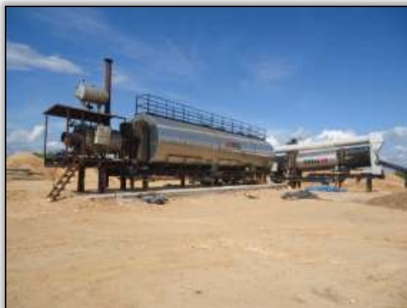
Foto 510 – Usina de asfalto móvel. Lado esquerdo. S 05.21944° W 049.34484° 07/05/2014
