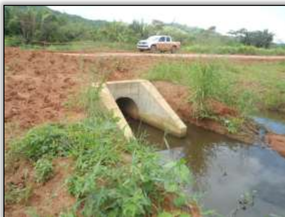
Foto 996 - Bueiro concluído. S 03.85139° W 054.15563°. 27/03/2014.
