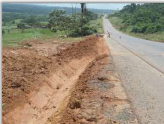
Foto 826 – Construção de valeta. Lado esquerdo. Estaca 2540. S 03.36740° W 052.64540° 18/02/2014.
