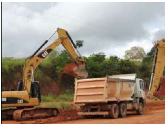
Figura 110. Manutenção do traçado no trecho entre Itupiranga e Cajazeiras – Lote 01. Data: 22/04/2014 _ 22M 0670930 E / 9445035 N
