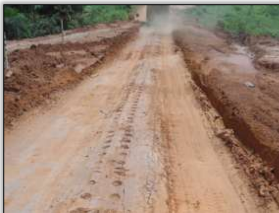
Foto 1008 - Bueiro concluído. S 03. 85307° W 054. 16079° 22/04/2014
