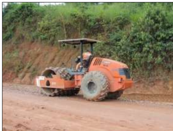
Figura 105. Manutenção do traçado no trecho entre Itupiranga e Cajazeiras – Lote 01. Data: 16/04/2014 _ 22M 0670744 E / 9444399 N
