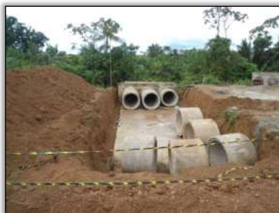
Foto 1074 - Implantação de bueiro. Estaca. 9437. S 03.88789° W 054.39499°. 11/02/2014.
