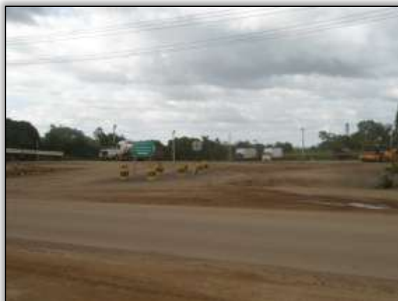
Foto 444 – Entrada para o estacionamento do CCBM. Lado direito. S 03.12371° W 051.78945° 31/01/2014
