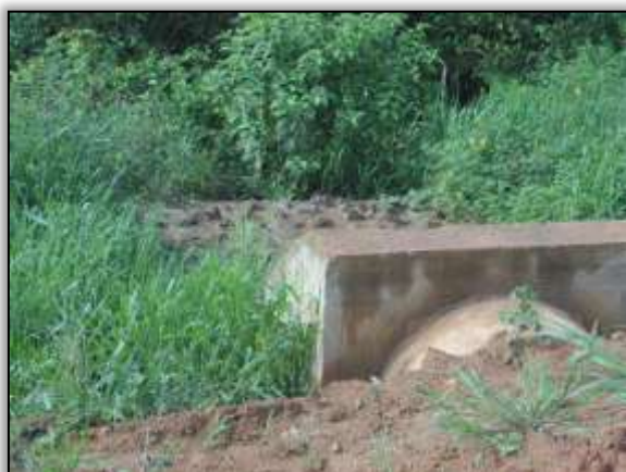
Foto 997 – Bueiro concluído. Estaca 8623. S 03.87561° W 054.24076°. 27/03/2014.
