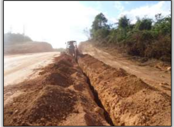
Foto 1348 – Abertura para instalação de dreno profundo. Lado direito. S 04.94908° W 049.46553° 28/07/2014
