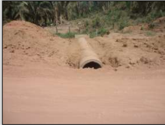
Foto 1052 - Construção de bueiro. S 03.85754° W 054.03567° 24/07/2014.
