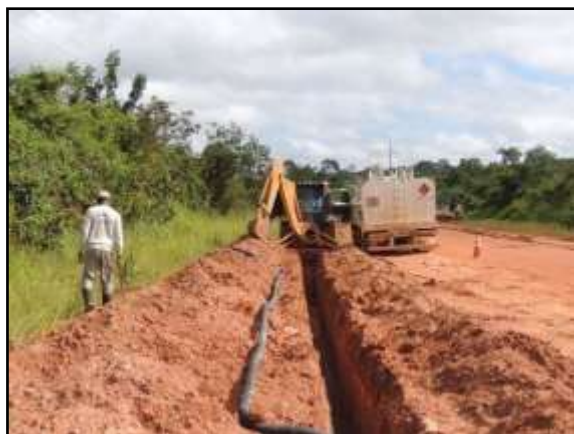
Figura 116. Biólogo acompanhando abertura de canaleta para locação de dreno entre Marabá e Itupiranga – Lote único.
