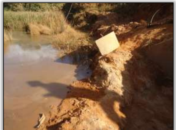
Foto 619 – Barramento em corpo hídrico para instalação de reforço em bueiro. Lado direito. S 05.01652° W 049.45953° 03/06/2014
