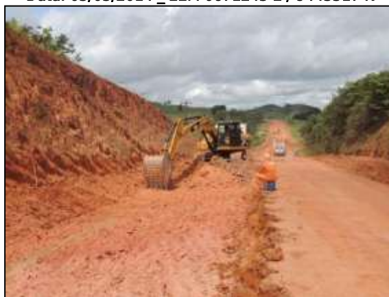
Figura 125. Rebaixamento de pista, trecho entre Itupiranga e Cajazeiras – Lote 01. Data: 06/05/2014 _ 22M 0671346 E / 9445674 N
