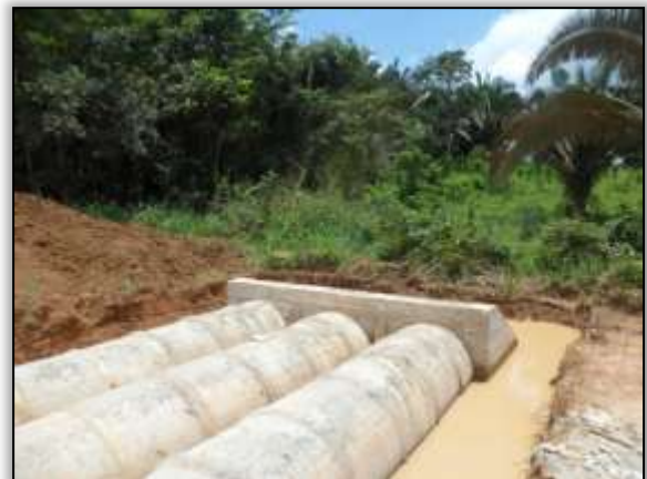
Foto 974 - Implantação de bueiro. Estaca 7715. S 03.86298° W 054.10204°. 19/02/2013
