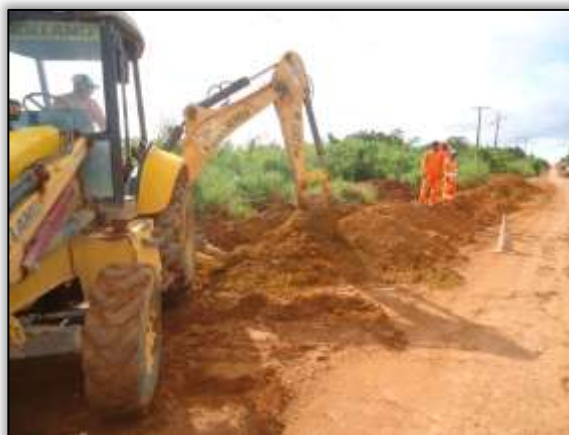
Foto 1294 – Alocação de dreno longitudinal. Lado esquerdo. S 05.16673° W 049.37858° 25/03/2014
