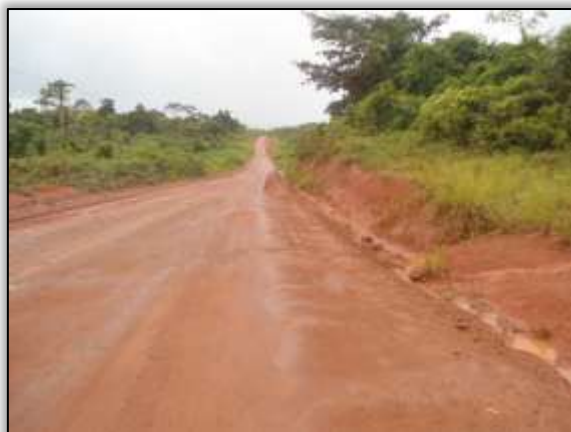
Foto 1196 – Pista em boas condições de tráfego. S 03.66233° W 053.51640° 15/04/2014.
