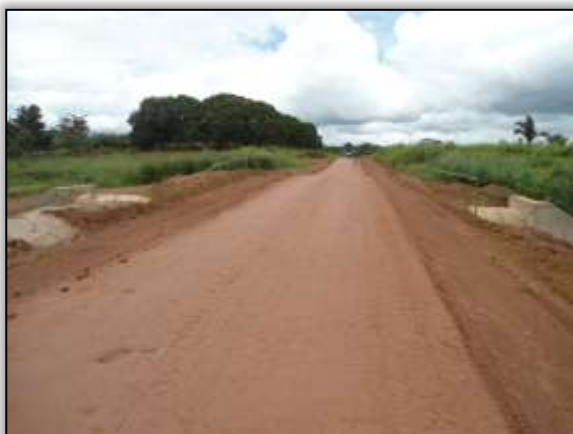
Foto 1065 - Bueiro concluído. Estaca 8751. S 03.89059° W 054.27679°. 25/02/2014.
