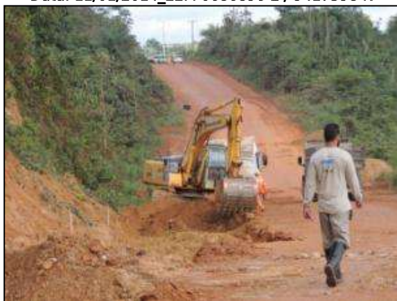
Figura 58. Acompanhamento de retirada de material úmido da terraplenagem entre Marabá e Itupiranga – Lote Único. Data: 11/01/2014_22M 0681184 E / 9426413 N
