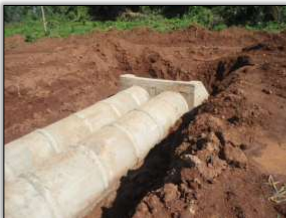
Foto 1088 – Bueiro. S 03.88964° W 054.41402° 22/04/2014.
