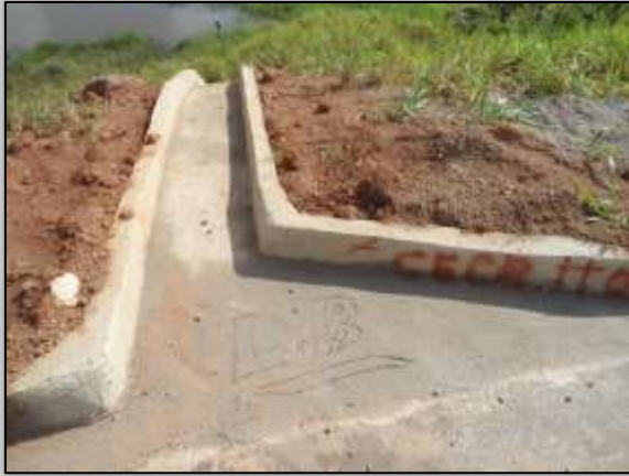
Foto 848– Reconstrução de descida d'água. Lado direito. Estaca 1938. S03. 31346° W 052.55519° 02/06/14
