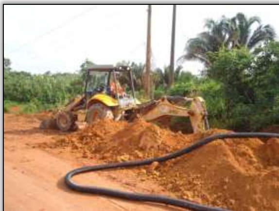
Foto 1292 – Alocação de dreno longitudinal. Lado esquerdo. S 05.17695° W 049.37176° 13/03/2014
