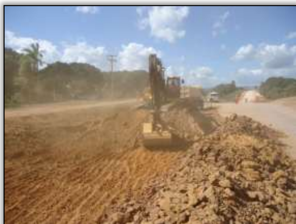
Foto 1037 - Corte na pista. Estaca 8600. S 03.88085° W 054.25368° 24/06/2014.
