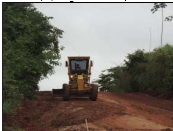
Figura 71. Limpeza de área lateral na rodovia entre Araguatins e Palestina. Data: 28/01/2014 _ 22M 0797900 E / 9370468 N
