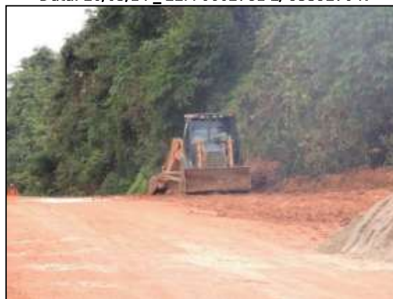
Figura 83. Abertura de vala para locação de drenos na rodovia entre Itupiranga e Cajazeiras – Lote 01.
