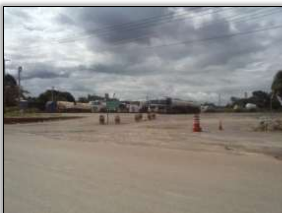
Foto 459 – Entrada para o estacionamento do CCBM. Lado direito. S 03.12371° W 051.78945° 03/04/2014
