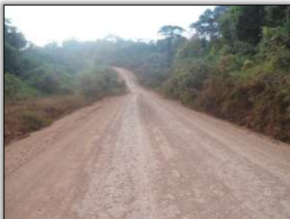
Foto 1246 – Declive reconformado. S 03.56678° W 053.20371° 17/07/2014.
