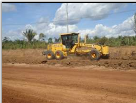
Foto 1033 – Terraplanagem. Estaca 8218. S 03.86058° W 054.18610° 24/10/2014.
