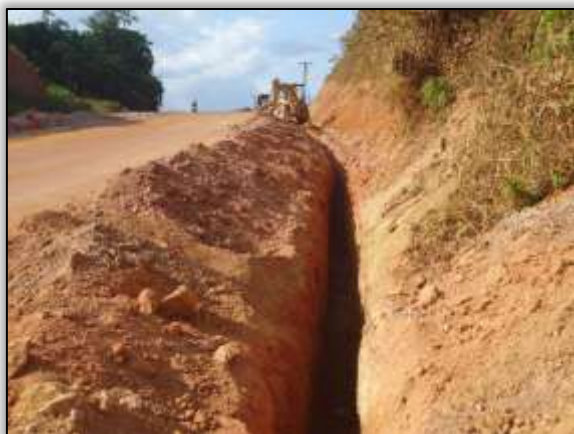
Foto 1342 – Abertura para instalação de dreno profundo. Lado esquerdo. S 04.99738° W 049.44621° 30/06/2014
