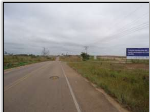
Foto 438 – Entrada para áreas de apoio do canteiro de obras. S 05.14985°W 049.38852° 29/07/2014
