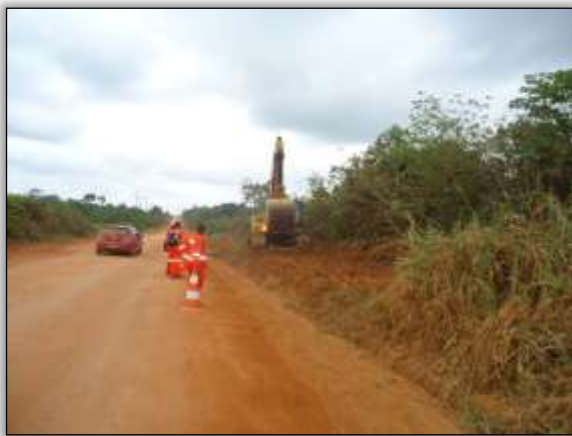
Foto 14 – Limpeza na faixa de domínio. Lado esquerdo. S 05.17602° W 049.37257° 06/01/2014
