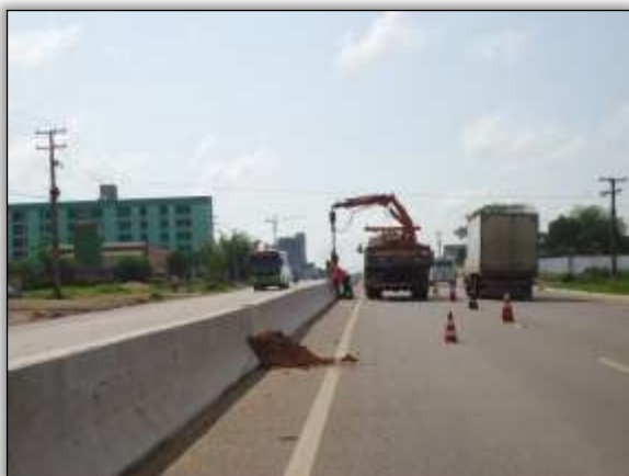
Foto 3- Instalação de iluminação na rodovia. S 05.35075° W 049.10010° 29/10/2013
