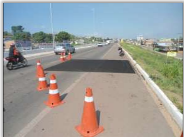
Foto 4 - Instalação de redutores de velocidade. S 05.35052° W 049.10483° 02/10/2013
