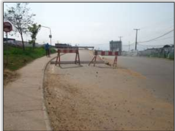
Foto 2- Acesso para Br-230 interditado. S 05.35750° W 049.08872° 30/08/2013
