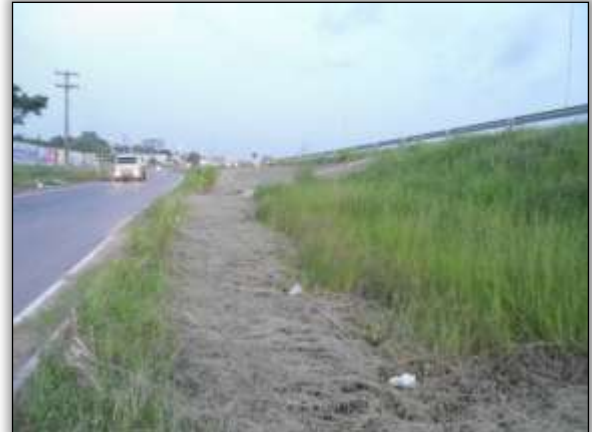
Foto 8 – Talude com revestimento vegetal. Lado esquerdo. S 05.35751° W 049.08878°. 03/12/2013
