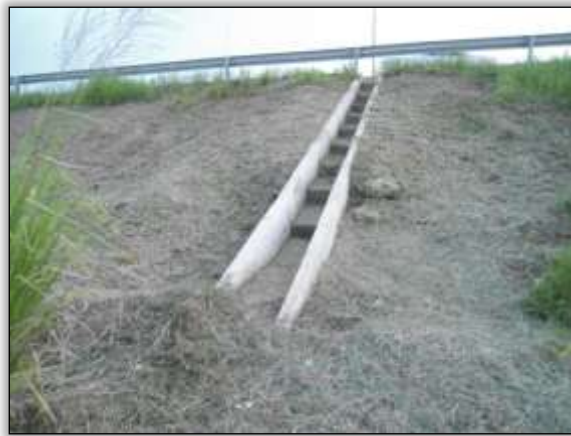
Foto 9 – Descida d'água com dissipador de energia. Lado direito. S 05.35724° W 049.08863. 03/12/2013.
