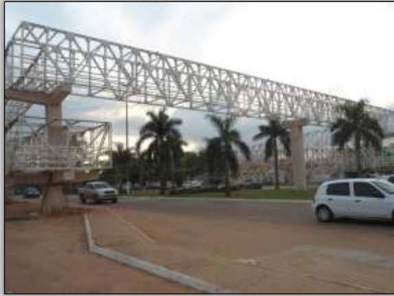
Foto 7 – Implantação de passarela. Ambos os lados. S 05.35750° W 049.08867. 03/12/2013.
