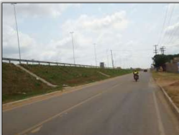
Foto 5 - Revestimento vegetal em talude. S 05.35081° W 049.10607° 28/10/2013
