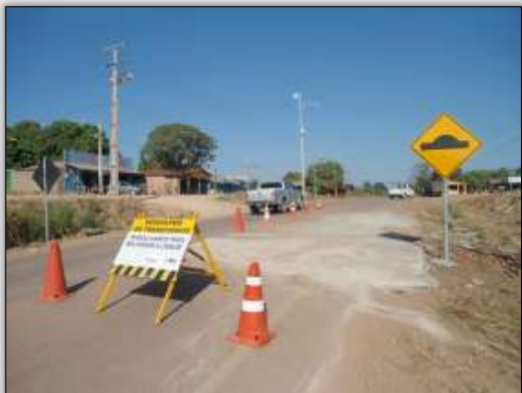
Foto 1– Instalação de Redutor de Velocidade. Lado Direito, S 05.17228° W 049.28856° 21/08/2013
