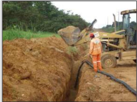
Foto 14 – Material de aterro em dreno longitudinal. Lado esquerdo. S 05.08560° W 049.42741° 21/01/2014
