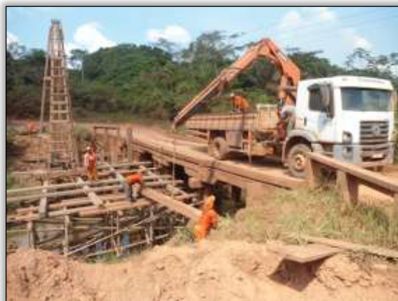
Foto 12 – Conservação de ponte. Eixo. 04.39896° W 049.94005° 10/12/2013
