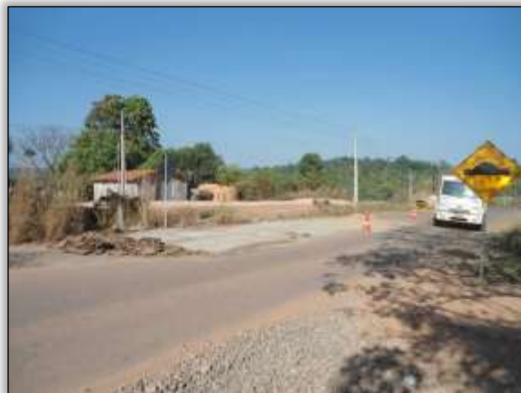
Foto 2 – Instalação de Redutor de Velocidade. Lado Direito, S 05.17228° W 049.28856° 21/08/2013
