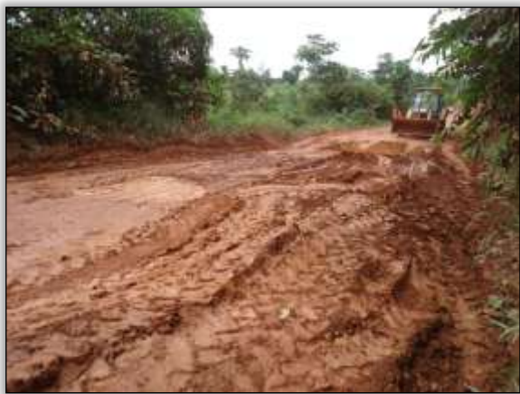
Foto 15 – Recuperação de desnível em rodovia. Eixo. S 04.74596° W 049.63427° 28/01/2014
