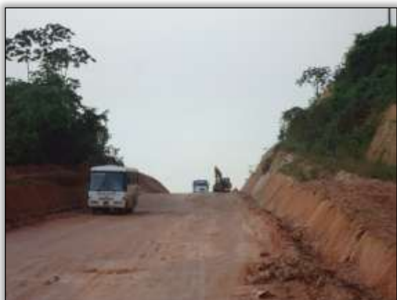
Foto 9 – Atividades de corte na rodovia. S 04.26239° W 049.94836° 04/12/2013
