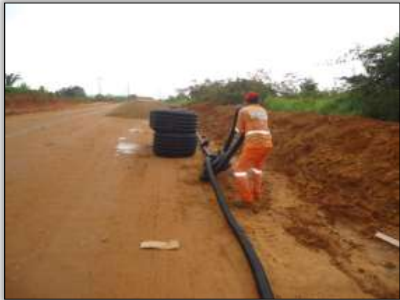
Foto 13 – Alocação de dreno longitudinal. Lado esquerdo. S 05.20109° W 049.35786° 21/01/2014
