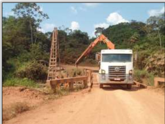
Foto 11 – Conservação de ponte. Eixo. 04.39896° W 049.94005° 10/12/2013
