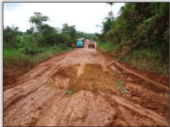
Foto 16 – Recuperação de desnível em rodovia. Eixo. S 04.74596° W 049.63427° 28/01/2014
