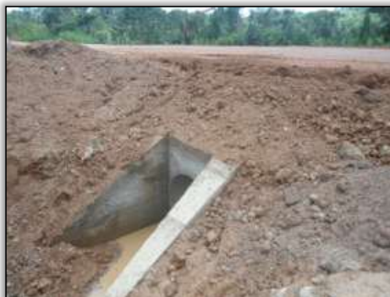
Foto 114 - Bueiro concluído. Estaca 7906. S 03.85446° W 054.13381°. 21/01/2014
