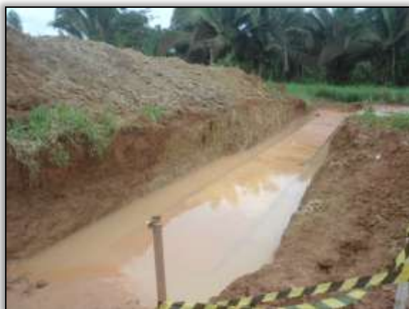
Foto 133 - Bueiro construção. Estaca 9246. S 03.88422° W 054.36125°. 30/01/2014.
