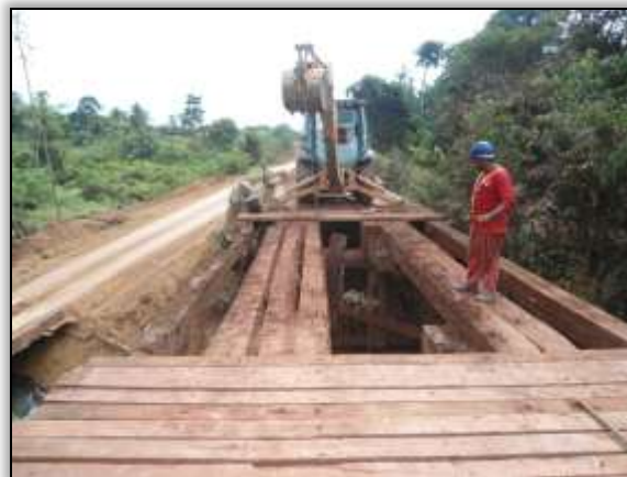
Foto 1 - Substituição de ponte (Ilg. Peruda) Trecho Placas/ Rurópolis. S 04.084350°W054. 838833°. 30/08/2013. Antes
