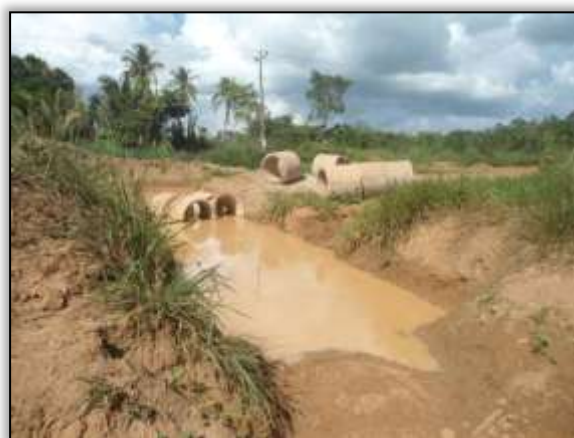
Foto 88 – implantação de bueiro. S 03.85415° W 054.13615° Estaca 7920.18/12/2013.
