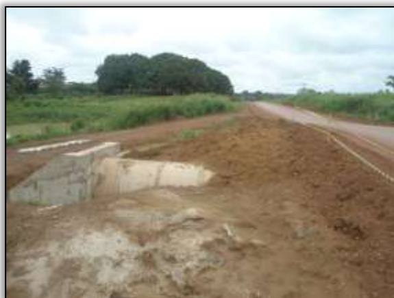
Foto 127 - Bueiro concluído. Estaca 8751. S 03.89060° W 054.27680. 29/01/2014
