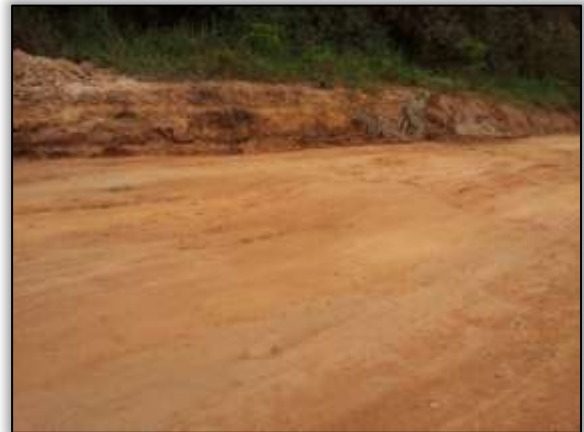
Foto 34 - Pista trafegável. S 03. 61714° W 053.33346° 25/10/2013
