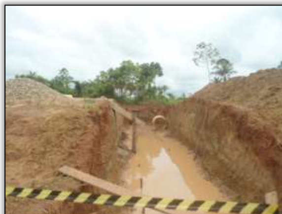
Foto 132 - Construção de bueiro. S 03.88947° W 054.34155°. 30/01/2014.
