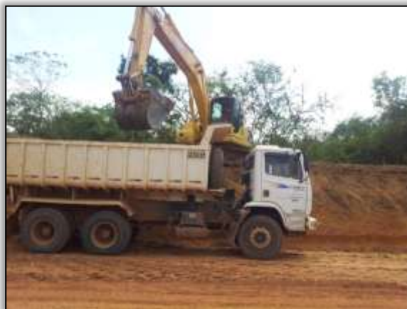
Foto 66 - Corte em talude. Lado esquerdo. Estaca 8763. S 03. 88965° W 054. 27910° 23/10/2013
