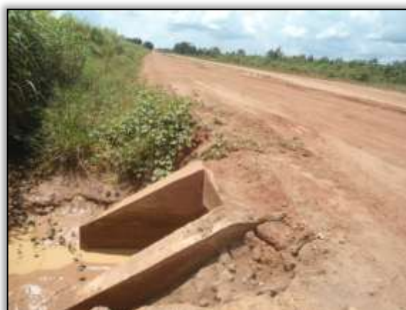
Foto 118 - Bueiro concluído. Estaca 8224. S 03.86076° W 054.18909°. 24/01/2014.
