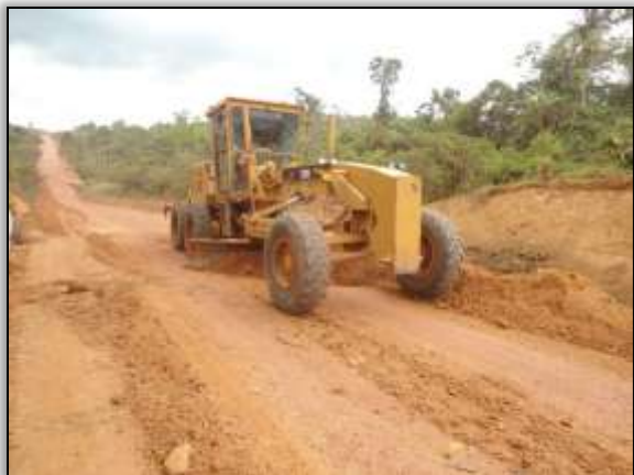
Foto 13 - Reconformação de declive. Trecho Placas/Rurópolis. S 04.08646° W 054.88838°. 30/08/2013.
