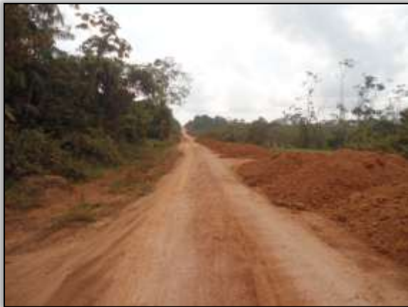
Foto 19 – Pista reconformada. Trecho Placas / Rurópolis. S 03.93107° W 054.59417°. 20/09/2013
