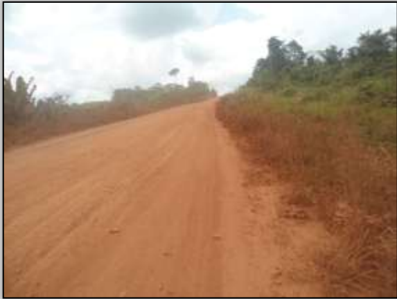
Foto 45 - Buracos em declive. S 03.50314° W 053.07617°. 18/12/2013
