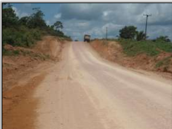
Foto 5 - Declive reconformado. Trecho Uruará /Placas. S 03.84232° W 053.94895°. 21/08/2013.
