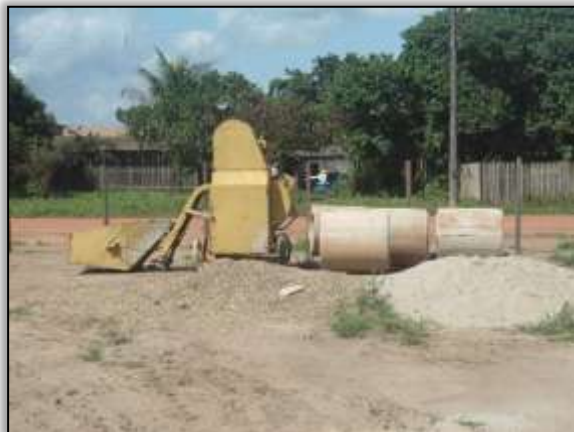
Foto 77 - Construção da fábrica de artefatos. Lado direito. S 03.866167° W 054.211694° 26/11/2013
