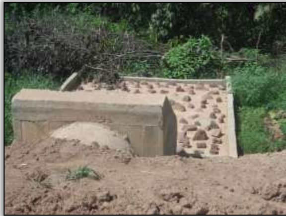
Foto 121 - Bueiro concluído. S 03.87558° W 054.24048°. 24/01/2014.
