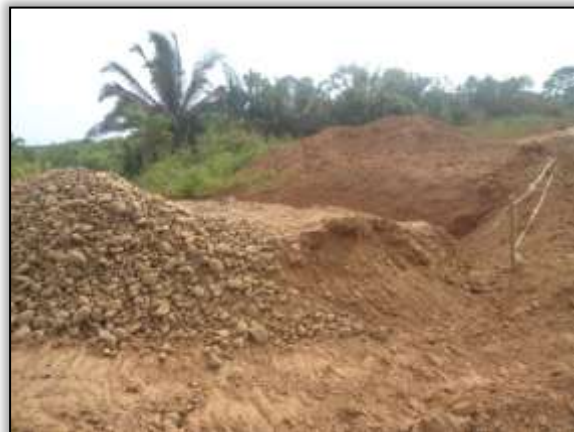
Foto 90 – Construção de bueiro. S 03.85141° W 054.15584°. 18/12/2013.
