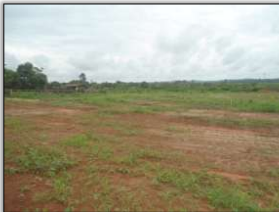
Foto 123 – Área onde será construído o canteiro de obras. Lado esquerdo. Estaca 8471. S 03.87243° W 054.22957°. 17/01/2014
