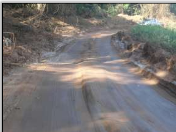
Foto 83 - Caminho de serviço. Lado esquerdo. S 03.89098° W 054.31071° 26/11/2013.
