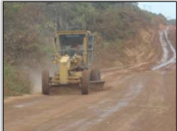
Foto 24 – Máquina fazendo a reconformação da pista. Trecho Placas/ Rurópolis. S 03.91251° W 054.54856°. 20/09/2013.
