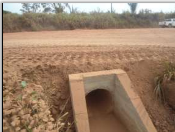
Foto 91 - Bueiro construído. S 03.86106° W 054.18923°. 18/12/2013
