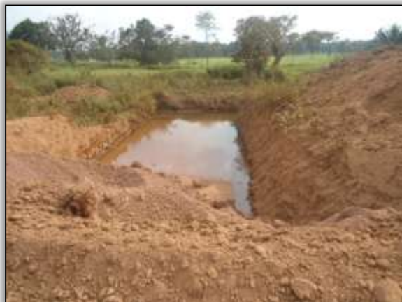
Foto 89 – Construção de bueiro. S 03.85087° W 054.15341°. 18/12/2013.
