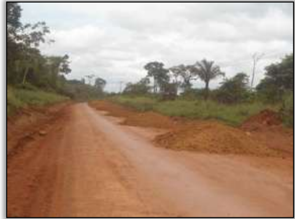
Foto 51 - Terraplenagem. S 03.61267° W 053.30700° 24/01/2014
