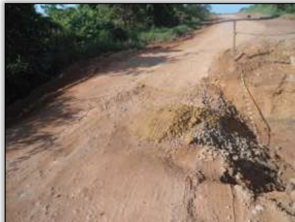
Foto 86 - Caminho de serviço. Lado esquerdo. Estaca 8671. S 03.88644° W 054.26514°. 26/11/2013
