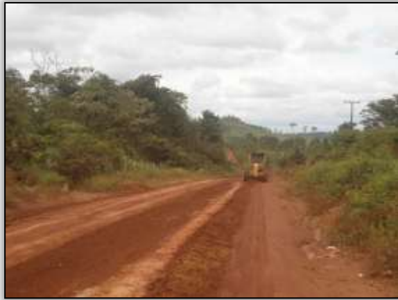
Foto 50 - Conservação da rodovia. S 03.60304° W 053.25818° 24/01/2014
