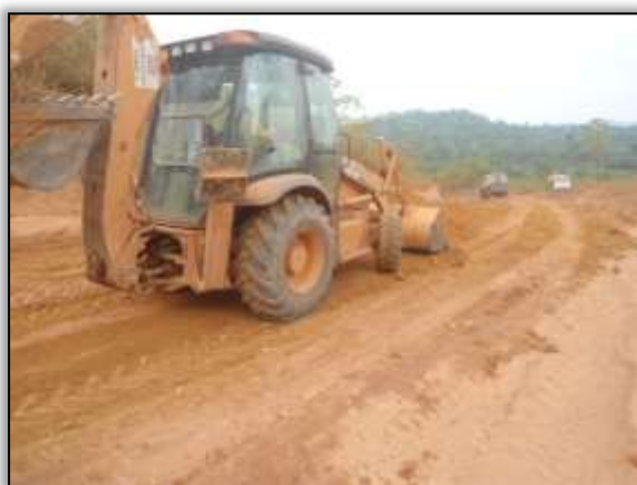
Foto 87 - Reconformação de buracos. S 03.76812° W 053.86707°. 18/12/2013
