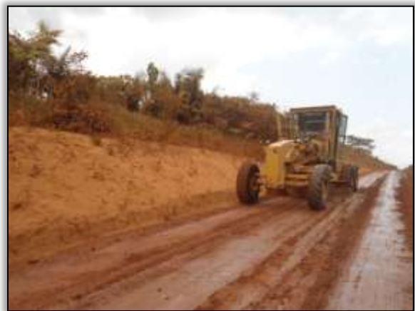
Foto 22 – Máquina na pista. Trecho Placas/ Rurópolis. S 03.91031° W 054. 54482°. 20/09/2013.
