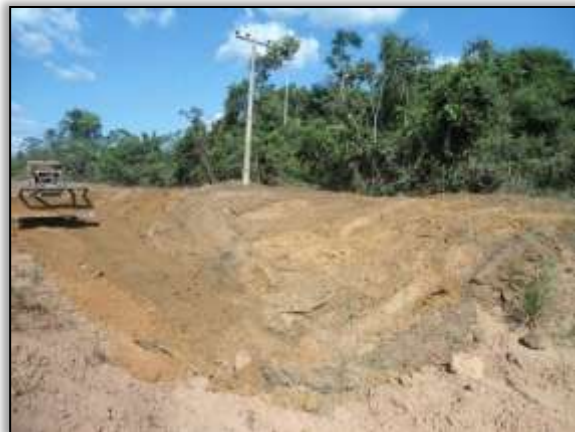
Foto 8 - Máquina fazendo reconformação de área de empréstimo. Lado esquerdo. Trecho Placas/Rurópolis. S 03.88787° W 054.32186°. 21/08/2013.
