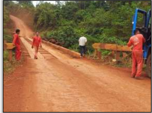
Foto 30 - Reforma da ponte do igarapé lajeado. S 03.49542° W 052.98054° 31/10/2013
