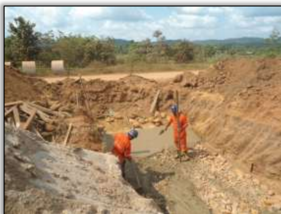
Foto 58 - Construção de bueiro. S 03.86237° W 054.19567° 17/10/2013.
