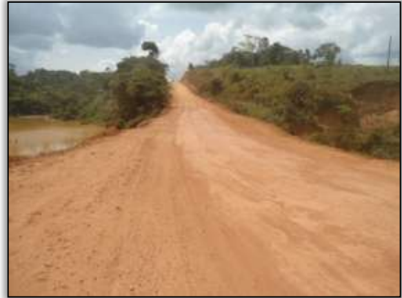
Foto 46 - Reconformação de erosão. Lado direito. S 03.50088° W 053.11529°. 18/12/2013.
