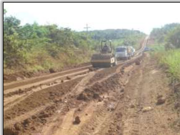
Foto 12 - Rolo fazendo a compactação da pista. Trecho Placas/Rurópolis. S 03.89370° W 054.47784°. 21/08/2013.
