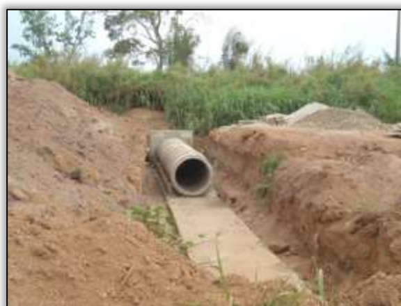
Foto 70 – Construção de bueiro. S 03.86090° W 054.18923° 11/11/2013.
