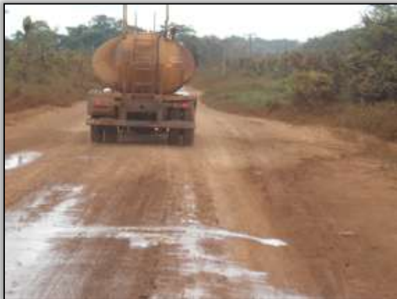
Foto 23 – Aspersão de água na pista para controle de poeira e auxílio na terraplanagem. Trecho Placas/Rurópolis S 03.91031° W 054. 54482°. 20/09/2013.
