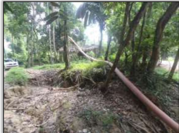
Foto 108 - Retirada de areia. Lado esquerdo. S03. 90013° W 054.27929°. 17/01/2014.
