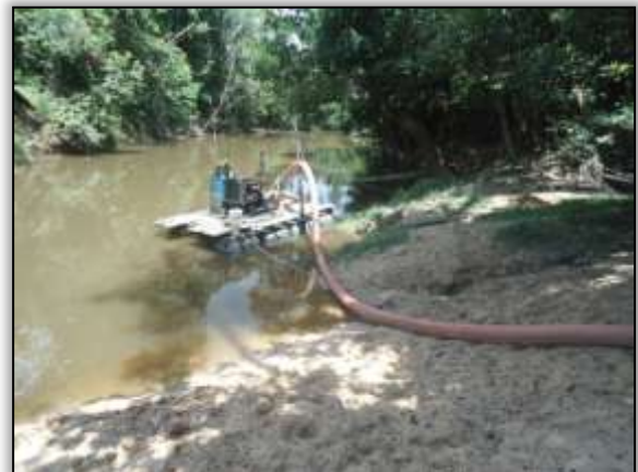
Foto 78 - Retirada de areia. Lado esquerdo. S 03.90013° W 054.27929° 02/12/2013.
