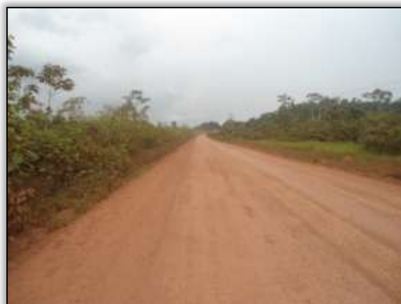
Foto 43 - Pista reconformada. S 03. 67951° W 053.55683°. 28/11/2013.
