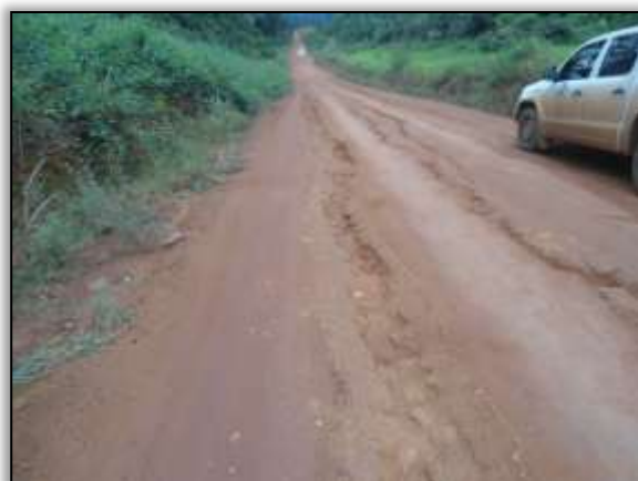
Foto 57 - Valas no corpo estradal da rodovia. S 03.55898° W 053.19400° 29/01/2014
