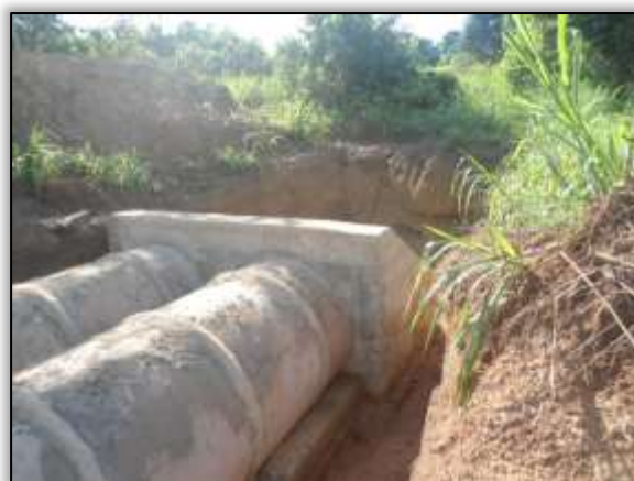
Foto 72 – Construção de bueiro. S 03.87593° W 054.24310° 26/11/2013.
