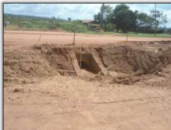
Foto 120 - Bueiro concluído. S 03.87191° W 054.22857°. 24/01/2014
