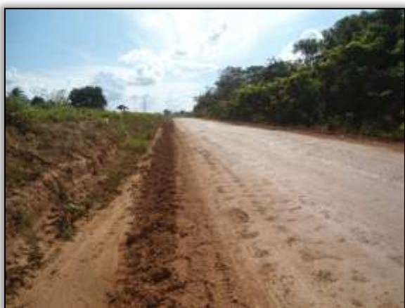
Foto 9 - Pista reconformada. Trecho Placas/ Rurópolis. S 03.89192° W 054.33269° 21/08/2013. Depois
