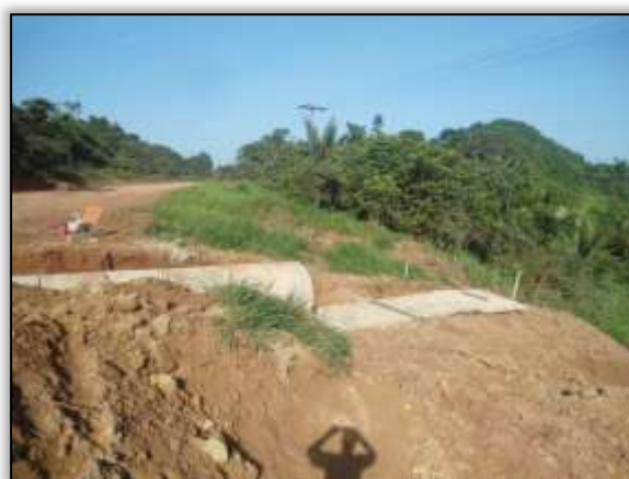
Foto 82 - Construção de bueiro. S 03.89098° W 054.31071° 26/11/2013.
