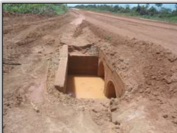
Foto 119 - Bueiro concluído. S 03.86229° W 054.19547°. 24/01/2014.
