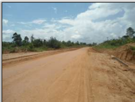
Foto 115 - Bueiro concluído. Estaca 7920. S 03.85407° W 054.13626°. 24/01/2014.
