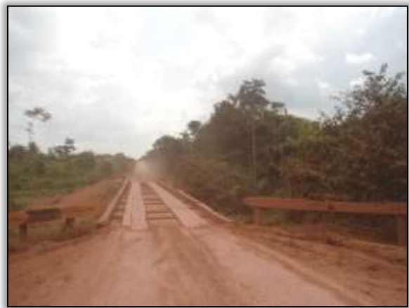
Foto 28 – Ponte substituída (Ilg. Peruda) Trecho Placas/ Rurópolis. S 04.084350° W054. 838833°. 20/09/2013.
