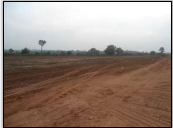
Foto 98 - Limpeza para a implantação do canteiro de obra. Lado esquerdo. Estaca 8471. S 03.87243° W 054.22957°. 18/12/2013
