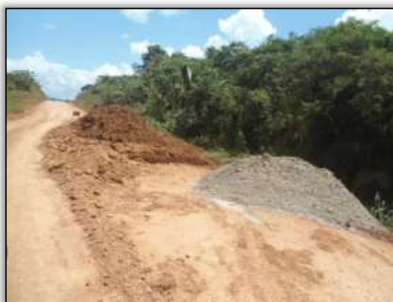
Foto 112 - Escavação para construção de bueiro de bueiro. S 03.86268° W 054.09820°. 21/01/2014.
