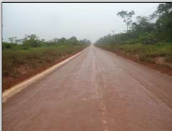
Foto 44 - Pista reconformada. S 03.69201° W 053.60104°. 28/11/2013.
