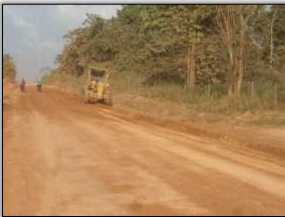
Foto 27 – Reconformação da pista. Trecho Medicilândia/ Uruará. S 03.70600° W 053.69453°. 27/09/2013
