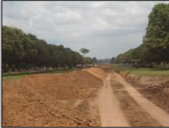
Foto 62 – Terraplenagem na zona urbana de Placas. Estaca 8364. S 03. 86700° W 054. 21354° 23/10/2013.
