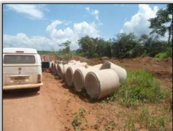
Foto 111 - Implantação de bueiro. Estaca 7680. S 03.86258° W 054.09551°. 21/01/2014.
