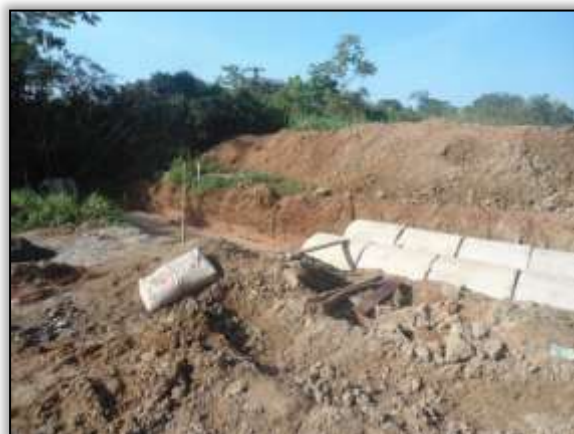
Foto 84 - Construção de bueiro. S 03.88807° W 054.29888° 26/11/2013.
