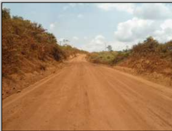
Foto 21 – - Pista reconformada Trecho Placas/ Rurópolis. S 03.91629° W 054.55464°. 20/09/2013.
