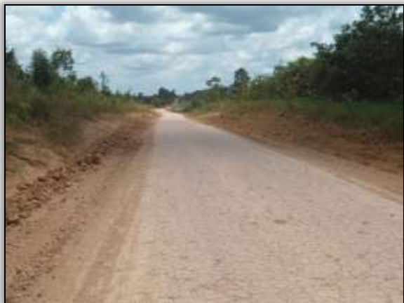
Foto 7 - Pista reconformada. Trecho Uruará/ Placas. S 03.85433° W 054.13504°. 21/082013. Depois.
