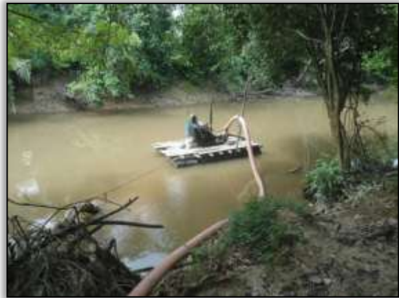
Foto 105 - Retirada de areia. Lado esquerdo. S03. 90013° W 054.27929°. 30/12/2013.
