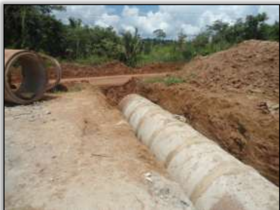
Foto 113 - Implantação de bueiro. S 03.85787° W 054.11796°. 21/01/2014.
