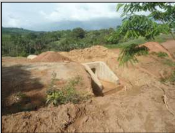
Foto 99 - Construção de bueiro. Estaca 8950. S 03.89117° W 054.31134°. 27/12/2013.
