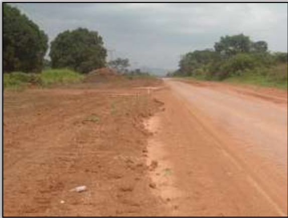
Foto 103 - Foto 104 - Limpeza na faixa de domínio. Lado direito. Estaca 8653. S 03.88486° W 054.26210°. 30/12/2013.
