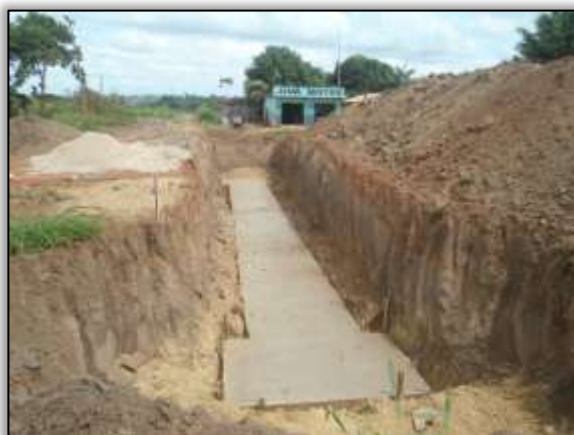
Foto 60 - Construção de bueiro. S 03.87025° W 054.22191° 13/10/2013.
