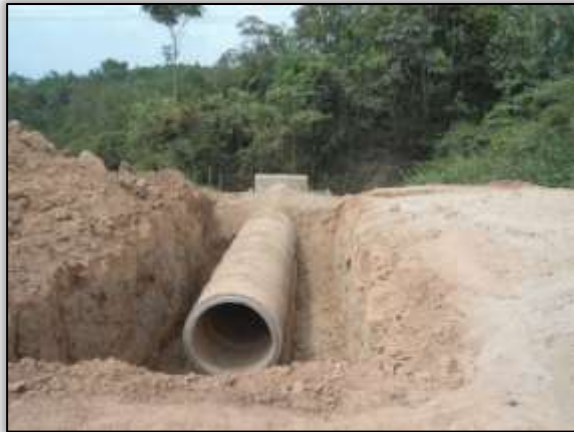
Foto 73 – Implantação de bueiro. S 03.87565 W 054.24110° 11/11/2013.
