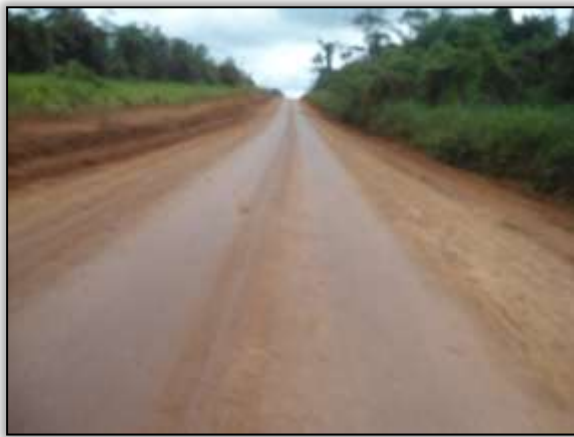
Foto 52 - Pista reconformada. S 03.61370° W 053.31116° 24/01/2014
