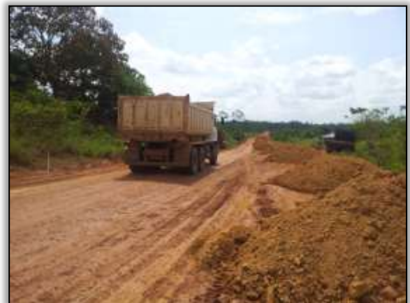
Foto 67 - Terraplenagem. Estaca 8773. S 03. 88901° W 054. 28034° 23/10/2013.
