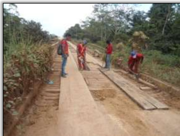
Foto 18 - Reforma da ponte Igarapé Macanã. Trecho Placas / Rurópolis. S 03.93110 W 054.59456. 20/09/2013.
