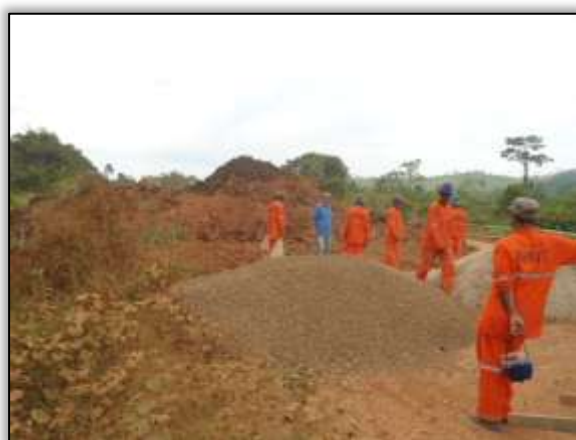
Foto 69 – Construção de bueiro. S 03.85095° W 054.15302° 11/11/2013.
