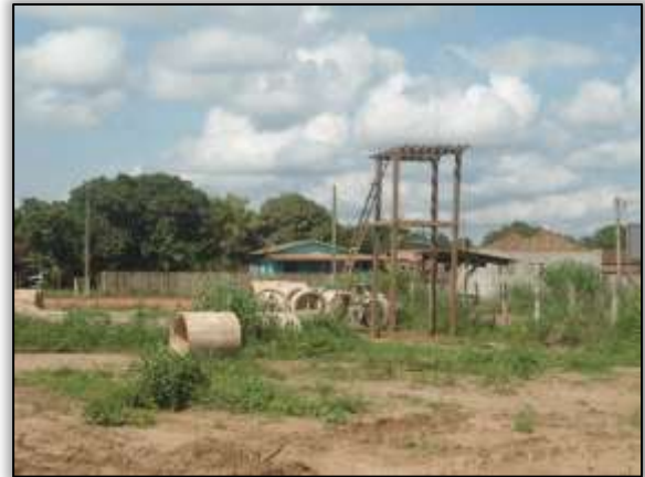
Foto 74 Construção da fábrica de artefatos. Lado direito. S 03.866167° W 054.211694° 26/11/2013
