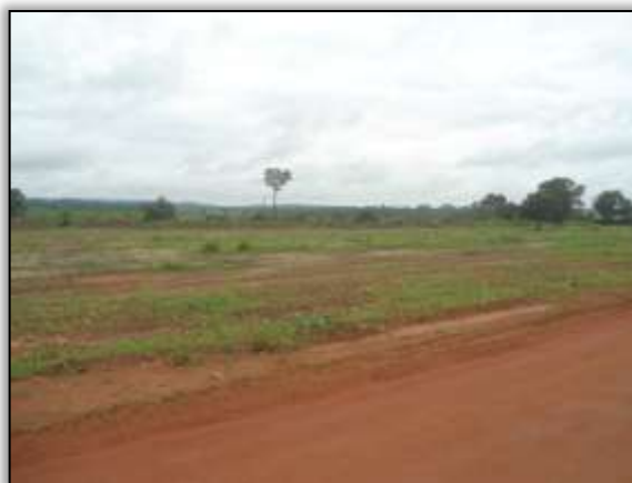
Foto 110 - Área onde será construído o canteiro de obras. Lado esquerdo. Estaca 8471. S 03.87243° W 054.22957°. 17/01/2014
