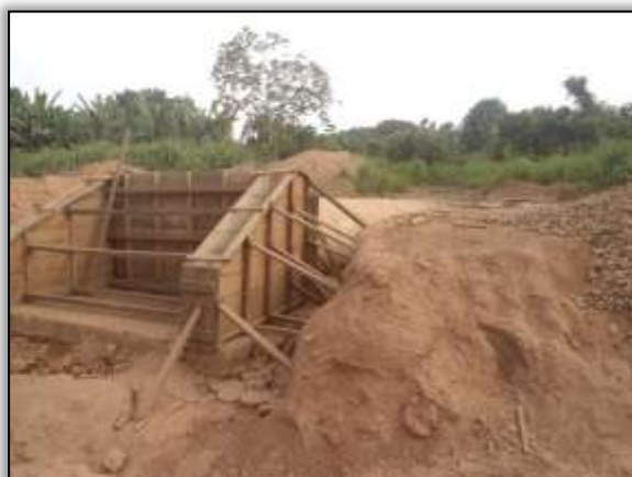
Foto 95 - Construção de bueiro. S 03.87603° W 054.24352°. 18/12/2013.
