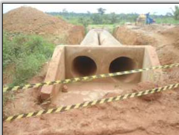
Foto 131 - Bueiro em construção. S 03.89170° W 054.33467°. 29/01/2014.
