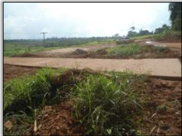
Foto 100 - Bueiro. S 03.89171° W 054.33097°. 27/12/2013.
