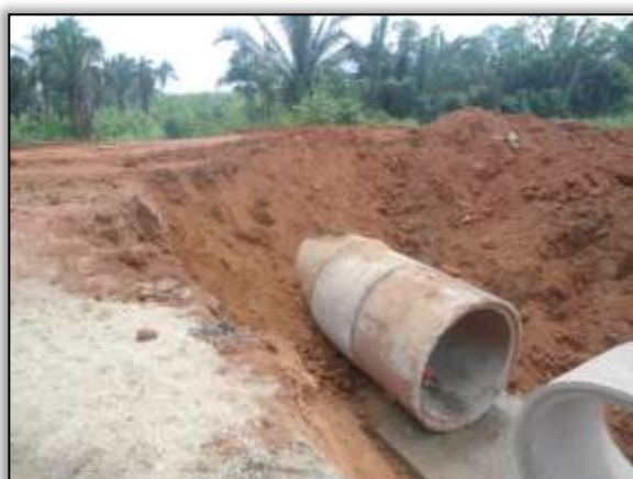
Foto 117 - Implantação de bueiro. S 03.85133° W 054.15569°. 24/01/2014.
