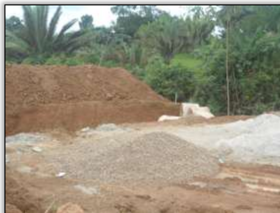
Foto 134 - Construção de bueiro. S 03.88794° W 054.39463°. 30/01/2014.
