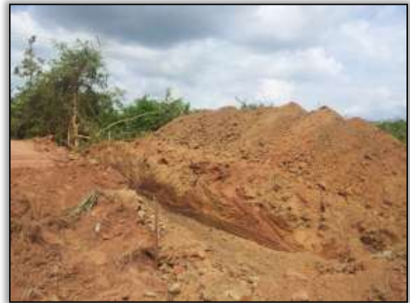
Foto 65 – Construção de bueiro. S 03.89094° W 054. 27748° 23/10/2013.
