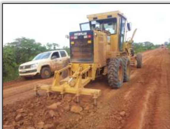
Foto 68 – Terraplenagem. Estaca 8786. S 03. 88940° W 054. 28294° 23/10/2013.
