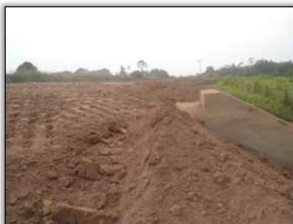
Foto 94 - Bueiro concluído. S 03.87243° W 054.22957°. 18/12/2013. Depois
