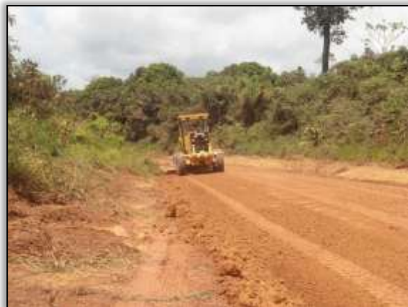
Foto 2 - Máquina fazendo reconformação da rodovia. Trecho Placas/Rurópolis. S 03.89098° W 054.31249° 19/08/2013.
