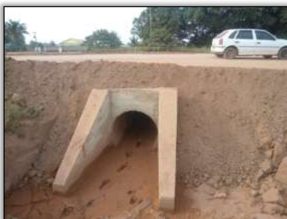
Foto 93 - Bueiro concluído. S 03.87206° W 054.22840°. 18/12/2013.
