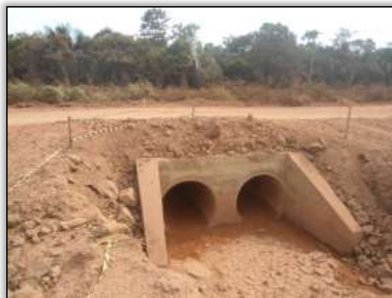
Foto 92 - Bueiro construído. S 03.86231° W054.19566°. 18/12/2013.
