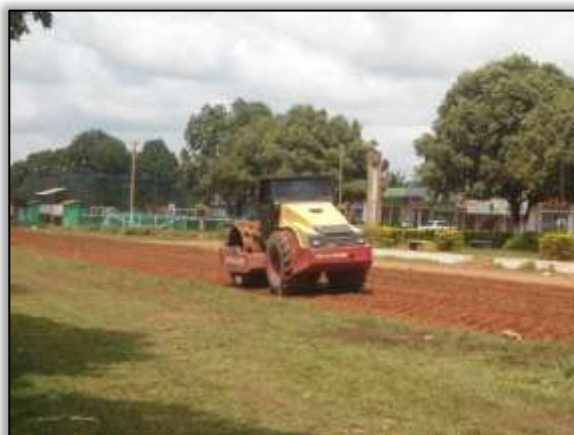
Foto 61 - Terraplenagem na zona urbana de Placas. Estaca 8380. S 03.86808° W 054.21615° 23/10/2013.
