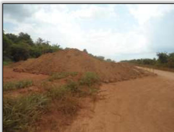
Foto 71 Construção de bueiro. S 03.86237° W 054. 19567° 11/11/2013.
