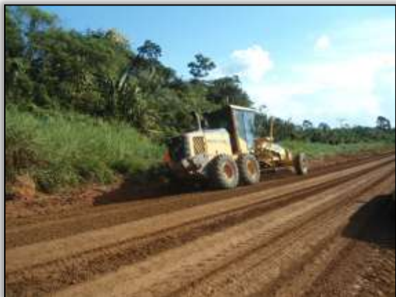
Foto 11 - Máquina fazendo a reconformação da rodovia. Trecho Placas/ Rurópolis. S 03.89249° W 054.46663°. 21/08/2013.
