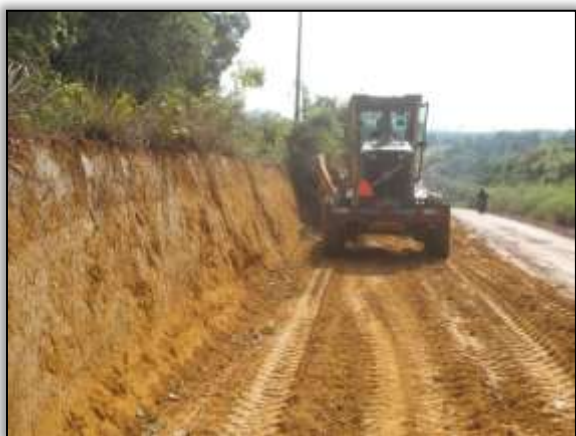
Foto 15 - Máquinas na pista fazendo reconformação de declive. Trecho Placas/Rurópolis. S 04.08965° W 054.90034°. 31/08/2013
