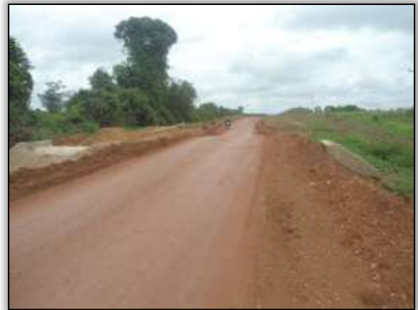
Foto 126 - Bueiro concluído. Estaca 8673. S 03.88625° W 054.26497°. 29/01/2014.
