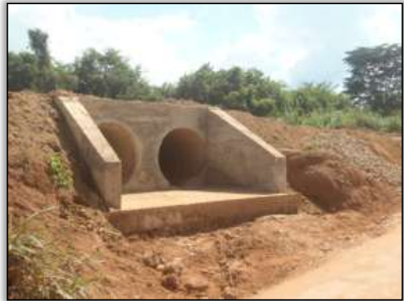
Foto 122 - Bueiro concluído. S 03.87590° W 054.24349°. 24/01/2014.
