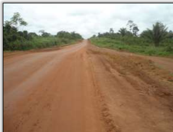
Foto 128 - Bueiro concluído. S 03.88804° W 054.29916°. 29/01/2014.
