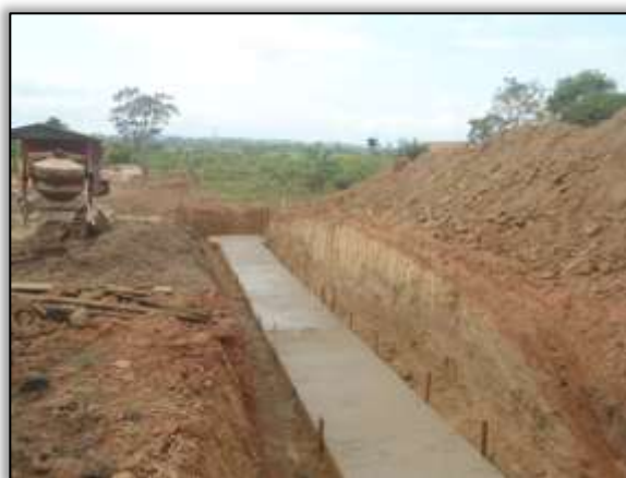
Foto 59 - Construção de bueiro. S 03.87207° W 054.22810° 23/10/2013.
