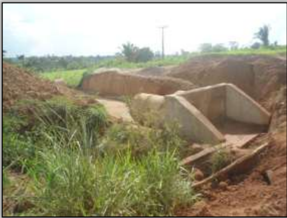
Foto 101 - Construção de bueiro. S 03.89175° W 054.33456°. 27/12/2013
