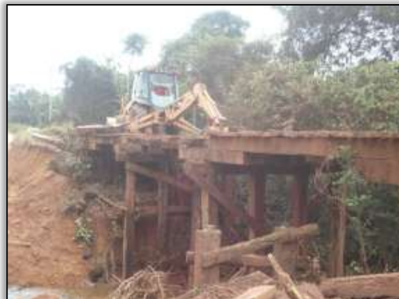
Foto 14 - Reforma de ponte (lg. Peruda) Trecho Placas/Rurópolis. S 04.08435° W 054.83883°. 30/08/2013.
