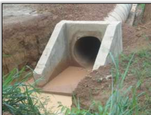
Foto 129 - Bueiro em construção. Estaca 8948. S 03.89120° W 054.31135°. 29/01/2014.
