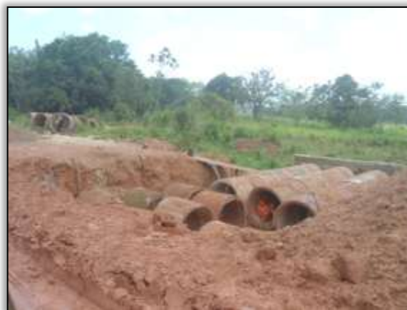
Foto 116 - Implantação de bueiro. S 03.85084° W 054.15321°. 24/01/2014.
