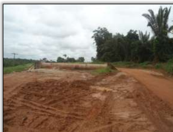
Foto 130 - Bueiro concluído. S 03.89171° W 054.33133°. 29/01/2014.
