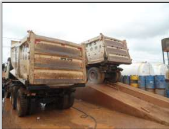
Foto 98 – Canteiro de obra. Lado esquerdo. Estaca 1827. S 03.30872° W 052.53631° 13/11/2013.
