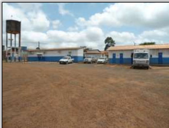
Foto 34 – Canteiro de obra. Lado esquerdo. Estaca 1827. S 03.30872° W 052. 53631 17/09/2013.
