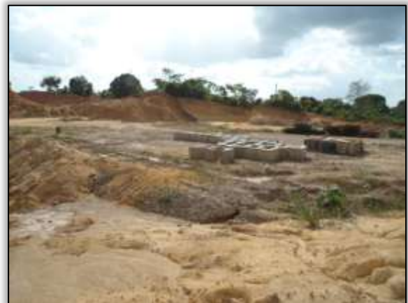
Foto 35 – Construção de concreto. Lado direito. Estaca 2432. S 03.35695° W 052.62812 17/09/2013.
