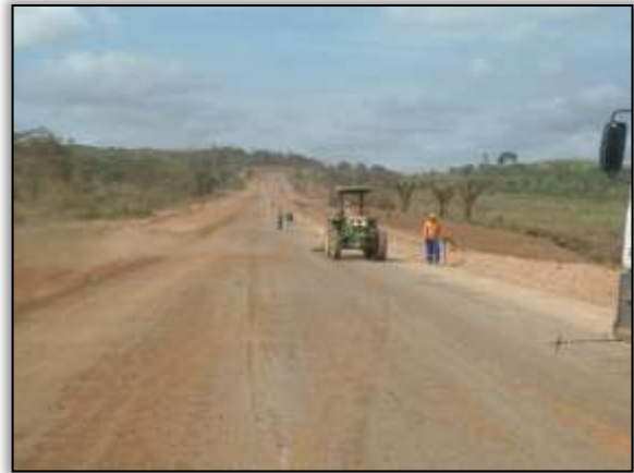
Foto 85 - Limpeza para aplicação de asfalto. Estaca 2108 a 2132. S 03.33117° W 052.58248° 17/10/2013.
