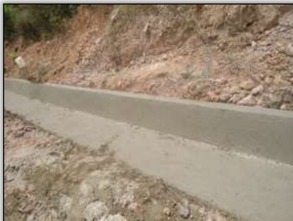
Foto 58 – Construção de valeta. Lado direito. Estaca 2564 S 03. 36999° W 052. 65012° 27/09/2013.
