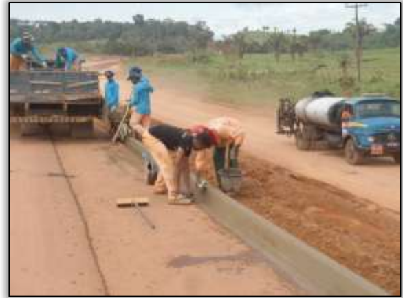
Foto 127 – Construção de meio fio. Lado direito. Estaca 2827. S 03.38815° W 052.69304° 28/11/2013.
