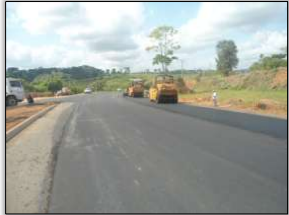
Foto 139 – Conclusão da pavimentação do trevo da vicinal 11. Lado esquerdo. S 03.29511° W 052.48823° 17/12/2013.
