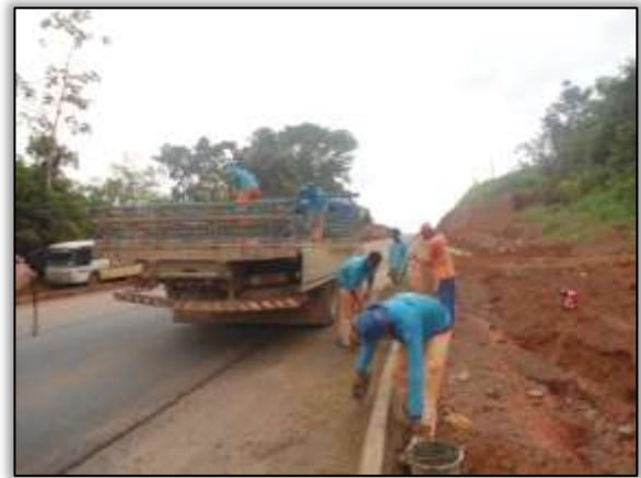
Foto 117 – Construção de meio fio. Lado esquerdo. S 03.39028° W 052.71560° 20/11/2013.
