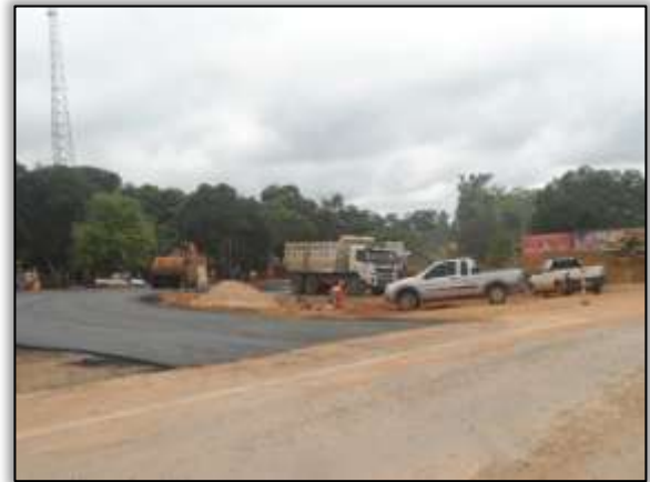
Foto 119 – Pavimentação do trevo na vicinal 11. Lado esquerdo. S 03.29595° W 052.48883° 20/11/2013.
