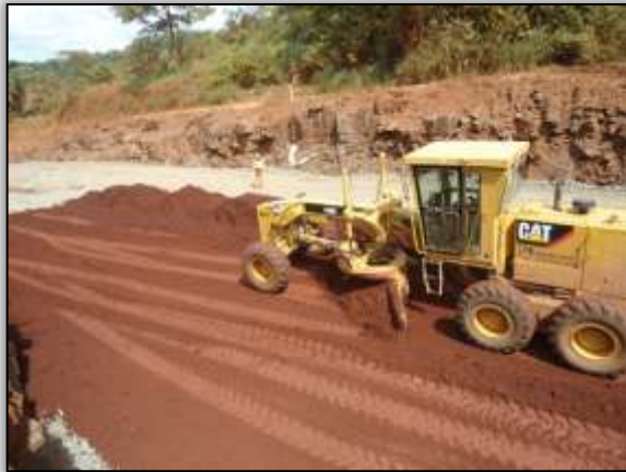
Foto 31– Terraplanagem. estaca 3775. S 03.44206° W 052. 85213°. 20/08/2013.
