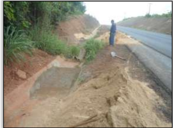
Foto 151– Construção de drenagem. Lado esquerdo. S 03.35649° W 052.62665° 17/12/2013.
