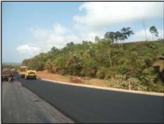
Foto 90 - Segunda camada de asfalto. Estaca 1885. S 03. 30814° W 052. 54790° 23/03/2013.
