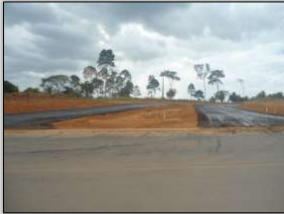
Foto 120 – Aplicação de piche na entrada da vicinal 12. Lado direito. S 03.28687° W 052.48946° 19/11/2013
