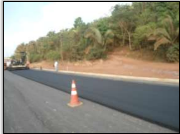
Foto 91 - Segunda camada de asfalto. S 03. 31051° W 052. 54897° 23/10/2013.
