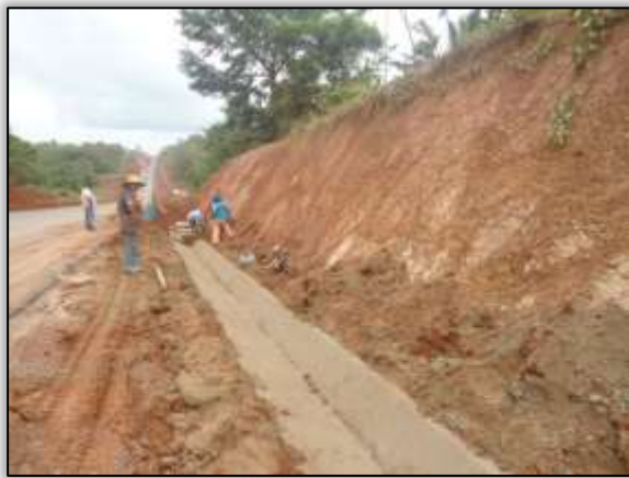
Foto 116 – Construção de valeta. Lado esquerdo. S 03.39035° W 052.71671° 20/11/2013.
