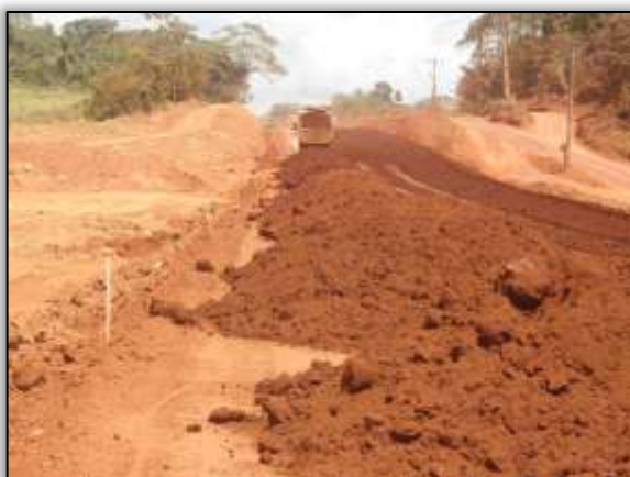
Foto 13 - Máquina fazendo terraplenagem. Estaca 3619. S 03. 43696° W 052. 82394° 14/08/2013
