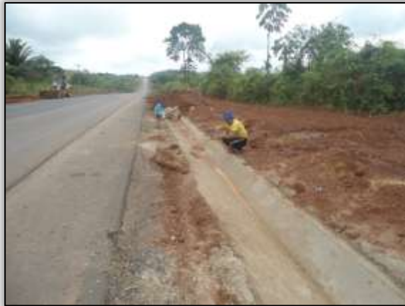
Foto 162 – Construção de valeta. Lado esquerdo. Estaca 2241. S 03.34256° W 052.59921° 27/12/2013.
