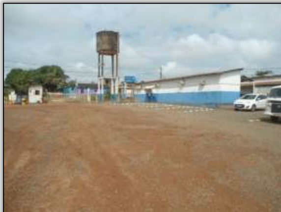
Foto 164 - Canteiro de obra. Lado esquerdo. Estaca 1827. S 03.30872° W 052.53631° 28/01/2014
