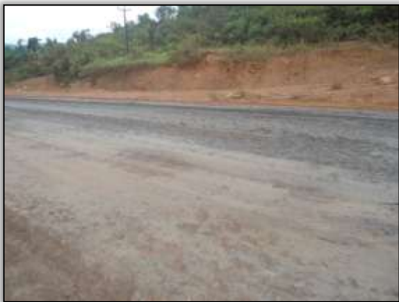
Foto 74 - Imprimação. Estaca 2021. S 03.31917° W 052.56637°. 10/10/2013.
