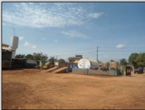
Foto 134 – Canteiro de obra. Lado esquerdo. Estaca 1827. S 03.30872° W 052.53631° 17/12/2013.
