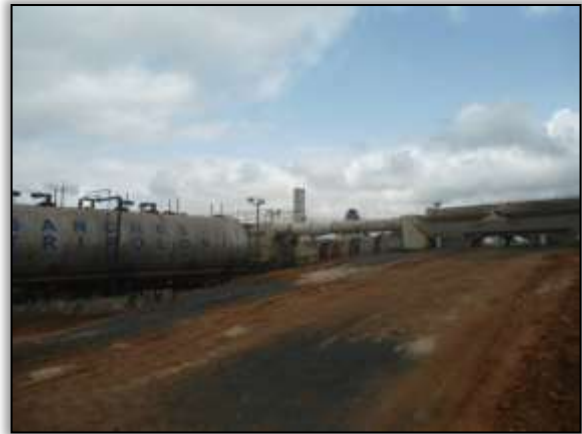
Foto 61 - Usina de asfalto. Estaca 1880. Lado direito. S 03. 30814° W 052. 54790° 10/10/2013.
