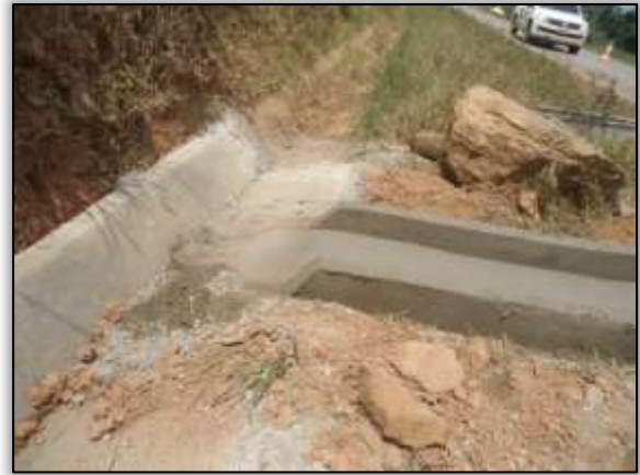
Foto 55 – Descida de água. Lado direito. Estaca 2557. S 03. 36918° W 052. 64856° 27/09/2013.
