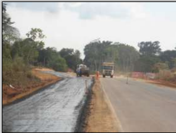
Foto 118 - Aplicação de piche na entrada da vicinal 11. Lado esquerdo. S 03.29595° W 052.48883° 19/11/2013.
