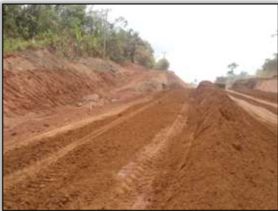
Foto 80 – Serviços de terraplenagem. Estaca 2943. S 03.39023° W 052.71381°. 10/10/2013.
