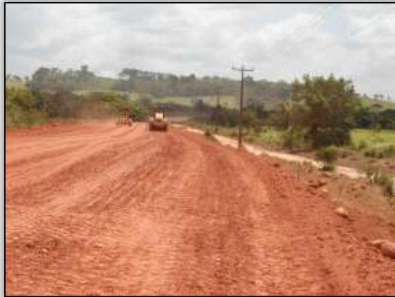
Foto 48 – Terraplanagem. Estaca 2803. S 03.38657° W 052.68878° 17/09/2013.
