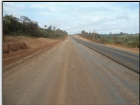
Foto 83 - Pavimentação da pista. Estaca 2108 a 2132. S 03.33117° W 052.58248° 17/10/2013.
