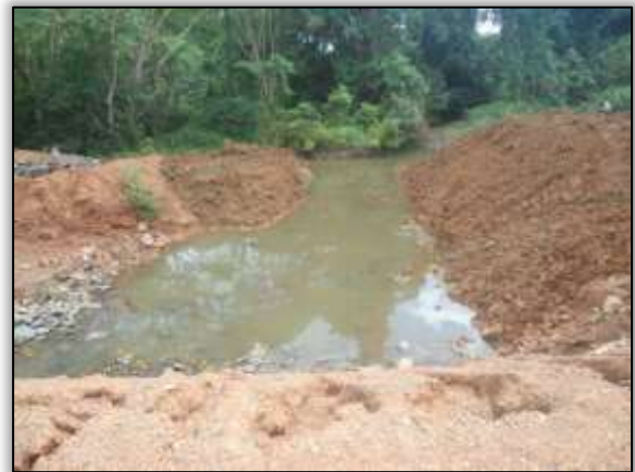
Foto 141 – Desobstrução da galeria capará. Estaca 3322. S 03.41224° W 052.77803° 17/12/2013.
