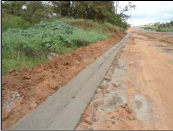
Foto 19 - Construção de drenagem. Lado esquerdo. Estaca 1794. S 03. 30709° W 052. 53133° 20/08/2013.
