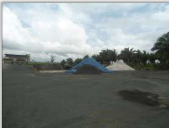
Foto 166 - Usina de asfalto. Lado direito. Estaca 1880. S 03.30814° W 052.54790° 23/01/2014
