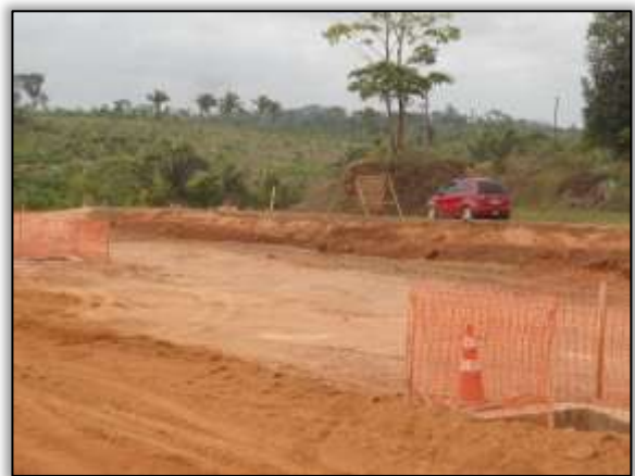
Foto 105 – Construção do trevo na entrada da vicinal 11. Lado esquerdo. S 03.29595° W 052.48883° 13/11/2013.
