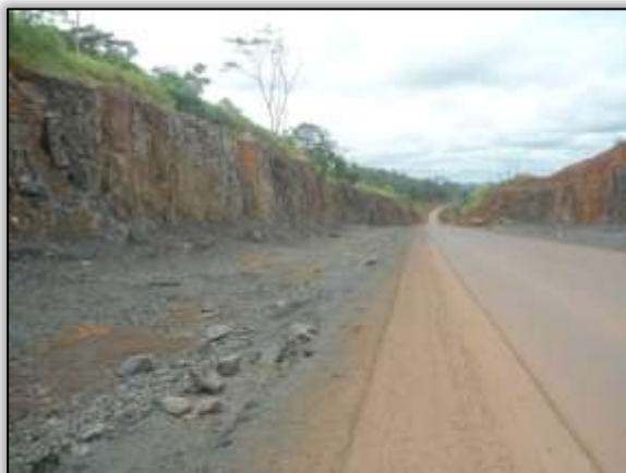
Foto 170 - Pedreira. Estaca 3740. S 03. 44180° W 052. 84491° 28/01/2014
