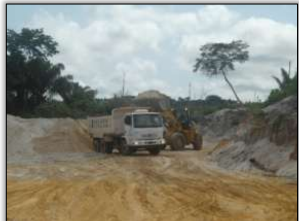
Foto 41 – Areal Campina. Lado esquerdo. Estaca 1837. S 03. 36819° W 052. 50527° 27/09/2013.
