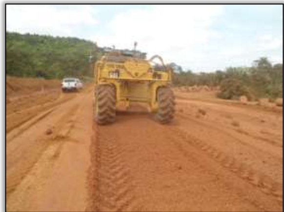
Foto 87 - Máquina recicladora na pista. Estaca 3532. S 03.42967° W 052.81073° . 17/10/2013.
