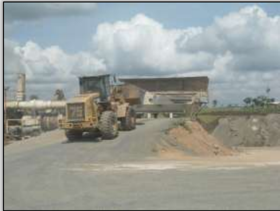
Foto 132– Usina de asfalto. Lado direito. Estaca 1880. S 03.30814° W 052.54790° 17/11/2013.
