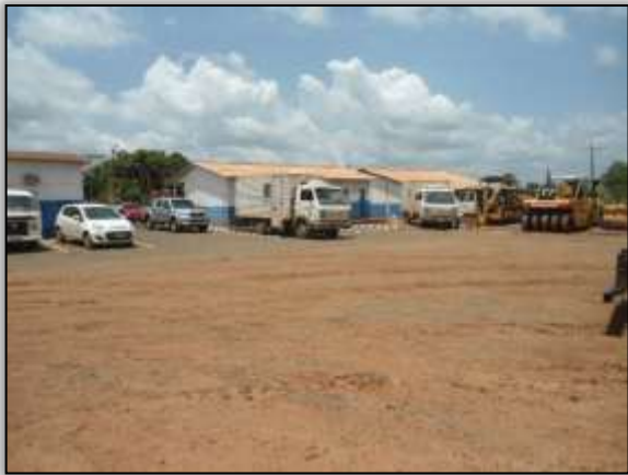
Foto 60 - Canteiro de obra. Lado esquerdo. Estaca 1827. S 03.30872° W 052. 53631 10/10/2013.
