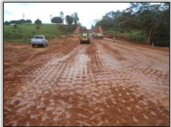
Foto 10 - Compactação do solo. Estaca 3321. S 03. 41170° W 052. 77778° 14/08/2013
