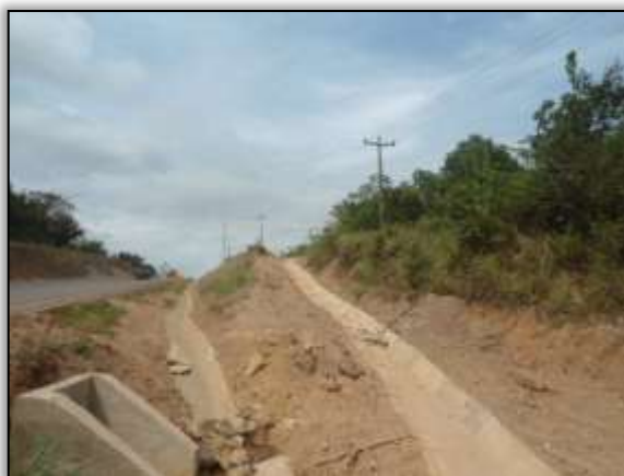
Foto 180 - Valetas de proteção concluída. Lado direito. Estaca 2413. S 03.35632° W 052.62643° 23/01/2014
