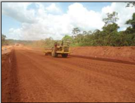
Foto 27 – Rolo compactando. Estaca 3645. S 03. 43803° W 052. 82837° 20/08/2013.
