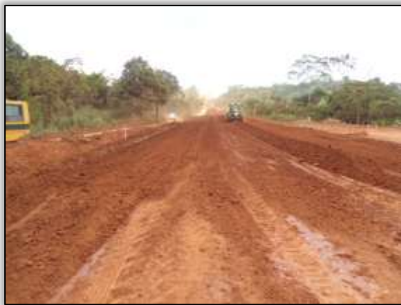
Foto 50 – Terraplanagem. Estaca 3682. S 03.43962° W 052.83486° 17/09/2013.
