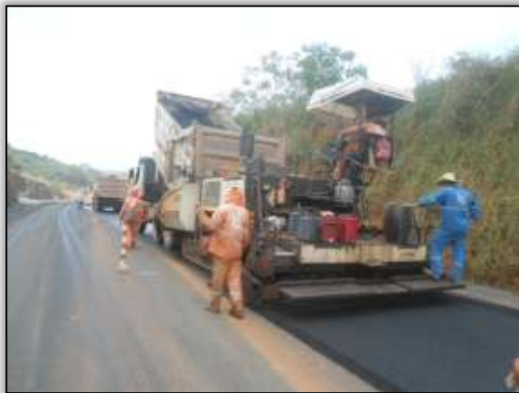
Foto 140- Segunda camada asfáltica. Estaca 3702. S 03.44061° W 052.83834° 18/12/2013.
