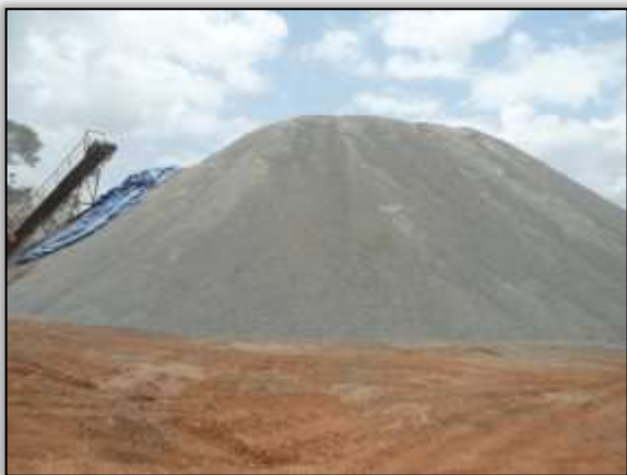
Foto 62 - Armazenamento de brita. Lado direito. Estaca 3775. S 03.44206° W 052. 85213° 10/10/2013
