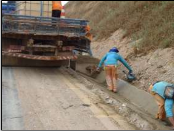
Foto 156 – Construção de valeta. Lado direito. Estaca 1586. S 03.29901° W 052.49601° 13/12/2013.
