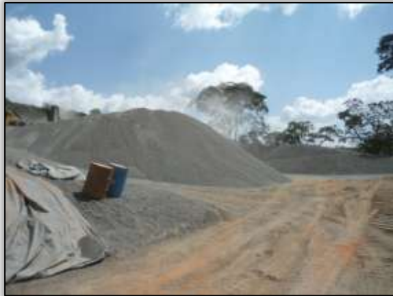
Foto 36 – Britador Sanches Tripoloni. Lado direito. Estaca 3775. S 03.44206° W 052. 85213° 17/09/2013.
