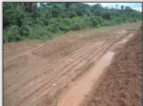
Foto 173 - Revegetação no caminho de serviços. Lado direito. Estaca 2028. S 03. 32080° W 052. 56928° 28/01/2014
