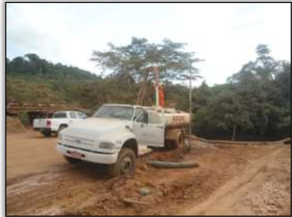
Foto 73 - Captação de água Igarapé Arrependido. Lado esquerdo. S 03.32021° W 052.56824°. 27/09/2013
