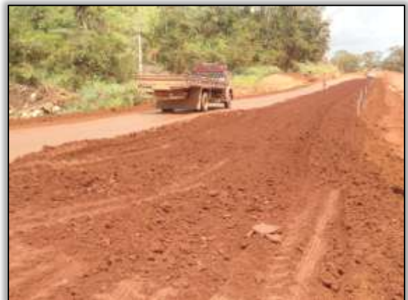
Foto 12 - Gradiando o solo. Estaca 3535. Lado direito. S 03. 42988° W 052. 81137° 14/08/2013
