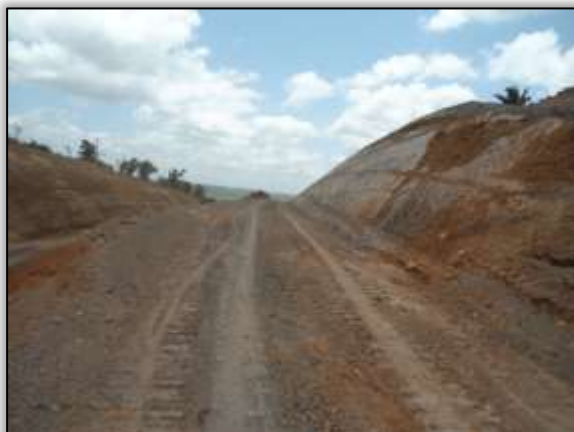
Foto 46 – Corte e construção de banquetas. Lado direito. Estaca 2665. S 03.37709° W 052.66370° 17/09/2013.
