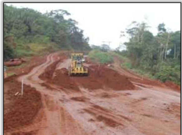
Foto 107 – Terraplanagem. Estaca 3754. S 03.44230° W 052.84764° 13/11/2013.
