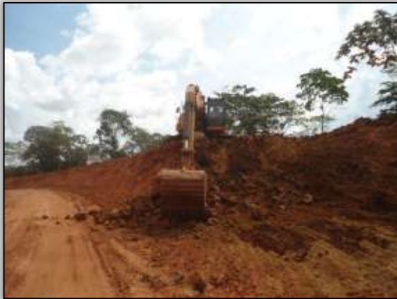
Foto 25 – Corte em talude. Lado direito. Estaca 3549. S 03. 43055° W 052. 81358° 20/08/2013.
