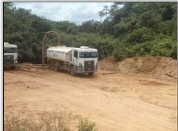
Foto 45 – Captação de água igarapé Arrependido. Lado esquerdo. S 03. 32021° W 052. 56824° 27/09/2013.
