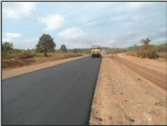
Foto 84 Compactação da pista. Estaca 2108 á 2132. S 03.33117° W 052.58248° 17/10/2013.
