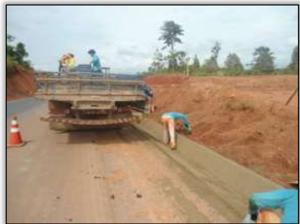
Foto 179 - Construção de valeta. Lado direito. Estaca 2904. S 03. 38952° W 053. 70567° 23/01/2014
