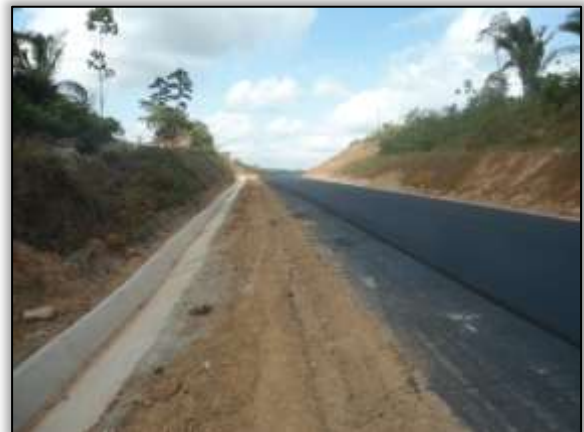
Foto 147 – Construção de valeta concluída. Lado esquerdo. Estaca 1583. S 03.29863° W 052.49510° 17q12/2013.
