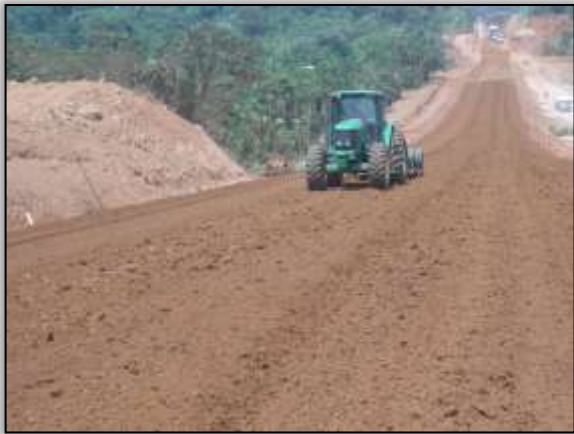
Foto 78 – Gradeamento do solo. Estaca 2902. S 03.38943° W 052.70567°. 10/10/2013.
