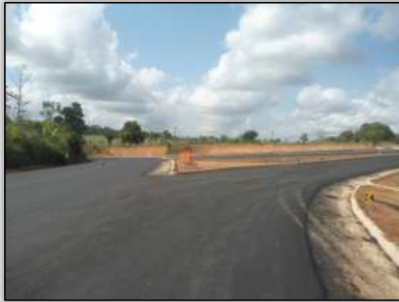
Foto 138 – Conclusão de trevo da vicinal 12 pavimentado. Lado direito. Estaca 1492. S 03.29901° W 052.48932° 17/12/2013.
