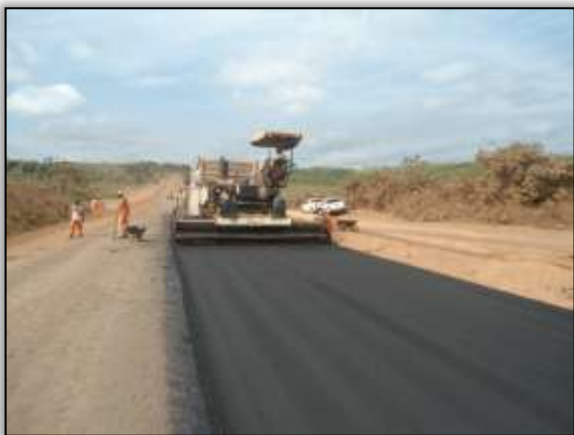
Foto 86 - Aplicação de asfalto. Estaca 2108 á 2132. S 03.33117° W 052.58248° 17/10/2013.
