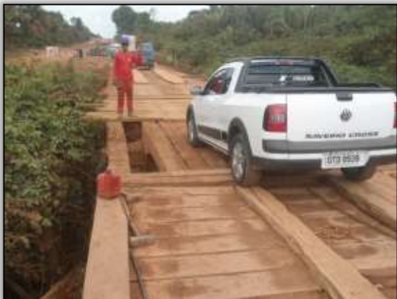
Foto 94 - Reforma de ponte do Igarapé arrependido. S 03.31975° W 052.56762°. 10/10/2013.
