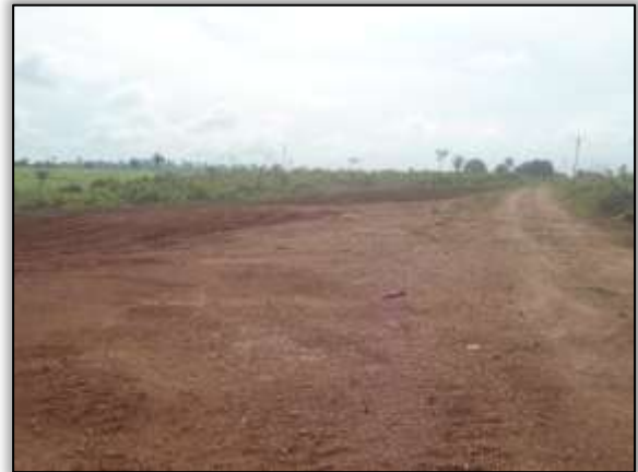
Foto 159 – Jazida caverna em fase de recuperação. Lado esquerdo. S 03.38127° W 052.58029° 26/12/2013.
