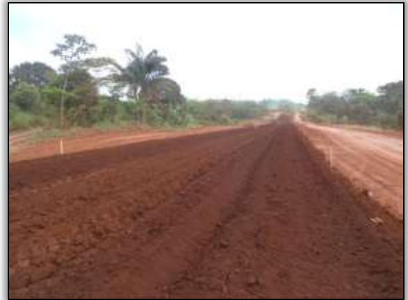
Foto 26 – Terraplanagem. Estaca 3573. S 03 43316° W 052. 81557° 20/08/2013.
