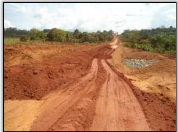
Foto 28 - Implantação de de sistema de drenagem. S 03.43939° W 52.83403°. 20/08/2013.
