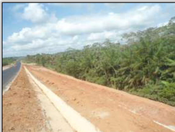
Foto 148 – Valeta concluída. Lado direito. Estaca 1608. S 03.29980° W 052.49967° 17/12/2013.
