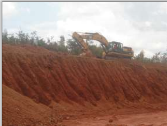
Foto 44 – Jazida em exploração próximo a vila do 70. Lado direito. Estaca 2931. S 03. 38983° W 052. 71158° 27/09/2013.
