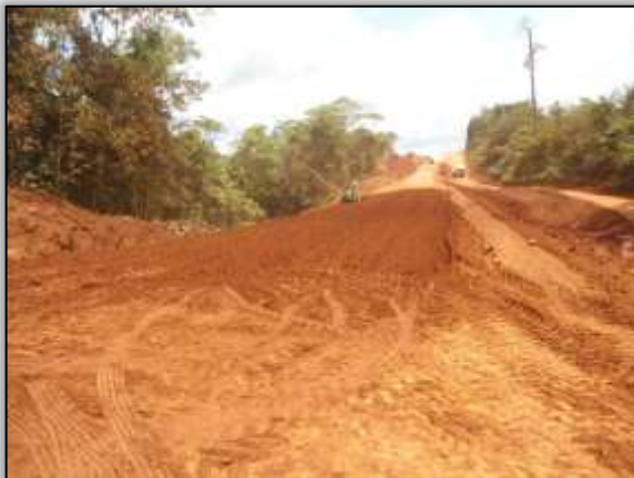
Foto 23 - Máquina gradeando a pista. Estaca 3455. S 03. 42138° W 052. 79944° 20/08/2013.
