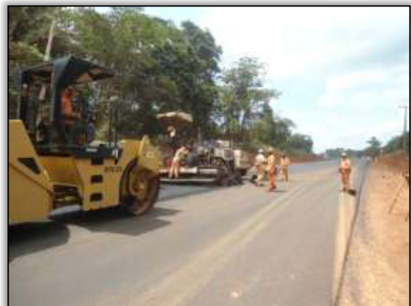
Foto 89 - Pavimentação da rodovia. Estaca 3406. S 03.41692° W 052.79198° . 23/10/2013.
