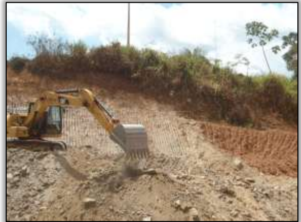
Foto 22 - Corte em talude. Lado direito. S 03. 39043° 052. 71729° 20/08/2013.
