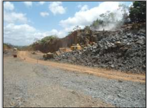
Foto 8 - Pedreira. Estaca 3740. S 03. 44180° W 052. 84491° 14/08/2013
