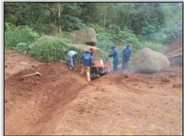
Foto 129 – Construção de valeta. Lado direito. Estaca 3350. S 03.41366° W 052.78276° 28/11/2013.
