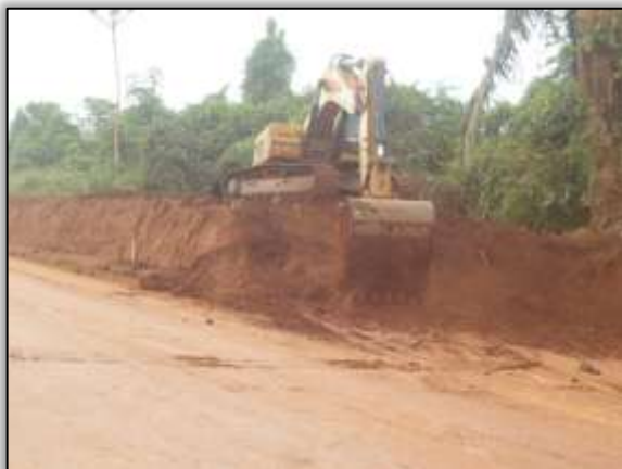
Foto 11 - Corte em talude. Estaca 3424. Lado esquerdo. S 03.41853° W 052. 79511° 14/08/2013
