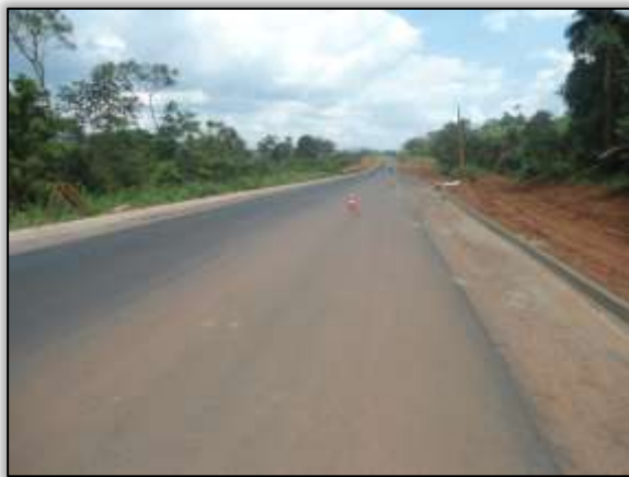
Foto 152 – Construção de meio fio. Lado esquerdo. Estaca 3690. S 03.44005° W 052.83631° 17/12/2013.
