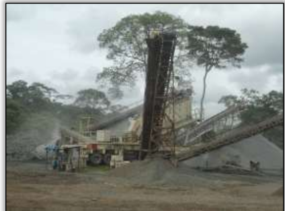
Foto 165 - Britador em funcionamento. Lado direito. Estaca 3775. S 03.44206° W 052.85213° 28/01/2014
