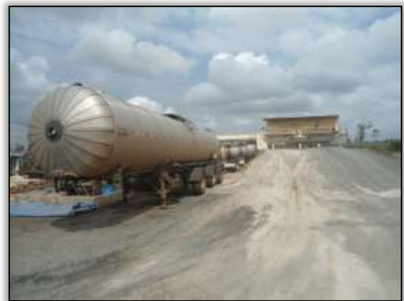
Foto 99 – Usina de asfalto. Lado direito. Estaca 1880. S 03.30814° W 052.54790° 14/11/2013.
