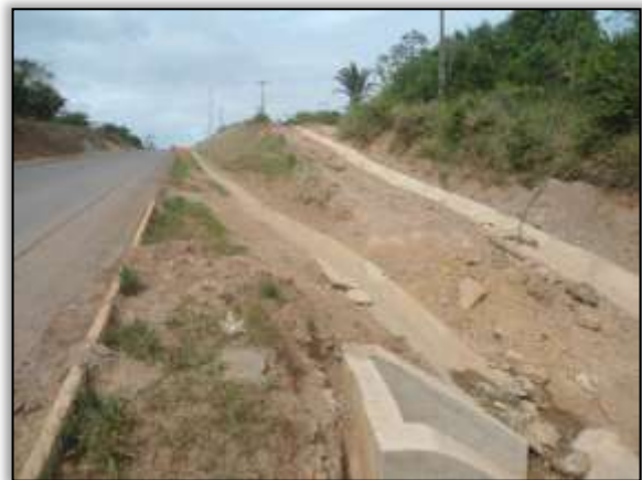
Foto 93 - Valeta de proteção. Lado direito. Estaca 2413. S 03.35632° W 052.62643°. 17/10/2013.
