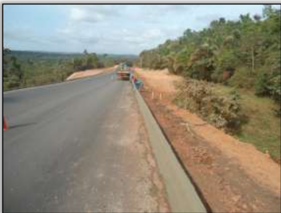
Foto 92 - Construção de meio-fio. Lado direito Estaca 1903. S 03.31085° W 052. 54976°. 17/10/2013.
