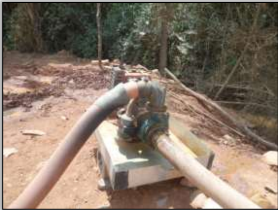
Foto 72 - Captação de água Igarapé Jacarezinho. Lado esquerdo. Estaca 3950. S 03.39049° W 052.71481°. 10/10/2013.
