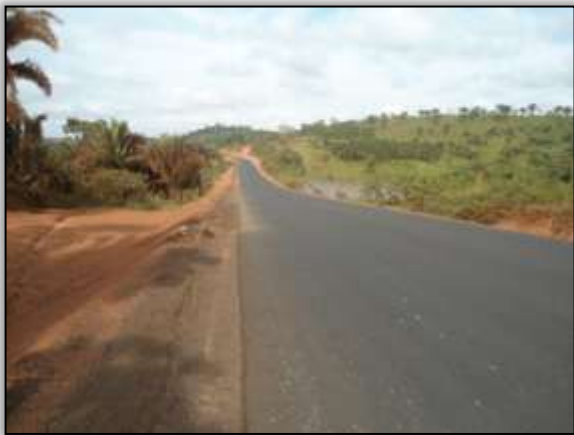
Foto 82 - Primeira camada asfáltica. Estaca 2056. S 03.32354° W 052.57369°. 17/10/2013
