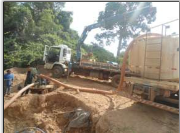
Foto 155 – Captação de água igarapé Arrependido. Lado esquerdo. S 03. 32021° W 052. 56824° 27/12/2013.
