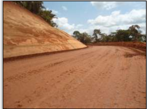
Foto 49 – Corte de talude. Lado esquerdo. S 03.43042° W 052.81324° 17q09/2013.
