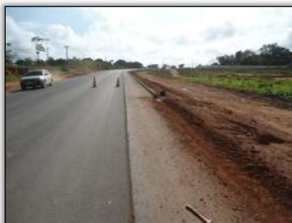
Foto 16 - Corte para construção de meio fio. Estaca 1878. Lado esquerdo. S 03. 30799° W 052. 54592° 14/08/2013
