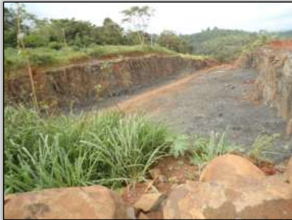
Foto 102 – Pedreira. Estaca 3740. S 03.44180° W 052.84491° 14/11/2013.
