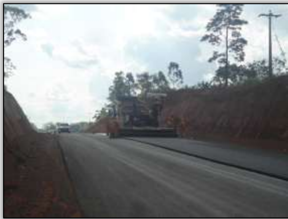
Foto 122 – Segunda camada asfáltica. Estaca 3294. S 03.41000° W 052.77272° 26/11/2013.
