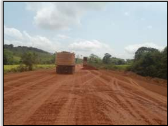
Foto 77 - Terraplenagem. Estaca 2815. S 03.38699° W 052.69066°. 10/10/2013.
