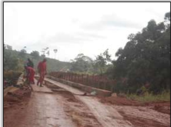
Foto 95 - Reforma de ponte do Igarapé Penetecal I. S 03.38640° W 052.68855°. 23/10/2013.
