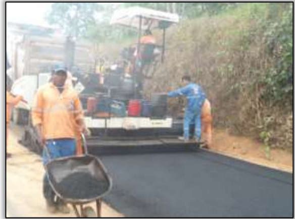
Foto 121 – Pavimentação na entrada da vicinal 12. Lado direito. S 03.28687° W 052.48946° 20/11/2013.
