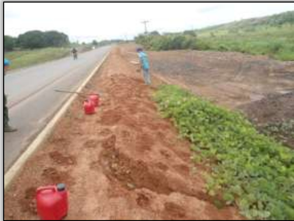
Foto 174 - Coveamento para o plantio de gramíneas. Lado direito. S 03. 32950° W 052. 58120° 28/01/2014
