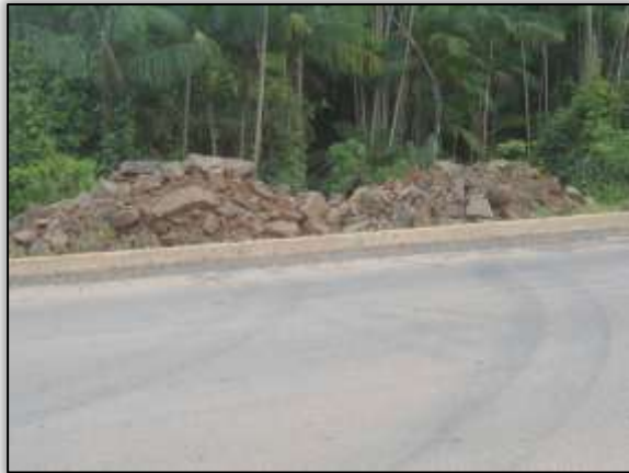
Foto 144 – Material depositado na faixa de domínio. Lado esquerdo. Estaca 2700. S 03.38077° W 052.67139° 17/12/2013.
