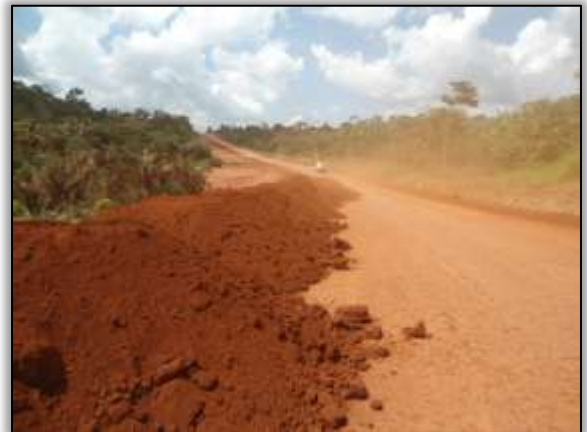
Foto 24 - Material para terraplanagem. Estaca 3542. S 03. 43032° W 052. 81293° 20/08/2013.
