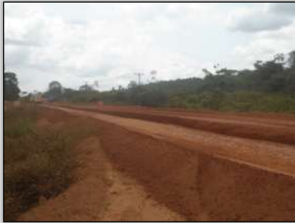
Foto 54 – Terraplanagem. Estaca 2273. S 03. 34434° W 052. 60472° 27/09/2013.
