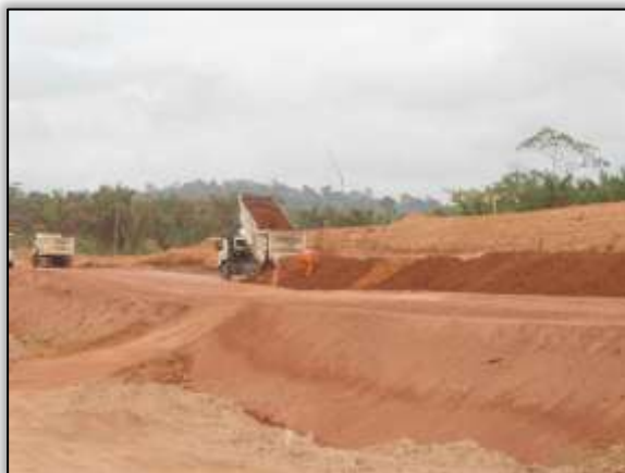
Foto 106 – Aterro e terraplanagem. S 03.30003° W 052.49889° 13/11/2013.
