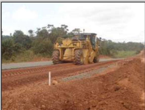
Foto 88 - Máquina Recicladora. Estaca 3607. S 03.43663° W 052.82151° . 23/10/2013.
