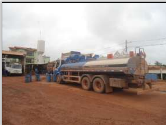
Foto 130 – Coleta de óleo no canteiro de obra. Lado esquerdo. Estaca 1827. S 03.30872° W 052.53631° 13/11/2013.
