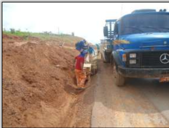
Foto 128 – Construção de valeta. Lado direito. Estaca 2904. S 03.38952° W 052.70567° 28/11/2013.
