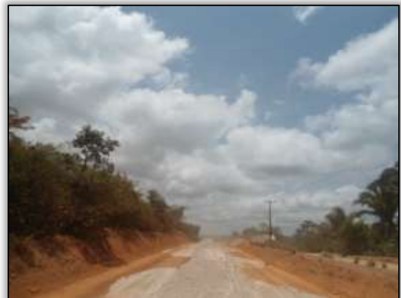
Foto 53 – Terraplanagem. Estaca 2067. S 03. 32461° W 052. 57510° 27/09/2013.
