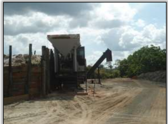
Foto 30– Usina de asfalto. Lado direito estaca 3775. S 03.44206° W 052. 85213°. 20/08/2013.
