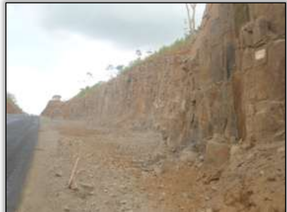
Foto 137 – Pedreira. Estaca 3740. S 03.44180° W 052.84491° 17/12/2013.
