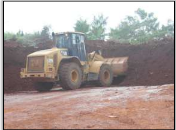
Foto 32– Retirada de material. Lado direito. S 03. 43860° W 052. 86596° 20/08/2013.
