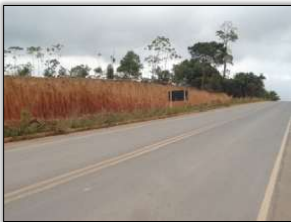
Foto 104 – Corte em talude. Lado esquerdo. S 03.29027° W 052.48940° 13/11/2013.
