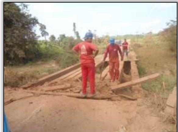
Foto 59 – Manutenção da ponte do igarapé Jarucu. S 03. 30410° W 052. 51256° 27/09/2013.
