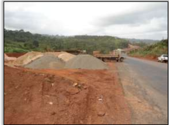
Foto 101 – Construção de artefato de concreto. Lado esquerdo. Estaca 3512. S 03.42750° W 052.80790° 14/11/2013.
