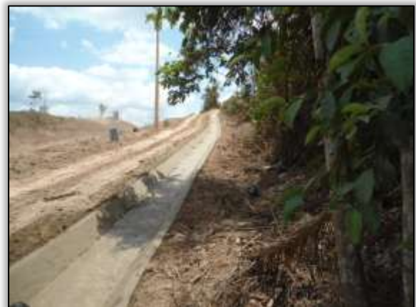
Foto 47 – Construção de valeta de drenagem. Lado direito. Estaca 2656. S 03.37706° W 052.66374° 17/09/2013.
