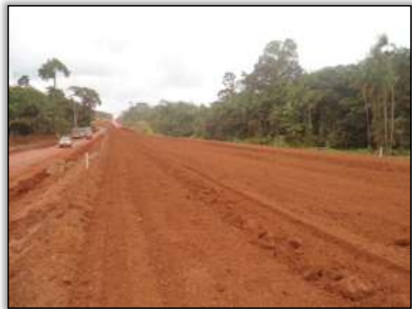
Foto 81 - Serviços de terraplenagem. Estaca 3325. S 03.41220° W 052.77825°. 10/10/2013.
