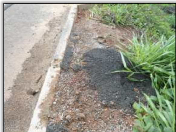
Foto 102– Resíduo de obra. Estaca 2978. Lado Esquerdo. S 03.17878° W 051.55574° 24/01/2014
