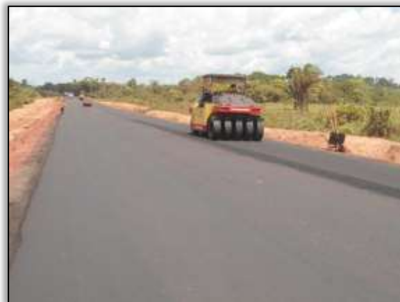
Foto 2 – Pavimentação asfáltica. Lado esquerdo. Estaca 3057. S 03.16901° W 051.56291° 21/08/2013
