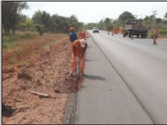
Foto 36 – Preparo para construção de meio fio. Lado esquerdo. S 03.11026° W 051.63110° 09/10/2013
