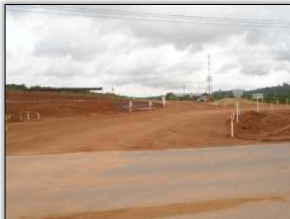
Foto 92- Acesso ao Canteiro Bela Vista - canais e diques. Lado Esquerdo. Estaca 4258. S 03.12479° W 051.73776° 26/12/2013.
