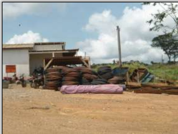
Foto 75– Material exposto na entrada do canteiro. Estaca 561. Lado Esquerdo. S 03.45068° W 051.21939°. 13/12/2013.
