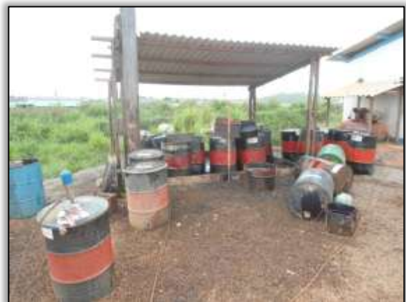
Foto 54 – Material betuminoso armazenado inadequadamente. Lado esquerdo. S 03.45018° W 051.21936° 26/11/2013
