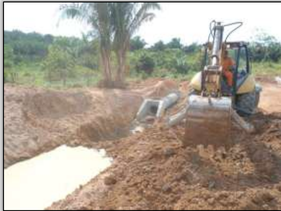
Foto 18 – Construção de sistema de drenagem. Lado esquerdo. Estaca 3274. S 03.13730° W 051.58879° 02/10/2013
