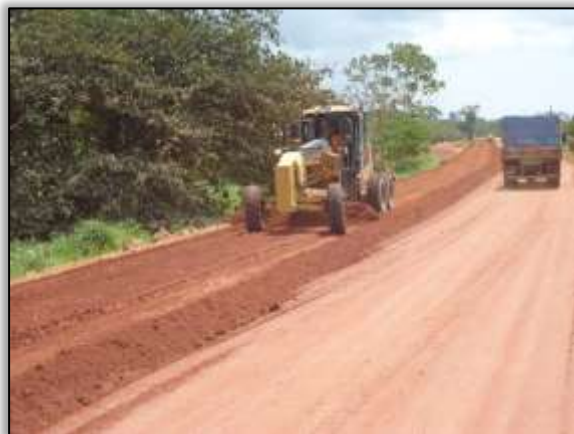
Foto 9 – Obras de terraplenagem na rodovia. Lado esquerdo. Estaca 3564. S 03.10972° W 051.63248° 29/08/2013
