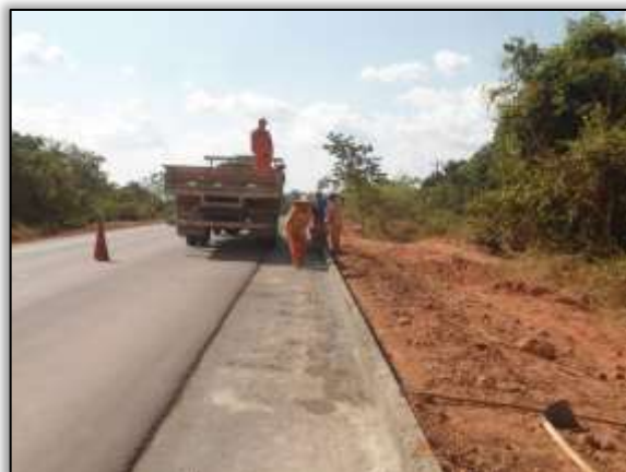
Foto 43 – Construção de sistema de drenagem (meio fio). Lado direito. Estaca: 3604. S 03.10646° W 051.63851° 22/10/2013
