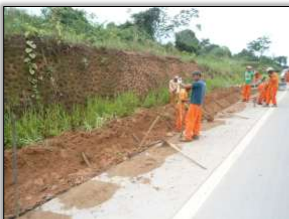
Foto 95 - Construção de sarjeta. Lado Esquerdo. S 03.12588° W 051.75270° 13/12/2013
