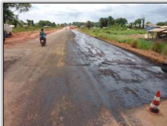
Foto 6 – Imprimação. Lado direito. Estaca 3293. S 03.13485° W 051.59189° 29/08/2013
