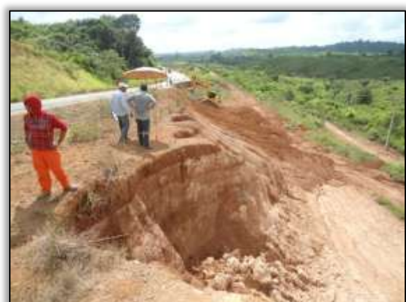
Foto 12 – Reconformação da saia de aterro. Lado esquerdo. Estaca 6071. S 03.16971° W 052.01240° 16/08/2013
