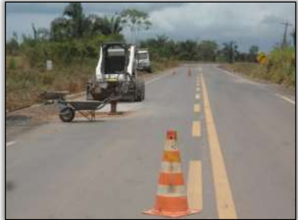
Foto 50- Reconformação da pista. Lado esquerdo. S 03.39594° W 051.28965° 29/10/2013
