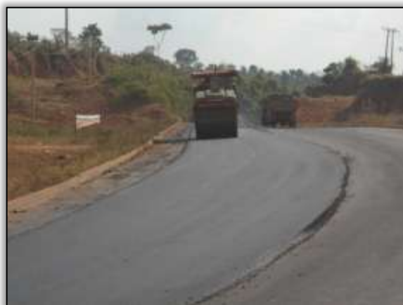
Foto10- Máquinas trabalhando em mais uma camada de asfalto. Lado esquerdo. Estaca 4788. S 03.10805° W 051.82986° 22/10/2013
