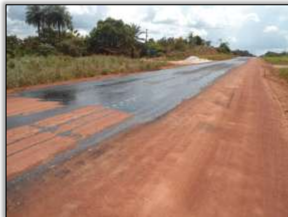
Foto 4 – Imprimação. Lado direito/esquerdo. Estaca 3160. S 03.15280° W 051.57512° 21/08/2013
