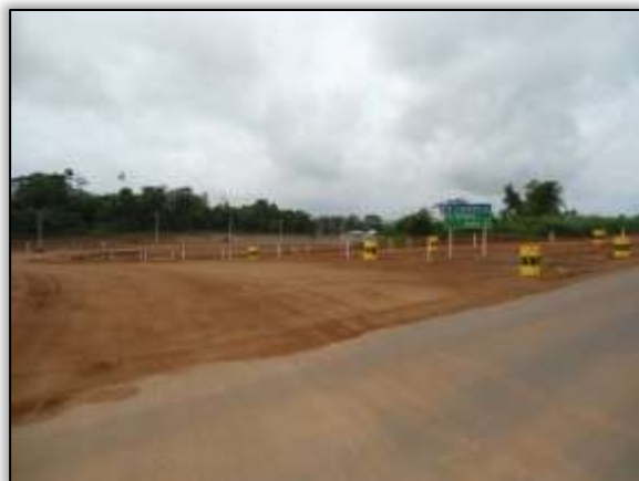
Foto 91- Acesso a vila residencial CCBM. Lado direito. Estaca 4230. S 03.1251° W 051.74237° 26/12/2013.
