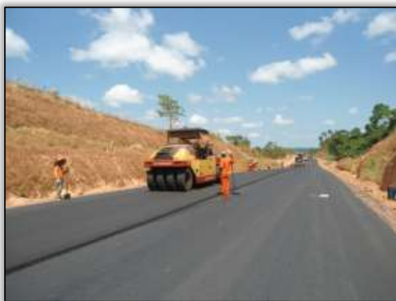
Foto 28 – Pavimentação asfáltica (2ª camada). Lado esquerdo. Estaca 3436. S 03.11900° W 051.61111° 25/09/2013
