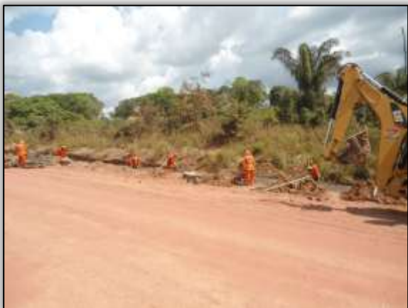
Foto 11 – Construção de valeta. Lado esquerdo. Estaca 3220. S 03.14480° W 051.58258° 07/08/2013
