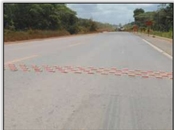
Foto 29 – Instalação de sonorizadores antes de ponte. Lado direito. Estaca 962. S 03.40539° W 051.27521° 24/09/2013
