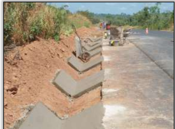
Foto 21 – Construção de sistema de drenagem (sarjeta). Lado esquerdo. Estaca 3472. S 03.11606° W 051.61711° 25/09/2013
