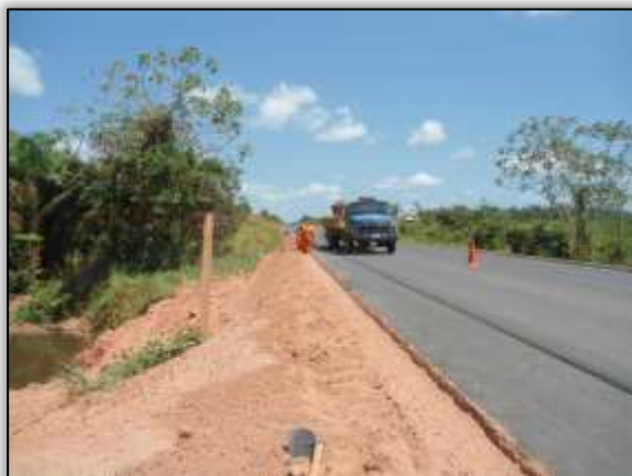
Foto 22 – Construção de sistema de drenagem (meio-fio). Lado esquerdo. Estaca 3134. S 03.15316° W 051.57401° 25/09/2013
