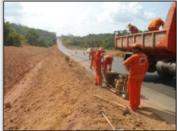
Foto 19 – Construção de sistema de drenagem (meio-fio). Lado esquerdo. Estaca 3396. S 03.12261° W 051.60519° 02/10/2013
