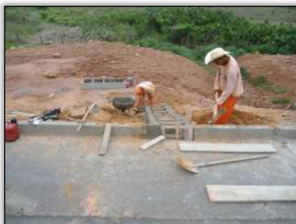
Foto 63 – Descida d'água. Lado direito. Estaca 3538. S 03.11170° W 051.62818° 20/11/2013
