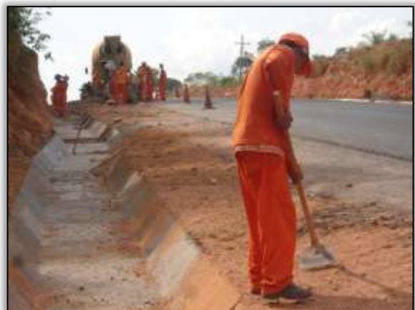
Foto 35 – Construção de sistema de drenagem (sarjeta). Lado esquerdo. Estaca: 3424. S 03.12040° W 051.60982° 09/10/2013
