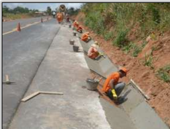
Foto 59 – Construção de valeta de proteção de corte. Lado direito. Estaca 3978. S 03.11806° W 051.69270° 12/11/2013
