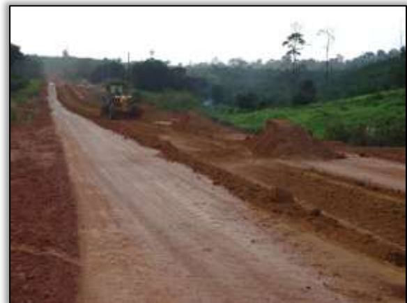
Foto 10 – Obras de terraplenagem na rodovia. Lado direito. Estaca 4084. S 03.13522° W 051.71356° 29/08/2013
