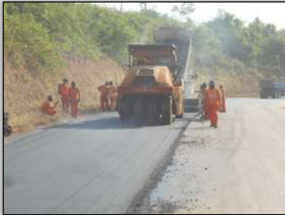
Foto 11- Máquina aplicando camada de asfalto. Lado esquerdo. Estaca 4798. S 03.10933° W 051.83132° 22/10/2013
