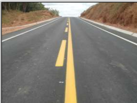
Foto 47- sinalização horizontal na rodovia. Lado direito e Esquerdo. Estaca 3376. S 03.12473° W 051.60197° 29/10/2013
