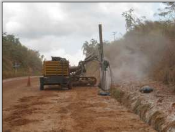
Foto 20 – Construção de sistema de drenagem (dreno profundo). Lado direito. Estaca 592. S 03.44715° W 051.22376° 24/09/2013
