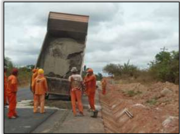
Foto 46- Construção de sarjeta. Lado Direito. Estaca 3791. S 03.11270° W 051.67028° 29/10/2013
