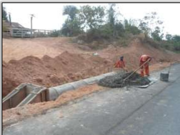
Foto 42 – Construção de sistema de drenagem. Lado esquerdo. Estaca 3852. S 03.11769° W 051.61365° 22/10/2013
