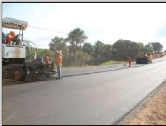
Foto 26 – Pavimentação asfáltica (2ª camada). Lado esquerdo. Estaca 4018. S 03.12861° W 051.70395° 02/10/2013
