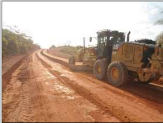
Foto 24 – Atividades de terraplenagem. Estaca 4304. S 03.12571° W 051.74994° 02/10/2013
