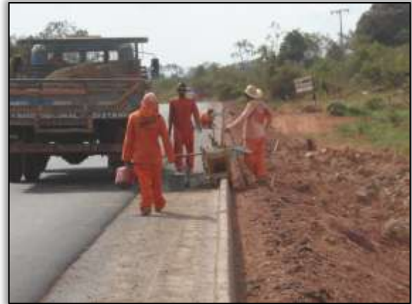
Foto 37 – Construção de sistema de drenagem (meio fio). Lado direito. Estaca: 3558. S 03.11580° W 051.68281° 09/10/2013
