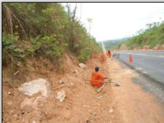
Foto 77– Sarjeta Triangular de concreto. Estaca 605. Lado Esquerdo. S 03.44531° W 051.22649°. 05/12/2012.
