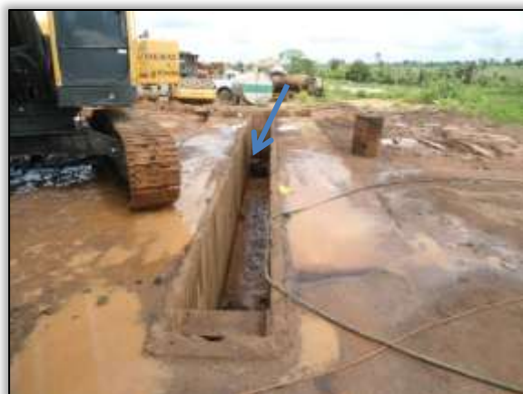
Foto 68– Óleo lubrificante exposto no lava a jato. Estaca 561. Lado Esquerdo. S 03.45172° W 051.21874°. 13/12/2013.
