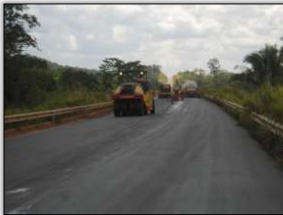
Foto 1 – Recapeamento asfáltico de trecho da rodovia. Lado esquerdo. Estaca 2512. S 03.639° W 051.49280° 07/08/2013
