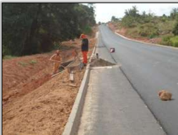
Foto 34 – Construção de sistema de drenagem (descida d'água). Lado esquerdo. Estaca: 3410. S 03.12191° W 051.60747° 09/10/2013
