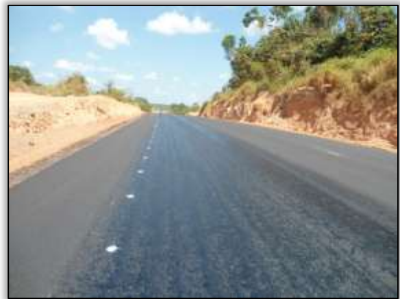
Foto 27 – Pavimentação asfáltica (1ª camada). Lado direito e esquerdo. Estaca 3448. S 03.11817° W 051.61281° 25/09/2013
