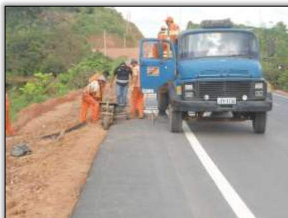
Foto 64 – Construção de meio fio. Lado esquerdo. Estaca 4134. S 03.13250° W 051.72222° 26/11/2013
