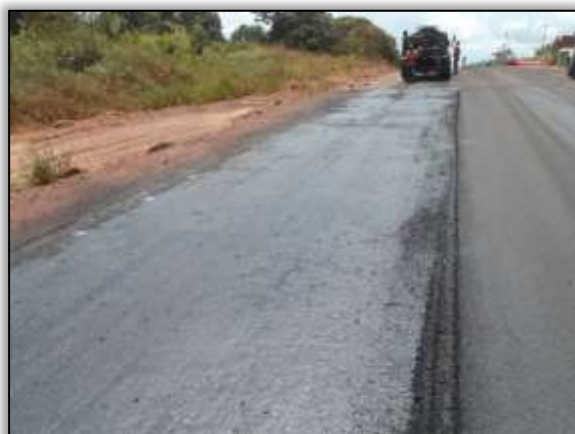
Foto 5 – Imprimação. Lado esquerdo. Estaca 3060. S 03.16607° W 051.56462° 21/08/2013
