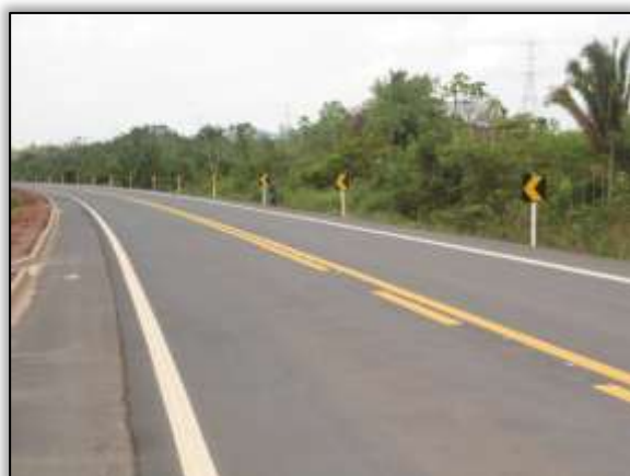
Foto 81– sinalização vertical. Estaca 3098. Lado Direito. S 03.16118° W 051.56741°. 06/12/2013.
