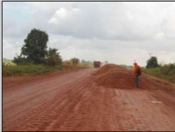
Foto 7 – Obras de terraplenagem na rodovia. Lado direito. Estaca 3748. S 03.11036° W 051.66332° 07/08/2013
