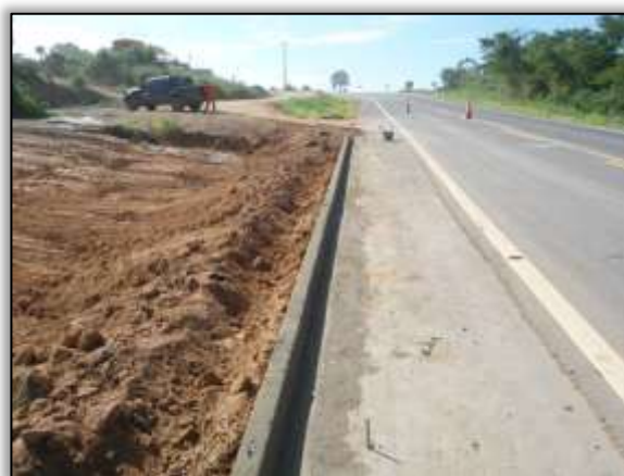
Foto 94 - Construção de meio fio. Lado Esquerdo. S 03.12519° W 051.73661° 07/01/2014
