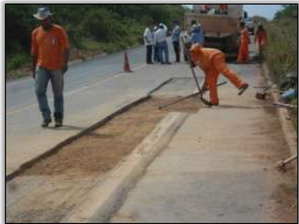
Foto 33 – Reconformação da pista. Lado direito. Estaca: 722. S 03.43128° W 051.24100° 09/10/2013
