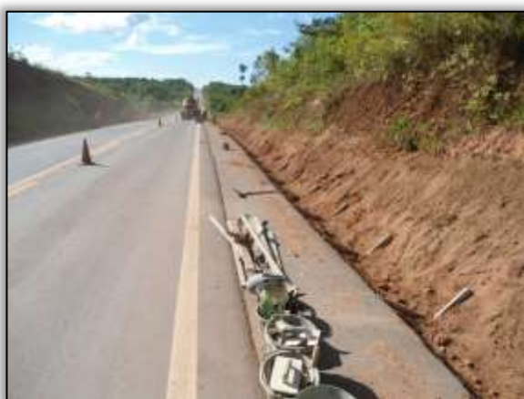
Foto 93- Construção de sarjetas. Estaca 4160. Lado Direito. S 03.13045° W 051.72620° 07/01/2014
