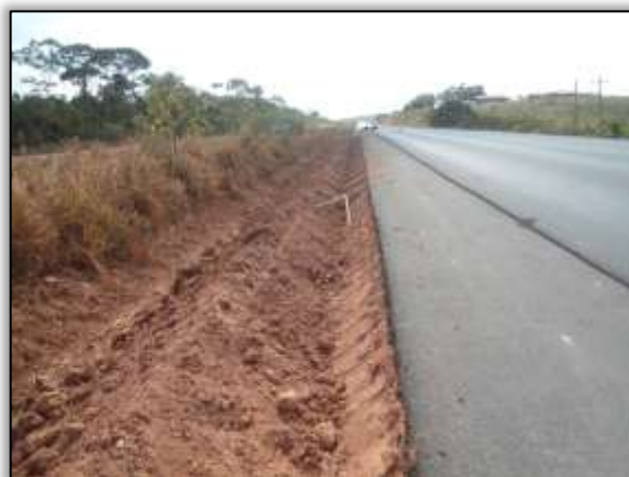
Foto 08- Construção de sistema de drenagem (sarjeta). Lado esquerdo. Estaca 3812. S 03.11362° W 051.67389° 22/10/2013
