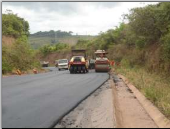
Foto 45- Asfaltamento da rodovia. Lado esquerdo. Estaca 4972. S 03.09462° W 051.85629° 29/10/2013
