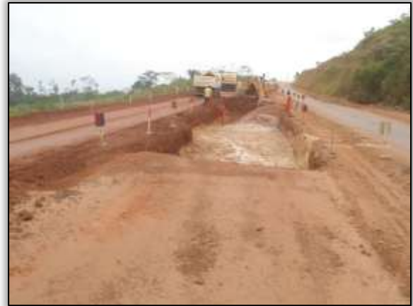
Foto 56 – Reconformação da rodovia e da saia de aterro (Gabião). Lado esquerdo. S 03.16962° W 052.01243° 20/11/2013
