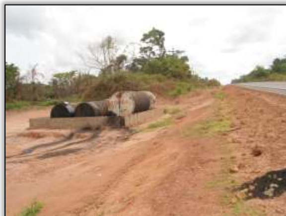
Foto 84– Vazamento de material betuminoso. Estaca 3478. Lado Direito. S 03.11609°W 051.61851°. 05/12/2013.
