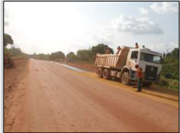
Foto 25 – Imprimação. Lado direito. Estaca 4094. S 03.13427° W 051.71517° 02/10/2013
