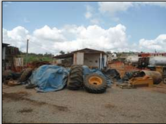
Foto 73– Material exposto no pátio do canteiro. Estaca 561. Lado Esquerdo. S 03.45163° W 051.21937°. 13/12/2013.
