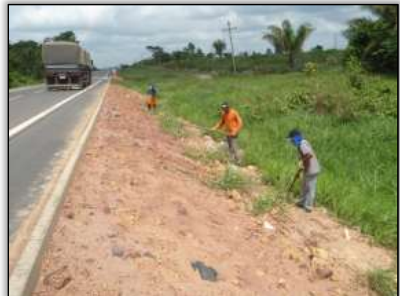
Foto 88– Preparo das covas para hidrossemeadura. Estaca: 3234. Lado Direito. S 03.14303° W 051.38424°. 05/12/2013.
