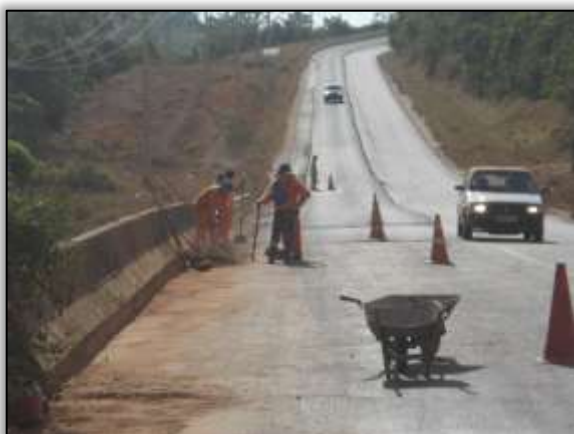
Foto 09- Limpeza da ponte. Estaca 4684. S 03.11787° W 051.81585° 22/10/2013
