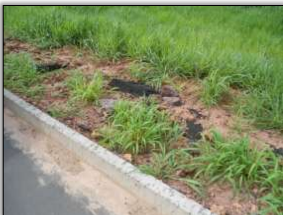
Foto 101– Resíduo de obra. Estaca 3138. Lado Esquerdo. S 03.115509° W 051.57214° 24/01/2014
