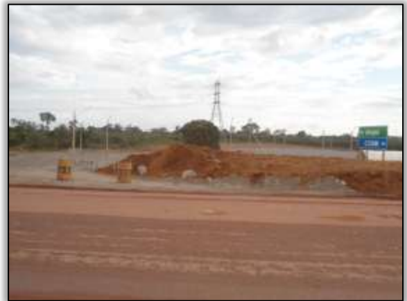
Foto 16 – Local da saída do desvio. Lado direito. S 03.12435° W 051.78915° 17/08/2013
