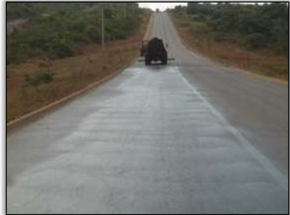
Foto 12- Preparo para colocar camada de asfalto – jogando ADP (asfalto diluído de petróleo). Lado esquerdo. Estaca 4812. S 03.10994° W 051.83340° 22/10/2013
