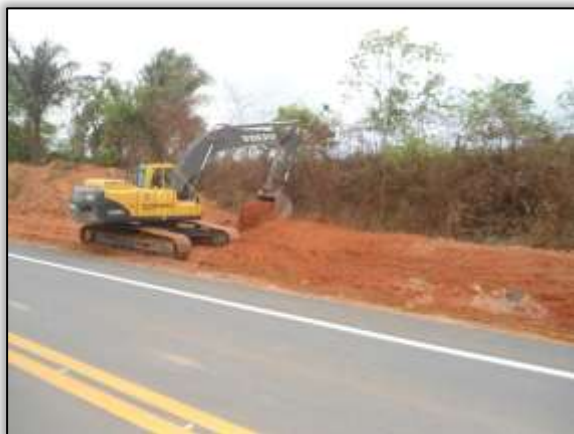
Foto 57 – Escavação para construção do dispositivo de drenagem. Lado esquerdo. Estaca 3716. S 03.10853° W 051.65794° 20/11/2013
