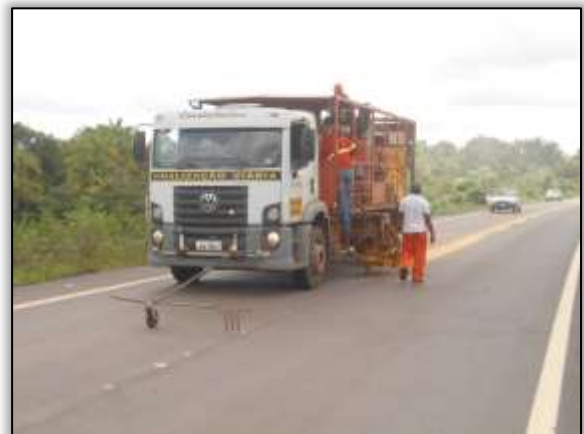
Foto 58 – Implantação de sinalização horizontal. Lado direito. Estaca 3100. S 03.16066° W 051.56785° 26/11/2013
