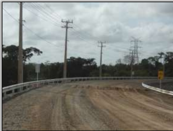
Foto 15 – Local do desvio com a via sinalizada. S 03.11912° W 051.77243° 17/08/2013
