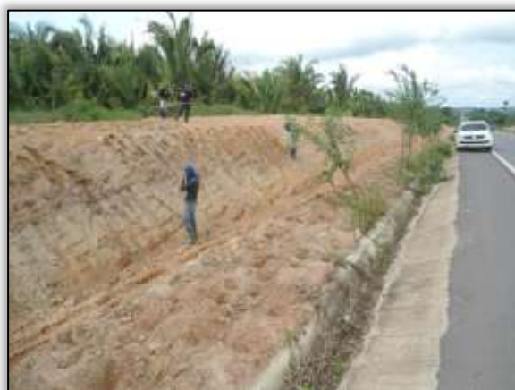
Foto 65 – Coveamento para sementeira. Lado esquerdo. Estaca 1582. S 03.33753° W 051.36348° 26/11/2013
