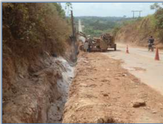
Foto 32 – Construção de sistema de drenagem (dreno profundo). Lado esquerdo. S 03.44524° W 051.22652° 09/10/2013
