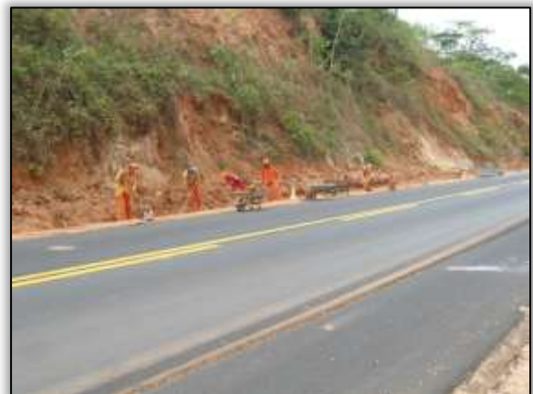
Foto 78– Sarjeta Triangular de concreto. Estaca 605. Lado Esquerdo. S 03.44531° W 051.22649°. 05/12/2012.
