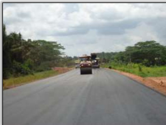
Foto 3 – Pavimentação asfáltica. Lado direito. Estaca 3272. S 03.13802° W 051.58896° 29/08/2013
