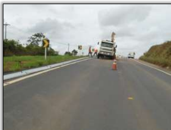
Foto 96- Defesa metálica. Estaca 6072. Lado Esquerdo. S 03.45068° W 051.21939° 28/01/2014
