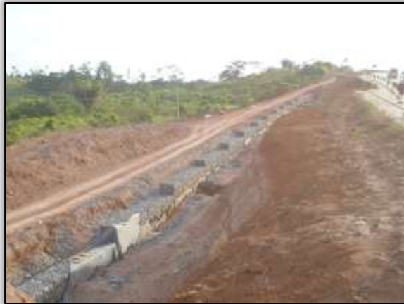
Foto 30 – Recuperação da pista de rolamento. Lado esquerdo. S 03.16922° W 052.01183° 02/10/2013
