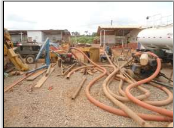
Foto 74– Material exposto no pátio do canteiro. Estaca 561. Lado Esquerdo. S 03.45163° W 051.21937°. 13/12/2013.
