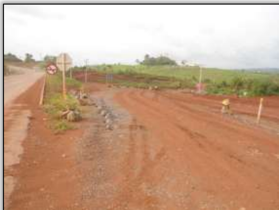
Foto 89– Acesso ao porto do CCBM. Lado esquerdo. Estaca 4572. S 03.12021° W 051.79644° 26/12/2013.
