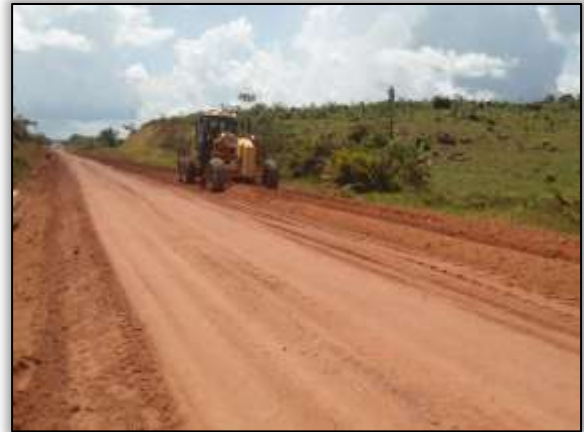
Foto 8 – Obras de terraplenagem na rodovia. Lado direito. Estaca 3134. S 03.15623° W 051.57190° 21/08/2013
