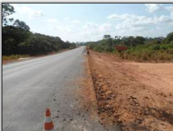
Foto 44- Preparo para construção de meio fio. Lado direito. Estaca 3614. S 03.10540° W 051.64023° 22/10/2013
