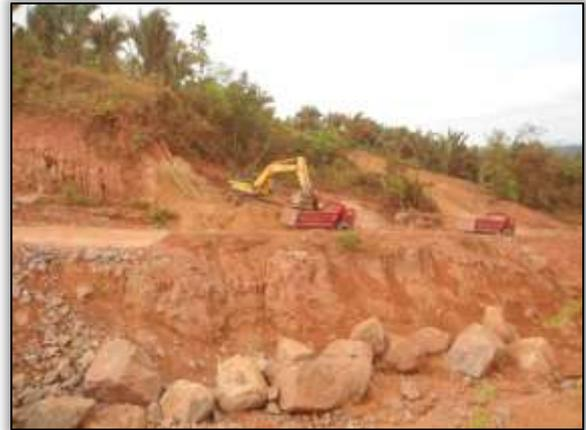
Foto 61 – Corte para conformação de talude. Lado esquerdo. S
