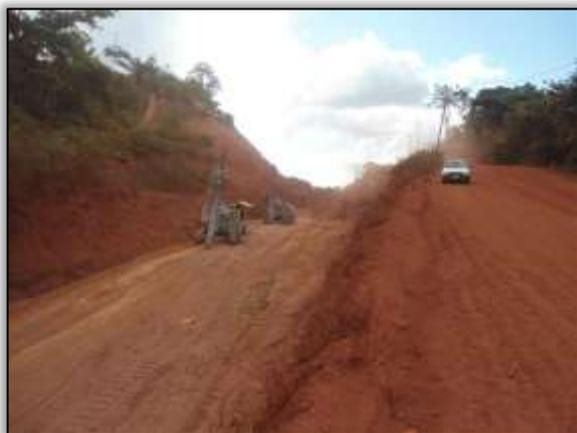
Foto 17 – Perfuração para detonação na ladeira da velha. Lado esquerdo. Estaca 1070. S 03.84910° W 050.51409° 20/08/2013
