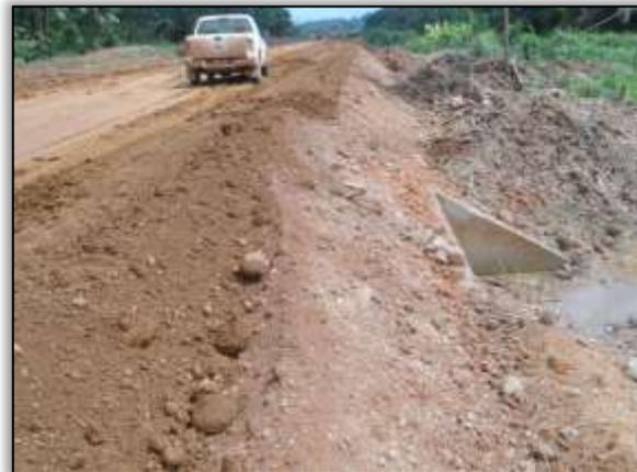
Foto 12 – Substituição de bueiro simples. Lado esquerdo. Estaca 5670. S 03.53888° W 051.12518° 07/08/2013
