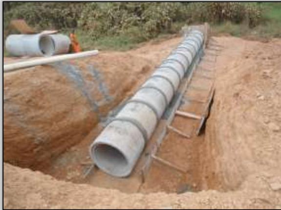
Foto 24 – Construção de bueiro simples. Lado direito. Estaca 3854. S 03.6665° W 050.95118° 02/10/2013
