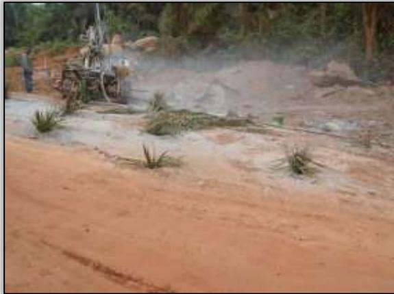
Foto 90 – Perfuração de pontos para detonação.
