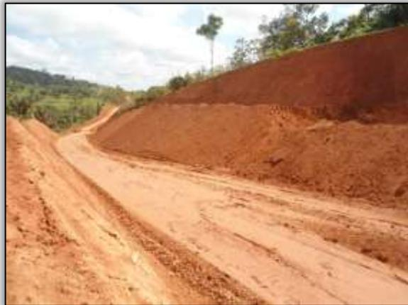
Foto 9 – Corte e conformação de talude. Lado direito. Estaca 4740. S 03.57618° W 050.08078° 07/08/2013
