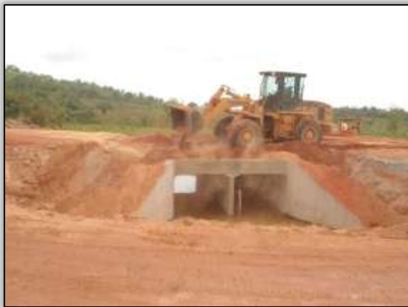
Foto 26 – Construção de bueiro celular duplo. Lado direito. Estaca 3904. S 03.66207° W 050.95924° 02/10/2013
