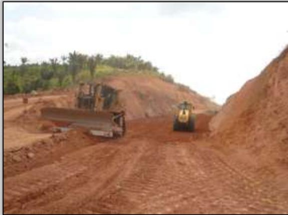
Foto 60 – Corte da rodovia e talude na ladeira do cantineiro (Depois).
