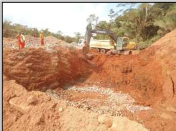
Foto 15 – Implantação de bueiro simples. Lado esquerdo. Estaca 4345. S 03.62321° W 051.01489° 21/08/2013
