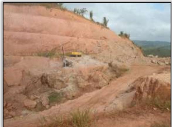
Foto 18 – Perfuração para detonação na ladeira da velha. Lado esquerdo. Estaca 1070. S 03.84711° W 050.51480° 21/08/2013
