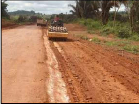
Foto 7 – Atividades de terraplenagem e compactação do solo na rodovia. Estaca 4575. S 03.59304° W 051.05669° 21/08/2013
