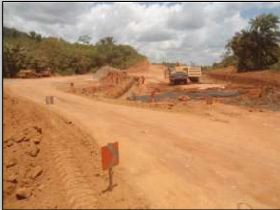
Foto 19 – Drenagem provisória. Lado esquerdo.
