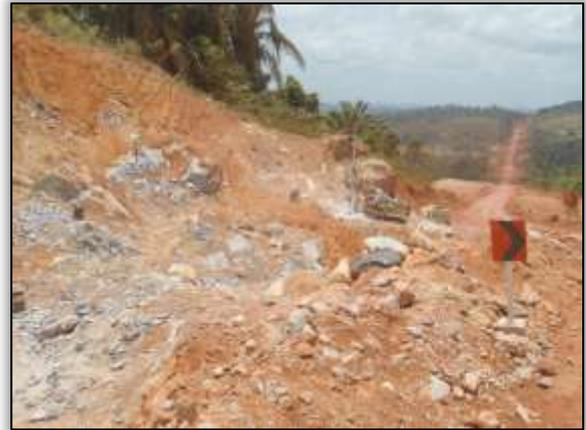
Foto 68 – Preparação para detonação. Lado esquerdo.
