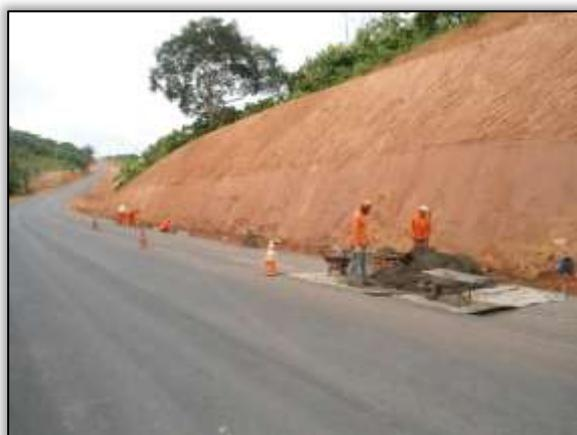
Foto 116 – Construção de sarjeta. Lado direito. Estaca 4741. S 03.57569° W 051.08104° 09/01/2014
