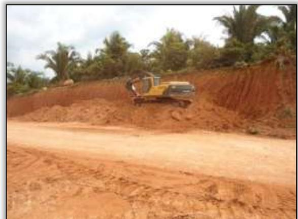
Foto 83 – Conformação do talude de corte. Lado esquerdo.
