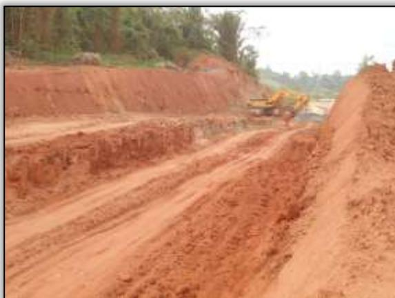
Foto 82 – Corte e conformação da rodovia (*off set*).
