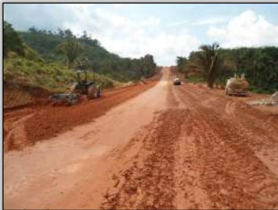
Foto 80 – Compactação e revolvimento de material.
