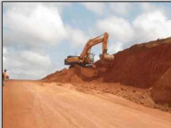
Foto 11 – Corte de talude. Lado direito. Estaca 4581. S 03.59170° W 051.05856° 21/08/2013
