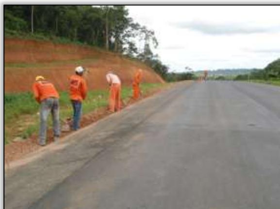
Foto 114 – Construção de meio-fio. Lado esquerdo. Estaca 5042. S 03.54373° W 051.12030° 08/01/2014
