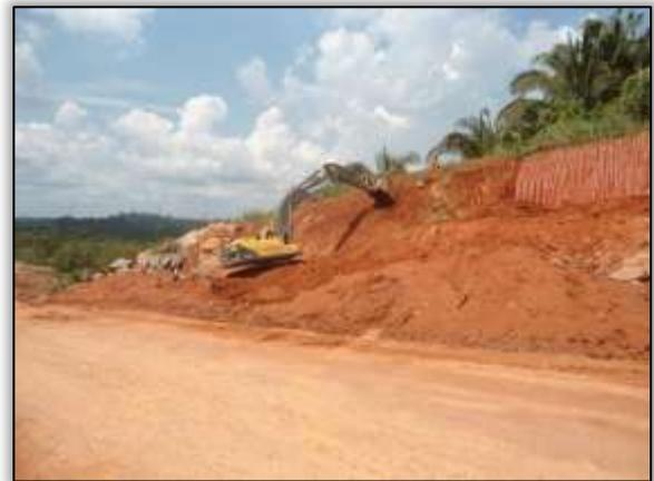
Foto 81 – Conformação do talude de corte. Lado direito.
