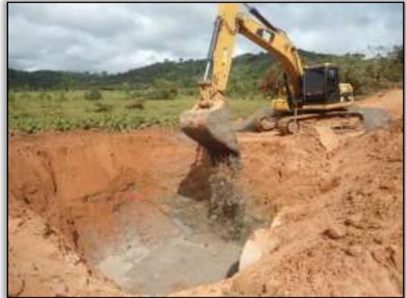
Foto 14 – Implantação de bueiro tubular duplo. Lado esquerdo. Estaca 4115. S 03.63841° W 050.99704° 21/08/2013
