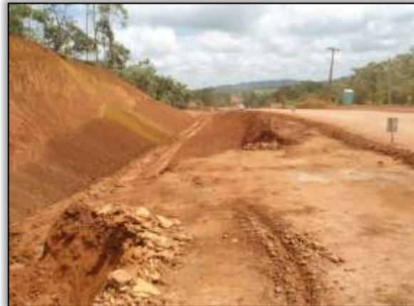
Foto 10 – Corte e conformação de talude. Lado esquerdo. Estaca 5044. S 03.54334° W 051.12090° 07/08/2013
