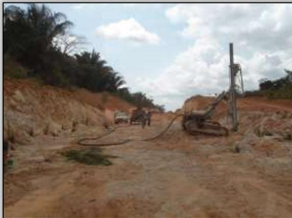
Foto 40 – Preparação para detonação. Lado esquerdo. Estaca 4986. S 03.55085° W 051.11335° 16/09/2013
