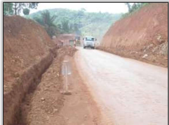
Foto 93 – Dreno profundo. Lado esquerdo. Estaca 4730.
