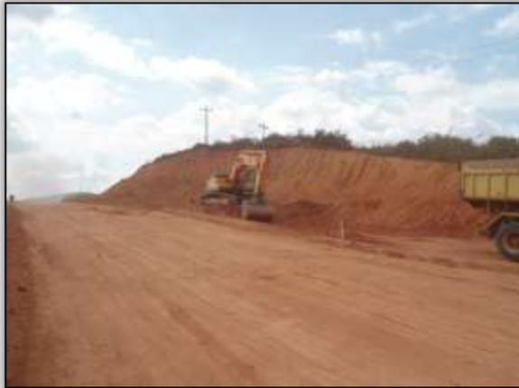
Foto 30 – Corte e conformação de talude. Lado direito. Estaca 4588. S 03.59184° W 051.05843° 16/09/2013
