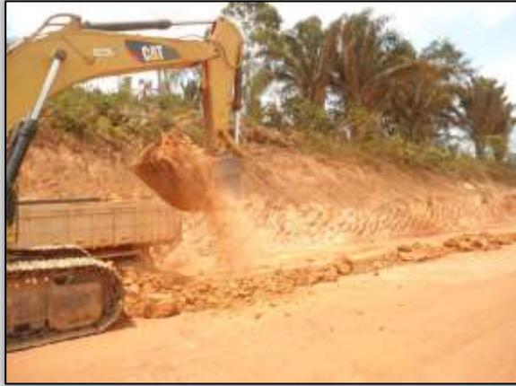
Foto 64 – Corte e conformação da rodovia.
