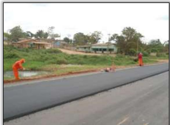
Foto 95 – Construção de meio fio. Lado esquerdo.
