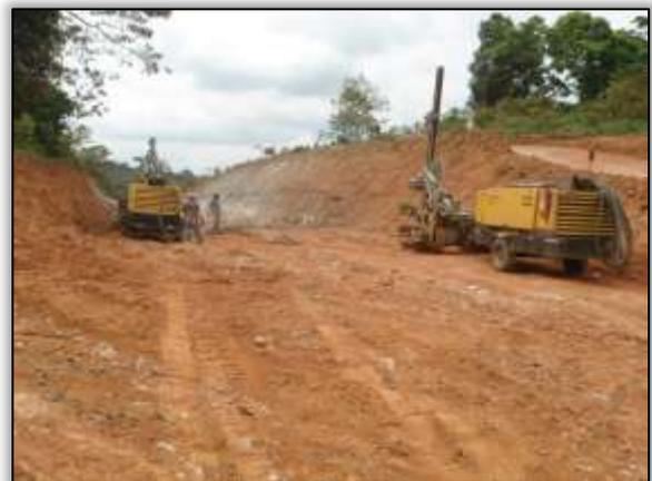
Foto 89 – Preparação para detonação. Lado esquerdo.
