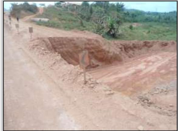
Foto 25 – Construção de bueiro celular. Lado direito. Estaca 3861. S 03.66458° W 050.95529 02/10/2013
