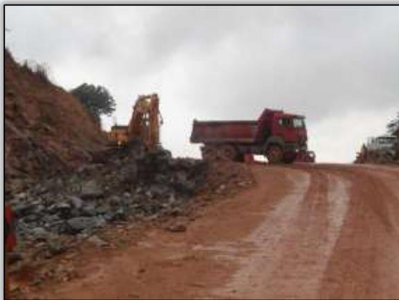
Foto 16 – Corte de talude e conformação da rodovia.
