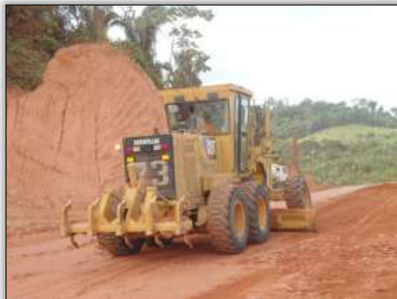
Foto 4 – Atividade de terraplenagem. Lado esquerdo. S 05.130808° W 049.62889° 20/08/2013
