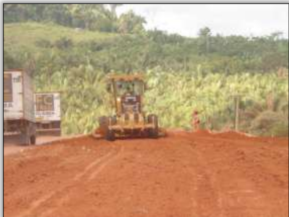
Foto 3 – Atividade de terraplenagem. Lado esquerdo, outra perspectiva. S 04.75595° W 049.62889° 20/08/2013
