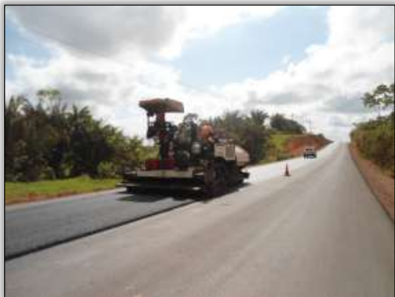
Foto 1 – Pavimentação da rodovia. Lado direito. S 04.15949° W 050.12640° 21/08/2013
