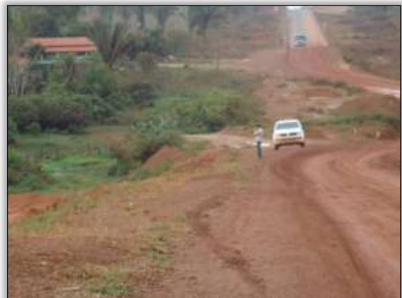
Foto 12 - Processo erosivo recuperado. Lado direito. S 04.02480° W 049.28643° 25/10/2013
