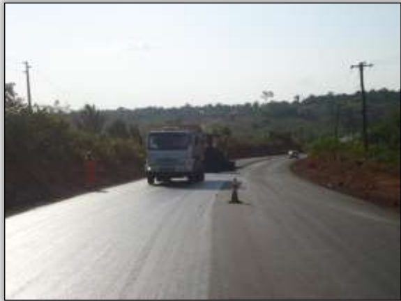
Foto 7 – Aplicação da segunda camada asfáltica. Lado esquerdo. S 04.13452° W 049.58199° 01/10/2013
