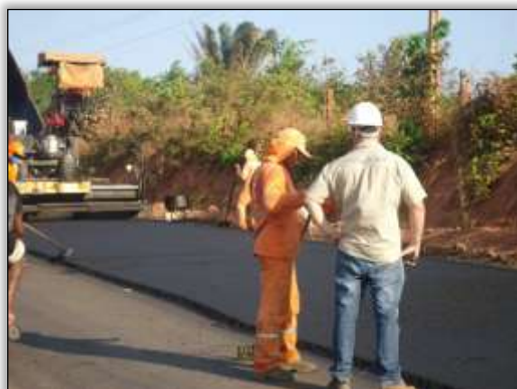
Foto 6 – Segunda camada asfáltica. Lado esquerdo, outra perspectiva. S 04.13452° W 049.58199° 01/10/2013
