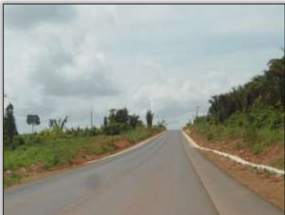
Foto 15 – Sistema de drenagem. Ambos os lados. S 04.17764° W 050.04556° 20/11/2013
