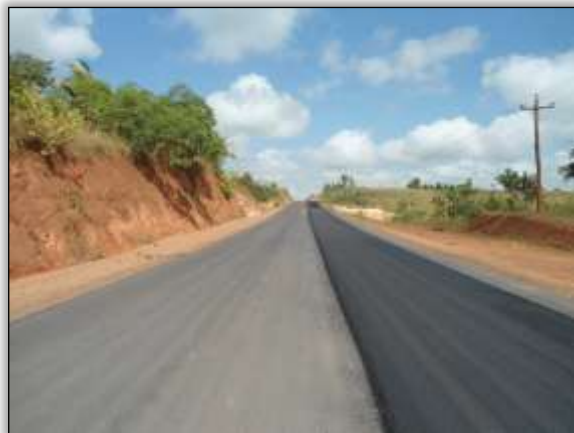
Foto 2 – Primeira camada asfáltica. Lado direito. S 04.15865° W 050.14987° 21/08/2013
