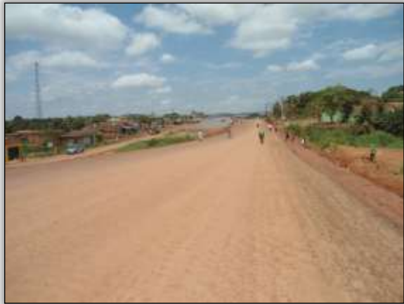
Foto 13 – Rodovia com aplicação da primeira camada asfáltica. Eixo da rodovia. S 04.25213° W 049.94488° 20/11/2013
