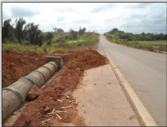
Foto 9 – Instalação de dreno. Lado esquerdo. S 04.14220° W 050.22594° 01/10/2013
