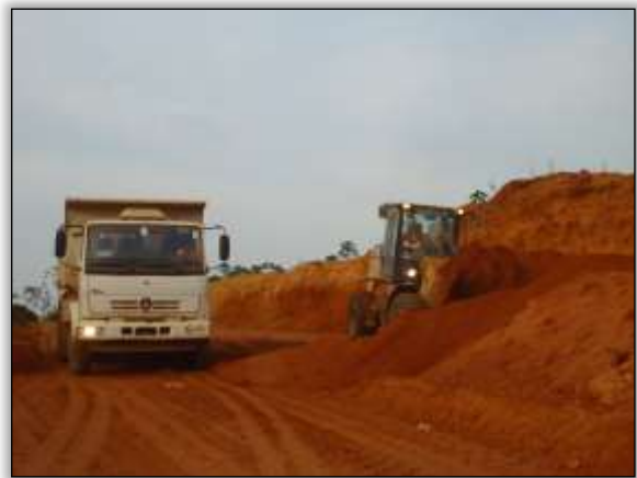
Foto 10 – Corte de talude. Lado esquerdo. S 04.26062° W 049.94761° 28/10/2013
