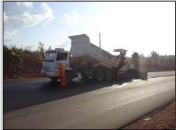
Foto 8 – Pavimentação asfáltica. Lado esquerdo. S 04.13452° W 049.58199° 01/10/2013
