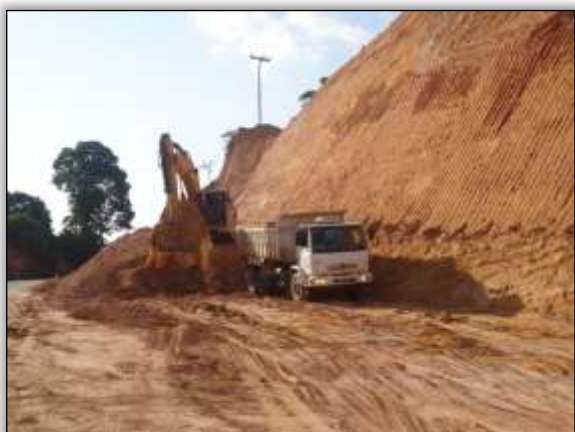
Foto 5 – Atividades de corte na rodovia. Lado direito. S 05.23541° W 049.96256° 26/09/2013
