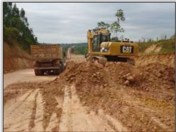
Foto 10 – Corte em talude. Lado esquerdo. . S 05.12872° W 049.39721° 12/11/2013
