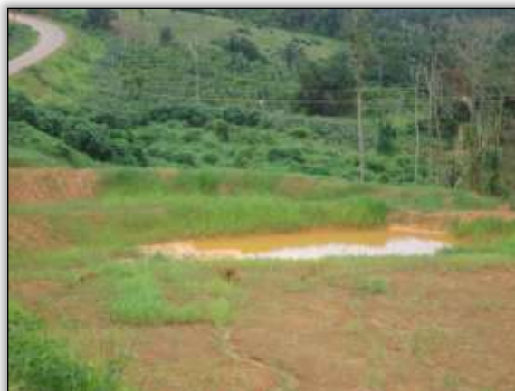
Foto 20 – Revestimento vegetal em aterro e bacia de contenção. Lado esquerdo. S 03.93082° W 050.33002° 29/01/2014
