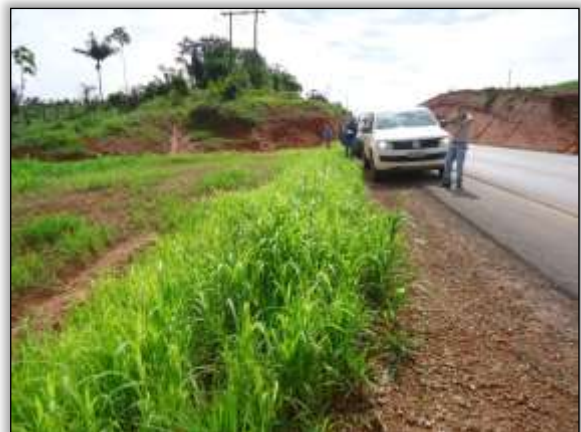
Foto 18 – Revestimento vegetal no bordo da rodovia. Lado direito. S 04.18025° W 050.03599° 29/01/2014
