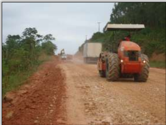
Foto 9 – Atividades de compactação do solo. Lado esquerdo. 04.25050° W 049.04603° 12/11/2013
