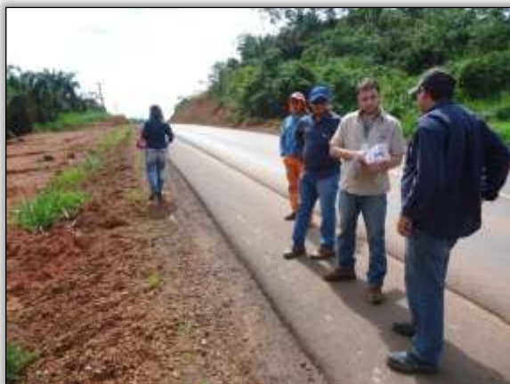
Foto 17 – Vistoria técnica entre Gestão Ambiental e Sanches Tripoloni. Lado direito. S 04.19449° W 050.01511° 29/01/2014
