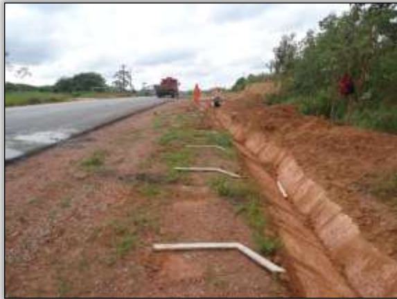
Foto 13 – Instalação de descidas d'águas. Lado direito. S 04.16201° W 050.17475° 20/11/2013
