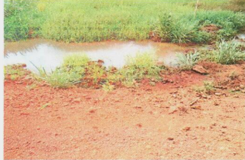
Foto 02 - Material desprendido para o corpo hídrico.
