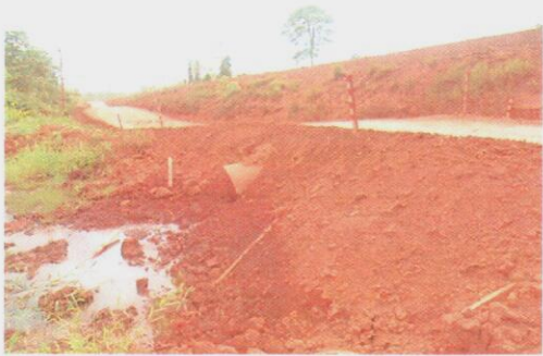
Foto 01 - Sedimentos existentes obstruindo a boca do bueiro.
