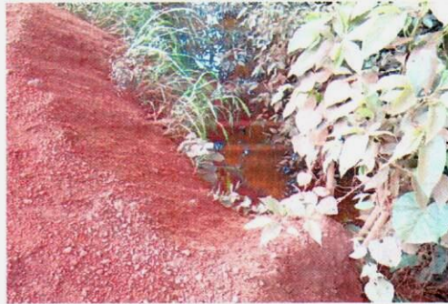
Foto 02 - Material de terraplanagem disposto para o corpo hídrico
