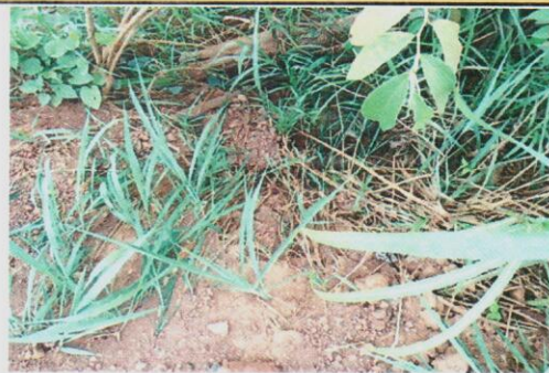
Foto 02- Sedimentos excedente no bueiro.
