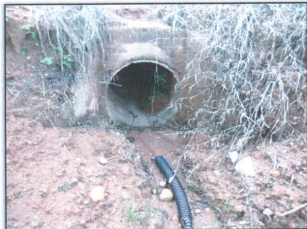
Foto 2 – Desobstrução do bueiro. Lado: Direito/Esquerdo. Estaca: 3075. S 03.39785° W 052.73565° 18/04/2013
