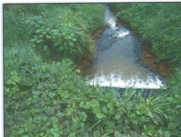
Foto 2 – Desobstrução do bueiro. Lado: Direito/Esquerdo. Estaca: 4032+4. S 03.44445° W 052. 89524° 18/04/2013
