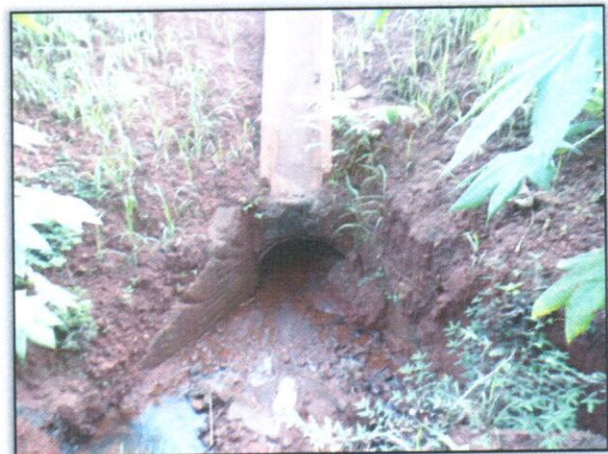
Foto 2 – Desobstrução do bueiro. Lado: Direito/Esquerdo. Estaca: 3798+15. S 03.44207° W 052.85532° 18/04/2013
