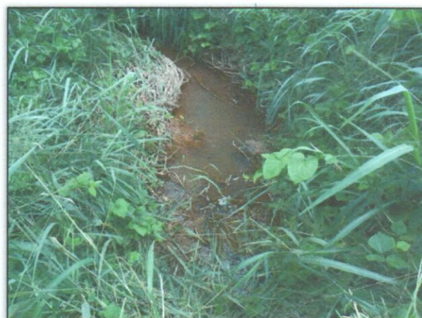
Foto 2 – Desobstrução de bueiro. Lado: Esquerdo. Estaca 4177. S 03.45109° W 052. 92046° 13/02/2013.
