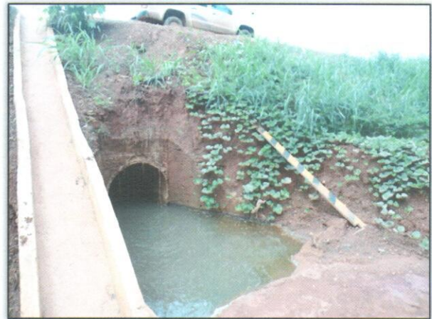
Foto 2 – Desobstrução de bueiro. Lado: Esquerdo. Estaca 4131. S 03. 44822° W 052. 91297° 13/02/2013.
