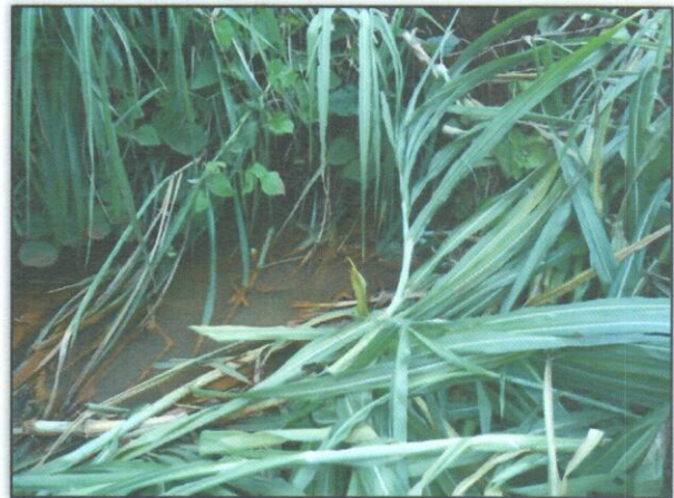
Foto 2 – Desobstrução de bueiro. Lado: Esquerdo. Estaca 4049. S 03.44496° W 052. 89866° 13/02/2013.
