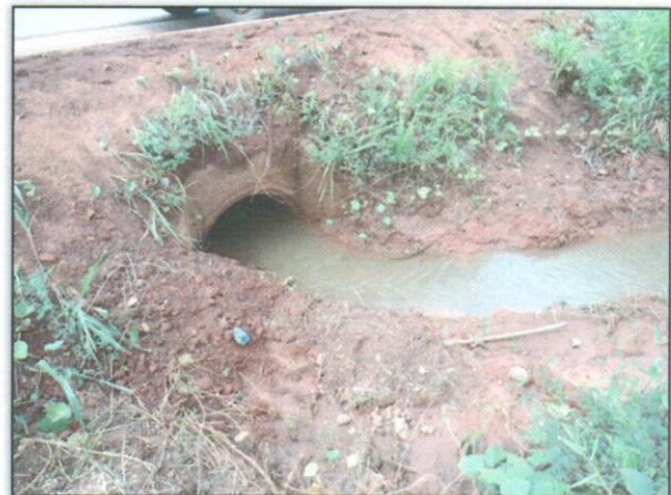
Foto 2 – Desobstrução de bueiro. Lado: Direito. Estaca: 3968. S 03.44078° W 052.88467° 13/02/2013.
