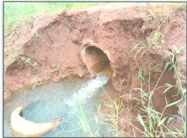
Foto 2 – Desobstrução de bueiro. Lado: Direito. Estaca: 3940. S 03. 43952° W 052. 87969° 13/02/2013.
