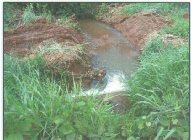
Foto 2 – Desobstrução de bueiro. Lado: Direito. Estaca: 3896. S 03.43744° W 052.87251° 13/02/2013.
