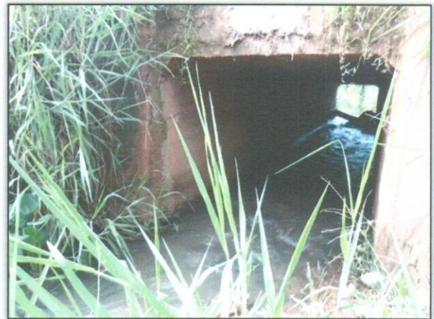
Foto 2 – Desobstrução de bueiro. Estaca: 3833. S 03.43959° W 052. 86113° 13/02/2013.
