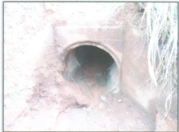
Foto 2 – Desobstrução de bueiro. Estaca: 3818. S 03.44074° W 052. 85849° 13/02/2013.
