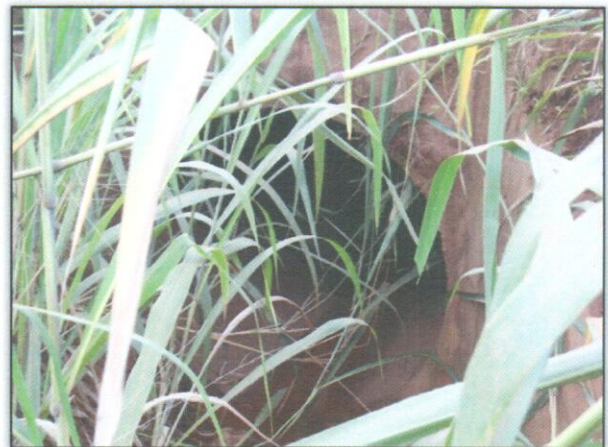
Foto 2 – Desobstrução de bueiro. Estaca 3786. S 03.44258° W 052.85361° 13/02/2013.
