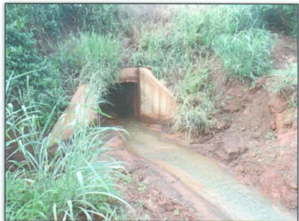
Foto 2 – Desobstrução de bueiro. Lado: Esquerdo. 3766. S 03.44278° W 052. 84949° 13/02/2013.
