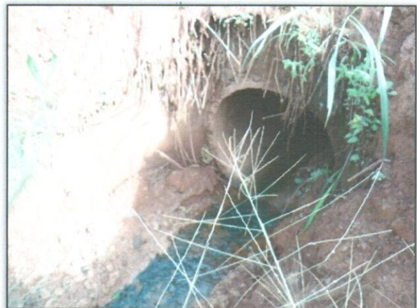
Foto 2 – Desobstrução de bueiro. Estaca 3699. S 03.44039° W 052.83799° 13/02/2013.
