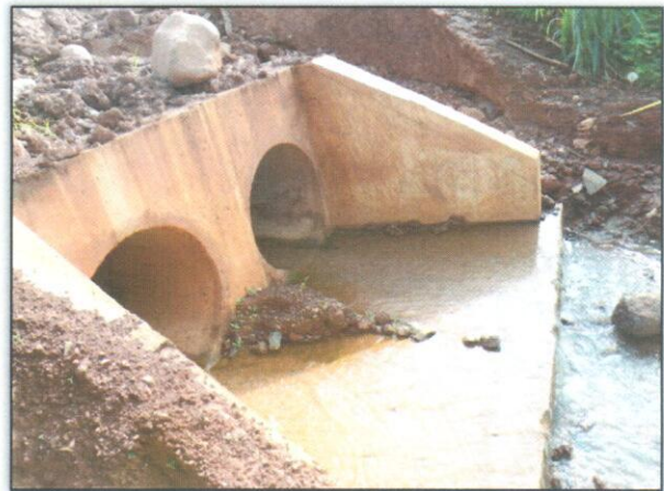
Foto 2 – Desobstrução do bueiro. Lado: Direito. Estaca: 3683+15. S 03.43981° W 052. 83508° 13/02/2013.
